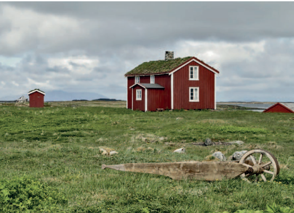
← Bolighus på Store Emårsøy. Foto: Inge Ove Tysnes
