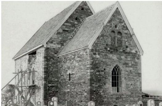
▲ 1965: Omfattende restaurering, bl.a. all puss hogd vekk og delvis rensing med saltsyre. Foto: Sem, RAs arkiv
