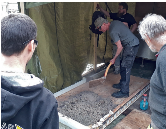
▲ Tradisjonell varmløsning av kalkmørtel med vedbrent kalk og sand på «gamlemåten», med spade. Leskingen/blandingen kan også gjøres i tvangsblender.
