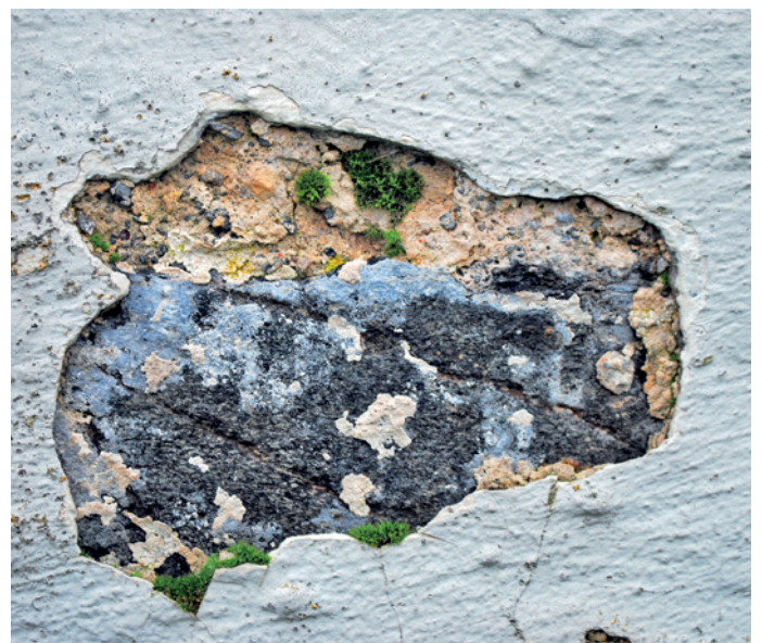
▲ Moderne materialer: Sementslemming og plastmaling kan gi så fuktige forhold at det vokser mose i avskallinger rett på muren etter bare noen få år. Her fra Hesby kirke
