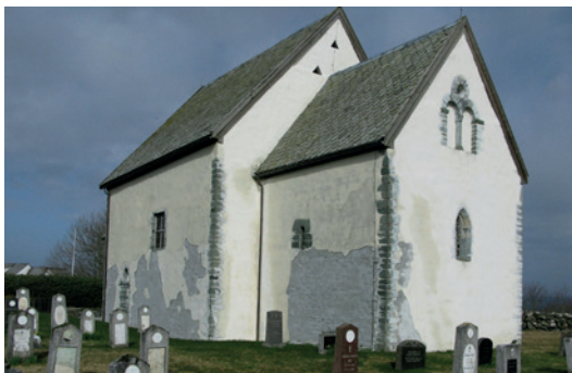
▲ 2013: Hele kirken er pusset med kalk og NHL, i flere omganger. Det går dårlig på den regnutsatte sørfasaden. Foto: Brevik, RAs arkiv
