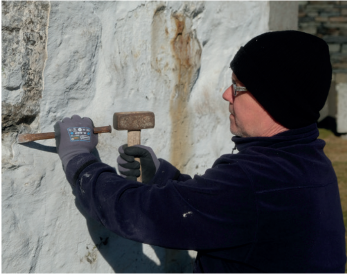
▲ Åpning av prøvefelt med renhogging av sement og gamle overflatebehandlinger er håndarbeid. Foto: Morten Stige, Fabrica
