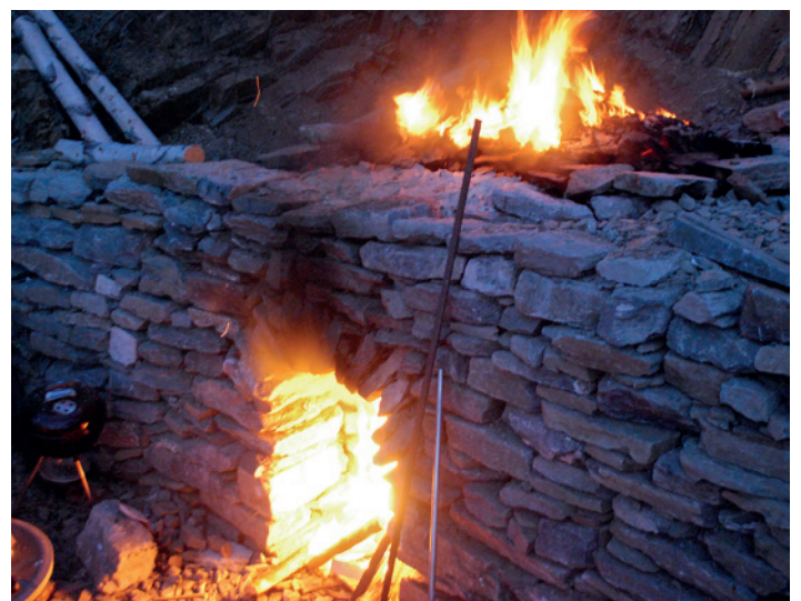
▲ I slike ovner brant man kortreist kalk med ved fra middelalderen til slutten av 1800-tallet. Dette er en ny tradisjonsovn på Helgøya med kapasitet på ca. 16 tonn pr. brenning. Hver brenning tar ca. 3 døgn.
