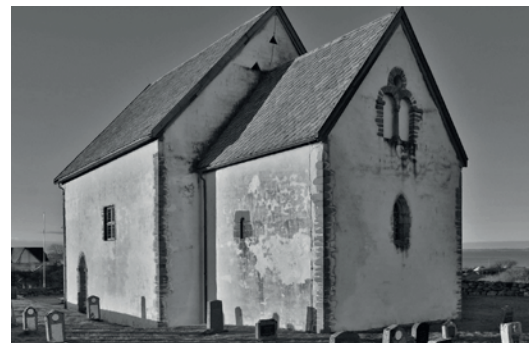
▲ 2020: Siden 2013 har det vært flere restaureringskampanjer, uten suksess. Som historien viser er dette nye skader på gamle skadesteder. Neste forsøk må ta hensyn til minst 100 år med problemer.
