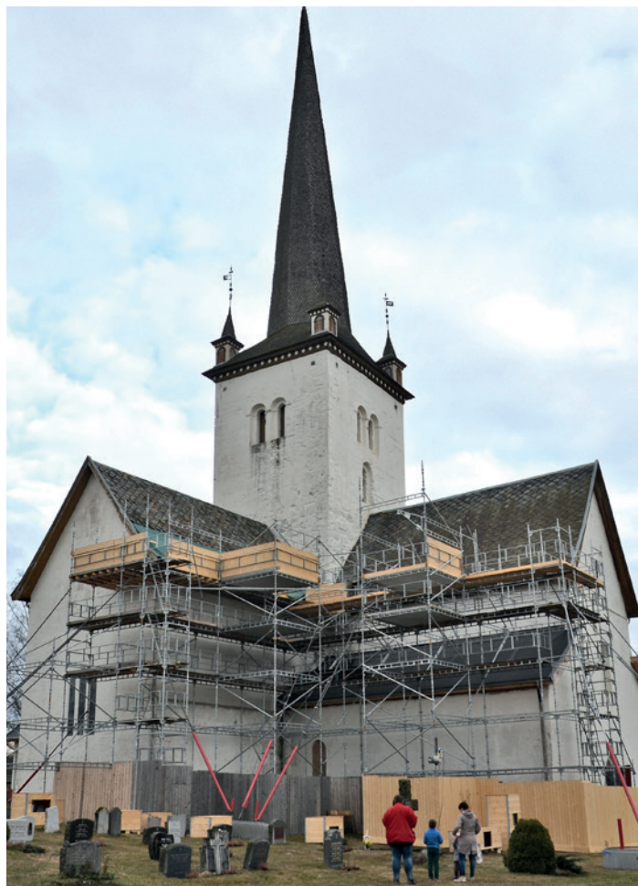
▲ Istandsetting av middelalderkirkene kan ha store logistiske utfordringer og må planlegges vel, ikke minst gjelder det stillasene. Her fra Ringsaker kirke.
