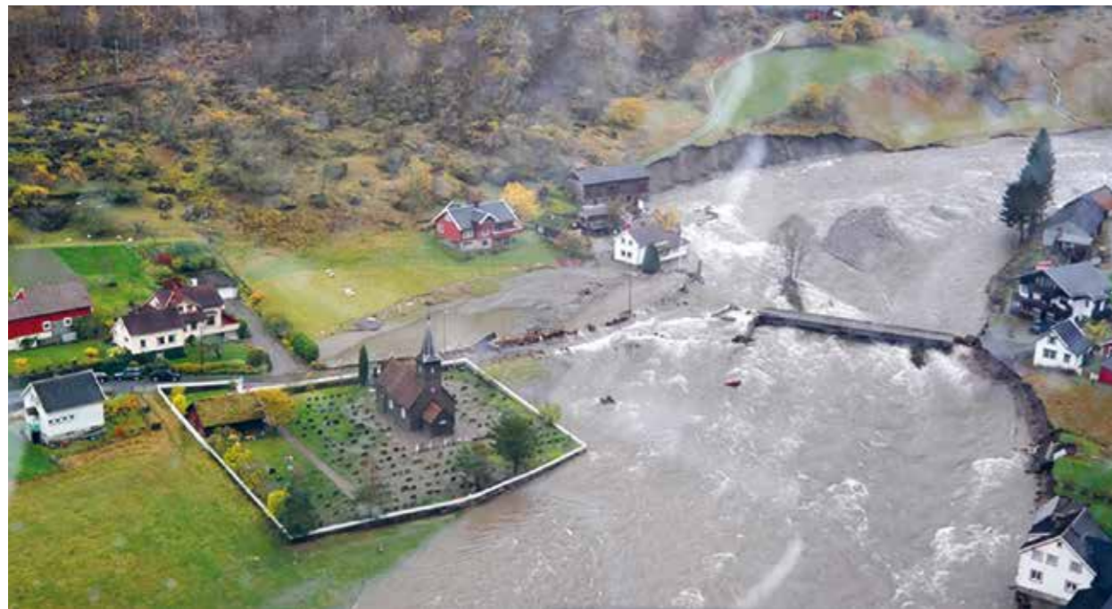
↑ FLYFOTO FRA FLOMMEN I FLÅMSDALENE I 2014. Flere bygninger, jordmasser og veier ble vasket ut med flommen. Flåm kirke fra 1600-tallet lå utsatt til. Kirkegårdsmuren holdt mye av vannet unna kirkegården, men store mengder trengte seg inn også i kirken. Foto: Oddleif Løset, NRK
