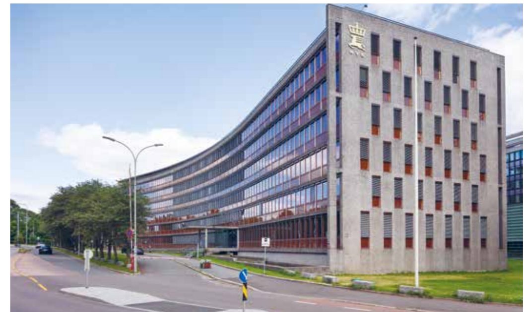
↑ MIDDELTHUNGSGATE 29 i Oslo ble oppført som administrasjonsbygg for Norges vassdrags- og energidirektorat, NVE (daværende Norges Vassdrags- og Elektrisitetsvesen), i 1962–64. Deler av bygget er fredet, både eksteriøret og interiør, som hovedinngangen, det sentrale trapperommet, to kontorfløyer og møterom. I 2011 stod bygget igjen klart som kontorlokaler etter en total rehabilitering. Fredningsbestemmelser, miljøkrav og universell utforming lå til grunn for rehabiliteringen. Samtidig som byggets opprinnelige, arkitektoniske kvaliteter ble søkt ivarettatt, har NVE-huset i dag Energimerke B. Det er blant annet gjort forbedring av isolasjon i vegger og tak, teknisk oppgradering av vinduer og behovsstyring av lys og ventilasjon. Foto: Trond A. Isaksen, Riksantikvaren
