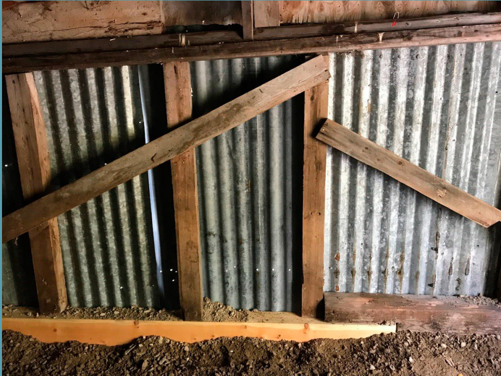
Innvendig sør- og østveggen. Enkel konstruksjon med jordgulv. Foto: Riinakaisa Laittila/RDM-PM.
