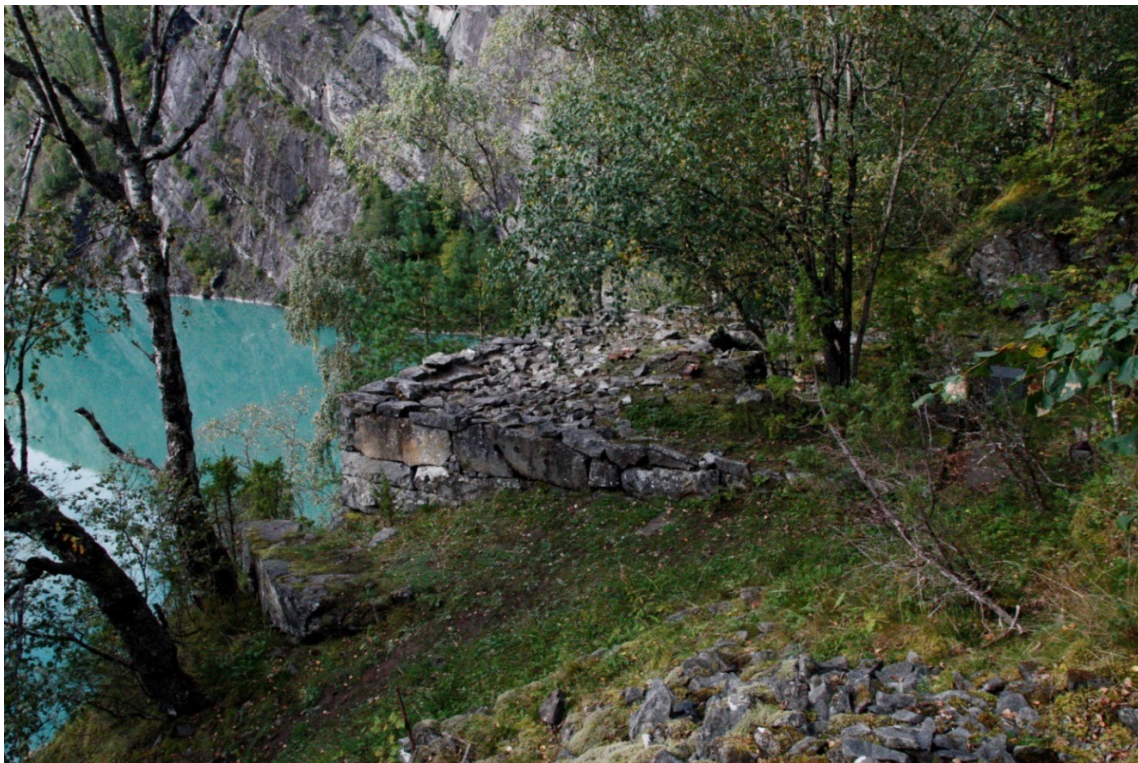
Figur 10. Grunnmuren til huset slik den stod i 2016, før huset vart ført tilbake til opphavleg stad. Foto: A. Bidne/Sogn og Fjordane fylkeskommune, 2016.
