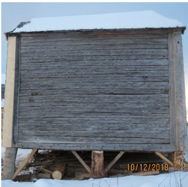
Nordfasade. Foto: Slidre Bygg & Prosjektering AS, 2018
