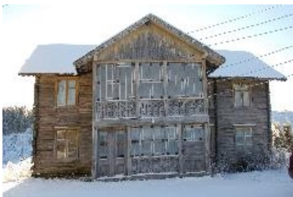
Gamlebygningens nordfasade. Foto: OFK, 2010
