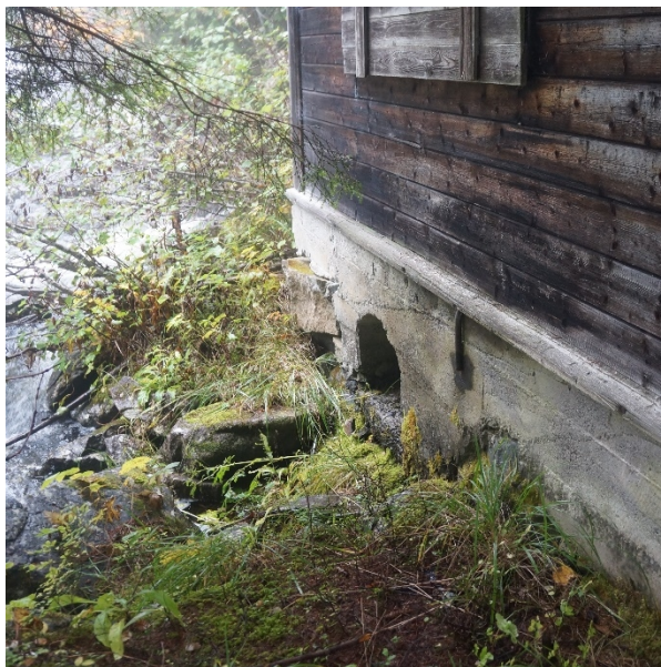
Utsnitt av sørlige fasade, med åpning for vannutkast. Foto: Dag Lindbråten, 2017
