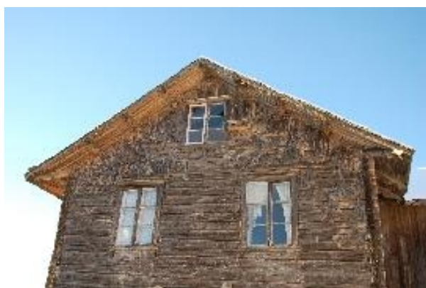
Gamlebygningens østfasade, med rester etter flisledning. Foto: OFK, 2010
