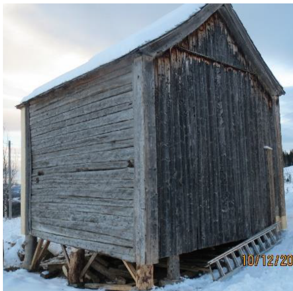
Nordre og vestre fasade. Foto: Slidre Bygg & Prosjektering AS, 2018
