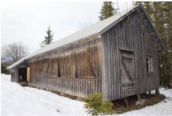
Søndre og østre fasade. Felt for tømmerinntak er panelt. Foto: Dag Lindbråten, 2017
