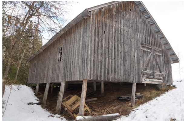
Vestre og nordre fasade. Deler av bygningen står på pilarer. Foto: Dag Lindbråten, 2017
