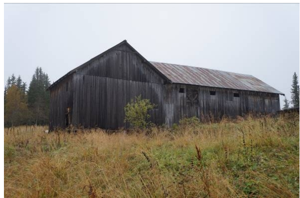
Østre og søndre fasade. Låven gikk tidligere ut i vinkel fra gavlen. Foto: Dag Lindbråten, 2017
