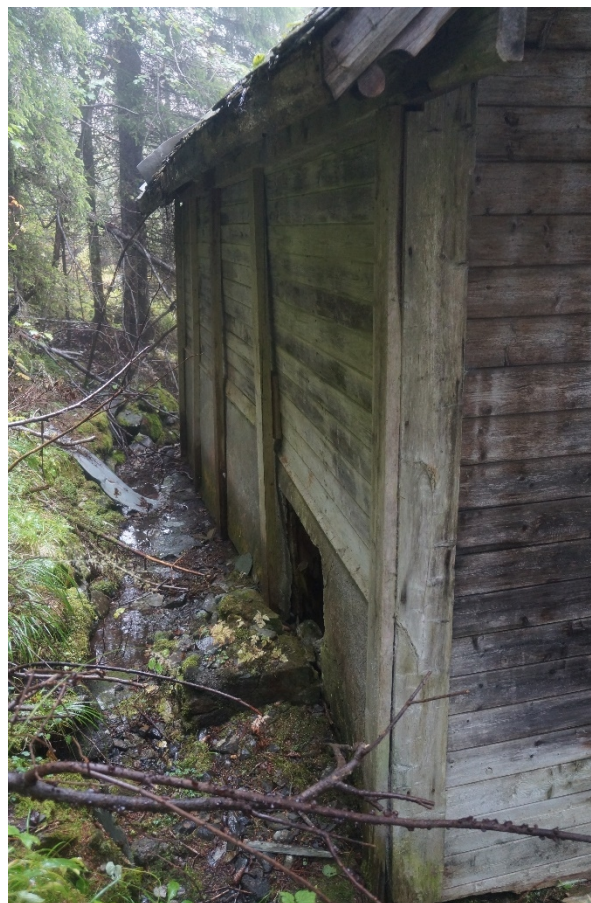
Nordre fasade, med veit og åpning for vanninntak. Foto: Dag Lindbråten, 2017
