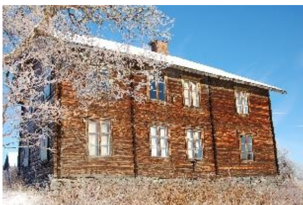
Gamlebygningens sørfasade. Foto: OFK, 2010
