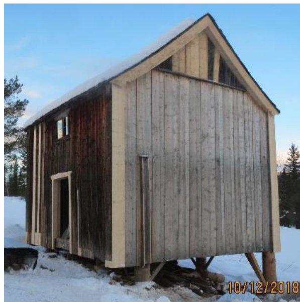
Søndre og østre fasade. Foto: Slidre Bygg & Prosjektering AS, 2018
