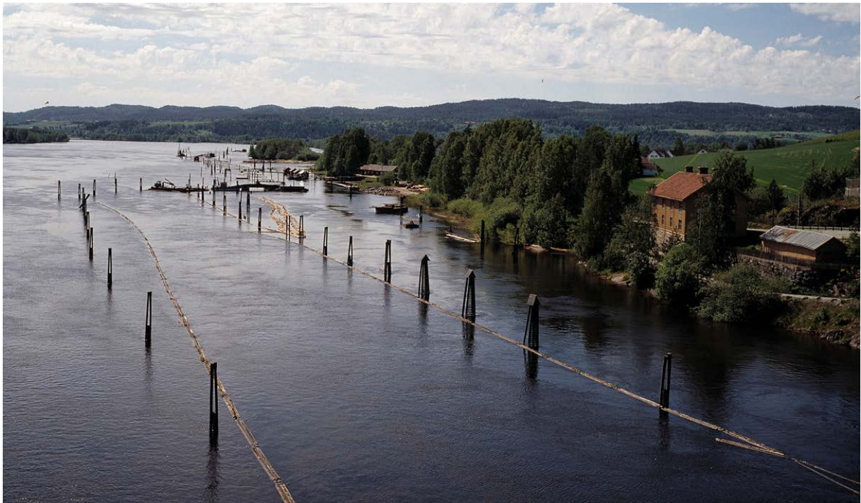
Fløtingsanlegget på Fetsund lenser er et markant element i landskapet. Foto: Arve Kjersheim, Riksantikvaren
