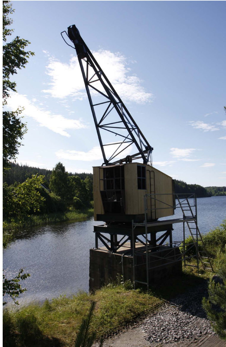
Tømmerkrana ved Skulerud brygge var viktig for overgangen mellom jernbane og kanal. Foto: Ulf Ingemar Gustafsson, Riksantikvaren
