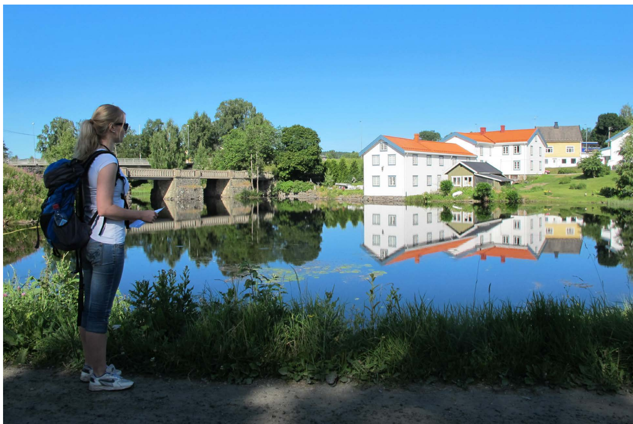
Andelva ved Eidsvoll verk, der det gamle bygdesentret Piro er på motsatt side av elva for Eidsvollsbygningen. Foto: Ola Rønne, Viken fylkeskommune
