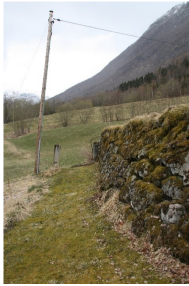
Figur 7, Figur 8 og Figur 9 Bakkemuren ved den gamle bygdevegen. Figur 8 viser parti på muren som held på å sige ut og har behov for istandsetjing.
