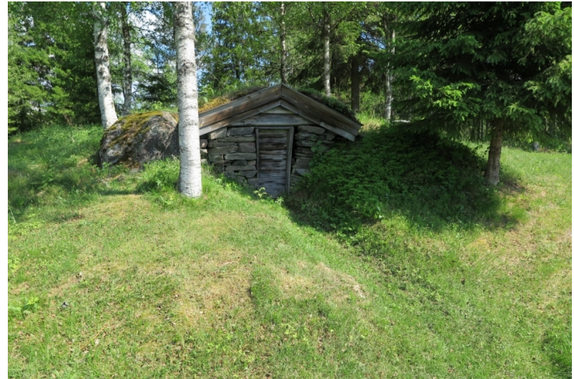
Kjelleren er murt inntil den naturlige haugen.
