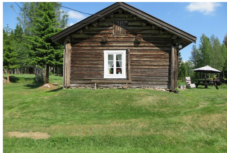
Inntil vestfasaden ligger en moldbenk.
