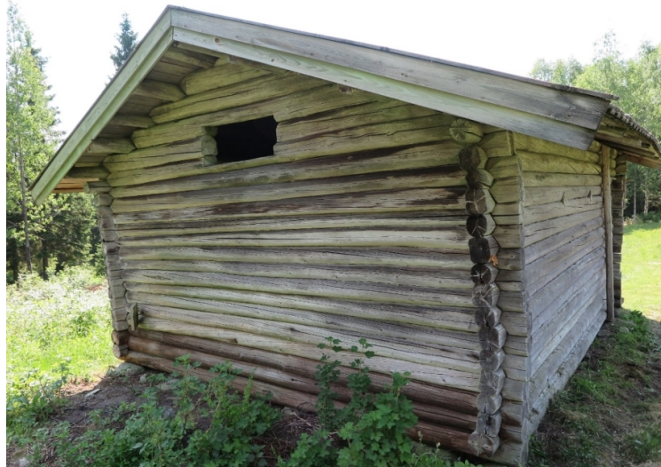
Baksida av fjøset, mot øst.
