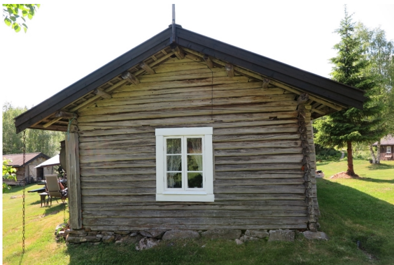
Østfasaden. Denne delen av stua er nyere enn røykstuedelen.
