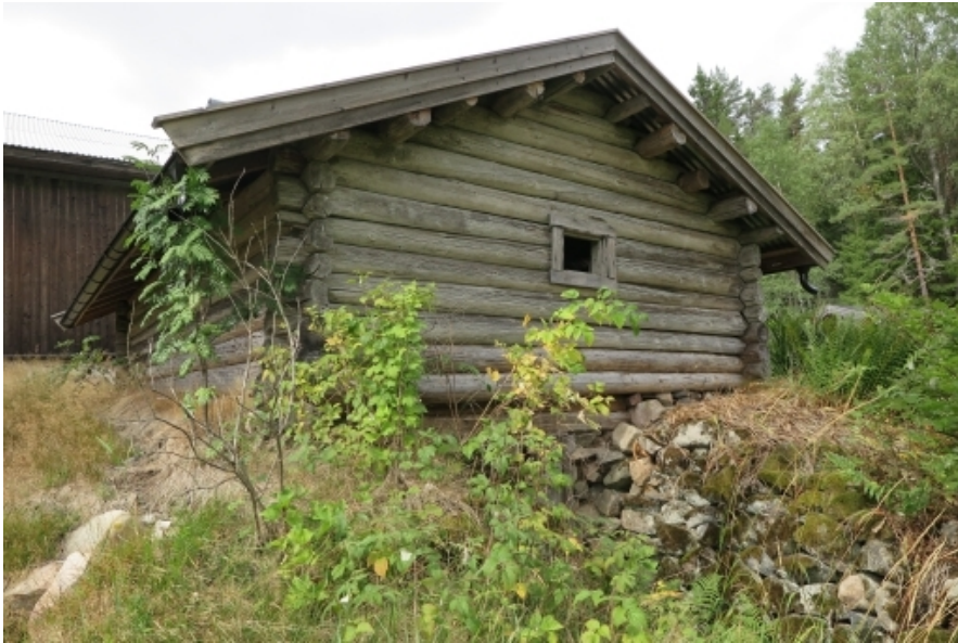
Østsida av bygningen med steinmur.
