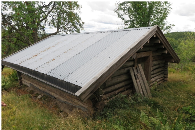
Jordkjelleren sett fra nord. Inngangsdør til loft. Potetluke med nedkast til kjelleren hitafor døra.
