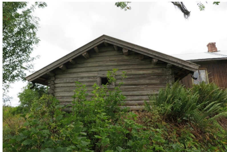
Østfasaden av jordkjellerens loft.
