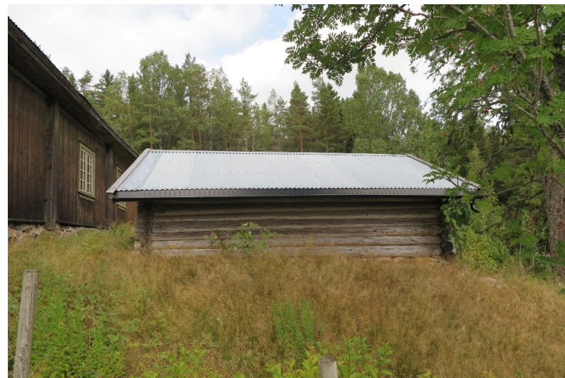
Sør-veggen på jordkjellerens loft
