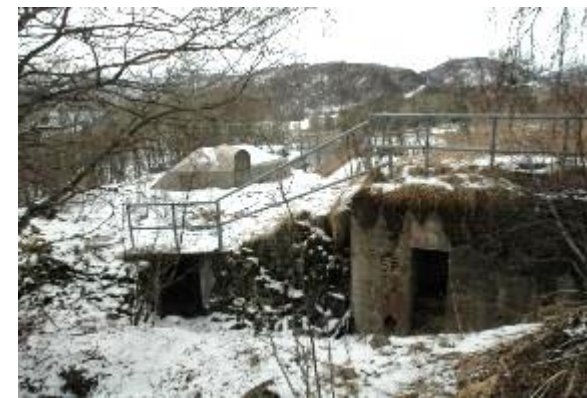
Inngang til bunker eller maskingeværstilling til høyre
