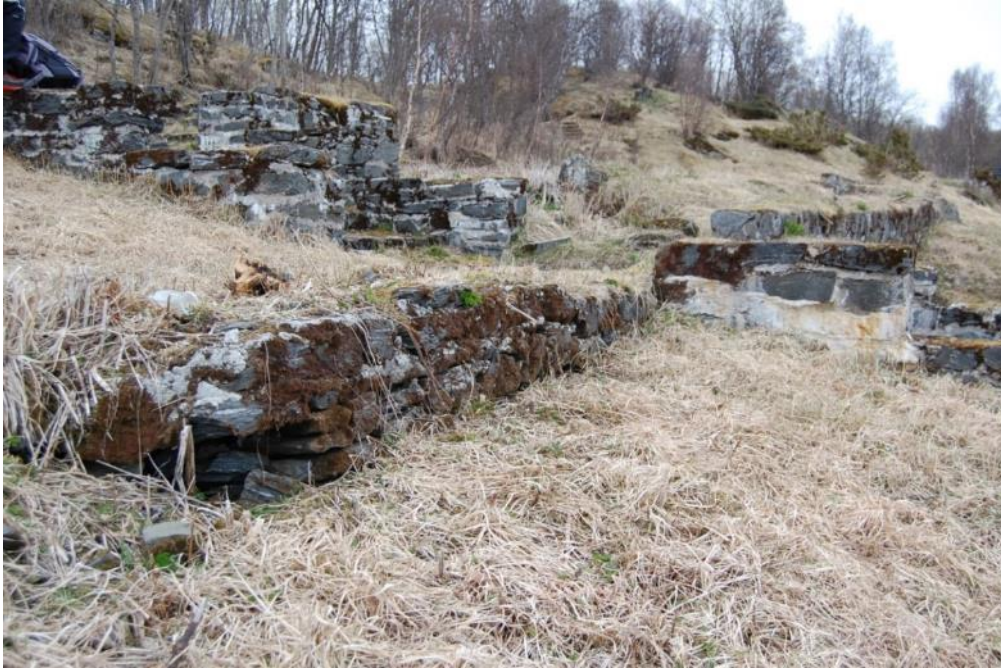
Figur 12 Støttemur, nr. 5, ligger vest for trapp, nr. 3.
