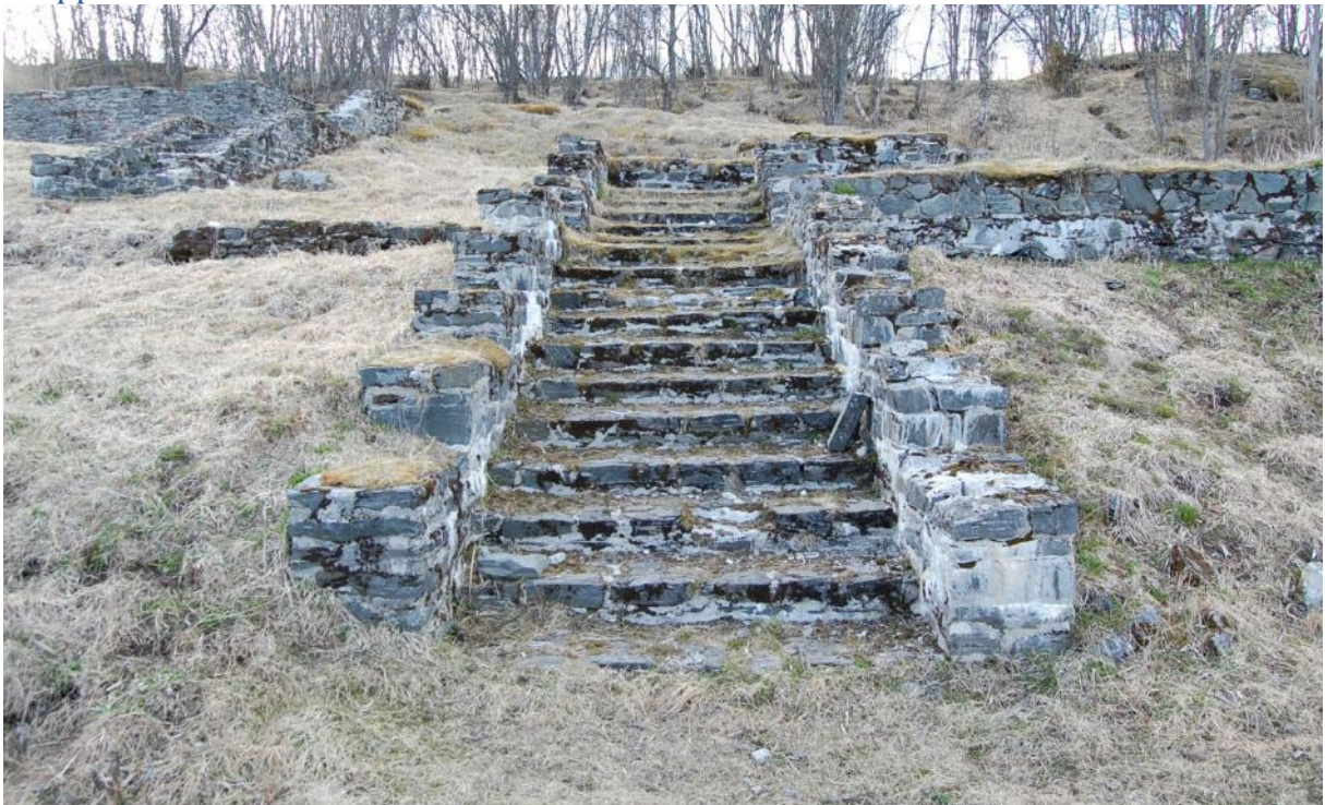
Figur 9 Trapp sett fra veien nr. 3
