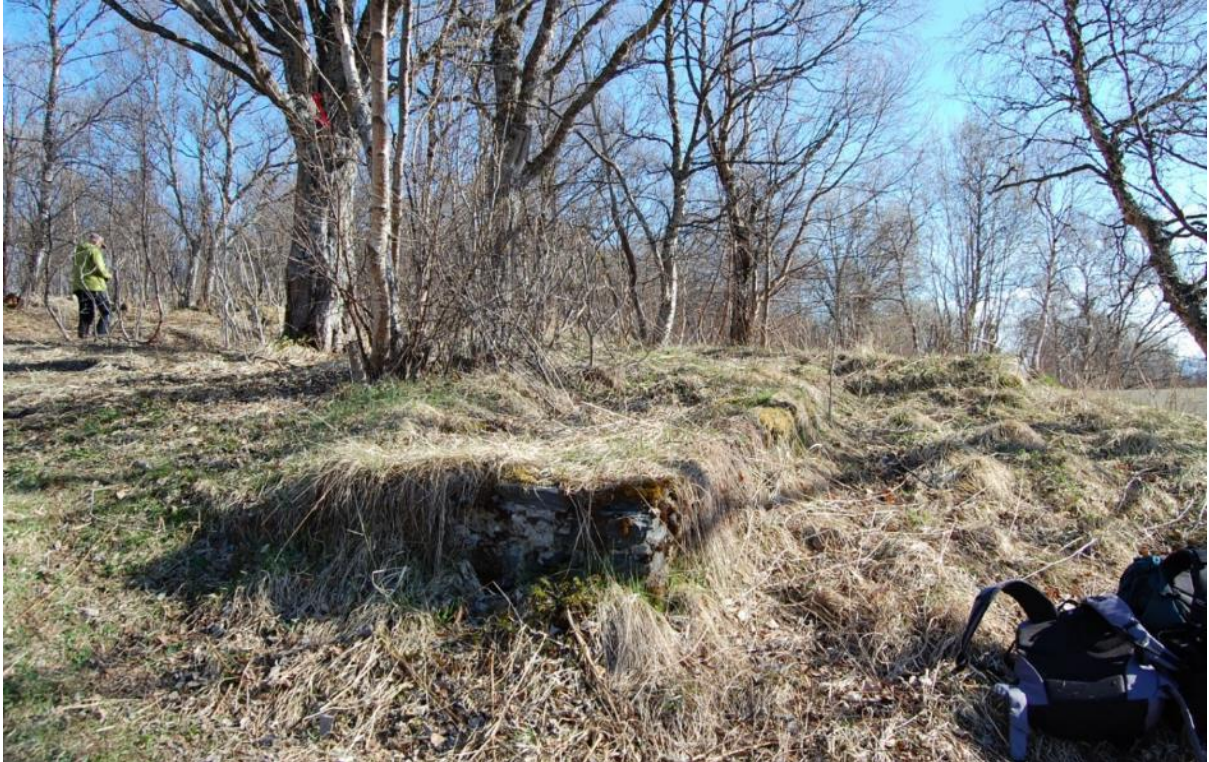
Figur 29 støttemur og trapp nr. 19
