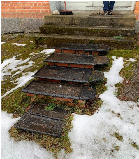
Gamle støpeovnsdeler er gjenbrukt som trapp på snekkerverkstedet. Foto: Linn Brox, Riksantikvaren.
