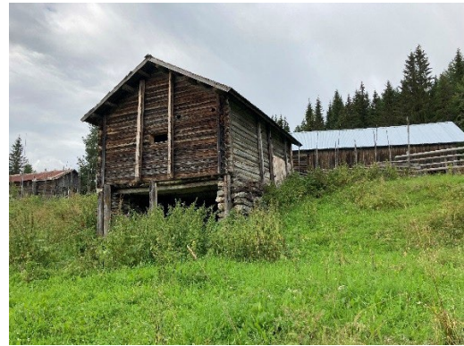
Fasade mot nord og øst
