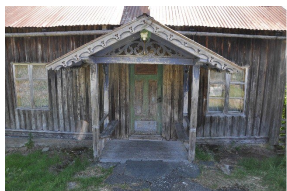
Fasade mot vest - detalj inngangsparti
