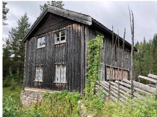
Fasade mot nord og øst
