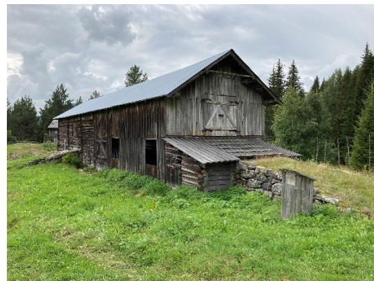
Fasade mot nord og øst
