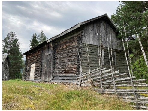
Fasade mot nord og øst
