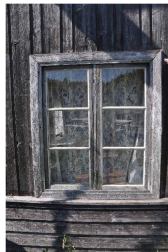
Detalj vindu og panel
