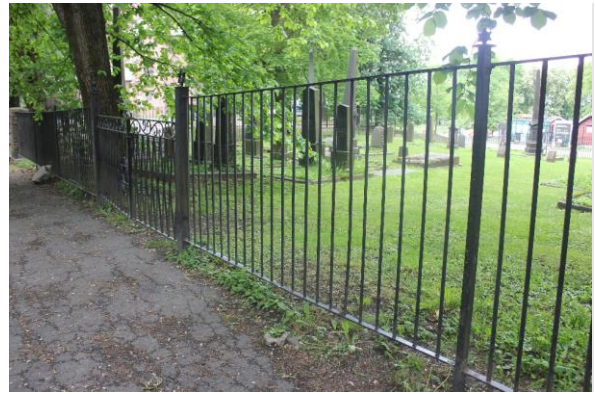
Gjerdet har en relativt enkel utforming, med stående spiler mellom slanke stolper.
