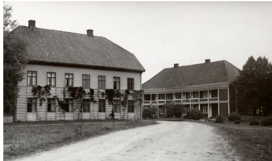
Hovedbygning og søndre murbygning sett fra innkjørselen. 1941. Foto: Riksantikvaren.
