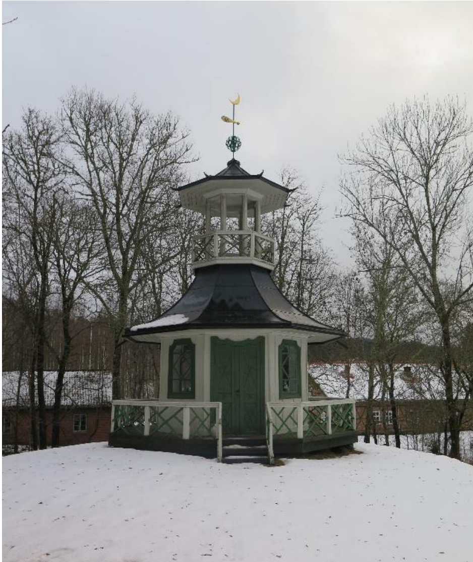
Til høyre (med klokken): Originalt spir, vindu, dør, trapp og rekkverk, detalj av takrenne (ny). Foto: Erle Austheim, Riksantikvaren, 2019.
