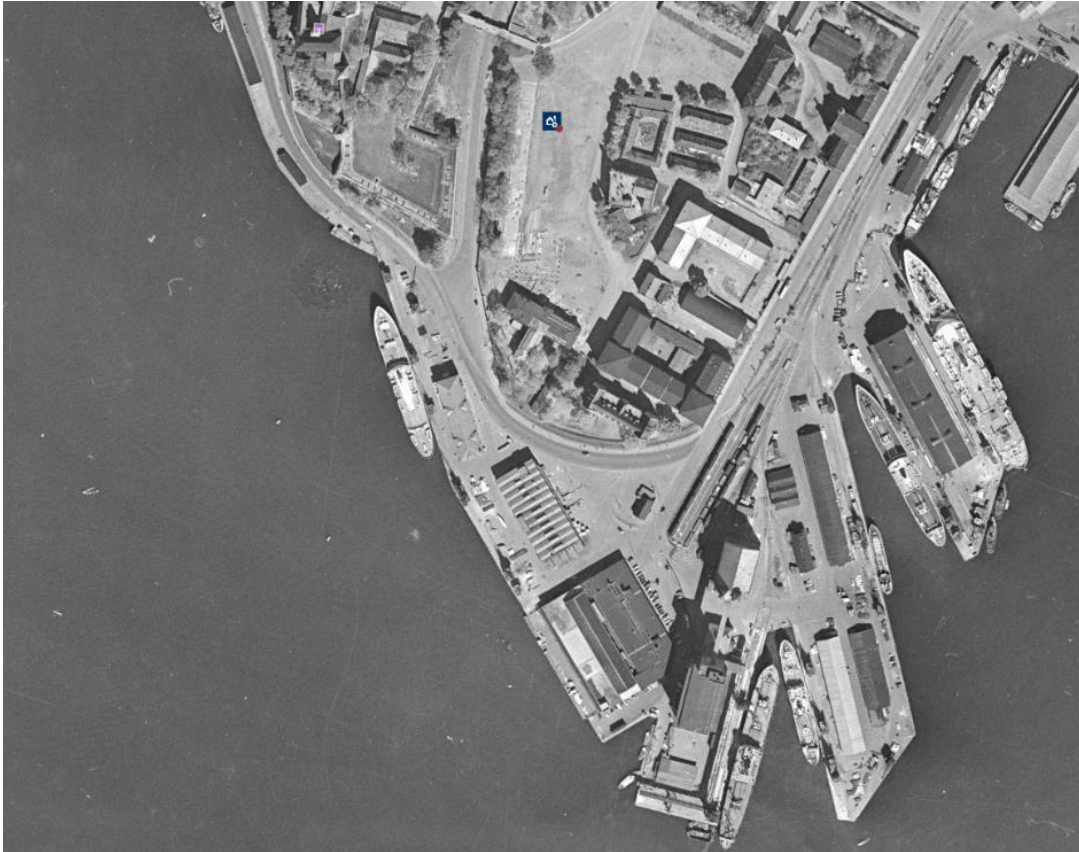
Ortofoto fra 1956. Pir 1, hvor Donau gikk fra, ligger lengst til høyre i bildet. Piren er senere blitt fylt igjen. Widerøes flyveselskap/Statens kartverk
