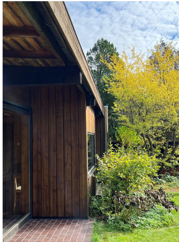
Utspring for spiseplass. Terrasse i den same klinkerflisen som innvendig.
