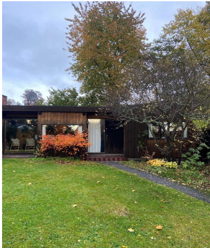
Fasade sørvest. Store glassfelt mot hagen. Utspringet/risalitten i fasaden hvor spiseplassen er, skjerner stuen og aksentuerer inngangspartiet.
