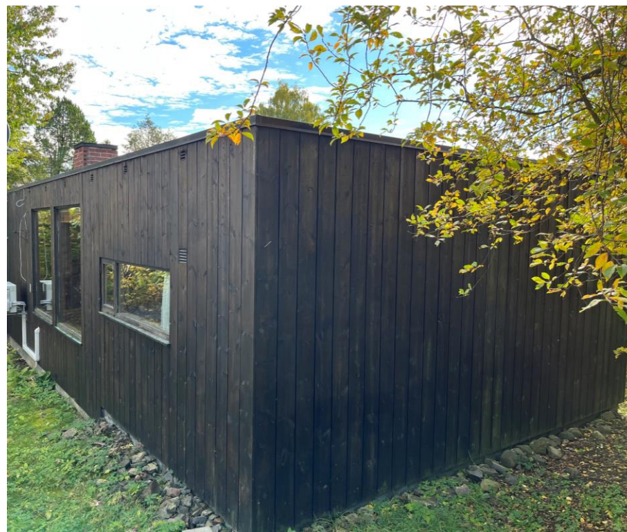
Hjørnet mellom fasade nordvest og fasade nordøst.
