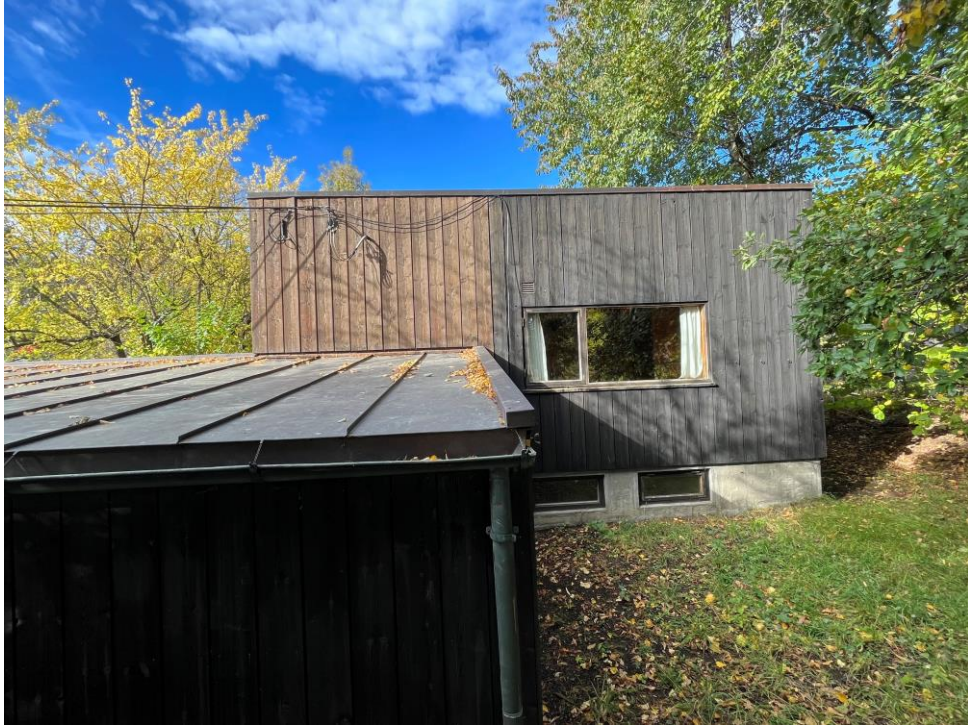
Vindu til soverom 2. Carporten bod-del i forgrunnen.
