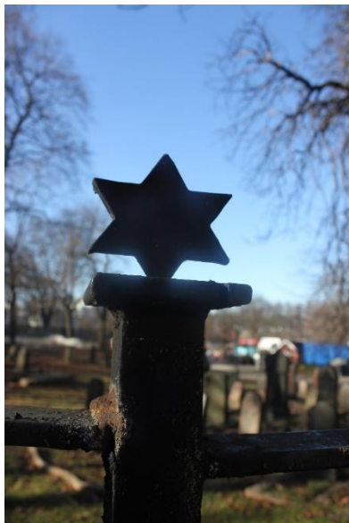
Detalj av stolpenes topputforming.
