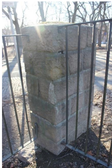
Det er trolig gjenbrukt en granittstolpe fra et tidligere gjerde rundt kirken.
