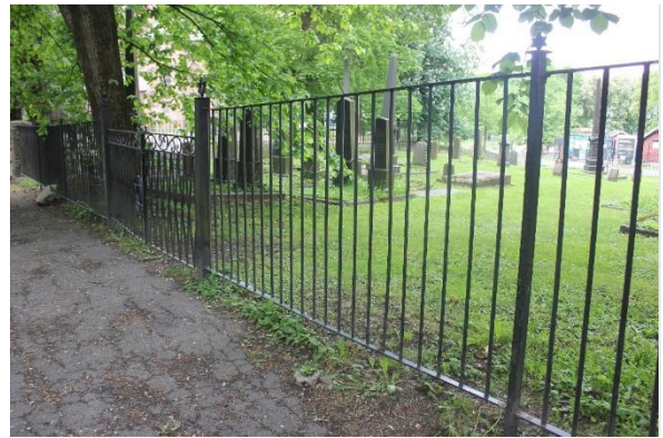
Gjerdet har en relativt enkel utforming, med stående spiler mellom slanke stolper.
