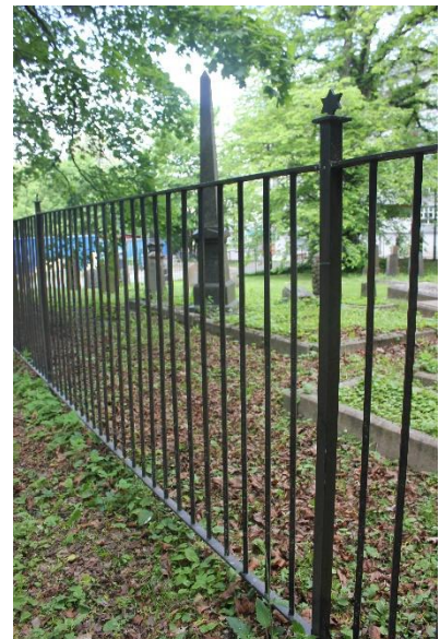
Det er brukt slanke stolper. Gjerdet har sveisete sammenføyninger.
