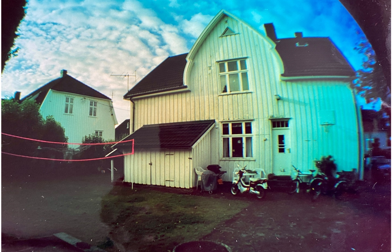
Figur 37 Sveins gate 15 rundt år 1990. Her ser vi den stående kledningen og skutet/tilbygget mot nord som ble erstattet med karnapp og kjellerlem i 1999. Den stående kledningen er også skiftet ut. Privat fotografi fra eier Rustenberg/Knutsen
