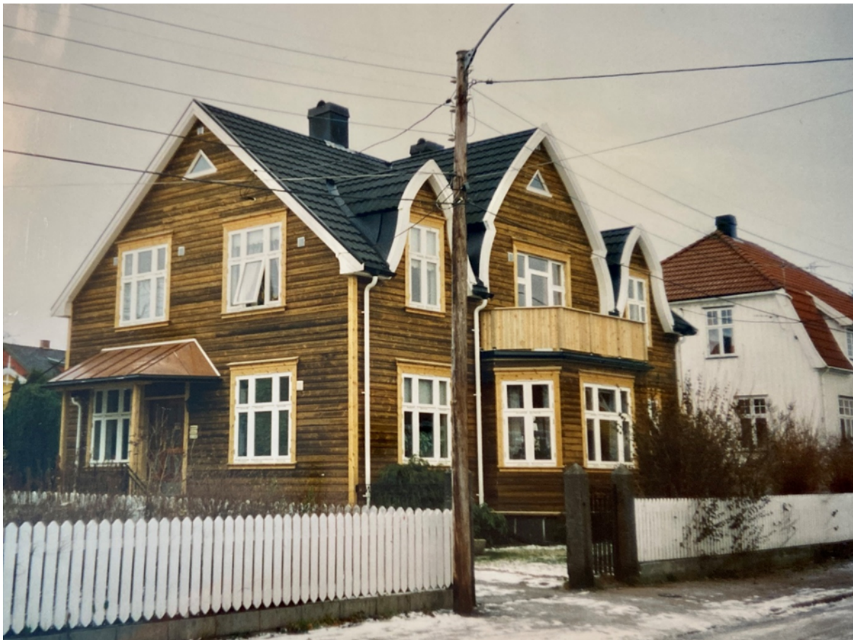
Figur 35 Sveins gate 15 ca 1990. Råtne vinduer og uoriginal kledning er skiftet ut og bygningen er i stor grad tilbakeført til opprinnelig utseende. Privat fotografi fra eier Rustenberg/Knutsen
