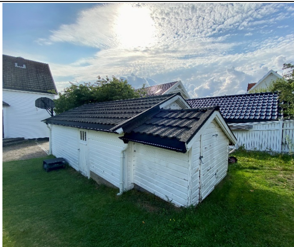
Figur 40 Sveins gate 15. Garasjen fasade mot øst. August 2022. Foto: Siv Abrahamsen, Kulturarv
