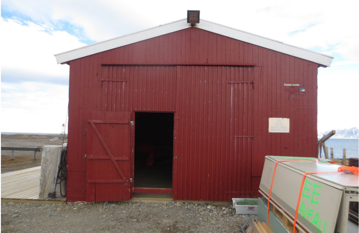
Figur 74: Naustet. Fasade mot SØ. Porten er ombygd og økt i høyden i forbindelse med heving av bygningen. Foto: Siri Hoem, Forsvarsbygg 2021.
