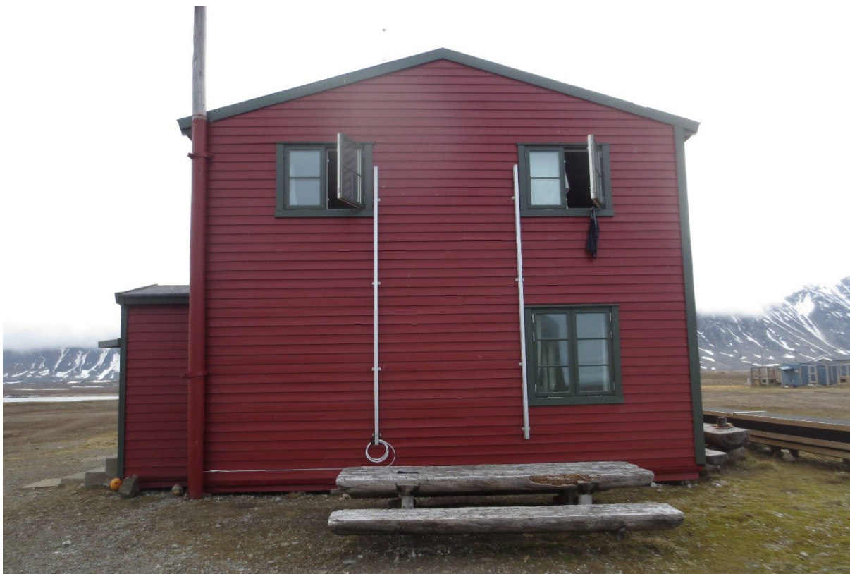
Figur 48: Gammelstasjonen. Gavlvegg/fasade mot V. Rømningsstiger montert ved vinduer. Foto: Siri Hoem, Forsvarsbygg 2021.
