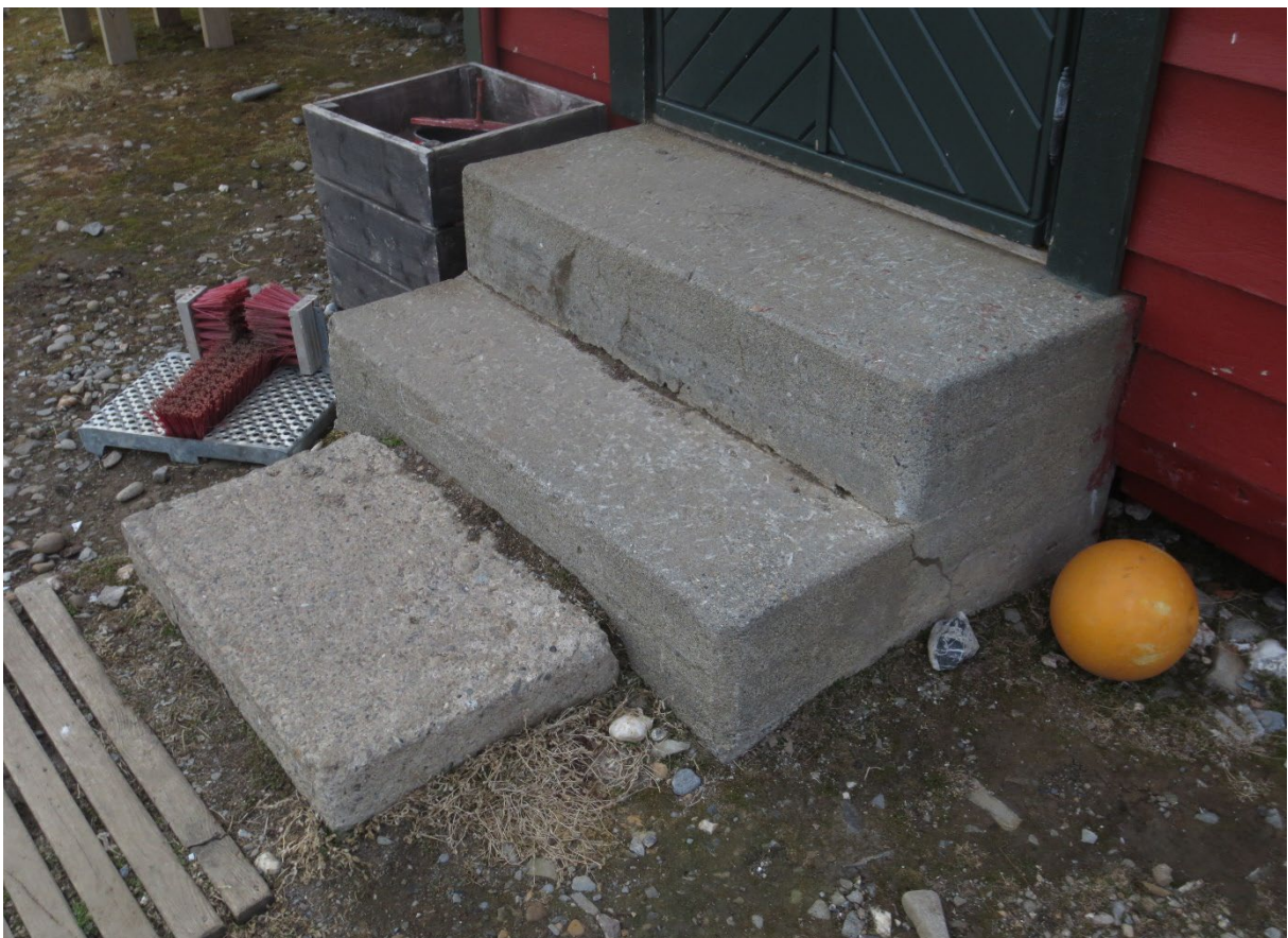
Figur 55: Gammelstasjonen. Betongtrapp ved hovedinngang. Foto: Siri Hoem, Forsvarsbygg 2021.
