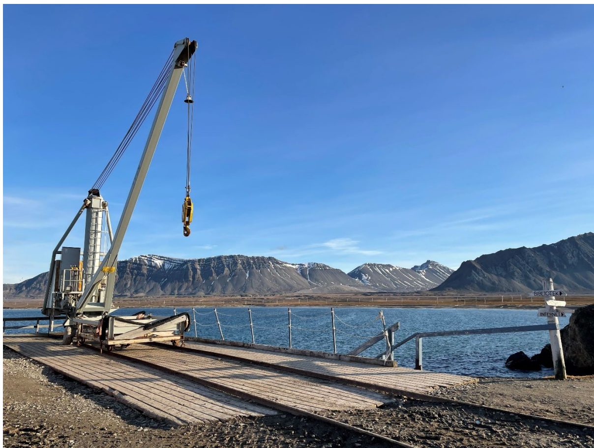
Figur 123: Skinnegangen ut på kaia. Krana er ikke omfattet av fredningen. Foto: Sysselmesteren på Svalbard, 2022.
