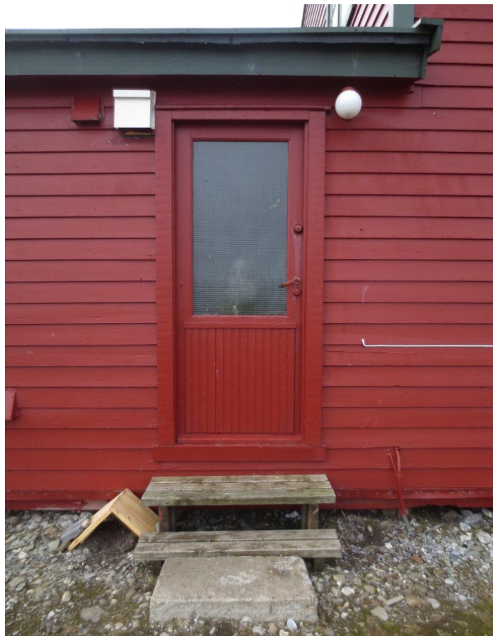
Figur 52: Gammelstasjonen. Dør i sidebygg, fasade N, med eldre betongtrinn foran. Foto: Siri Hoem, Forsvarsbygg 2021.
