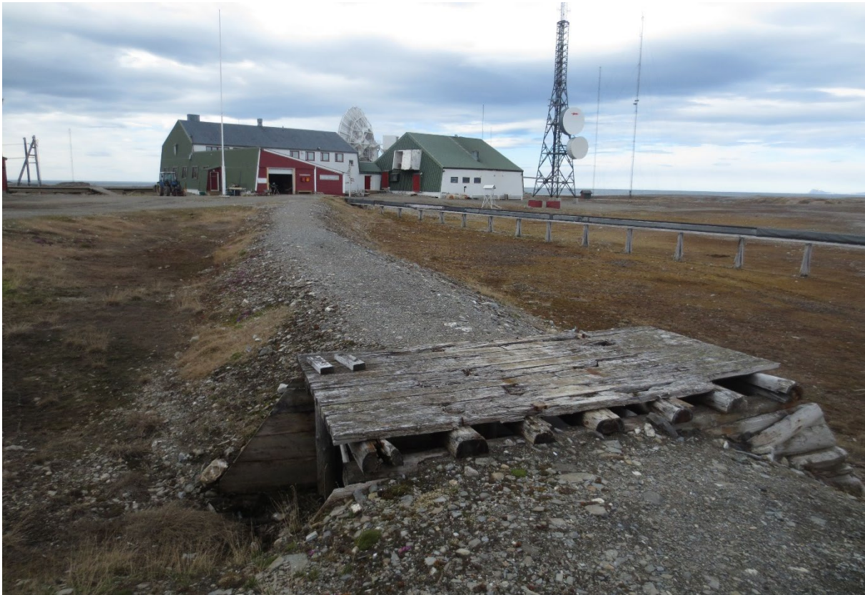
Figur 121: Oppbygd trasé for skinnegang, med kulvert/trekonstruksjon over søkk i terrenget. Foto: Siri Hoem, Forsvarsbygg 2021.
