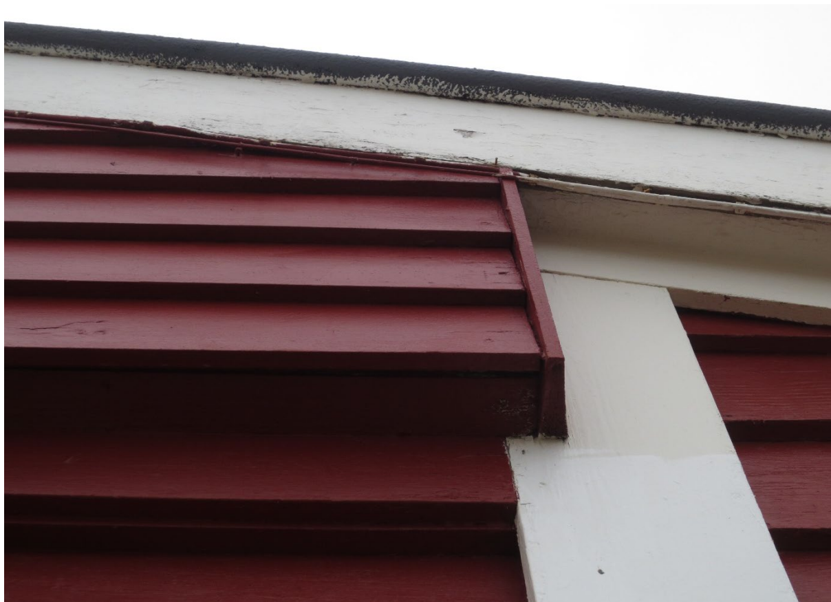
Figur 41: Detalj over garasjeport. Igjenbygd tidligere vindusfelt. Vindusfeltene er bevart bak gjenbyggingen. Foto: Siri Hoem, Forsvarsbygg 2021.
