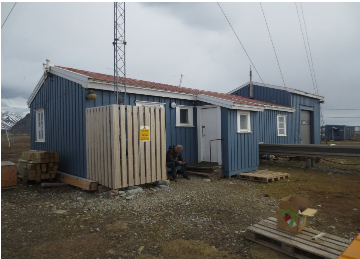
Figur 80: Sondebrakka. Foto mot SØ. Beskyttelsesgitter rundt mast er ikke omfattet av fredningen. Foto: Siri Hoem, Forsvarsbygg 2021.
