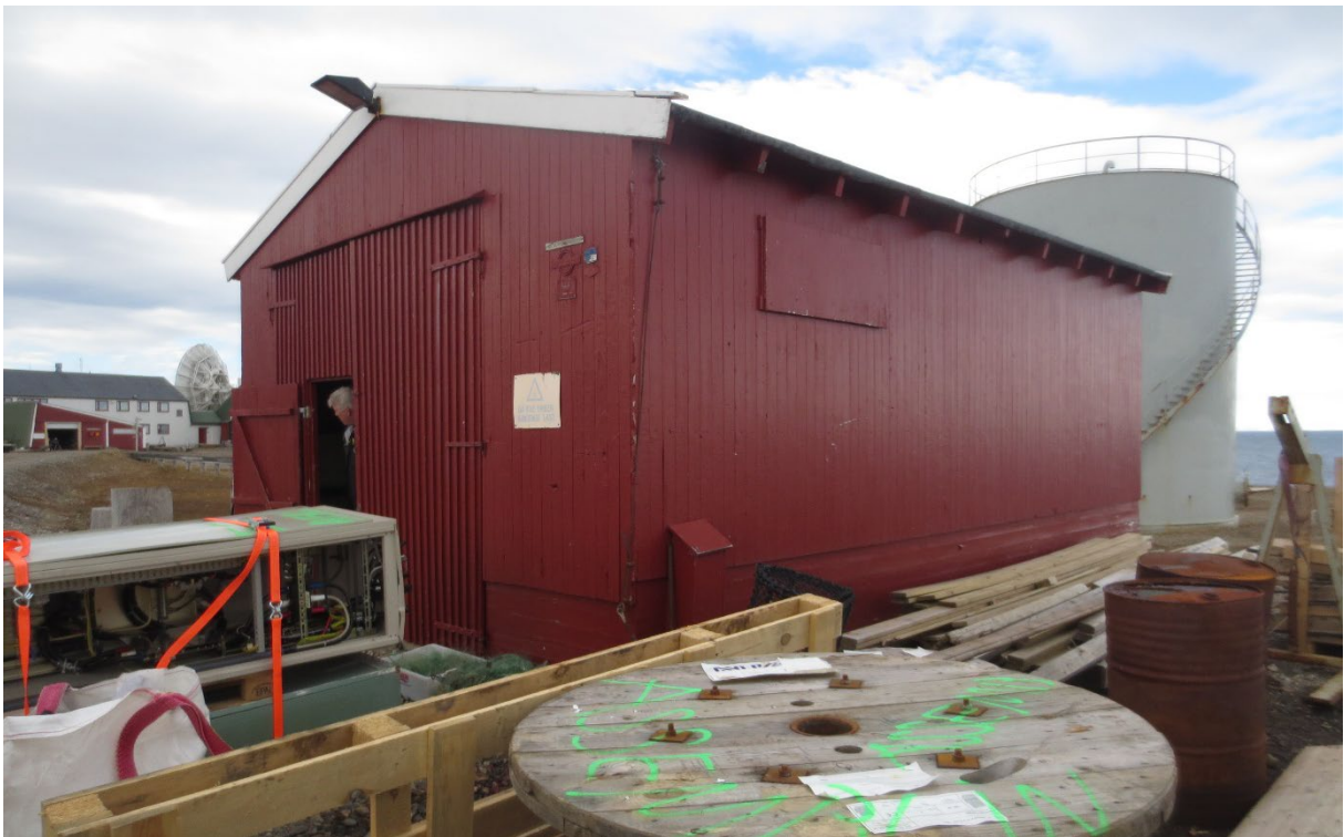
Figur 75: Naustet, fasade mot SØ (gavl) og NØ (langvegg, mot sjøen). Blendet vindu høyt opp på vegg. Foto: Siri Hoem, Forsvarsbygg 2021.
