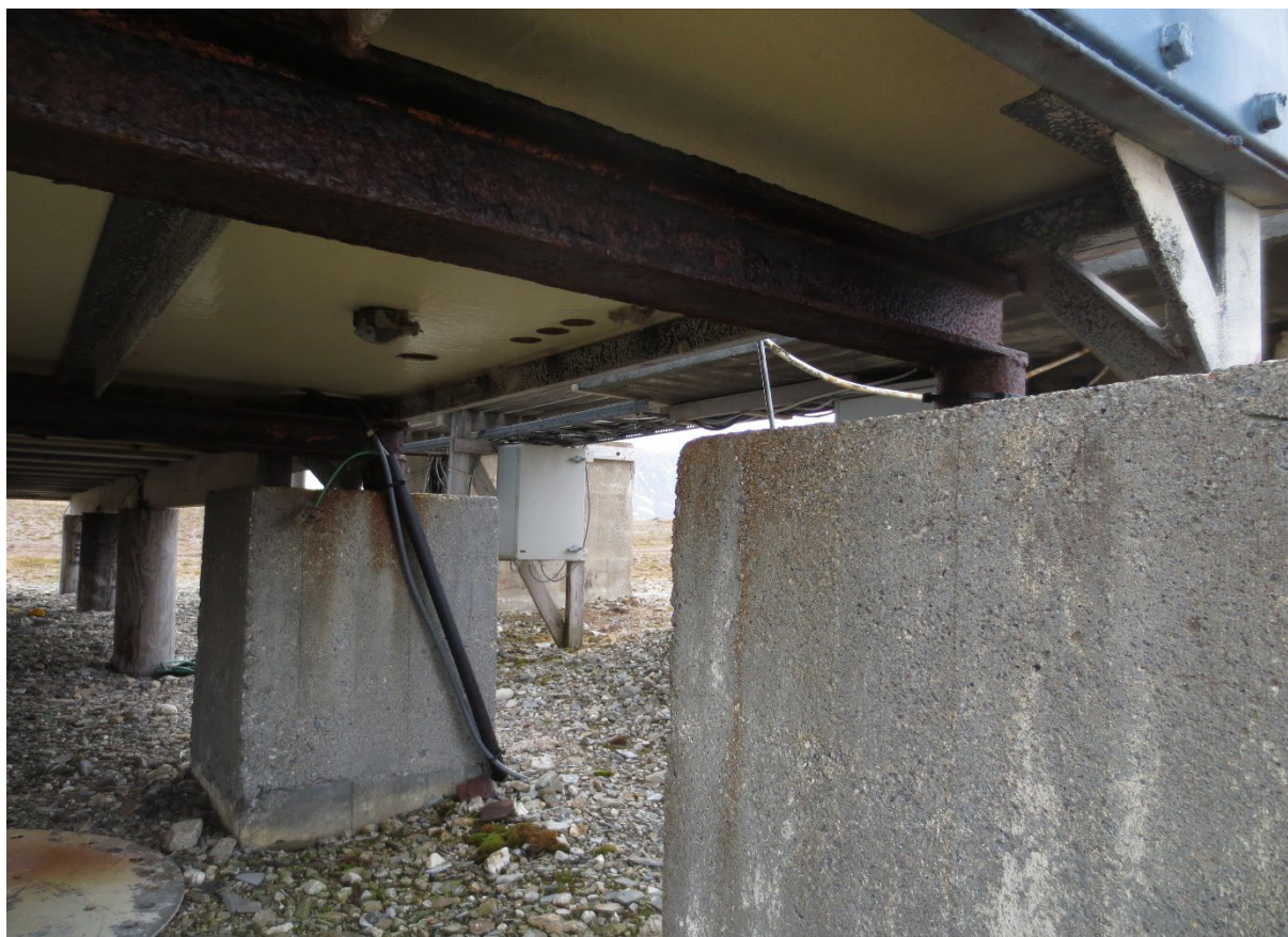
Figur 96: Detalj av fundamenter for teknisk rom. Lukk for antennefeste under bygningen. Foto: Siri Hoem, Forsvarsbygg 2021.
