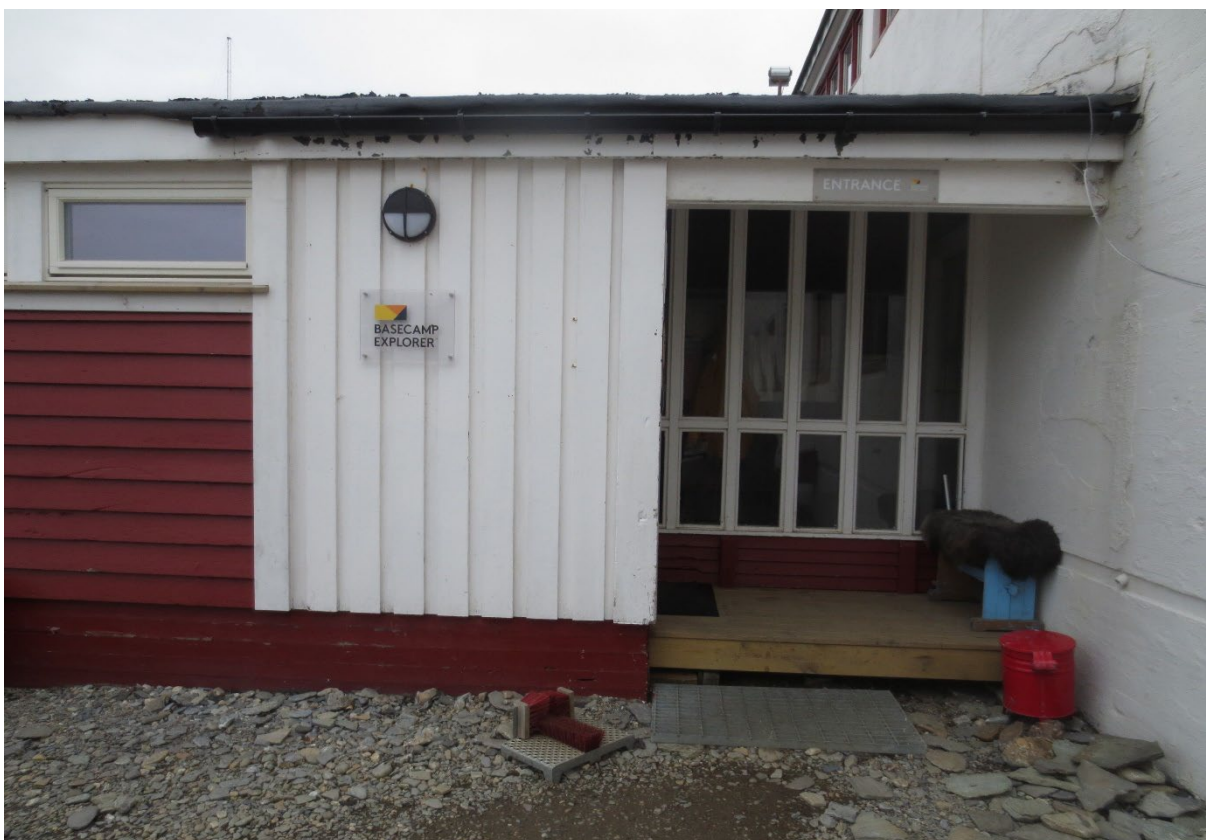
Figur 38: Inngangsparti. Foto: Siri Hoem, Forsvarsbygg 2021.
