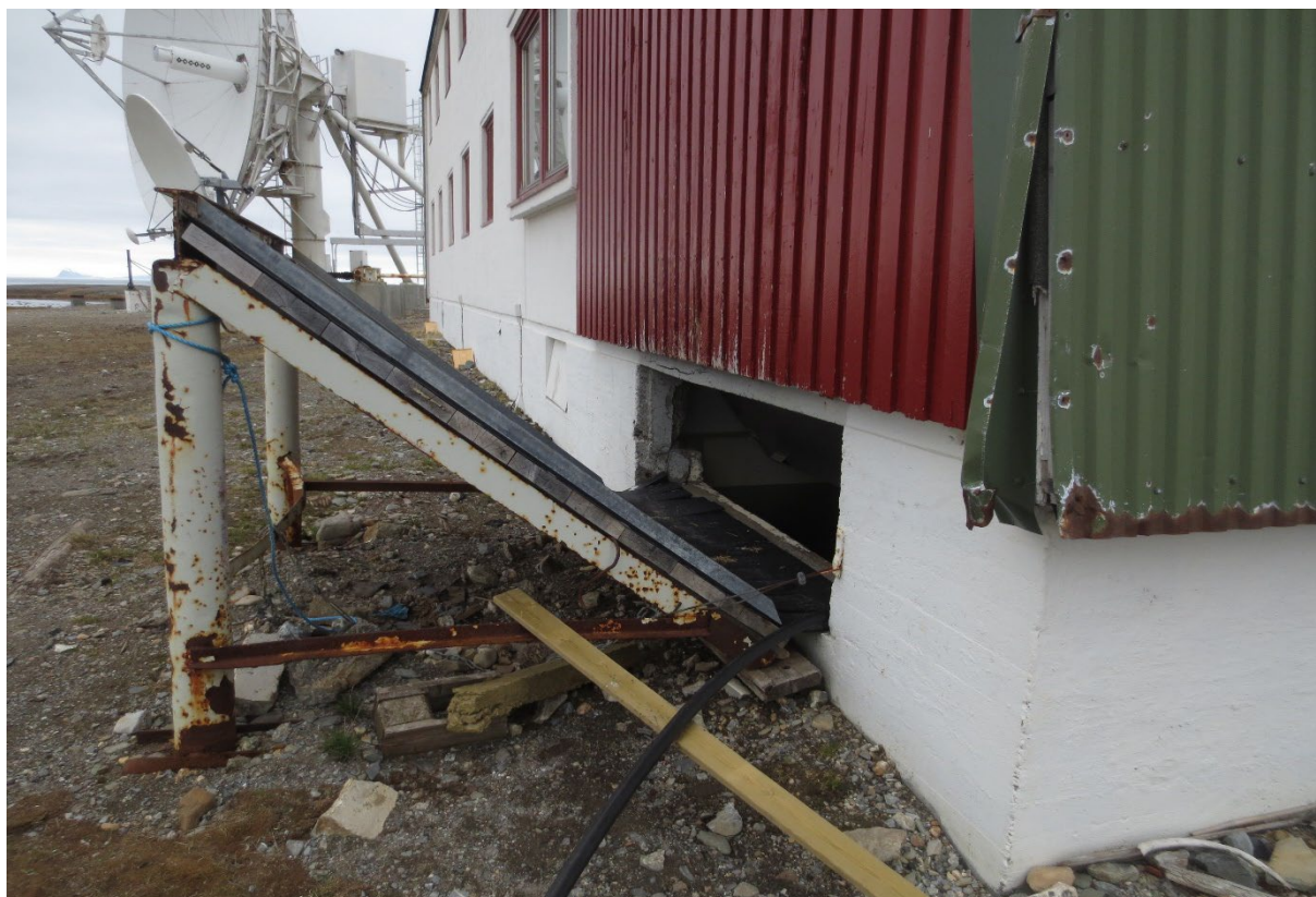
Figur 26: Hovedstasjonen, boligdel. Snøtippen med luke til vannbasseng i kjeller. Foto: Siri Hoem, Forsvarsbygg 2021.
