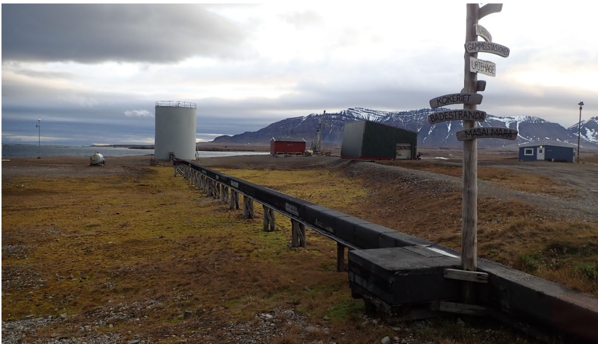
Figur 106: Dieseltanken, med rørgate over bakken. Liten drivstofftank til venstre i bildet er ikke omfattet av fredningen. Foto: Sysselmesteren på Svalbard, 2022.
