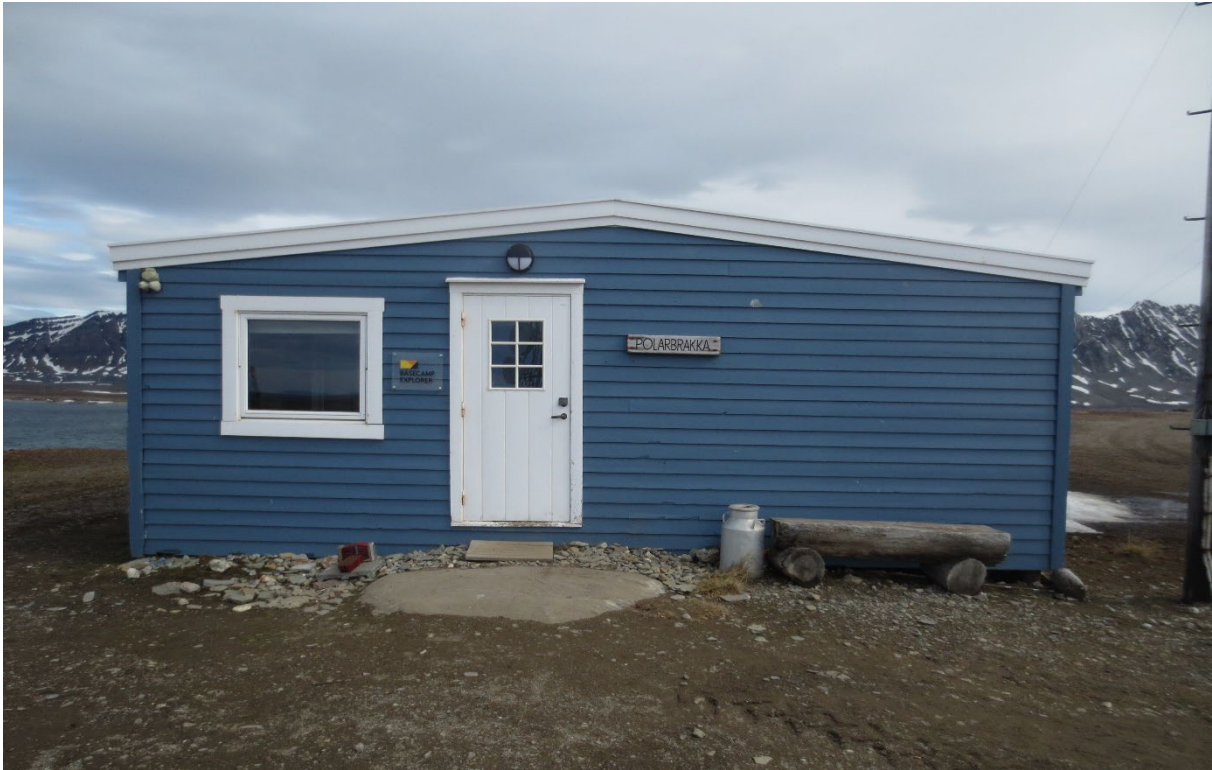
Figur 59: Polarbrakka. Fasade mot V. Foto: Siri Hoem, Forsvarsbygg 2021.
