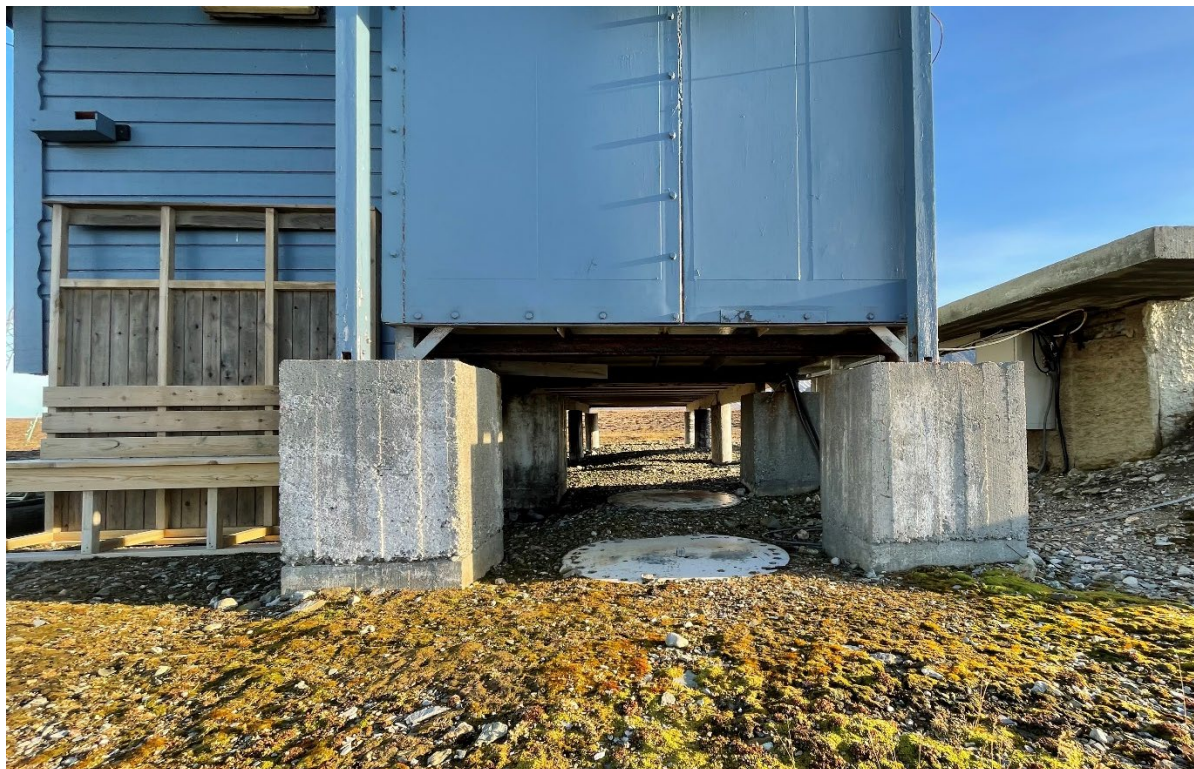
Figur 95: Detalj av fundamenter og fagverk i teknisk rom. Lukk for antennefester under bygningen. Foto: Sysselmesteren på Svalbard 2022.
