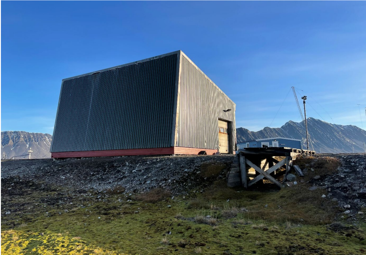
Figur 69: Båthuset, fra NV. I forgrunn ses bro/kulvertkonstruksjon i oppbygd trase for tidligere skinnegang til garasjen i hovedstasjonen. Foto: Monika Serafinska, Sysselmasteren på Svalbard 2022.
