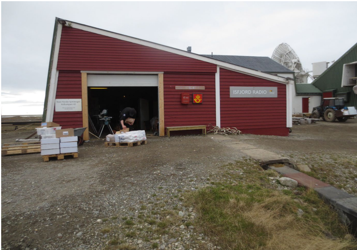
Figur 107: Rørgate fra dieseltanken går inn i Hovedstasjonen. De siste meterne ligger konstruksjonen i bakken. Foto: Sysselmesteren på Svalbard, 2022.
