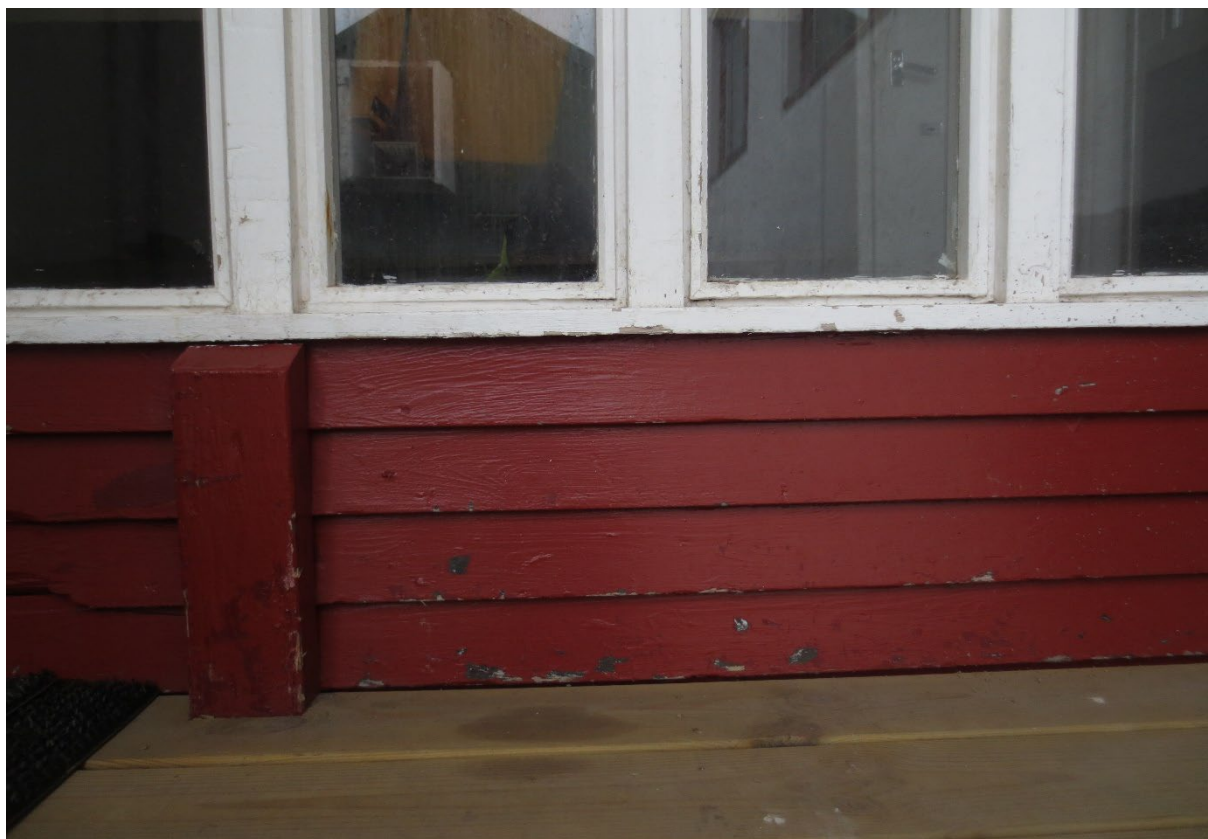
Figur 42: Detalj fra vinduer i inngangsparti. Foto: Siri Hoem, Forsvarsbygg 2021.
