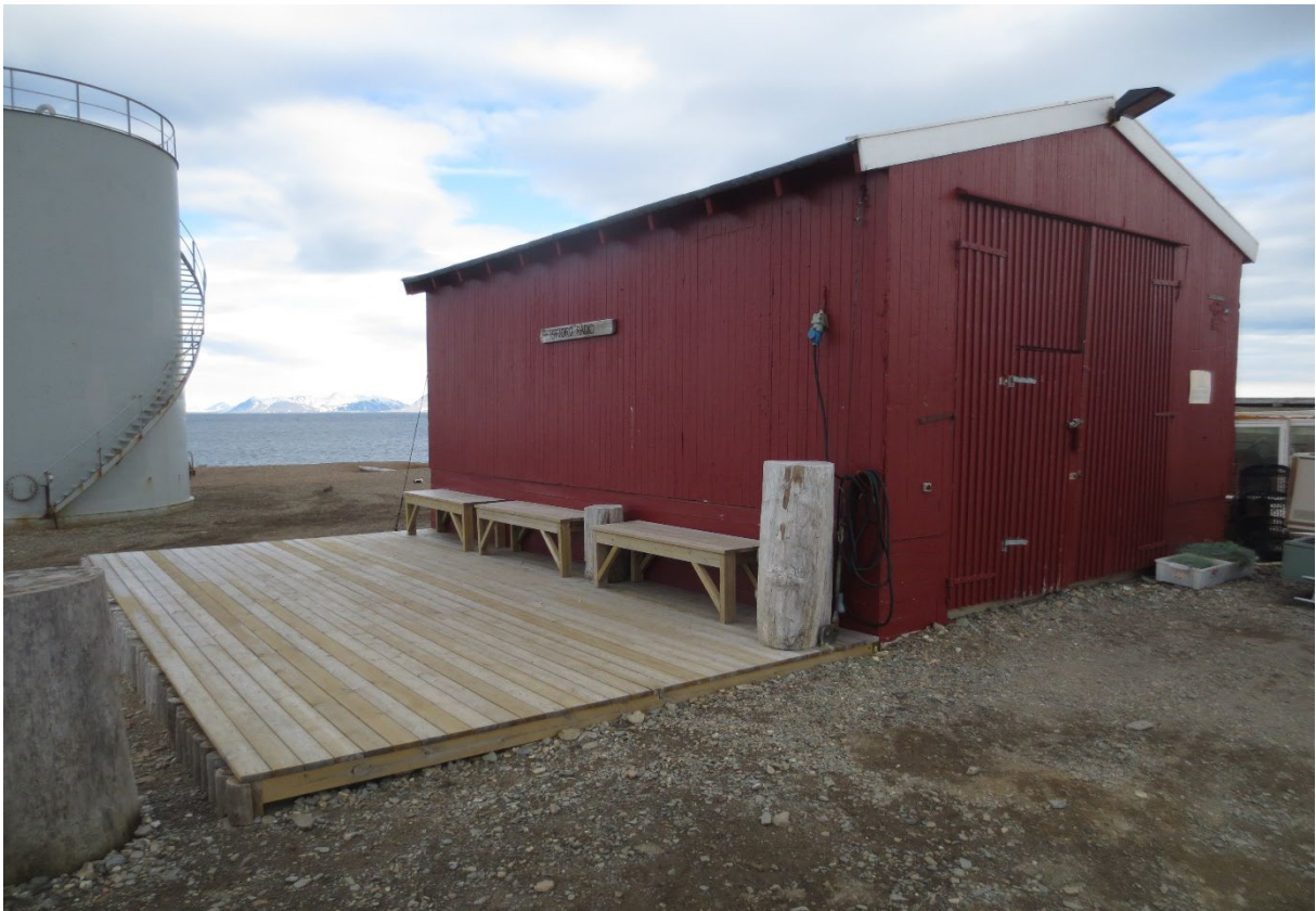
Figur 77: Naustet. Fasade mot SV (langvegg) og SØ (gavl). I langvegg ses blendet døråpning som gikk ut av bruk da bygningen ble hevet. Nyere platting (ikke fredet). Foto: Siri Hoem, Forsvarsbygg 2021.
