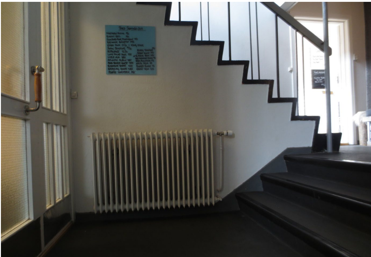
Figur 28: Hovedstasjonen, boligdel. Trapperom 1. etasje, inngangsparti fra kjøkkendel. Foto: Siri Hoem, Forsvarsbygg 2021.
