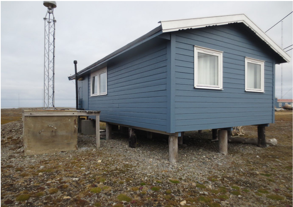
Figur 94: Telenorhytta. Fasade mot S (langvegg) og Ø (gavl). Foto: Siri Hoem, Forsvarsbygg 2021.
