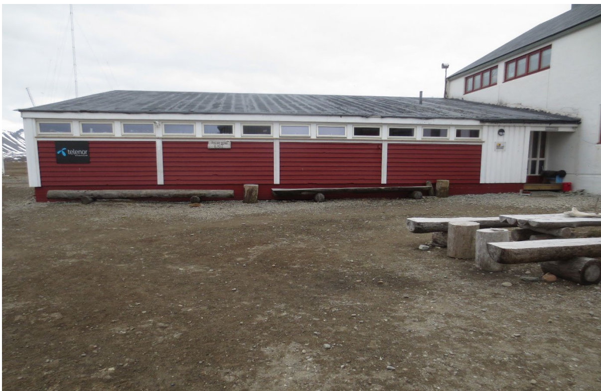
Figur 37: Fasade mot NV, mot gårdsrom. Til høyre ses inngangsparti og deler av boligdelen. Foto: Siri Hoem, Forsvarsbygg 2021.
