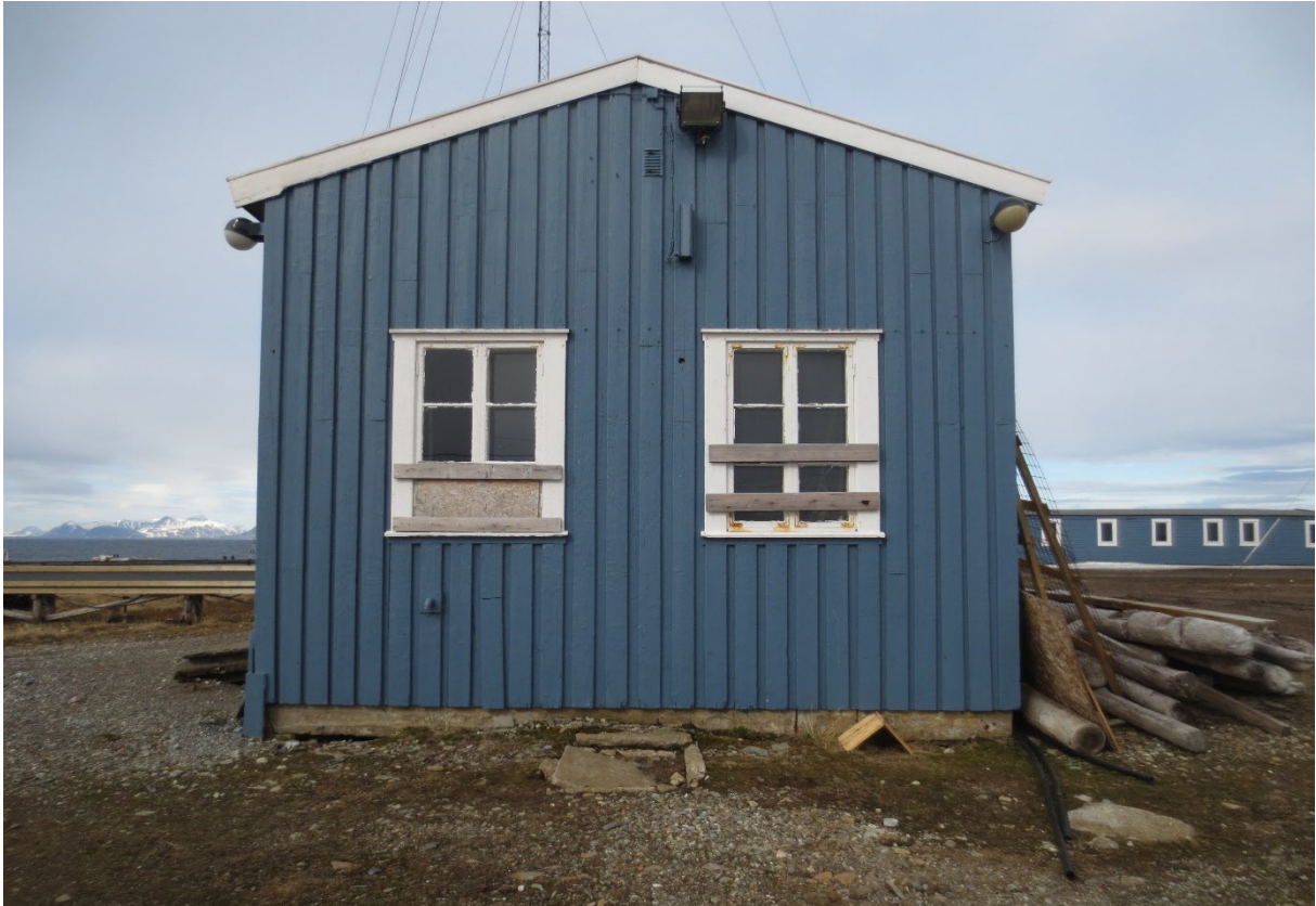
Figur 82: Sondebrakka. Fasade mot S. Den synlige delen er tilbygg fra 1956. Lamper/lyskupler i hjørnene inngår i fredningen. Foto: Siri Hoem, Forsvarsbygg 2021.
