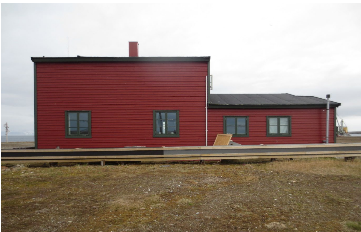
Figur 49: Gammelstasjonen. Fasade mot S. Rømningsstige i overgang mellom hoveddel og sidebygg. Lufting fra septikk/toalett helt til høyre på sidebygg. I forkant av bildet ses rørgate for vann fra hovedstasjonen til Gammelstasjonen og Sondebrakka. Foto: Siri Hoem, Forsvarsbygg 2021.
