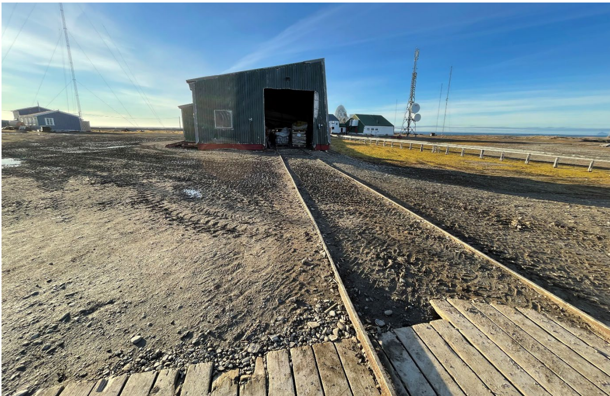
Figur 68: Båthuset, fra sjøsiden. Med skinnegang til brygge/- sjøområdet. Foto: Monika Serafinska, Sysselmasteren på Svalbard 2022.
