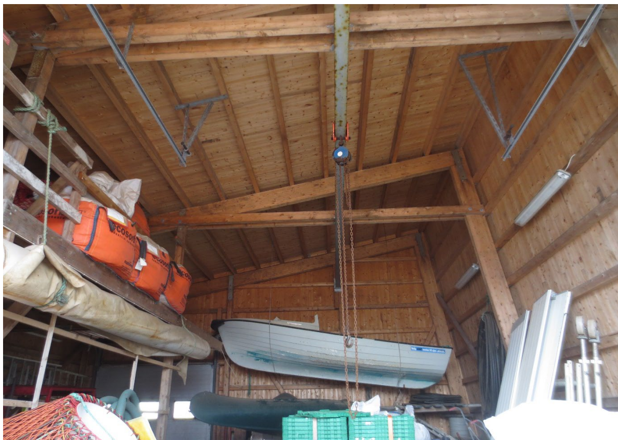
Figur 71: Båthuset, innvendig. Tak- og veggkonstruksjon av limtredragere. Foto: Siri Hoem, Forsvarsbygg 2021.
