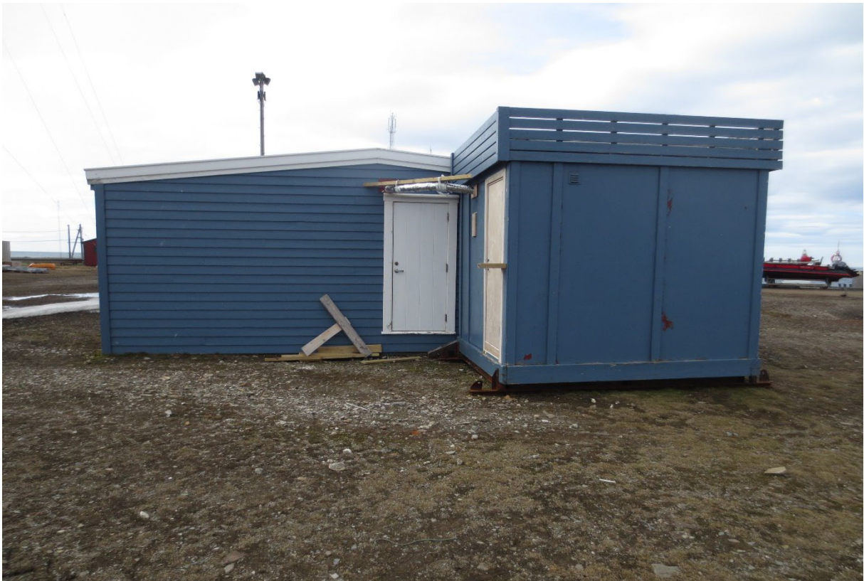
Figur 62: Polarbrakka. Fasade mot Ø. Til høyre er tilbygd rom for septik (ikke fredet). Foto: Siri Hoem, Forsvarsbygg 2021.
