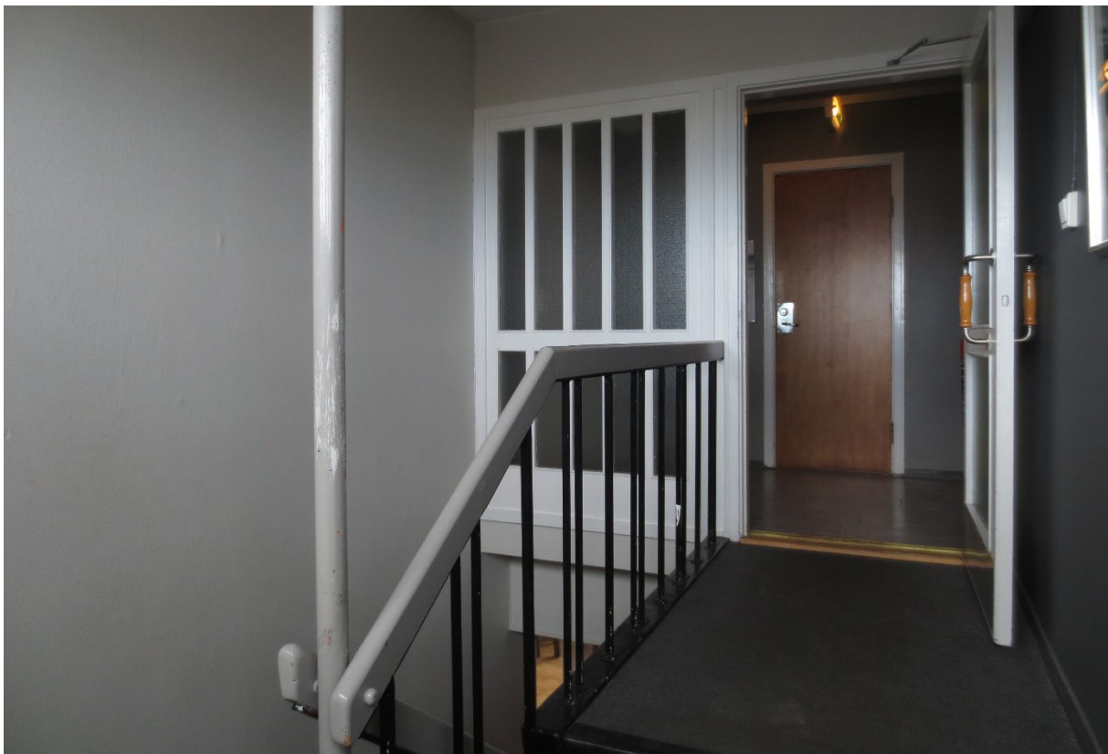
Figur 30: Hovedstasjonen, boligdel. Trapperom 2. etasje, N. Foto: Siri Hoem, Forsvarsbygg 2021.
