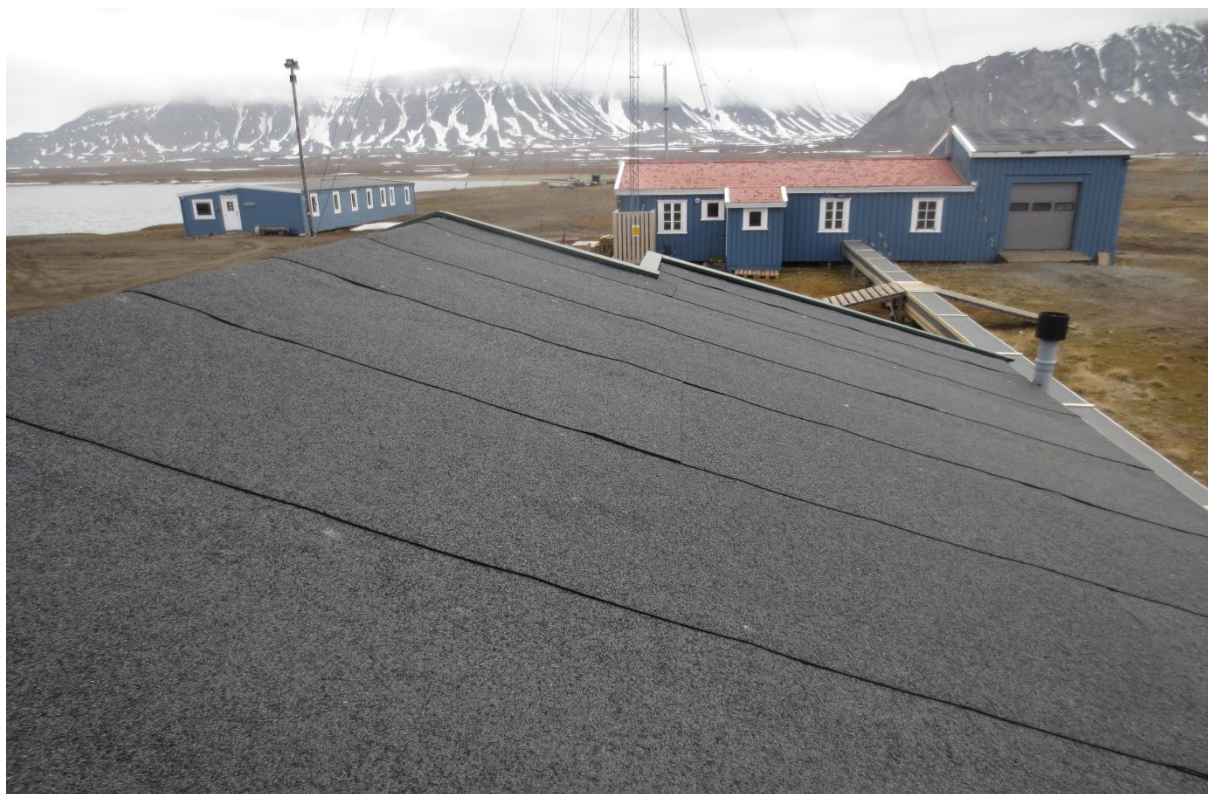
Figur 56: Gammelstasjonen. Tak på sidebygning. Foto mot Ø. Foto: Siri Hoem, Forsvarsbygg 2021.
