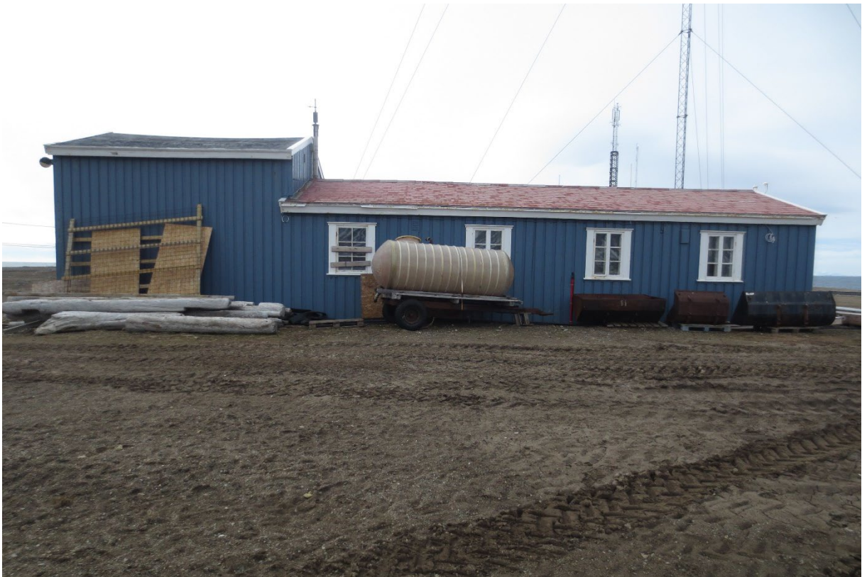
Figur 83: Sondebrakka. Fasade mot Ø. Foto: Siri Hoem, Forsvarsbygg 2021.
