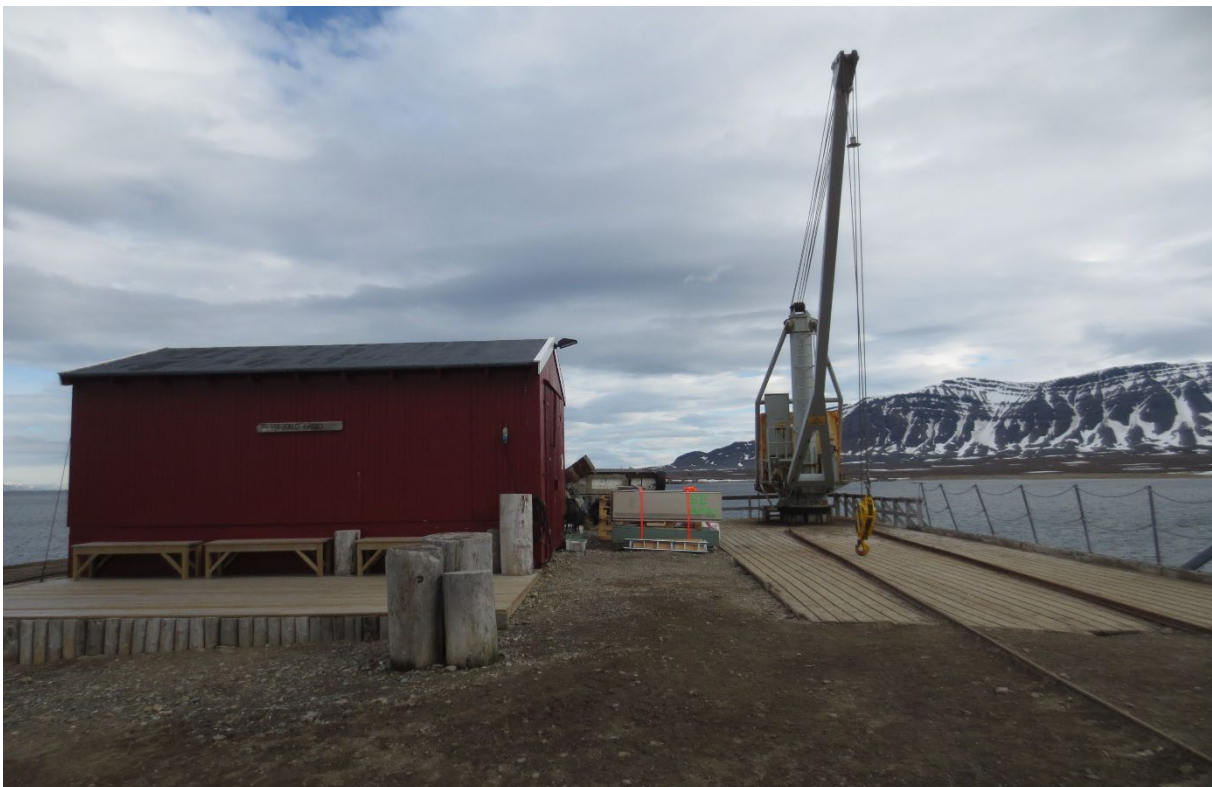
Figur 73: Naustet. Foto: Siri Hoem, Forsvarsbygg 2021.
