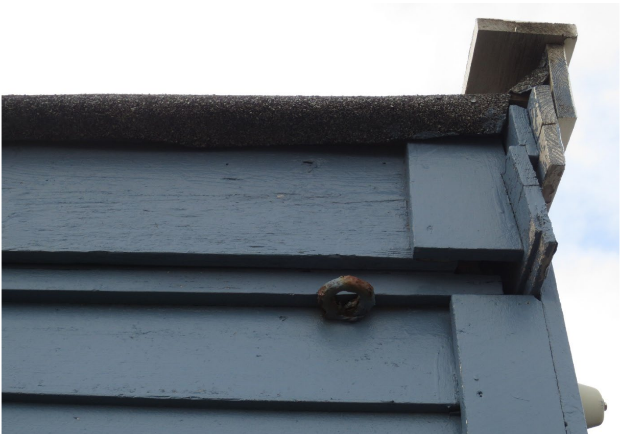
Figur 64: Polarbrakka. Detalj hjørne NV. Feste for bardunering. Foto: Siri Hoem, Forsvarsbygg 2021.
