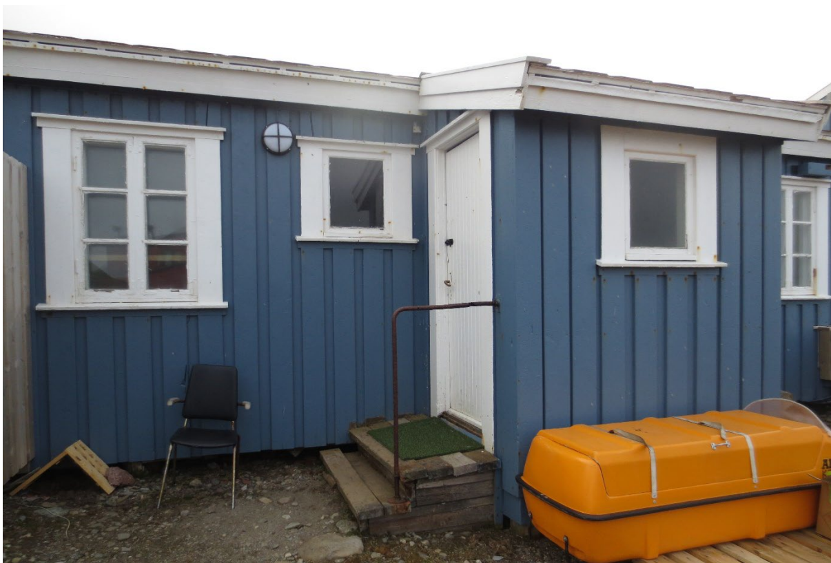
Figur 85: Sondebrakka. Bislag med inngangsdør og trapperekkverk. Foto: Siri Hoem, Forsvarsbygg 2021.
