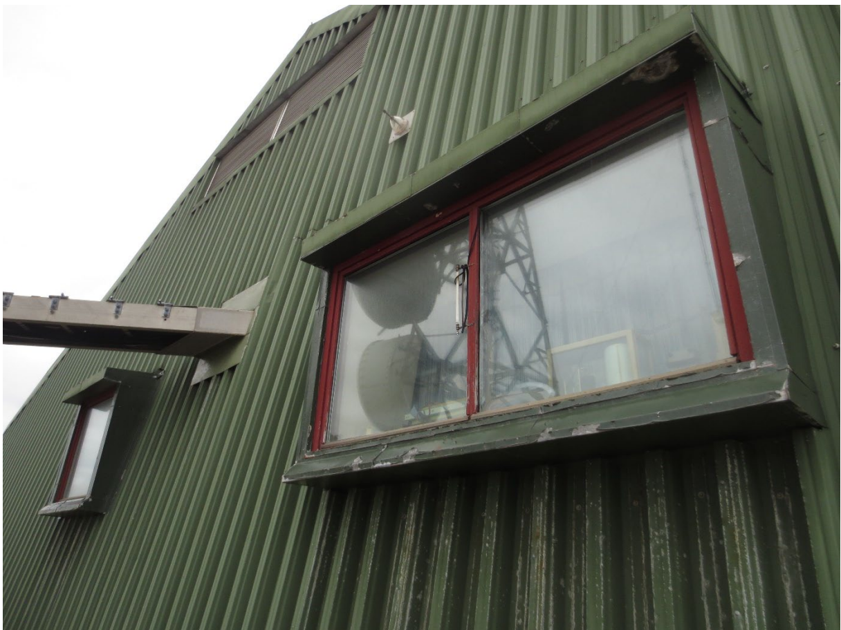
Figur 15: Detalj av gavlvegg NV, med vinduer i utkragede blikkleddede kasser/bokser. Foto: Siri Hoem, Forsvarsbygg 2021.
