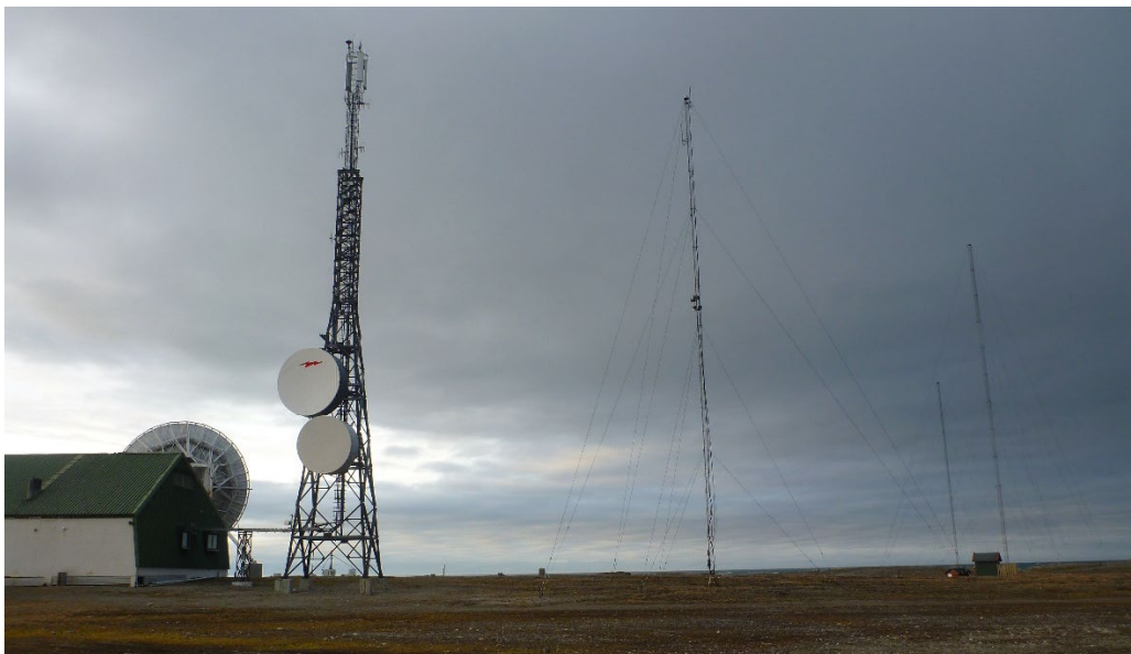
Figur 111: Antennemasta på Isfjord radio. De to store parabolantenne, samt toppantenne, som er festet på masta er ikke omfattet av fredningen. De tre fagverksmastene med barduner er ikke omfattet av fredningen. Foto: Sysselmesteren på Svalbard, 2022.
