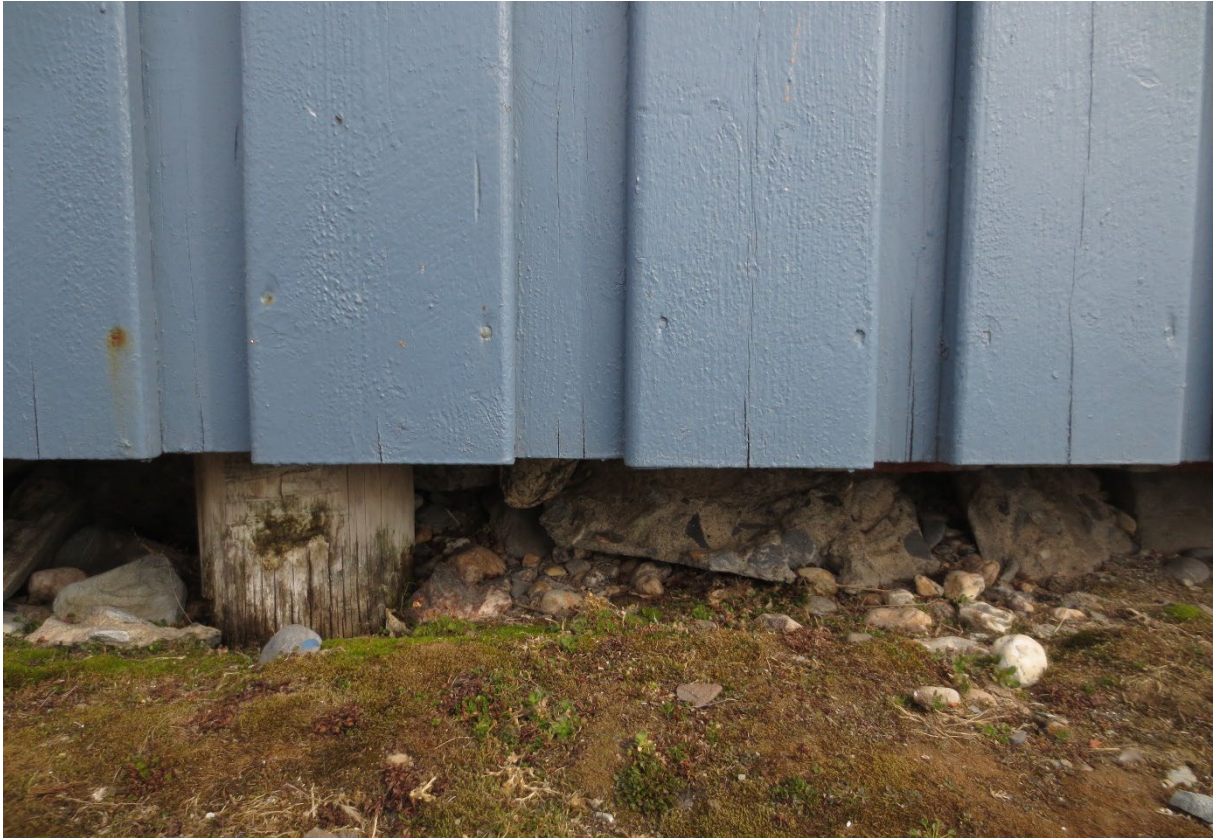
Figur 86: Sondebrakka. Detalj kledning og fundament. Foto: Siri Hoem, Forsvarsbygg 2021.
