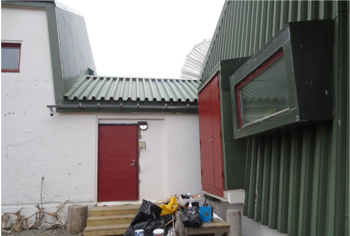
Figur 10: Mellombygg, inngangsparti til teknisk del. Foto: Siri Hoem, Forsvarsbygg 2021.
