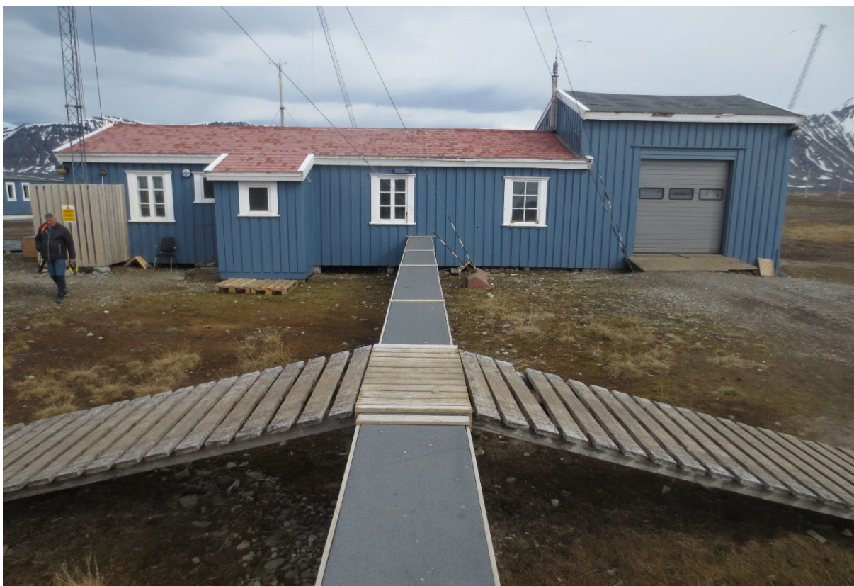
Figur 81: Sondebrakka. Fasade mot V. Rørgate for vannforsyning fra hovedstasjonen, med «rampe» for kryssing. Første
