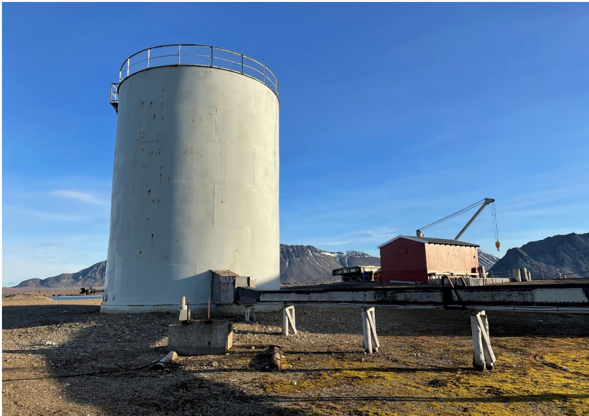
Figur 104: Dieseltanken, med rørgate over bakken. Foto: Sysselmesteren på Svalbard, 2022.
