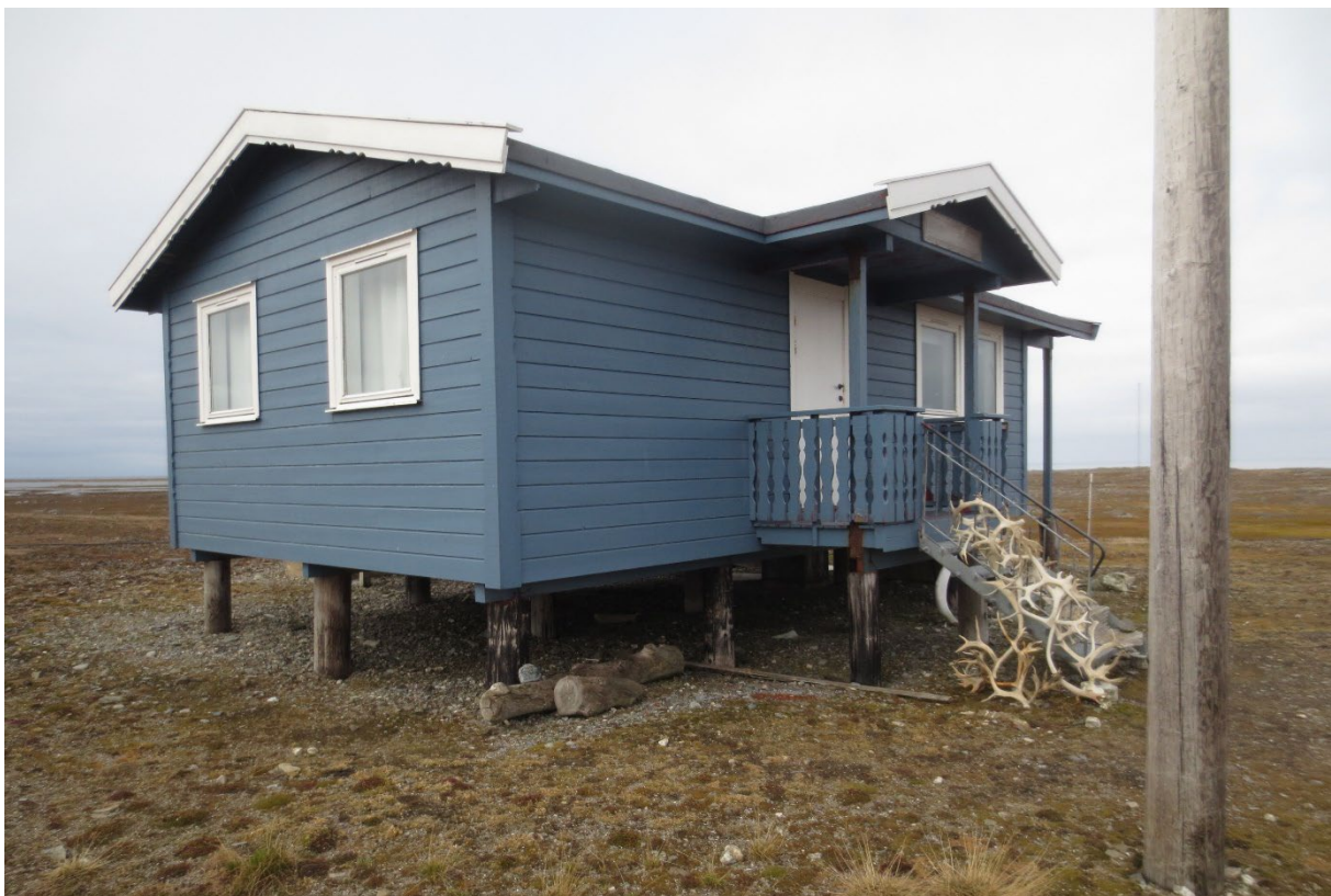
Figur 90: Telenorhytta. Foto mot SV. Foto: Siri Hoem, Forsvarsbygg 2021.
