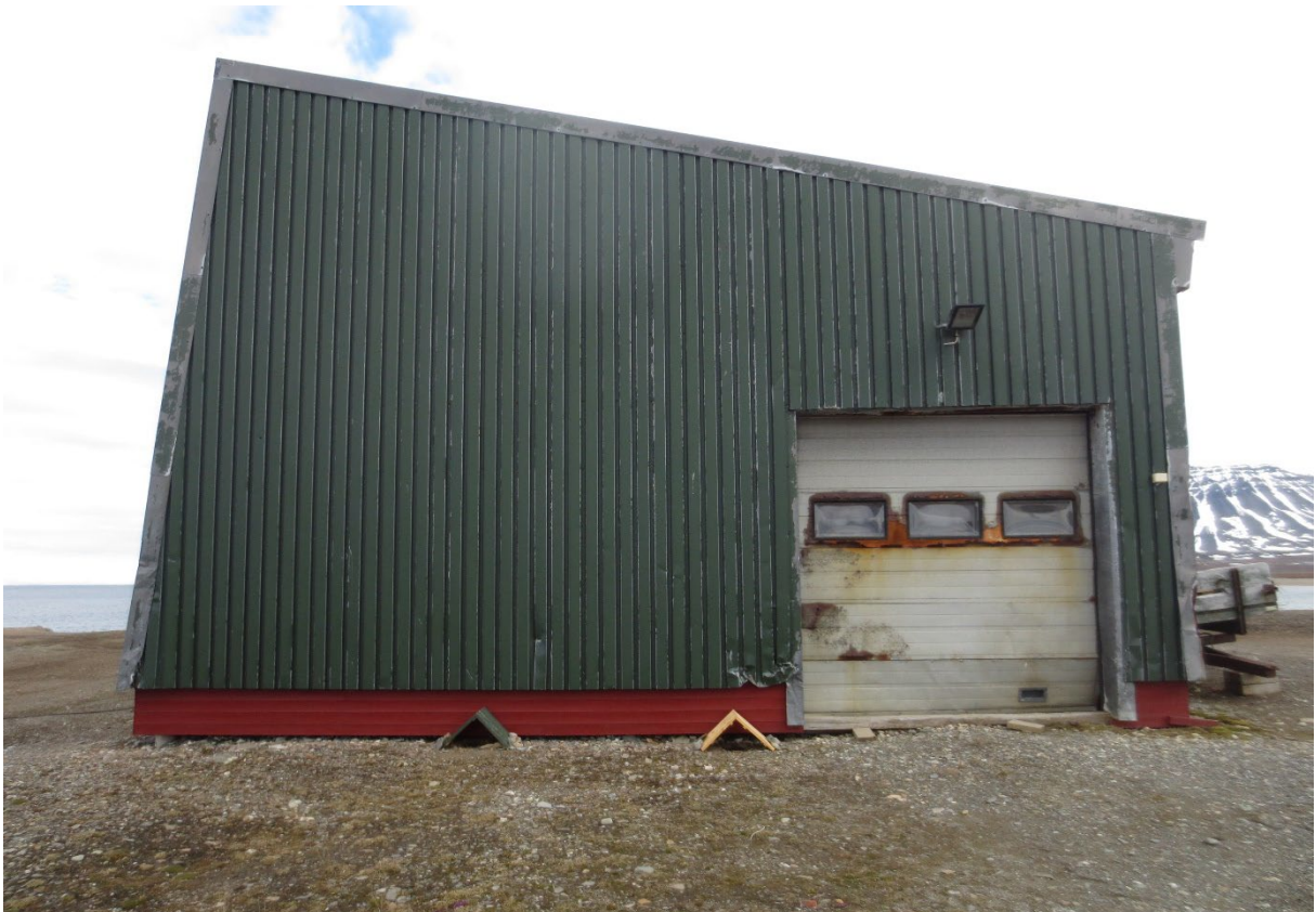
Figur 70: Båthuset. Fasade mot SV med port. Foto: Siri Hoem, Forsvarsbygg 2021.
