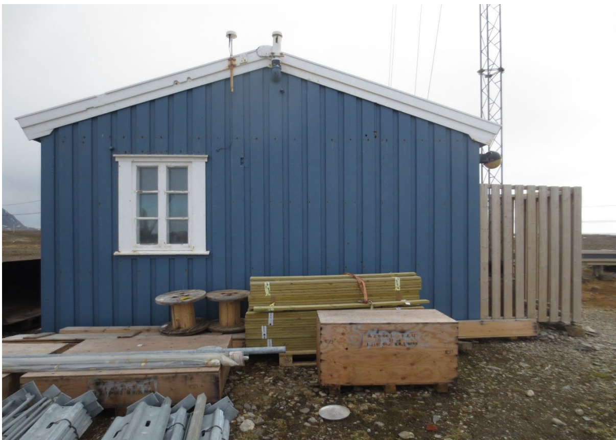
Figur 84: Sondebrakka. Fasade mot S. Den synlige delen av bygget er første byggetrinn (1946). Beskyttelsesgitter rundt mast til høyre er ikke omfattet av fredningen. Foto: Siri Hoem, Forsvarsbygg 2021.
