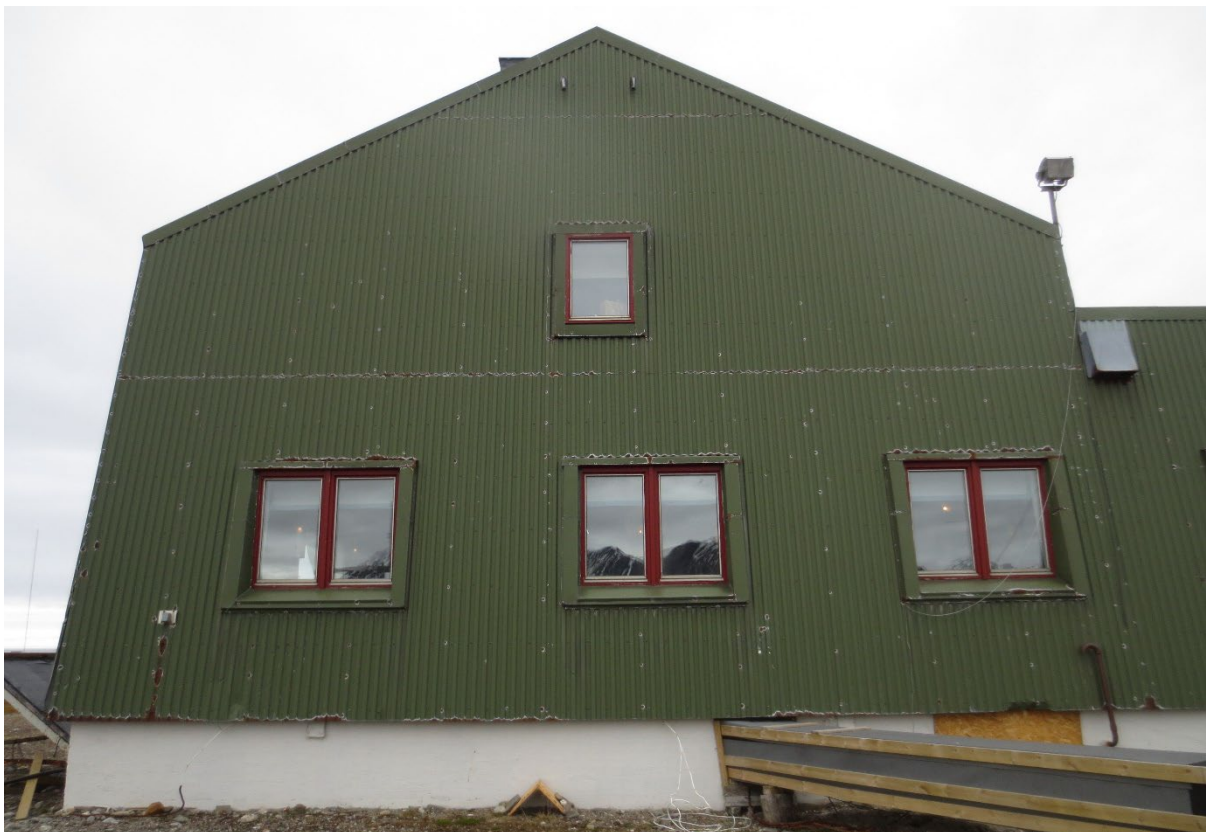
Figur 22: Hovedstasjonen, boligdel. Fasade SØ. Til høyre ses overgang til kjøkken- og garasjedel. Fra kjeller går rørgate for vann til Sondebrakka. Foto: Siri Hoem, Forsvarsbygg 2021.
