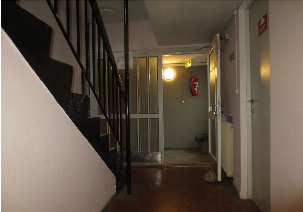
Figur 27: Hovedstasjonen, boligdel. Trapperom i 1. etasje. Mellombygg mot teknisk del til høyre. Foto: Siri Hoem, Forsvarsbygg 2021.
