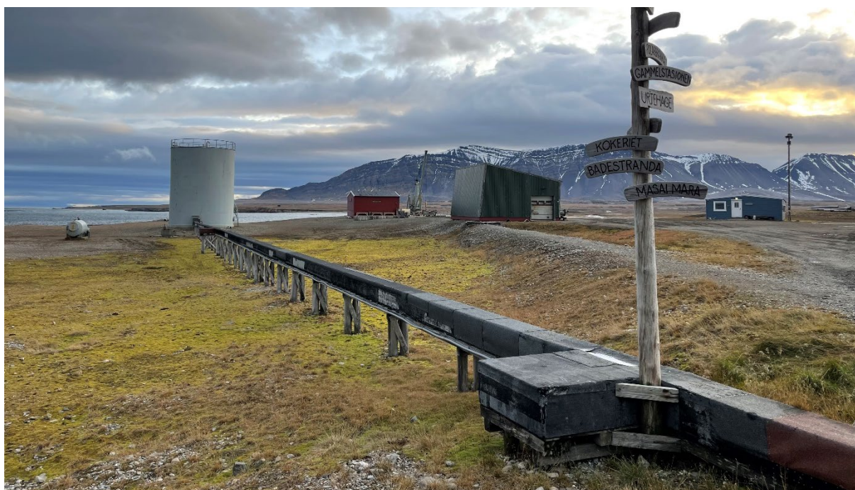
Figur 120: Oppbygd trasé for skinnegang ses som en rett «grusvoll» Båthuset. Foto: Sysselmesteren på Svalbard, 2022.
