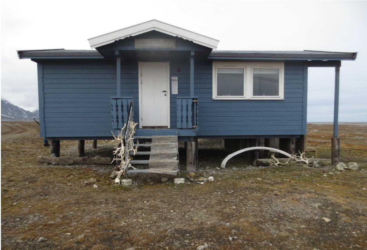
Figur 91: Telenorhytta. Fasade mot N. Foto: Siri Hoem, Forsvarsbygg 2021.
