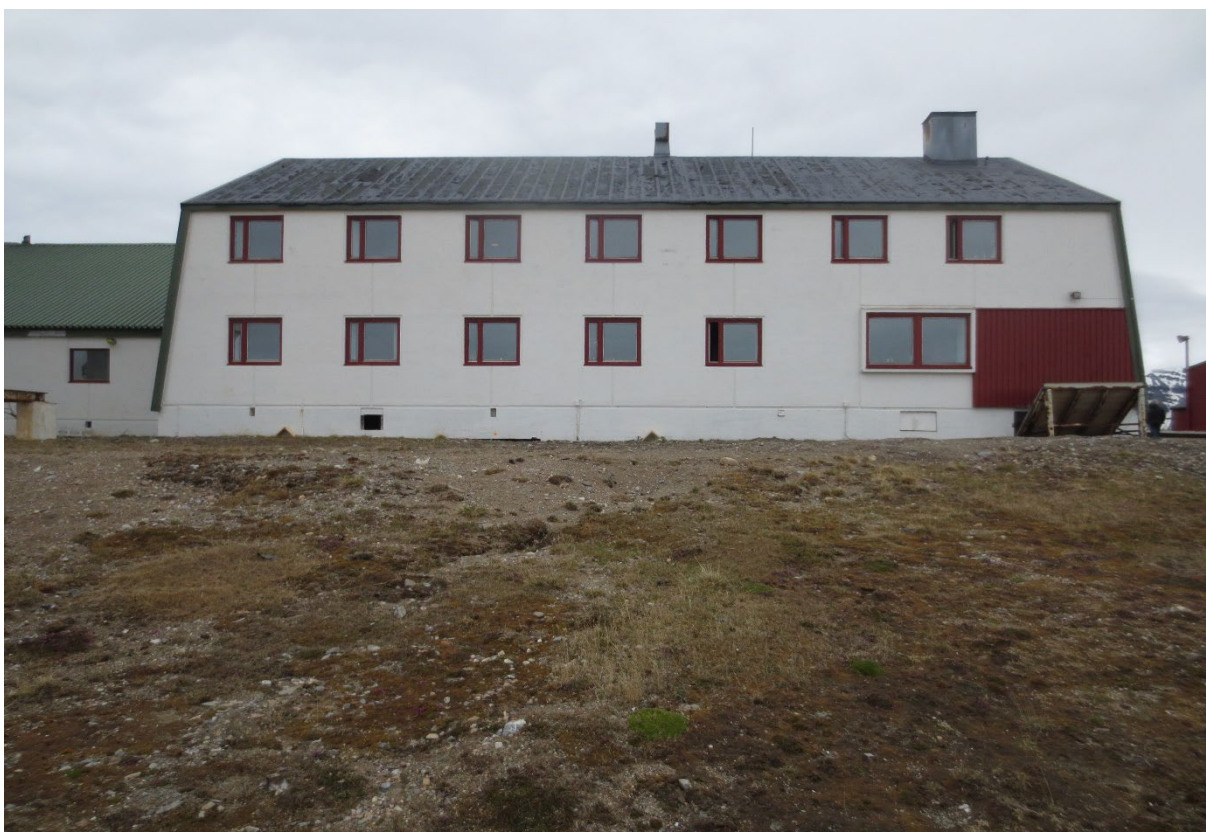
Figur 23: Hovedstasjonen, boligdel. Fasade SV. Til høyre ses snøtippen med felt med tømmermannskledning over. Foto: Siri Hoem, Forsvarsbygg 2021.
