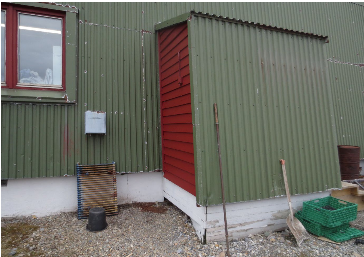
Figur 40: Bakside av bislag på fasade mot SØ. Foto: Siri Hoem, Forsvarsbygg 2021.
