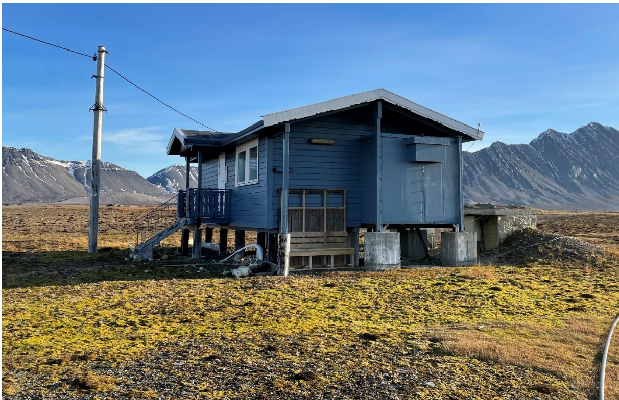
Figur 92: Telenorhytta. Fasade mot V (gavl). Teknisk rom med platekledning i halve byggets bredde til høyre. Foto: Sysselmesteren på Svalbard 2022.
