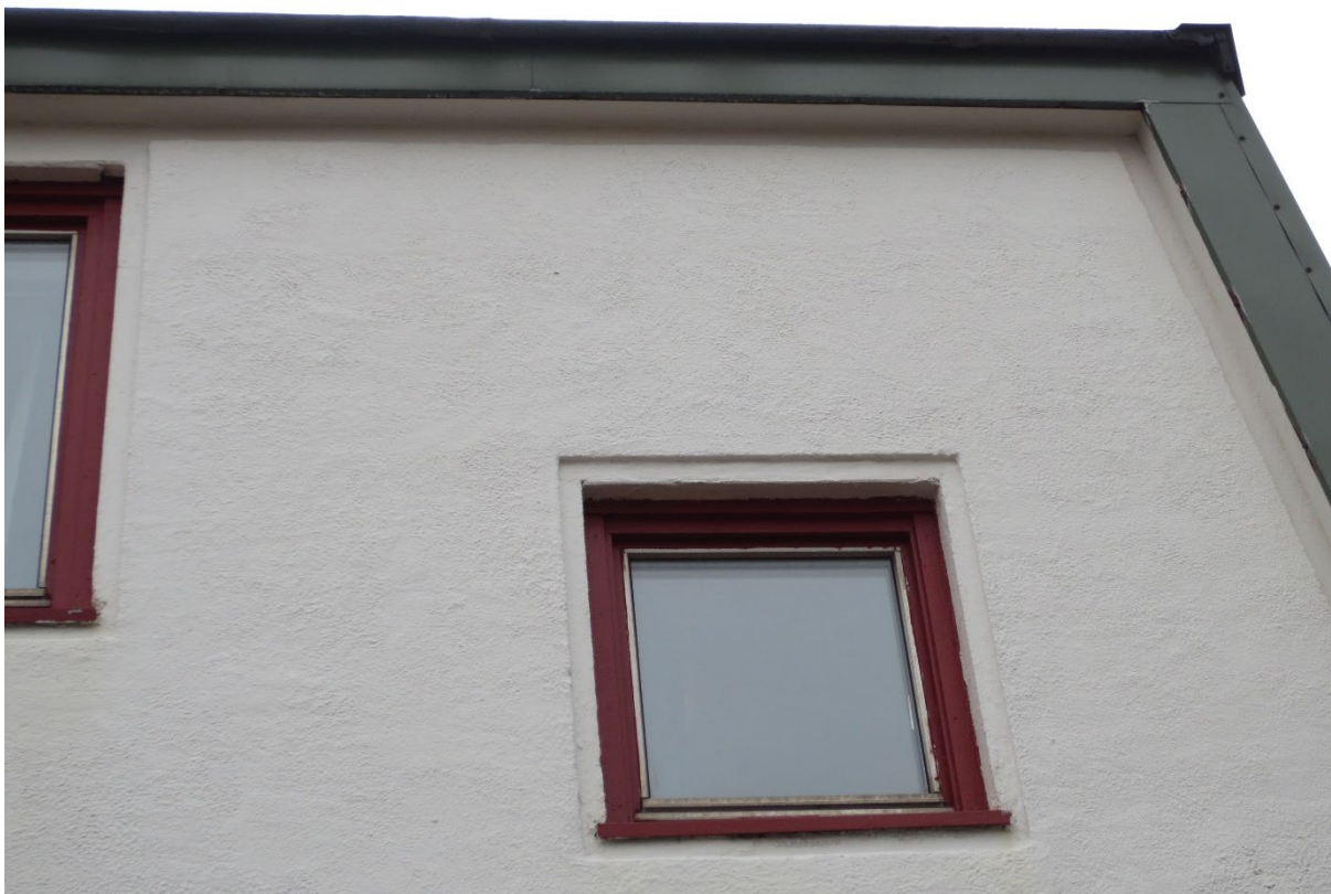
Figur 21: Hovedstasjonen, boligdel. Fasade mot gårdsrom (NØ), vindu i trappegang og dekor rundt vinduer og veggfelt. Foto: Siri Hoem, Forsvarsbygg 2021.
