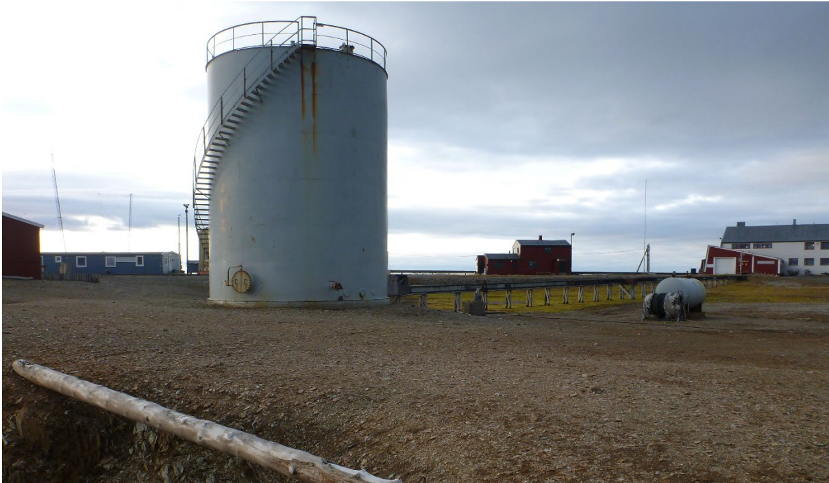
Figur 105: Dieseltanken, med rørgate over bakken. Liten drivstofftank til høyre i bildet er ikke omfattet av fredningen. Foto: Sysselmesteren på Svalbard, 2022.
