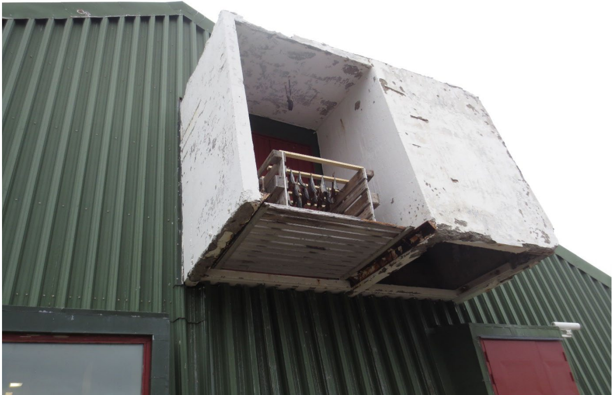
Figur 12: Detalj av gavlvegg SØ, med støpt utbygg med tilkomst til loft. Til venstre: åpen lasterampe. Til høyre: ventilasjonssjakt med åpning mot bakken. kabelgate. Foto: Siri Hoem, Forsvarsbygg 2021.
