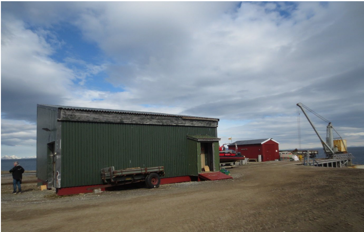
Figur 122: Båthuset med skinnegang ut på kaia til høyre i bildet. Foto: Siri Hoem, Forsvarsbygg 2021.
