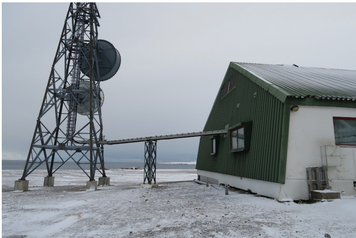
Figur 112: Nederste del av antennenårnet på Isfjord radio, med tilkobling til Hovedstasjonen. Foto: Maria Lytomt, Riksantikvaren 2021.
