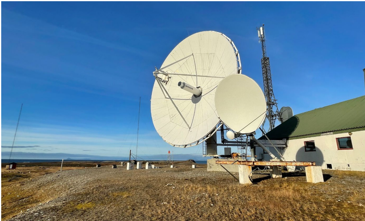
Figur 114: Parabolantenne på Isfjord radio. Den minste antenna er ikke omfattet av fredningen. Foto: Sysselmesteren på Svalbard, 2022.
