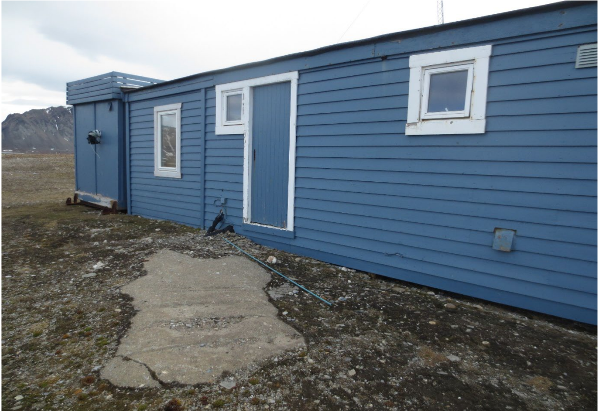
Figur 61: Polarbrakka. Fasade mot N. Østre del. Skille mellom opprinnelig bygningsvolum (1946) og senere påbygg (1959) går til høyre for dør, mellom dør og vindu til høyre. Lengst til venstre er tilbygd rom for septik (ikke fredet). Foto: Siri Hoem, Forsvarsbygg 2021.
