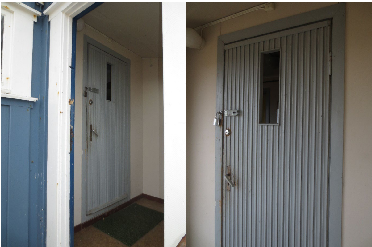
Figur 87: Sondebrakka. Dør i bislag. Tidligere inngangsdør, før bislaget ble bygget i 1956. Foto: Siri Hoem, Forsvarsbygg 2021.
