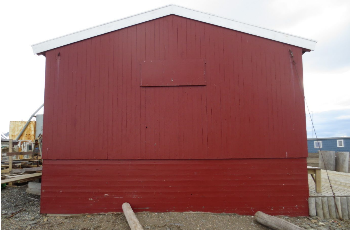
Figur 76: Naustet. Fasade mot NV. Blendet vindu under mønet. Stående bordkledning i opprinnelig del, liggende bordkledning på tilbygd del. Foto: Siri Hoem, Forsvarsbygg 2021.
