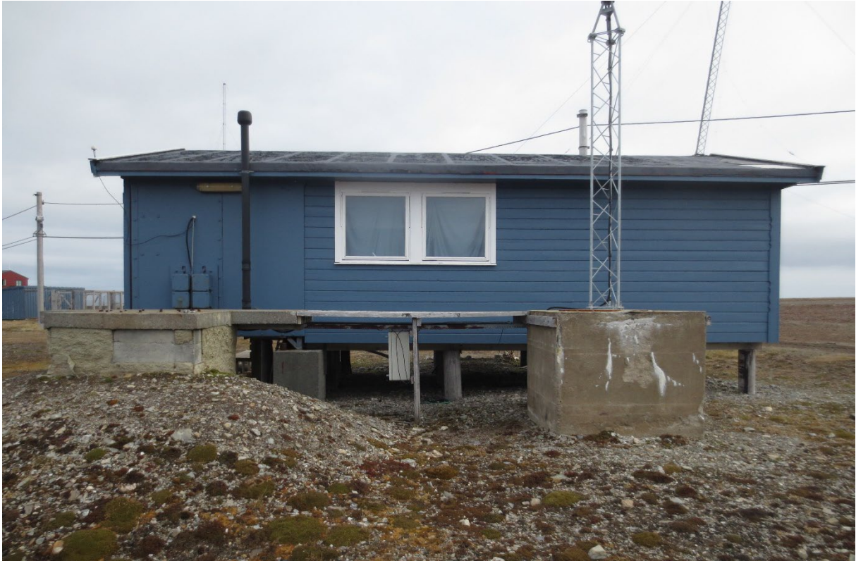
Figur 93: Telenorhytta. Fasade mot S. Teknisk rom med platekledning til venstre. Lufting fra toalett i svart rør langs vegg (ikke omfattet av fredningen). Foto: Siri Hoem, Forsvarsbygg 2021.
