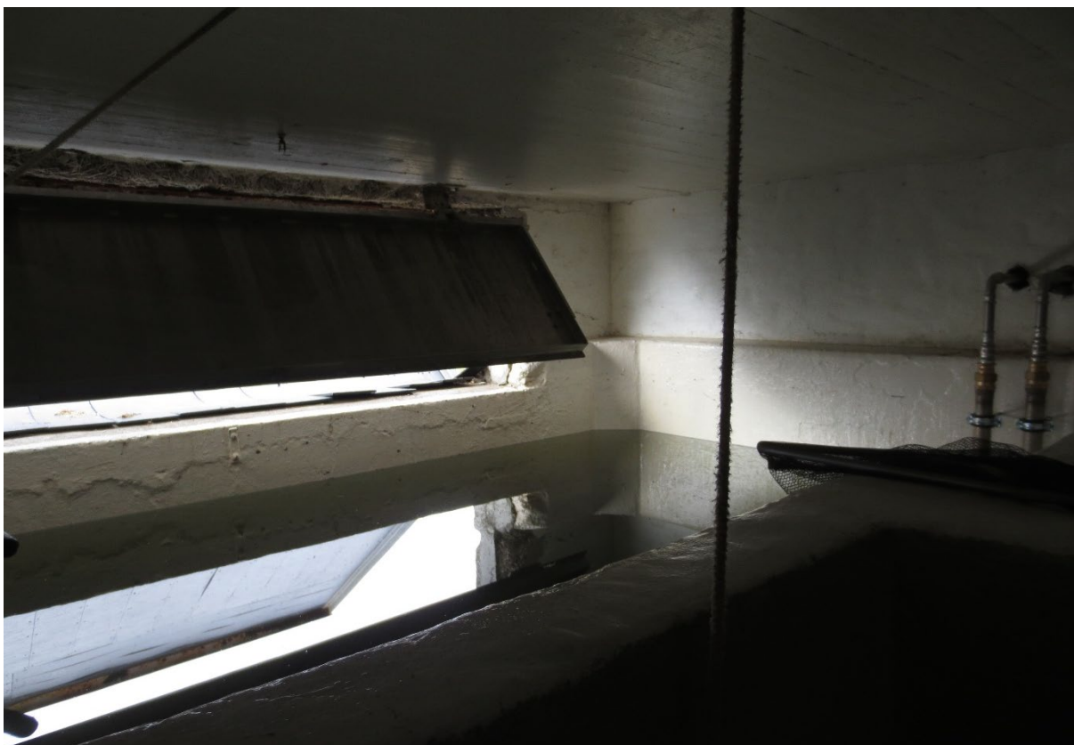
Figur 32: Hovedstasjonen, boligdel. Kjeller med vannkammer. Åpen luke mot snøtipp. Foto: Siri Hoem, Forsvarsbygg 2021.
