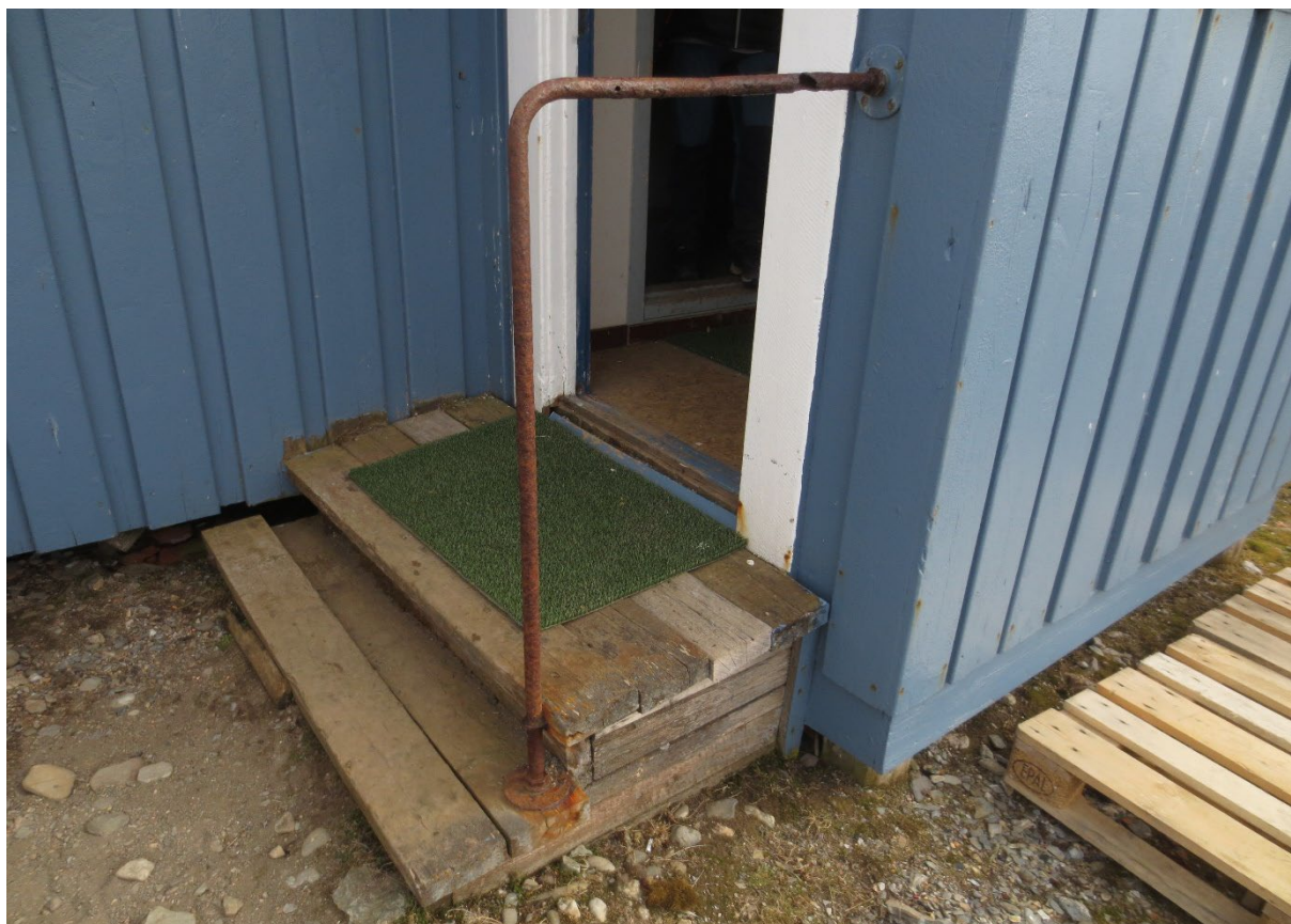
Figur 88: Sondebrakka. Detalj trapp og rekkverk ved inngang. Foto: Siri Hoem, Forsvarsbygg 2021.
