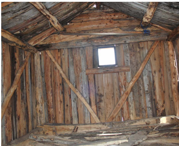
Den samme bygningen, sett innvendig. Båtbord gjenbrukt som taktro. Kautokeino.
