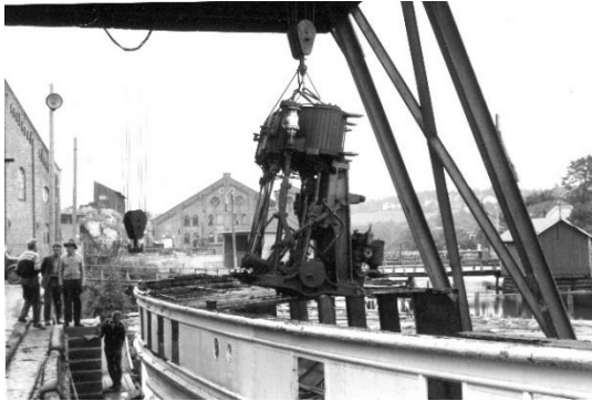
Maskinen heises ut av skroget sommer 1964.
