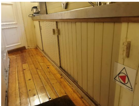
Skap under vasken – tidsriktig utførelse.
