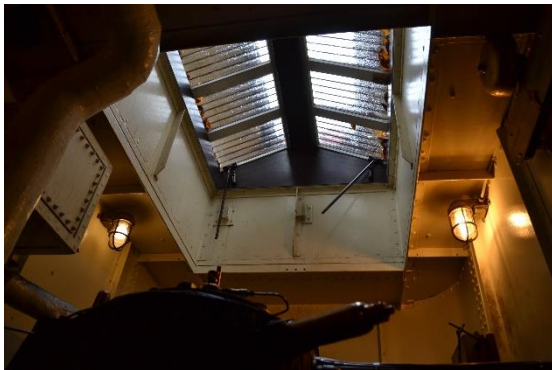
Skylight fra maskinen.
