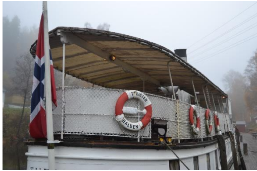
Innvendig stenderverk og dragere for baldakintak.
