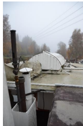
Skorsteinsgjennomføring fra oversiden mot «smørkassa».
