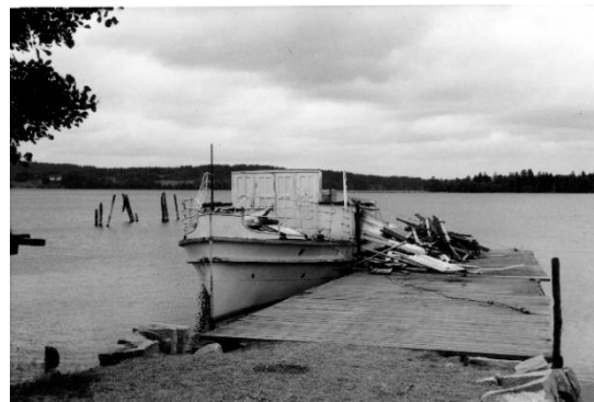
Rivningsarbeidet ved Bjørnstadbryggen, sommer 1964. Foto: Tore Paulsen-Næss
