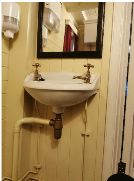
Tidsriktige kraner og vaskeservant.
