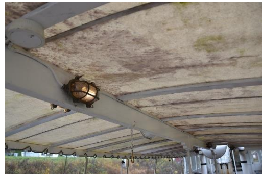
Baldakintak – seilduk mot akterenden.
