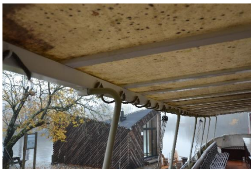
Stender, bjelkelag og dragere utvendig - baldakintak.
