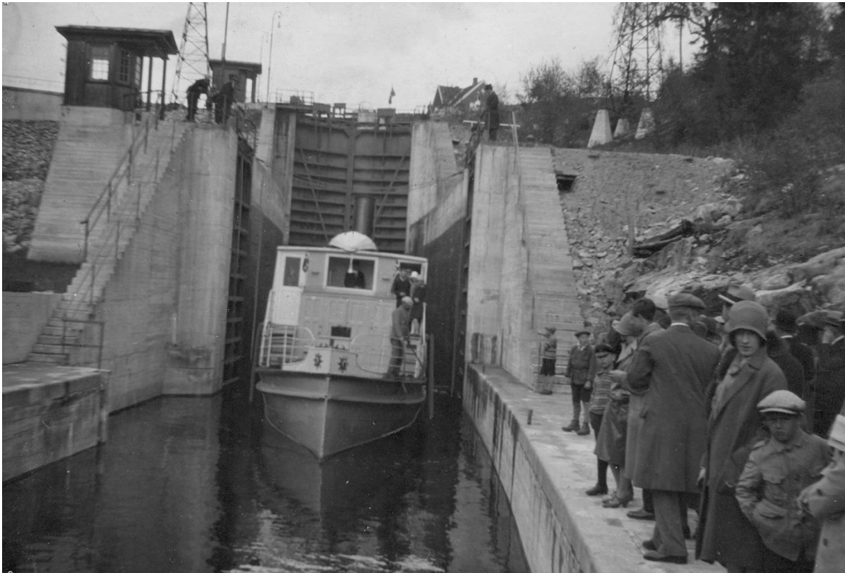
I Brekke sluser i 1927.
