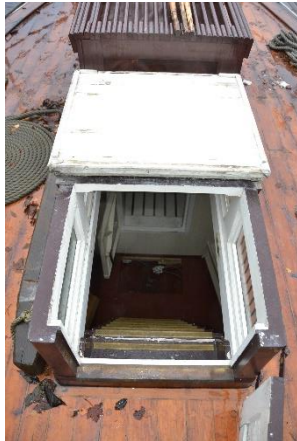
Nedgangskappe – mannskapslugarer forut.
