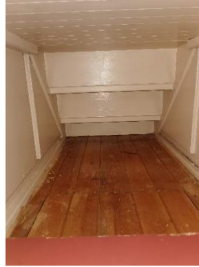
Dørk til ballast akterut. Leder fra promenadedekk ned til 1. klasse salong.
