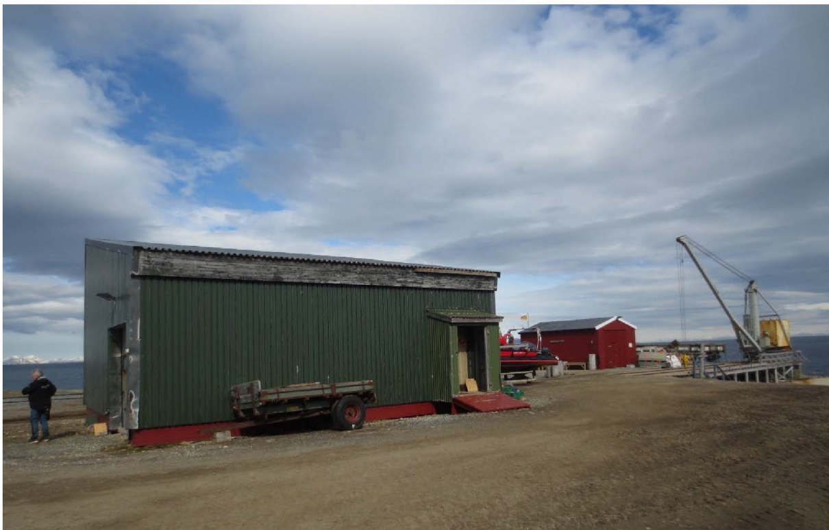
Figur 164: Båthuset med skinnegang ut på kaia til høyre i bildet. Foto: Siri Hoem, Forsvarsbygg 2021.
