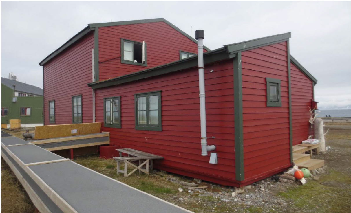
Figur 86: Gammelstasjonen. Rørgate for vann fra Hovedstasjonen. Foto mot NV. Foto: Siri Hoem, Forsvarsbygg 2021.
