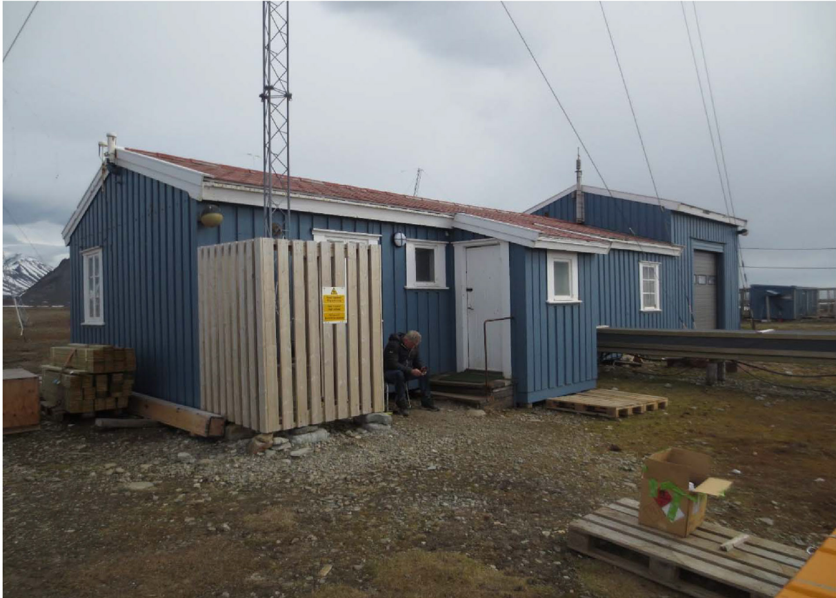
Figur 116: Sondebrakka. Foto mot SØ. Beskyttelsesgitter rundt mast er ikke omfattet av fredningen. Foto: Siri Hoem, Forsvarsbygg 2021.
