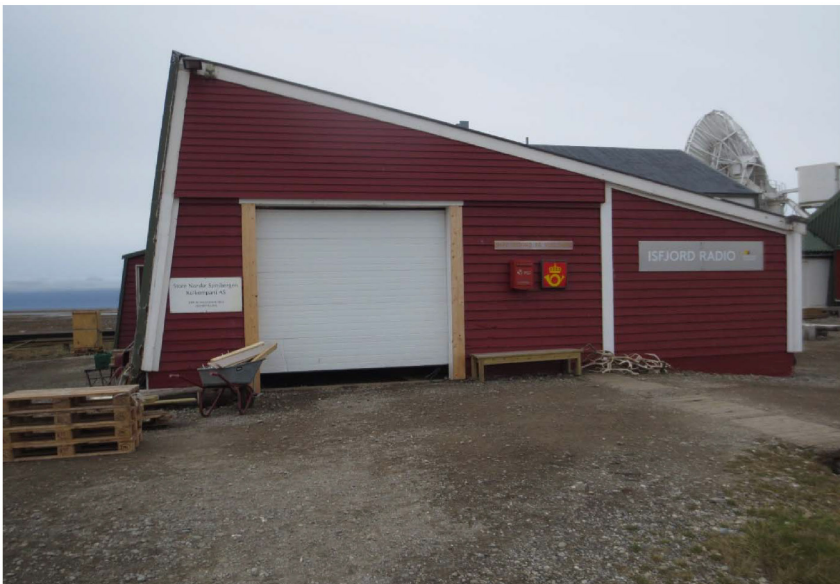
Figur 72: Fasade mot NØ, med garasjeport. Over garasjeporten har det opprinnelig vært vindusfelt. Til høyre i bildet, inn mot
