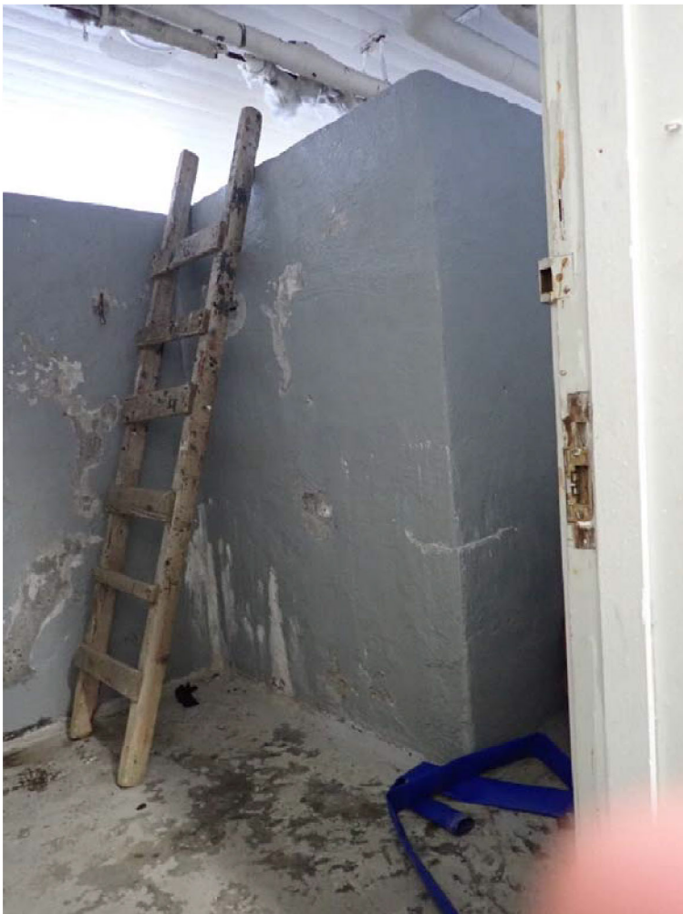
Figur 43: Vanntanker for snøsmelting. Foto: Sysselmesteren på Svalbard 2023.
