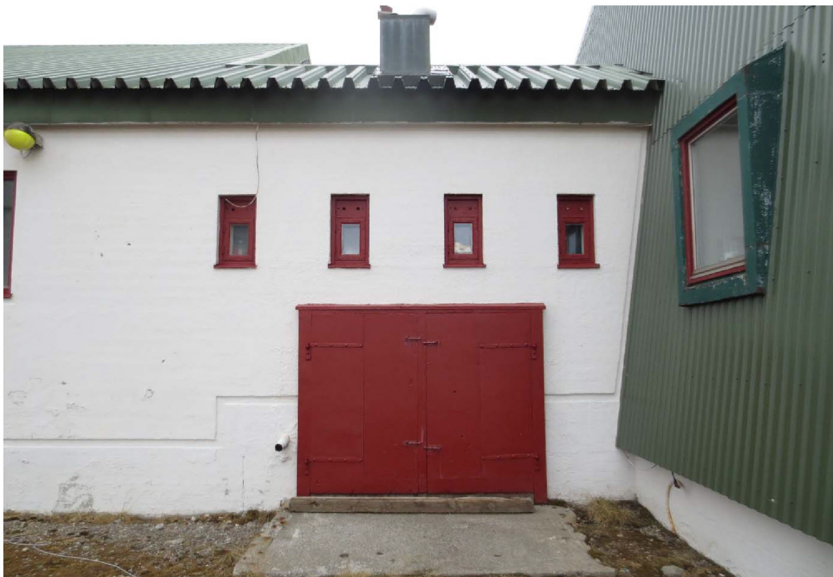
Figur 18: Del av fasade SV, med port i mellombygg. Foran porten ses støpt rampe/inngangsparti. Over porten er originale vinduer med ventilasjonsluke i øvre del av ramme. Helt til venstre er lampe som inngår i fredningen. Til høyre ses vindu i utkraget boks i boligdel. Foto: Siri Hoem, Forsvarsbygg 2021.
