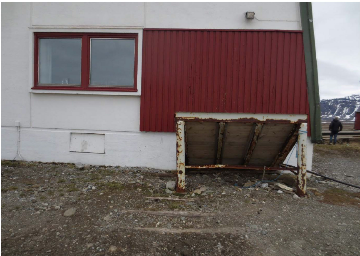
Figur 39: Hovedstasjonen, boligdel. Fasade SV. Snøtippen med felt med tømmermannskledning over. Foto: Siri Hoem, Forsvarsbygg 2021.
