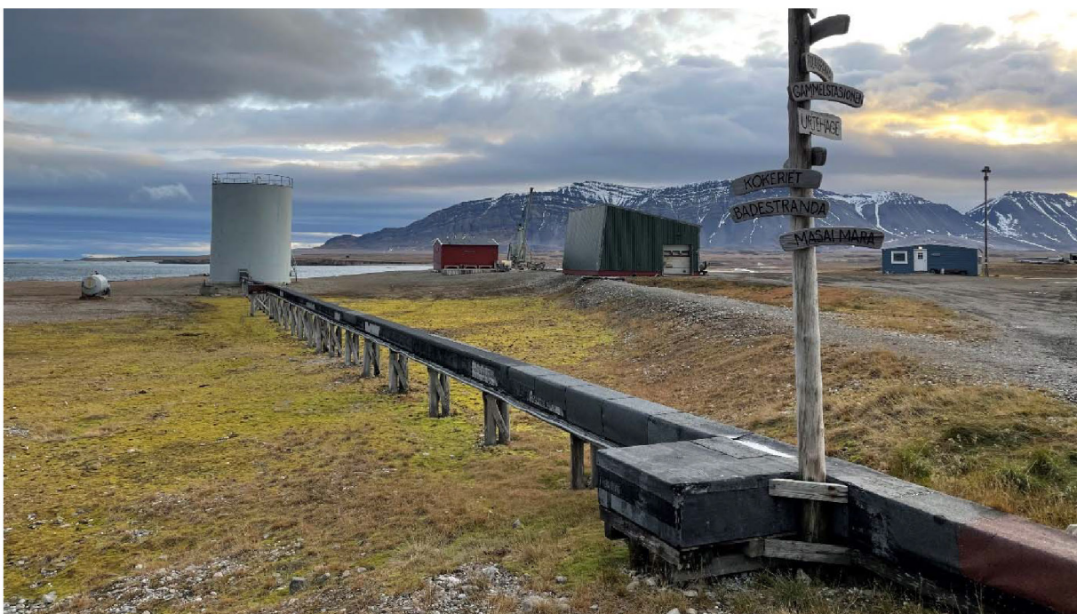
Figur 162: Oppbygd trasé for skinnegang ses som en rett «grusvoll» Båthuset. Foto: Sysselmesteren på Svalbard, 2022.
