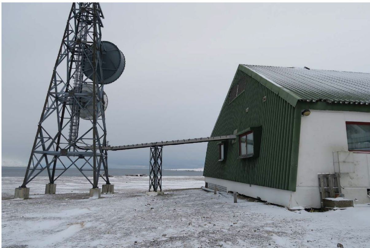
Figur 154: Nederste del av antennenårnet på Isfjord radio, med tilkobling til Hovedstasjonen. Foto: Maria Lytomt, Riksantikvaren 2021.
