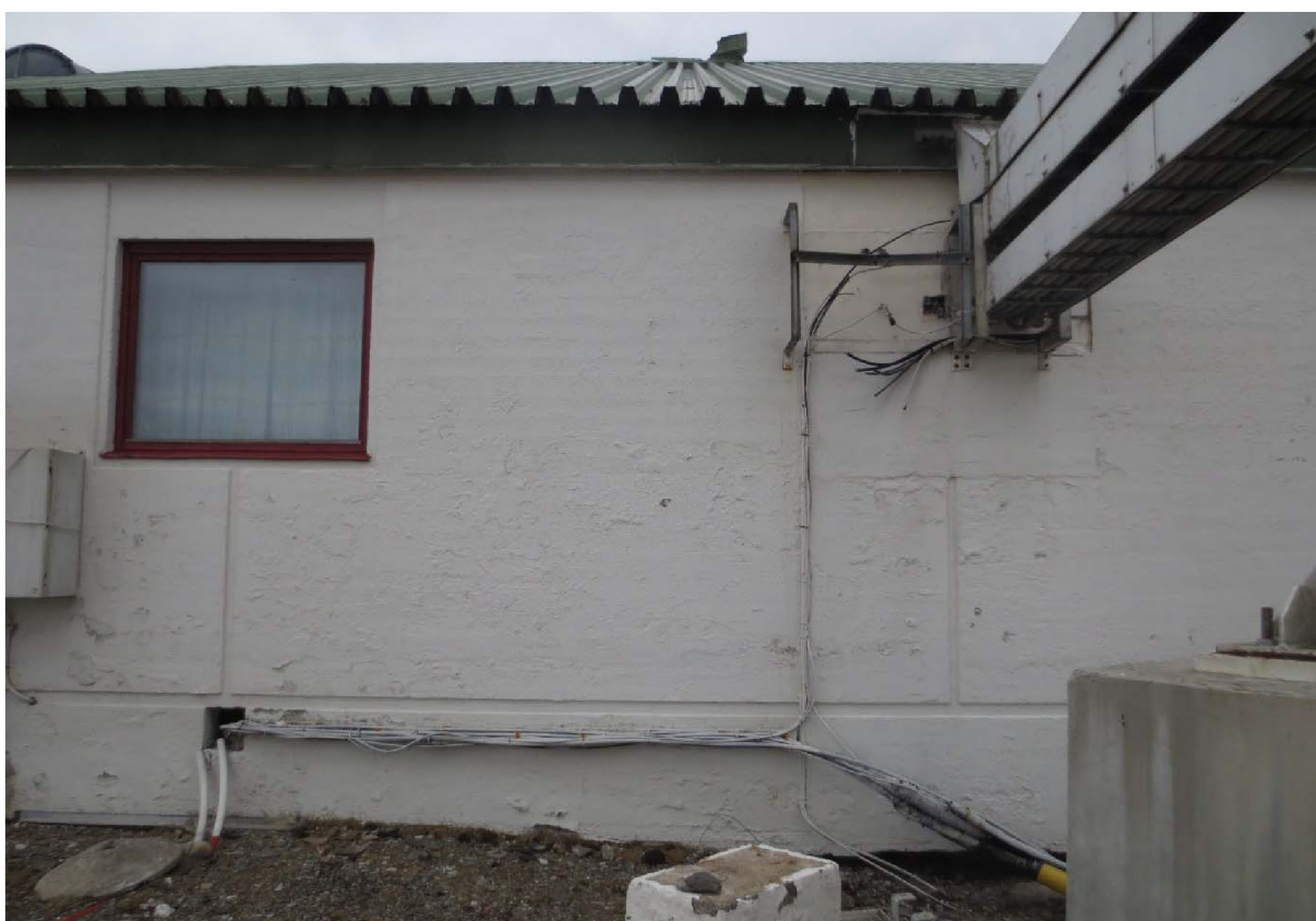
Figur 17: Del av fasade SV. Innfesting av støtte for parabolantenne i eldre gjenstøpt vindusåpning. Foto: Siri Hoem, Forsvarsbygg 2021.
