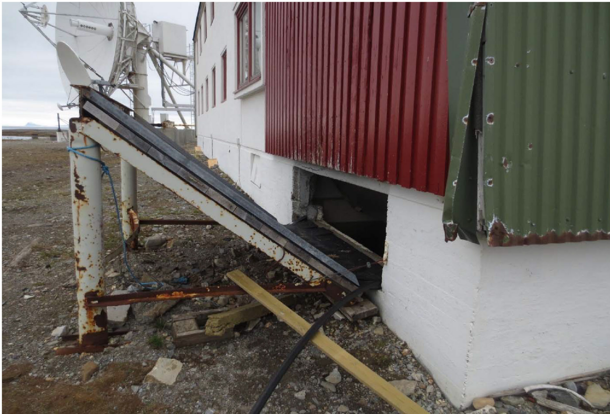
Figur 40: Hovedstasjonen, boligdel. Snøtippen med luke til vannbasseng i kjeller. Foto: Siri Hoem, Forsvarsbygg 2021.
