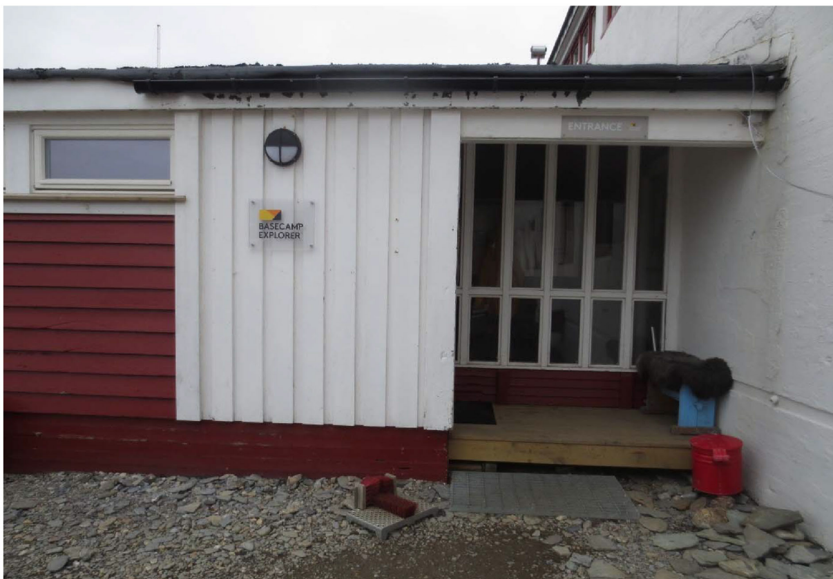
Figur 74: Inngangsparti. Foto: Siri Hoem, Forsvarsbygg 2021.
