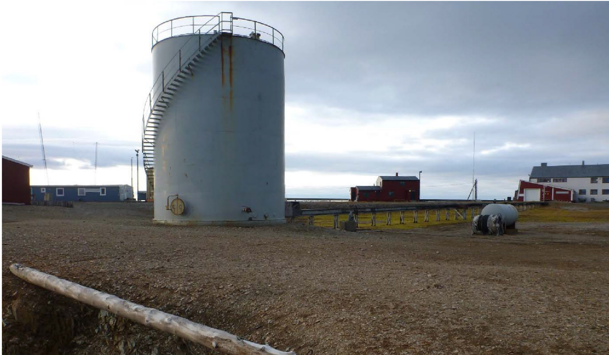
Figur 147: Dieseltanken, med rørgate over bakken. Liten drivstofftank til høyre i bildet er ikke omfattet av fredningen. Foto: Sysselmesteren på Svalbard, 2022.
