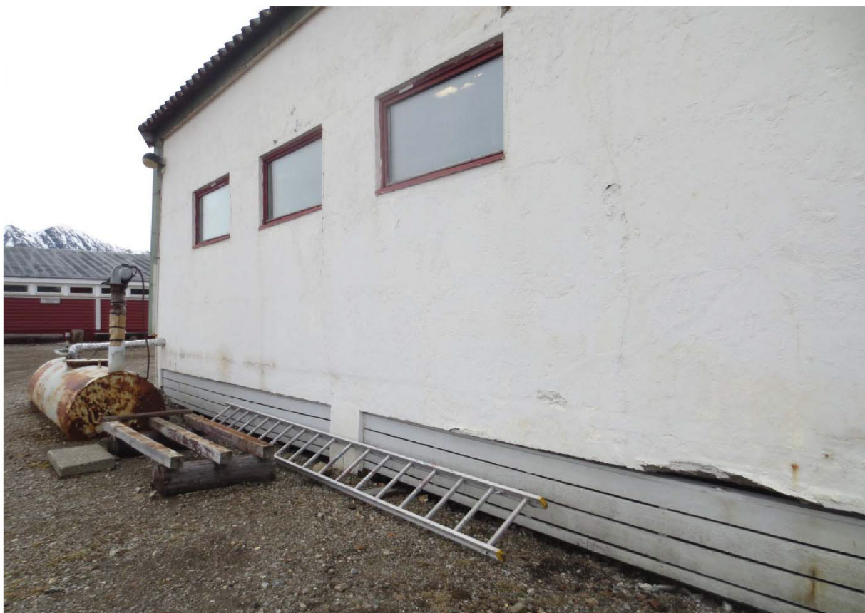
Figur 13: Deler av fasade/langvegg mot NØ. Utelampe oppunder tak i hjørnet. Foto: Siri Hoem, Forsvarsbygg 2021.
