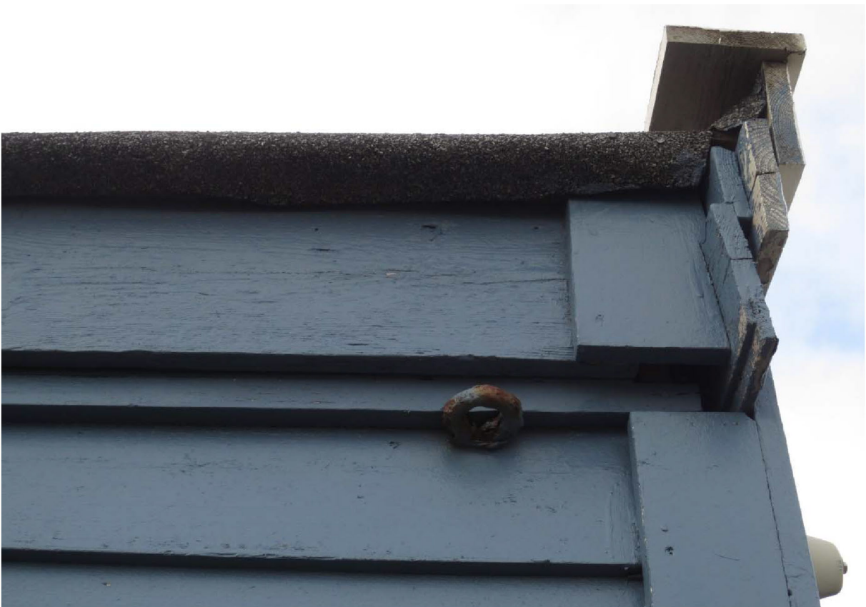
Figur 100: Polarbrakka. Detalj hjørne NV. Feste for bardunering. Foto: Siri Hoem, Forsvarsbygg 2021.
