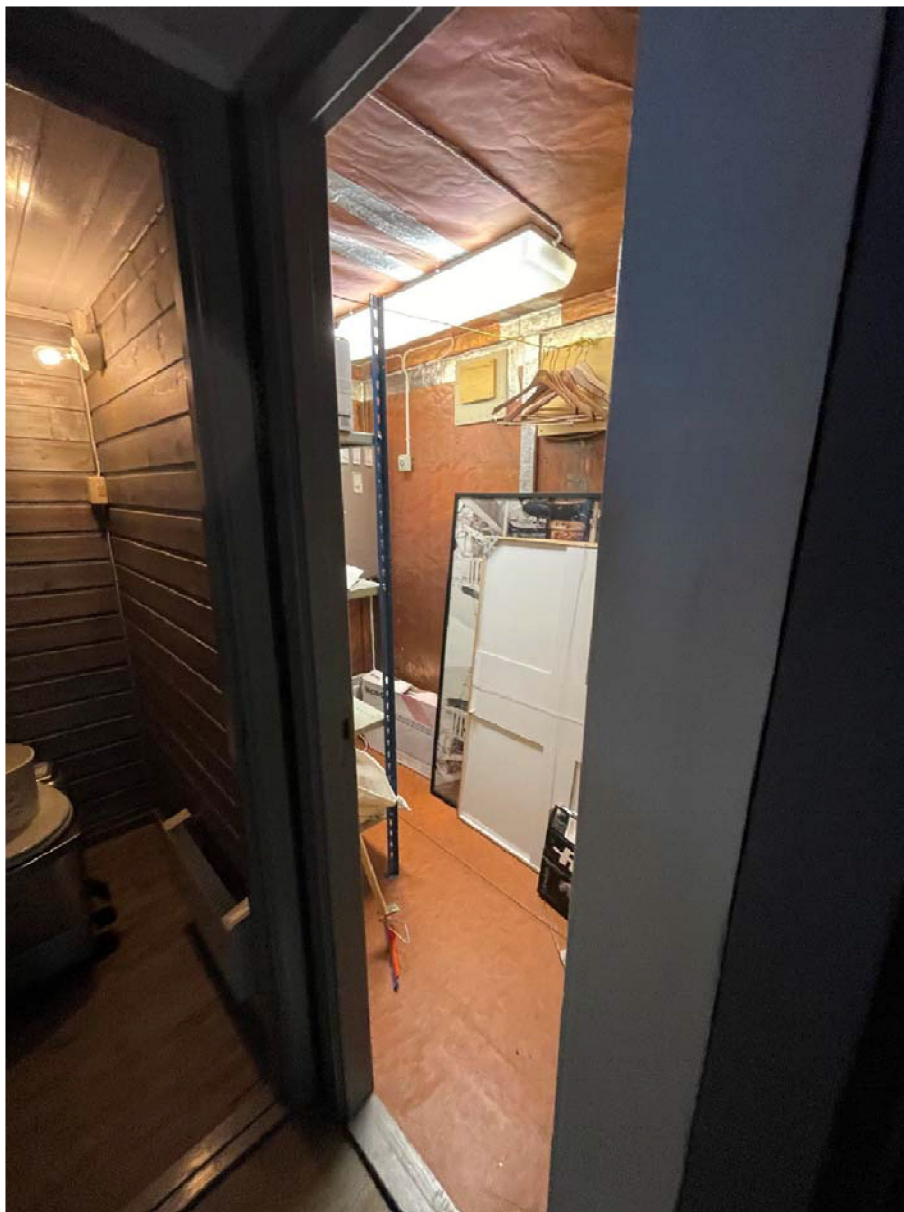
Figur 135: Del av fredet rom i Telenorhytta, med synlig kobberkledning i gulv, vegger og tak (Faraday bur-konstruksjon). Foto: Sysselmasteren på Svalbard 2023.
