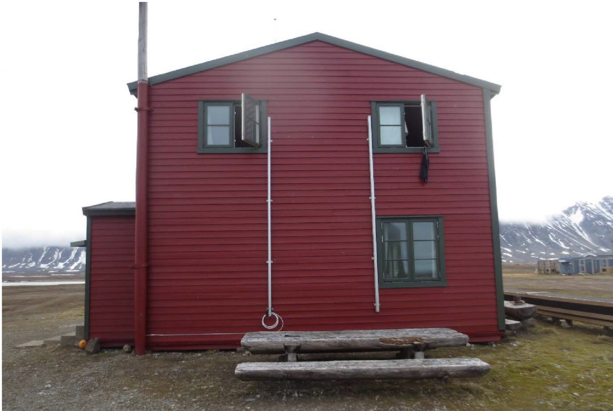
Figur 84: Gammelstasjonen. Gavlvegg/fasade mot V. Rømningsstiger montert ved vinduer. Foto: Siri Hoem, Forsvarsbygg 2021.
