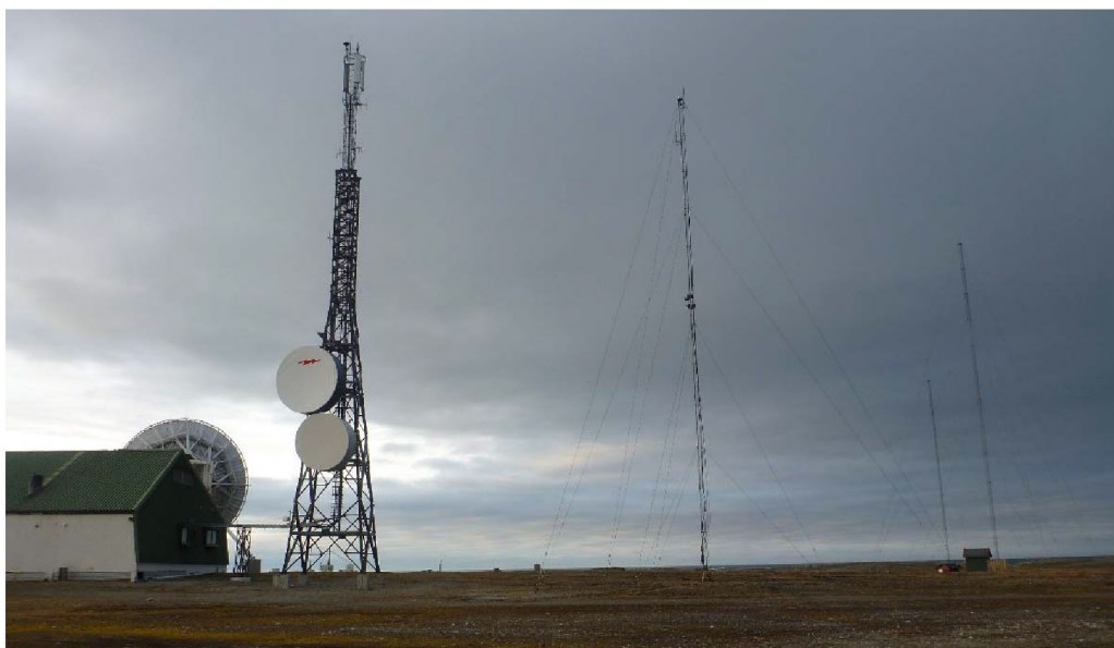
Figur 153: Antennemasta på Isfjord radio. De to store parabolantenne, samt toppantenne, som er festet på masta er ikke omfattet av fredningen. De tre fagverksmastene med barduner er ikke omfattet av fredningen. Foto: Sysselmesteren på Svalbard, 2022.
