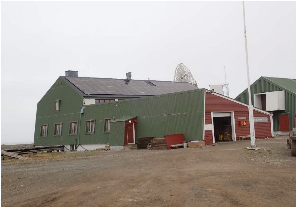
Figur 71: Kjøkken- og garasjedel. Fasade mot SØ, med bislag. Til venstre er gavlvegg/fasade i boligdel. Solceller er montert på taket til boligdelen. Foto: Sysselmesteren på Svalbard 2023.
