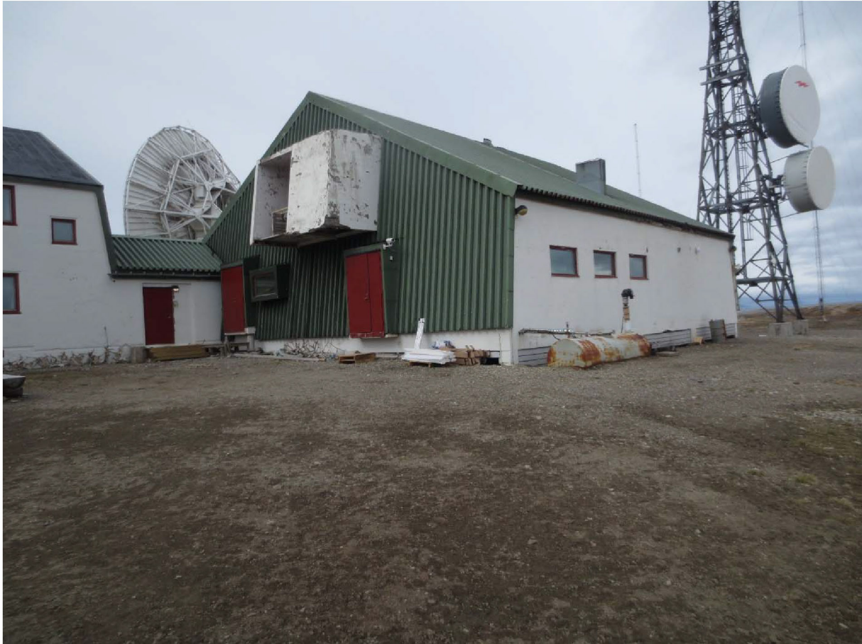
Figur 9: Hovedstasjonen, teknisk del. Inngangsparti, gavlvegg (SØ) og sidevegg (NØ). Foto mot NV. Foto: Siri Hoem, Forsvarsbygg 2021.
