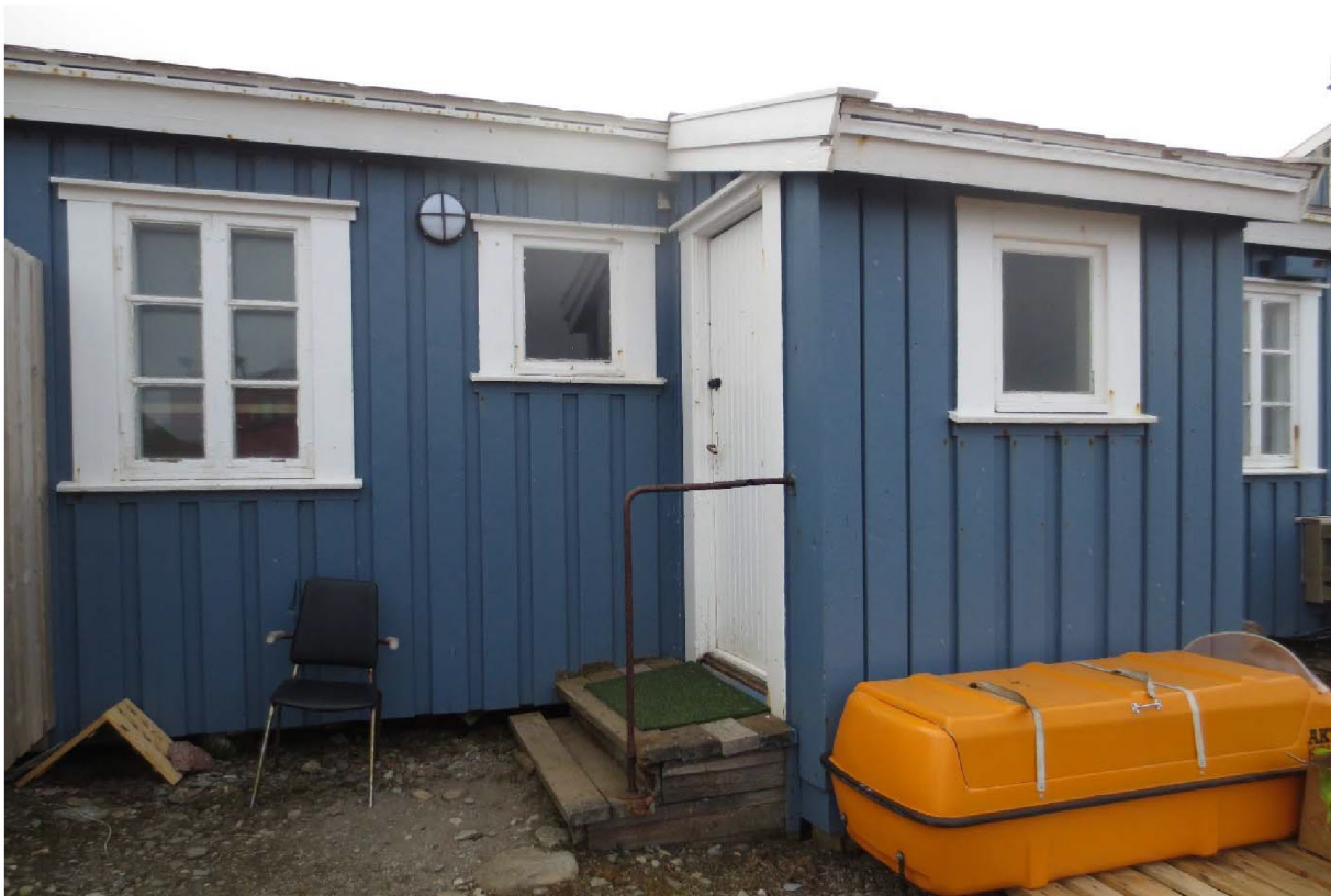
Figur 121: Sondebrakka. Bislag med inngangsdør og trapperekker. Foto: Siri Hoem, Forsvarsbygg 2021.
