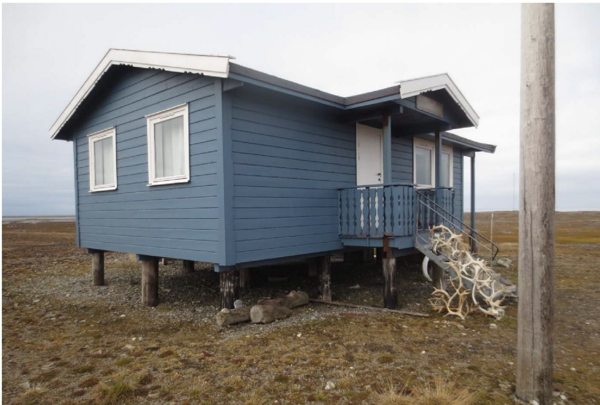
Figur 126: Telenorhytta. Foto mot SV. Foto: Siri Hoem, Forsvarsbygg 2021.
