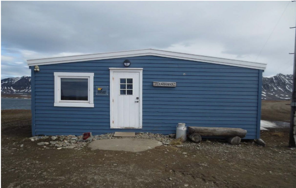
Figur 95: Polarbrakka. Fasade mot V. Foto: Siri Hoem, Forsvarsbygg 2021.
