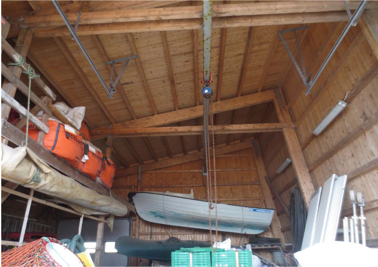
Figur 107: Båthuset, innvendig. Tak- og veggkonstruksjon av limtredragere. Foto: Siri Hoem, Forsvarsbygg 2021.
