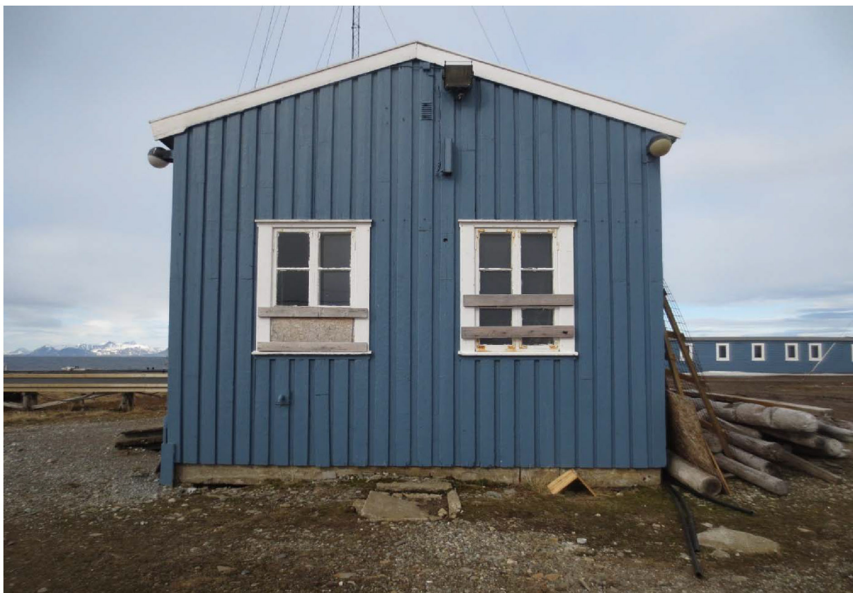
Figur 118: Sondebrakka. Fasade mot S. Den synlige delen er tilbygg fra 1956. Lamper/lyskupler i hjørnene inngår i fredningen. Foto: Siri Hoem, Forsvarsbygg 2021.
