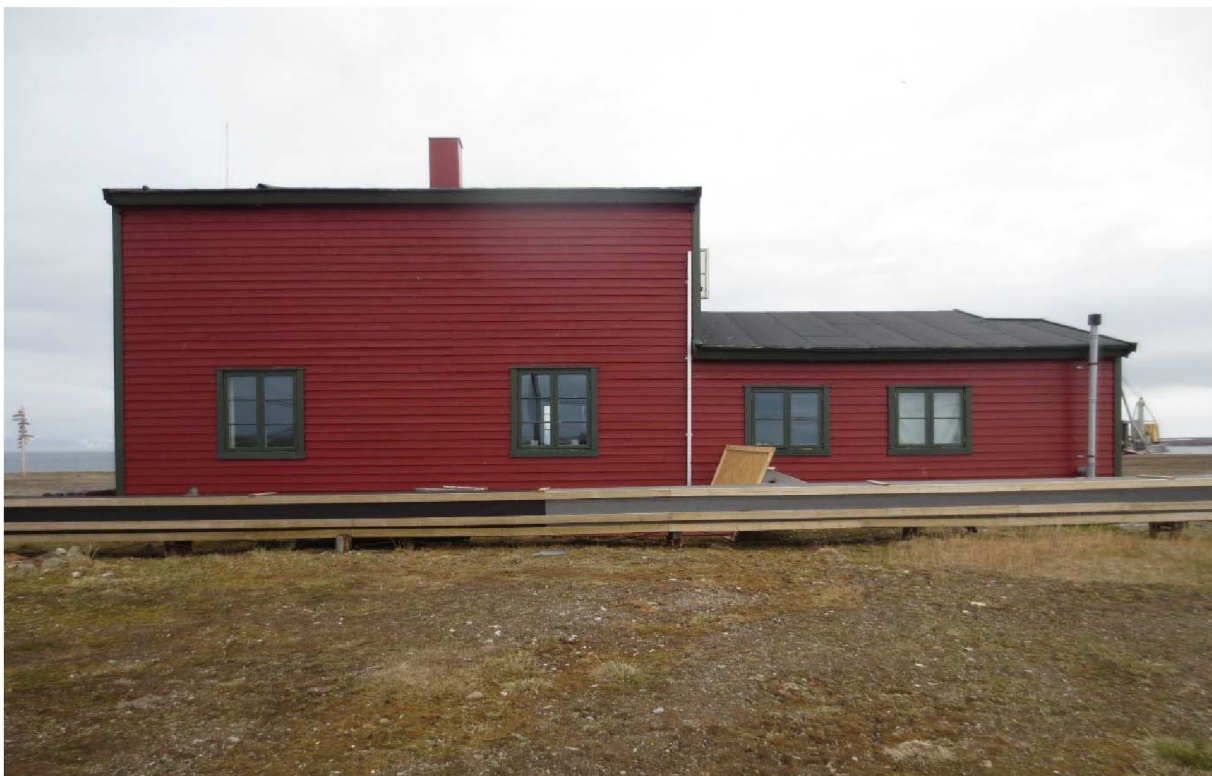
Figur 85: Gammelstasjonen. Fasade mot S. Rømningsstige i overgang mellom hoveddel og sidebygg. Lufting fra septikk/toalett helt til høyre på sidebygg. I forkant av bildet ses rørgate for vann fra hovedstasjonen til Gammelstasjonen og Sondebrakka. Foto: Siri Hoem, Forsvarsbygg 2021.
