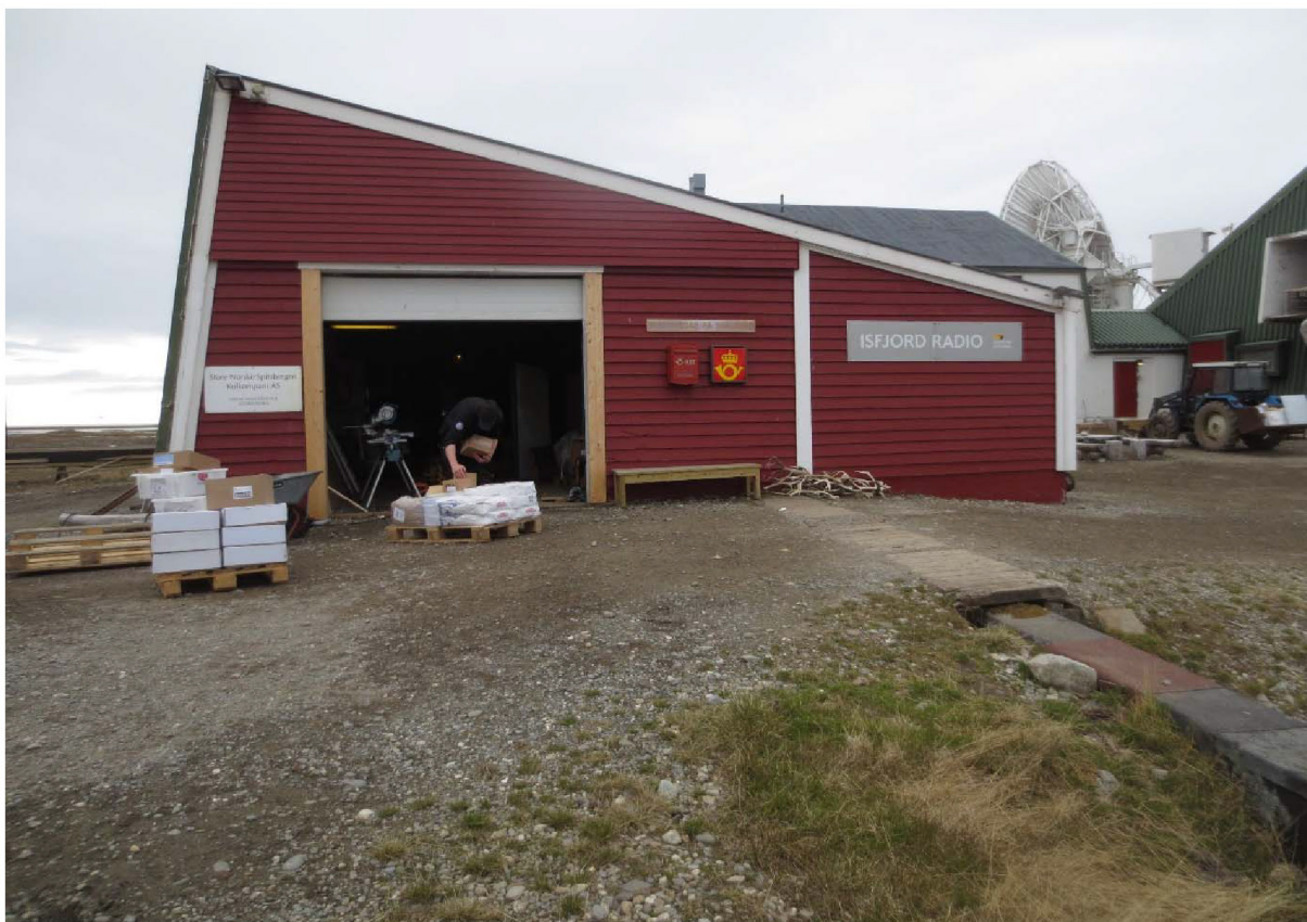
Figur 149: Rørgate fra dieseltanken går inn i Hovedstasjonen. De siste meterne ligger konstruksjonen i bakken. Foto: Sysselmesteren på Svalbard, 2022.
