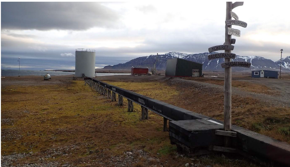
Figur 148: Dieseltanken, med rørgate over bakken. Liten drivstofftank til venstre i bildet er ikke omfattet av fredningen. Foto: Sysselmesteren på Svalbard, 2022.
