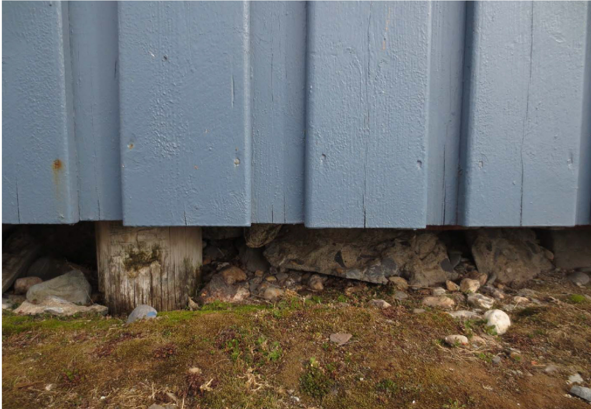
Figur 122: Sondebrakka. Detalj kledning og fundament. Foto: Siri Hoem, Forsvarsbygg 2021.
