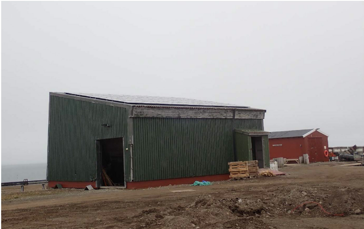
Figur 103: Båthuset, mot nord. Solceller er montert på taket. Foto: Sysselmesteren på Svalbard, 2023.
