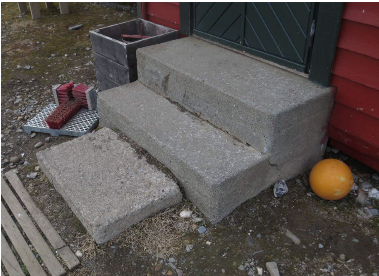
Figur 91: Gammelstasjonen. Betongtrapp ved hovedinngang. Foto: Siri Hoem, Forsvarsbygg 2021.
