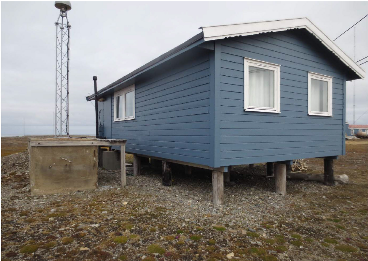
Figur 130: Telenorhytta. Fasade mot S (langvegg) og Ø (gavl). Foto: Siri Hoem, Forsvarsbygg 2021.
