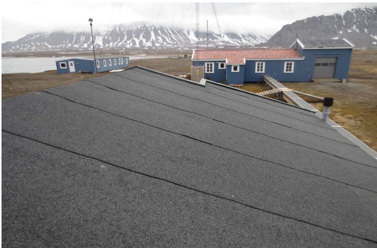
Figur 92: Gammelstasjonen. Tak på sidebygning. Foto mot Ø. Foto: Siri Hoem, Forsvarsbygg 2021.
