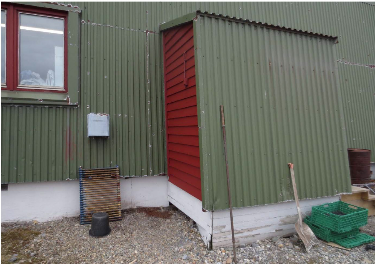
Figur 76: Bakside av bislag på fasade mot SØ. Foto: Siri Hoem, Forsvarsbygg 2021.
