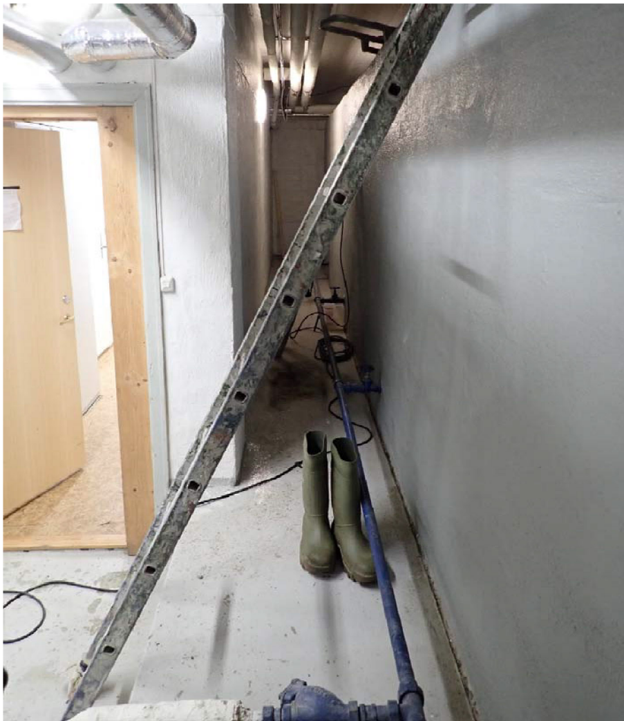
Figur 48: Rom med vanntanker (grå vegg til høyre). Fredningen omfatter den oppbygde delen av rommet (høyre side i bildet). Vanntankene er bygget slik at det er gangareal rundt hele. Foto: Sysselmesteren på Svalbard, 2023
