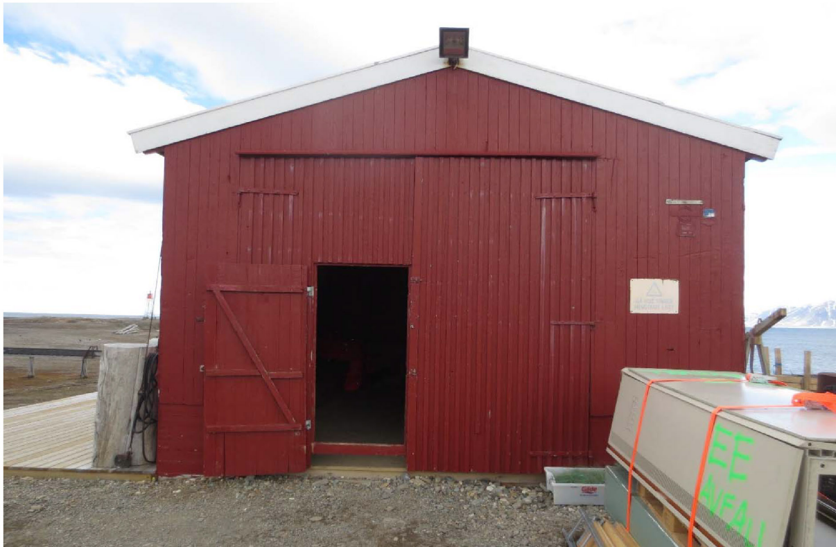
Figur 110: Naustet. Fasade mot SØ. Porten er ombygd og økt i høyden i forbindelse med heving av bygningen. Foto: Siri Hoem, Forsvarsbygg 2021.
