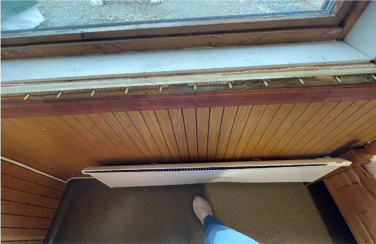
Figur 22: Kontrollrom. Detalj vindu med Faradays bur-konstruksjon. Foto: Sysselmesteren på Svalbard, 2023.
