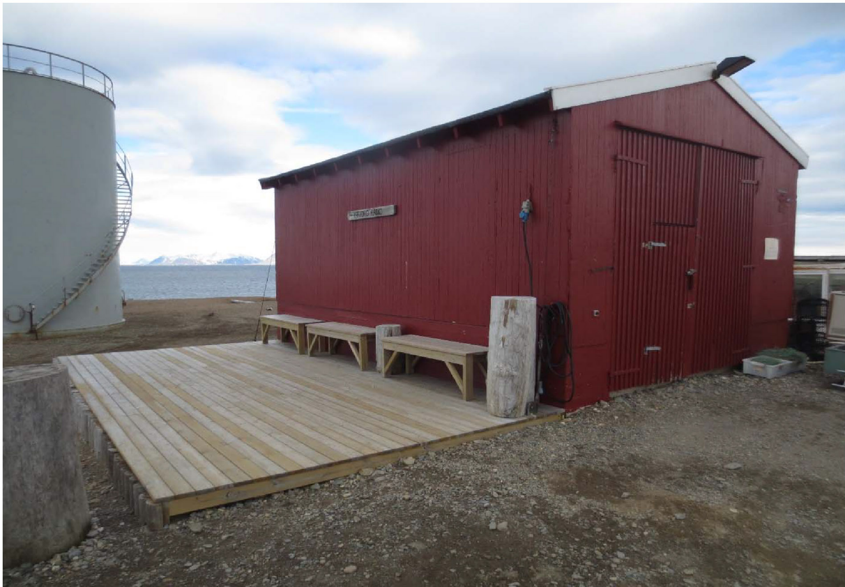
Figur 113: Naustet. Fasade mot SV (langvegg) og SØ (gavl). I langvegg ses blendet døråpning som gikk ut av bruk da bygningen ble hevet. Nyere platting (ikke fredet). Foto: Siri Hoem, Forsvarsbygg 2021.
