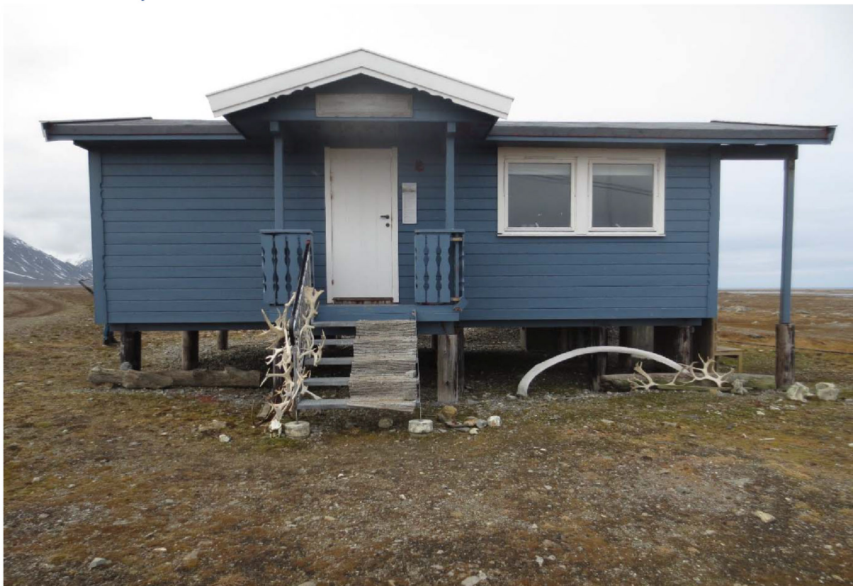
Figur 127: Telenorhytta. Fasade mot N. Foto: Siri Hoem, Forsvarsbygg 2021.
