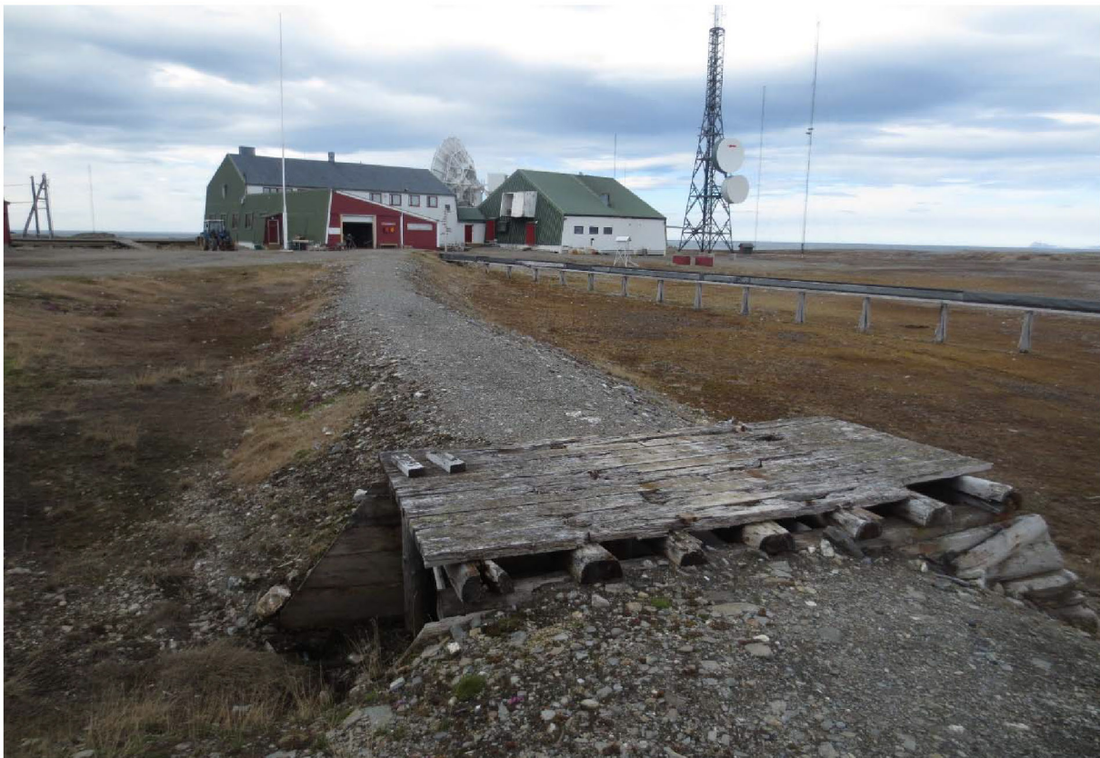
Figur 163: Oppbygd trasé for skinnegang, med kulvert/trekonstruksjon over søkk i terrenget. Foto: Siri Hoem, Forsvarsbygg 2021.
