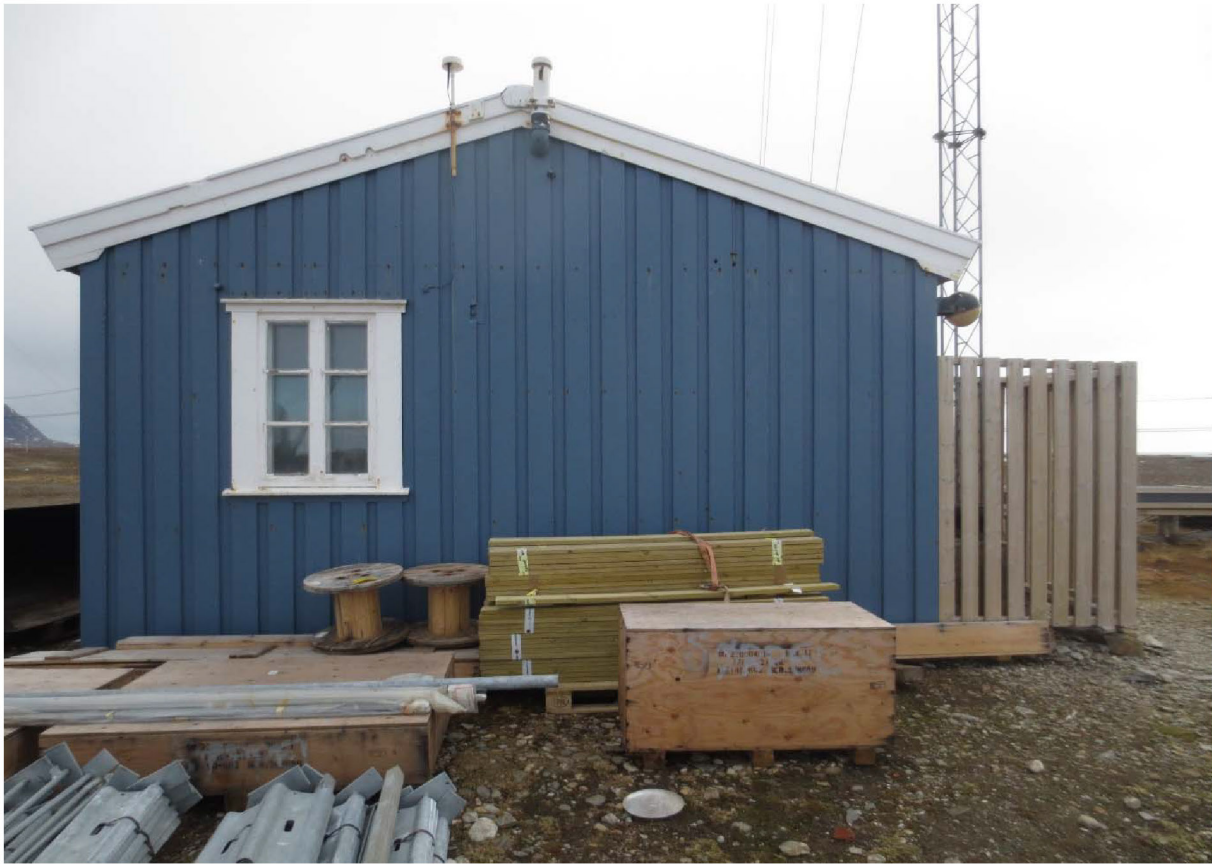
Figur 120: Sondebrakka. Fasade mot S. Den synlige delen av bygget er første byggetrinn (1946). Beskyttelsesgitter rundt mast til høyre er ikke omfattet av fredningen. Foto: Siri Hoem, Forsvarsbygg 2021.
