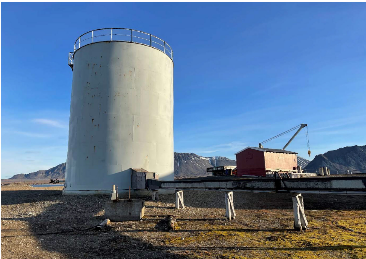
Figur 146: Dieseltanken, med rørgate over bakken. Foto: Sysselmasteren på Svalbard, 2022.
