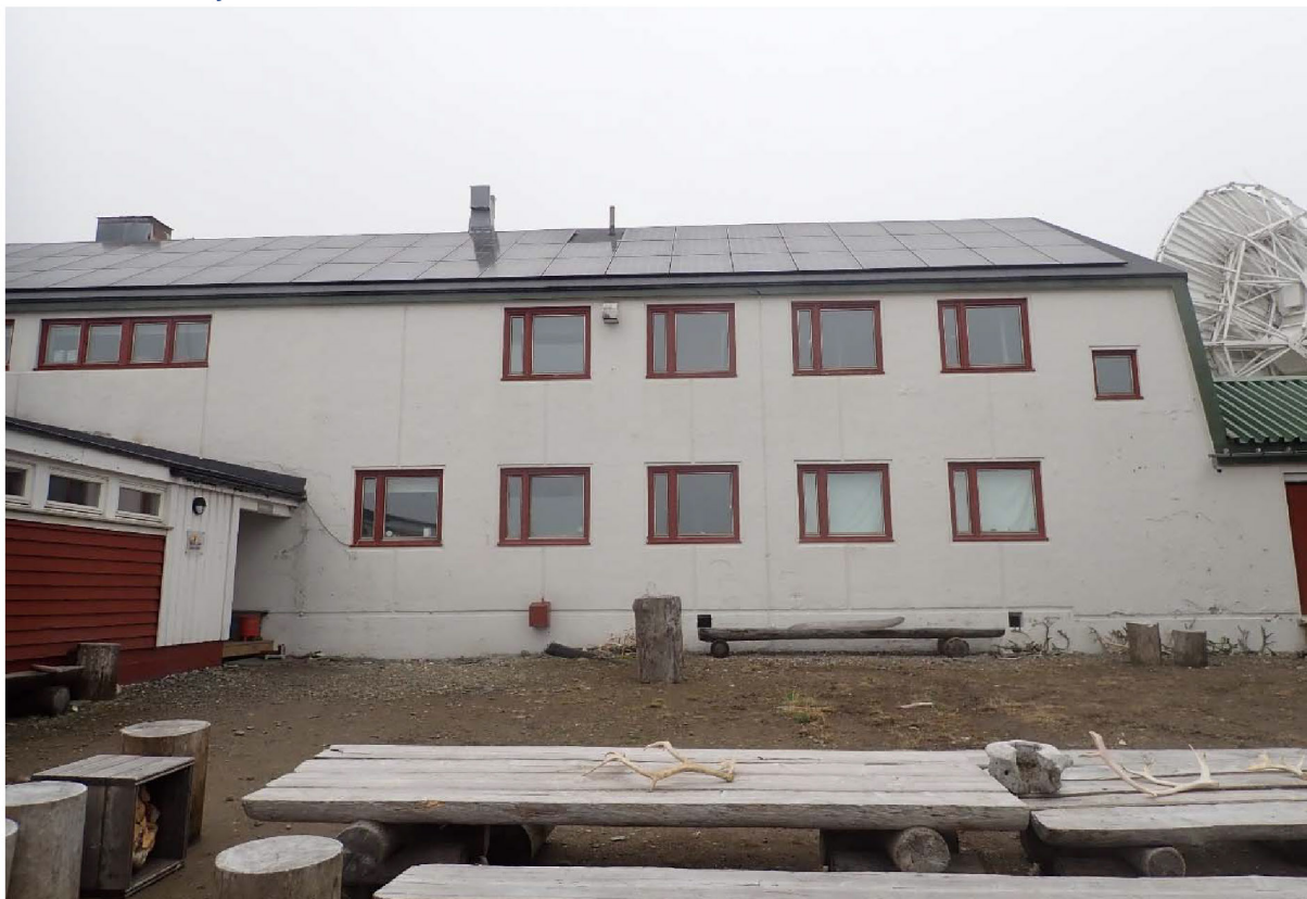
Figur 34: Hovedstasjonen, boligdel. Fasade mot gårdsrom (NØ). Til høyre ses mellombygg mot teknisk del, til venstre ses kjøkken- og garasjedel. Solceller er montert på taket. Foto: Sysselemesteren på Svalbard, 2023..
