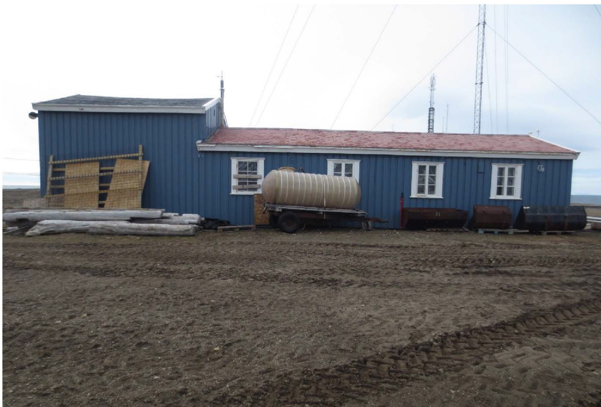
Figur 119: Sondebrakka. Fasade mot Ø. Foto: Siri Hoem, Forsvarsbygg 2021.
