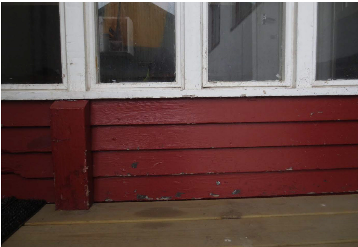
Figur 78: Detalj fra vinduer i inngangsparti. Foto: Siri Hoem, Forsvarsbygg 2021.
