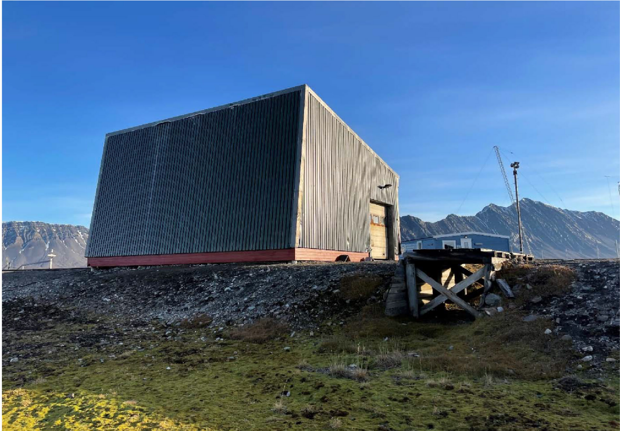
Figur 105: Båthuset, fra NV. I forgrunn ses bro/kulvertkonstruksjon i oppbygd trase for tidligere skinnegang til garasjen i hovedstasjonen. Foto: Monika Serafinska, Sysselmesteren på Svalbard 2022.
