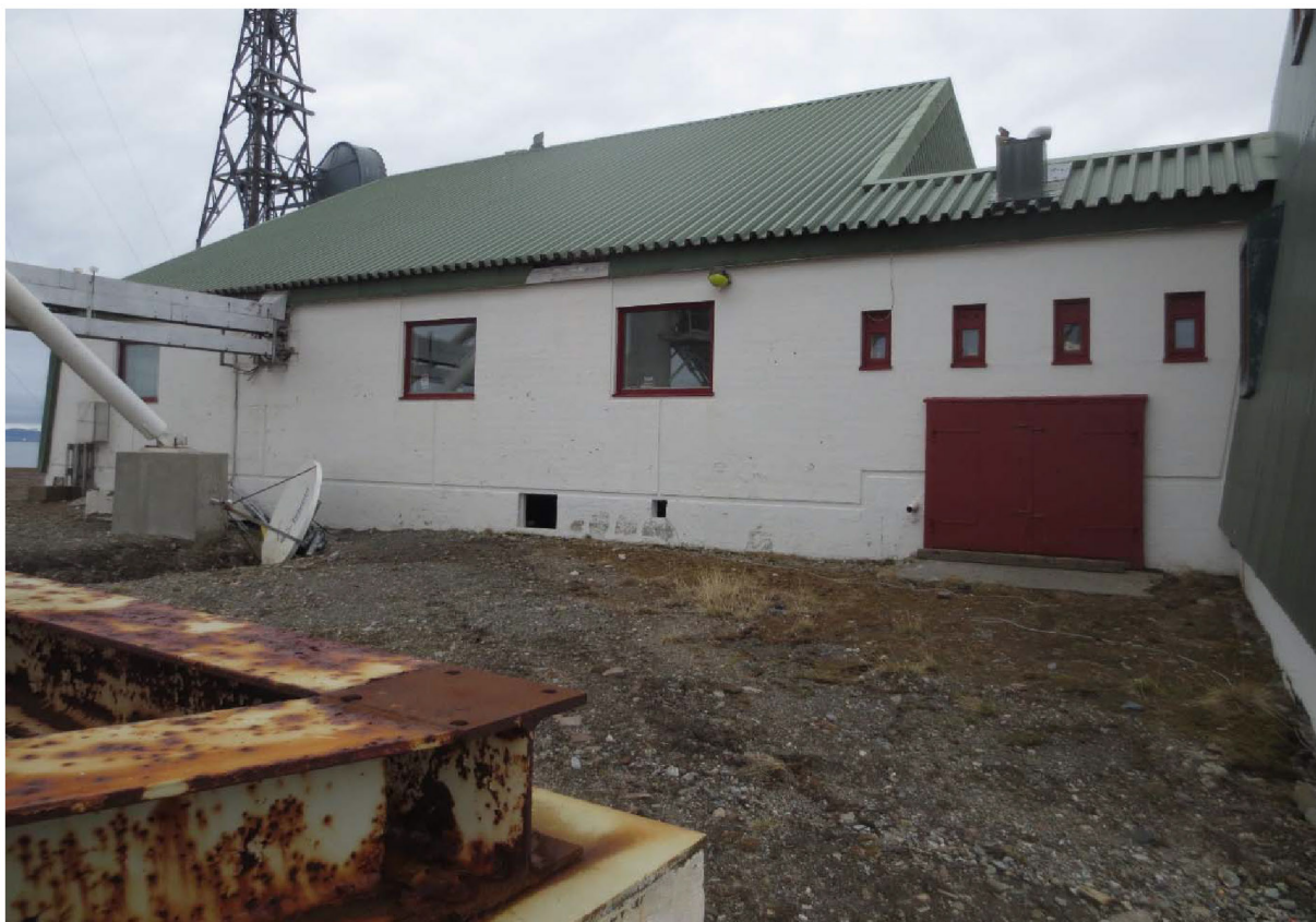
Figur 16: Fasade SV. Lampe som inngår i fredningen over vindu. Foto: Siri Hoem, Forsvarsbygg 2021.
