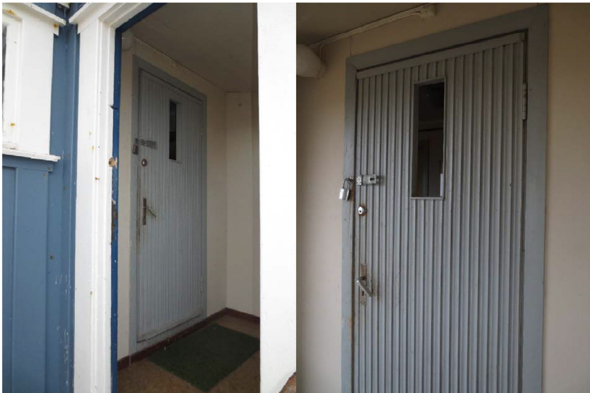
Figur 123: Sondebrakka. Dør i bislag. Tidligere inngangsdør, før bislaget ble bygget i 1956. Foto: Siri Hoem, Forsvarsbygg 2021.
