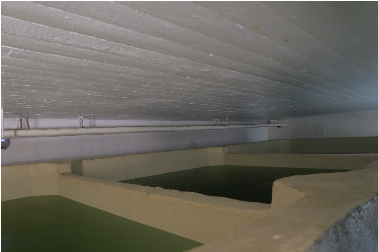
Figur 50: Fulle vanntanker i kjeller. Vanntankene er bygget slik at det er gangareal rundt hele. Foto: Maria Lytomt, Riksantikvaren 2021.
