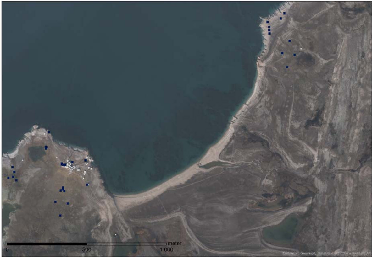
Figur 160: Fundamenter på Isfjord radio. Fundamentene er til både eksisterende og tidligere tekniske installasjoner og anlegg.
