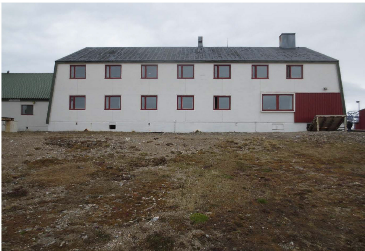
Figur 37: Hovedstasjonen, boligdel. Fasade SV. Til høyre ses snøtippen med felt med tømmermannskledning over. Foto: Siri Hoem, Forsvarsbygg 2021.
