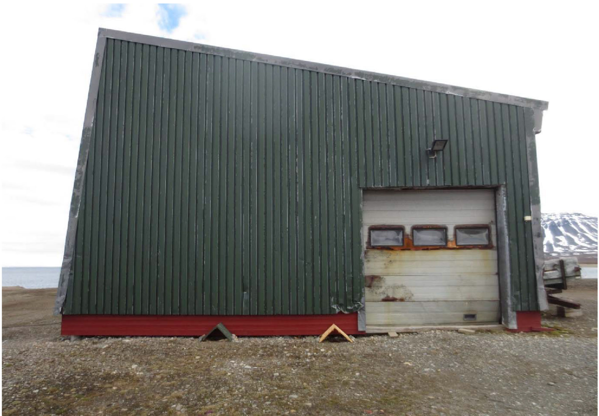
Figur 106: Båthuset. Fasade mot SV med port. Foto: Siri Hoem, Forsvarsbygg 2021.
