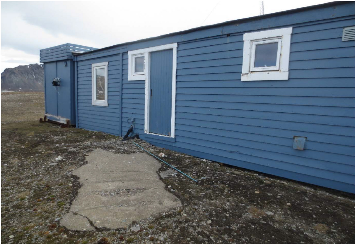
Figur 97: Polarbrakka. Fasade mot N. Østre del. Skille mellom opprinnelig bygningsvolum (1946) og senere påbygg (1959) går til høyre for dør, mellom dør og vindu til høyre. Lengst til venstre er tilbygd rom for septik (ikke fredet). Foto: Siri Hoem, Forsvarsbygg 2021.
