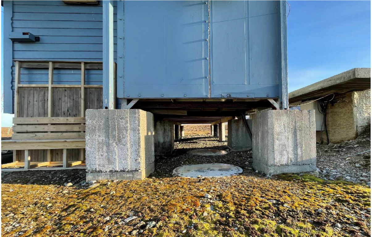
Figur 131: Detalj av fundamenter og fagverk i teknisk rom. Lukk for antennefester under bygningen. Foto: Sysselmesteren på Svalbard 2022.
