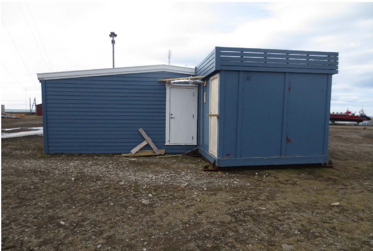
Figur 98: Polarbrakka. Fasade mot Ø. Til høyre er tilbygd rom for septik (ikke fredet). Foto: Siri Hoem, Forsvarsbygg 2021.
