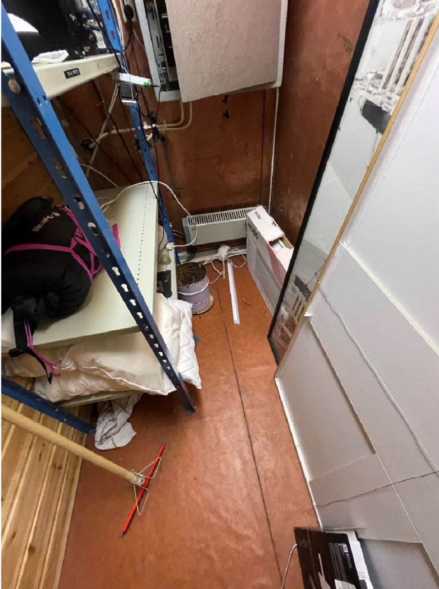
Figur 137: Del av fredet rom i Telenorhytta, med synlig kobberkledning i gulv, vegger og tak (Faraday bur-konstruksjon). Foto: Sysselmasteren på Svalbard 2023.
