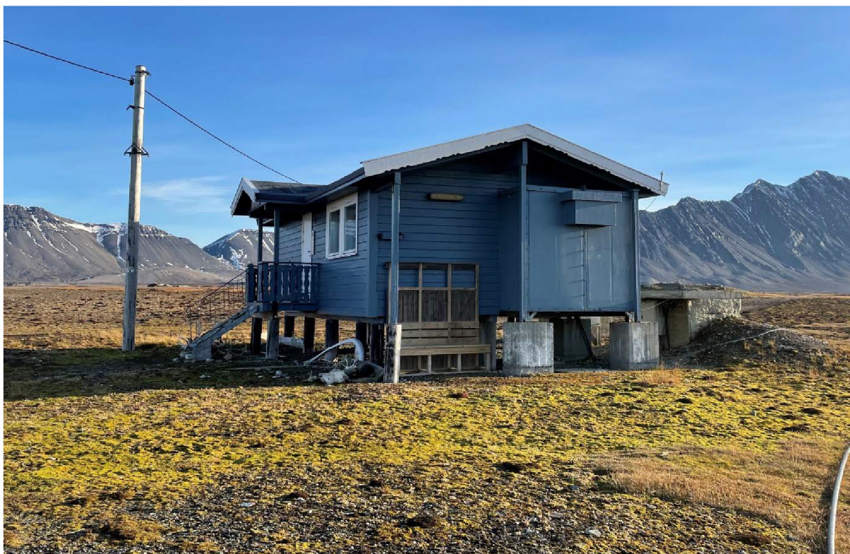
Figur 128: Telenorhytta. Fasade mot V (gavl). Teknisk rom med platekledning i halve byggets bredde til høyre. Foto: Sysselmesteren på Svalbard 2022.
