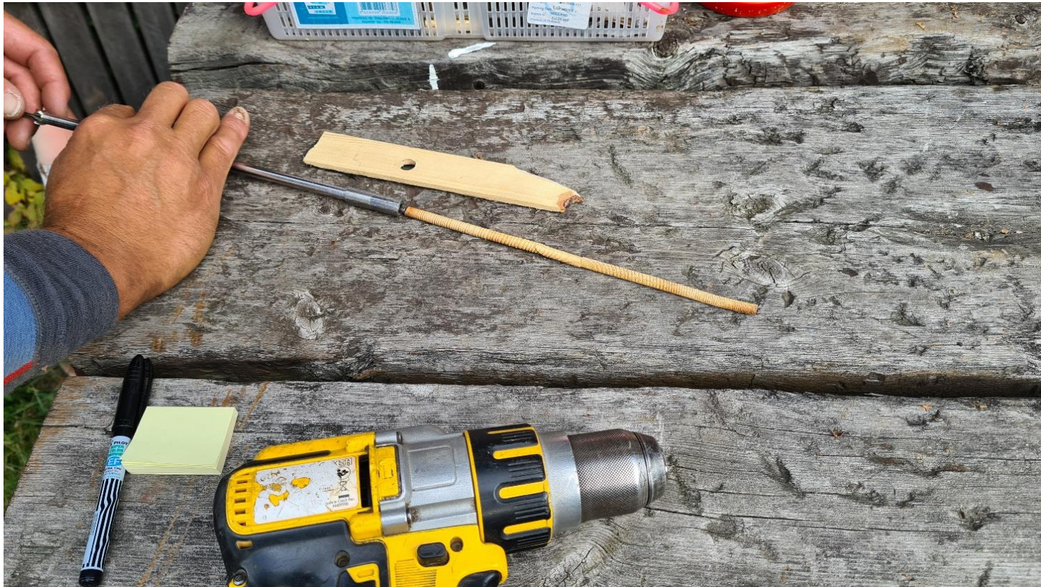
Boreprøver utført av Jørn Berget. Loft på Lillemoen i Notodden. Foto: Anund Grini.
