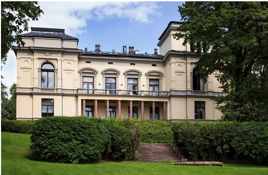
Foto: Trond Isaksen, Riksantikvaren. Hovedhuset sett fra hagen.
