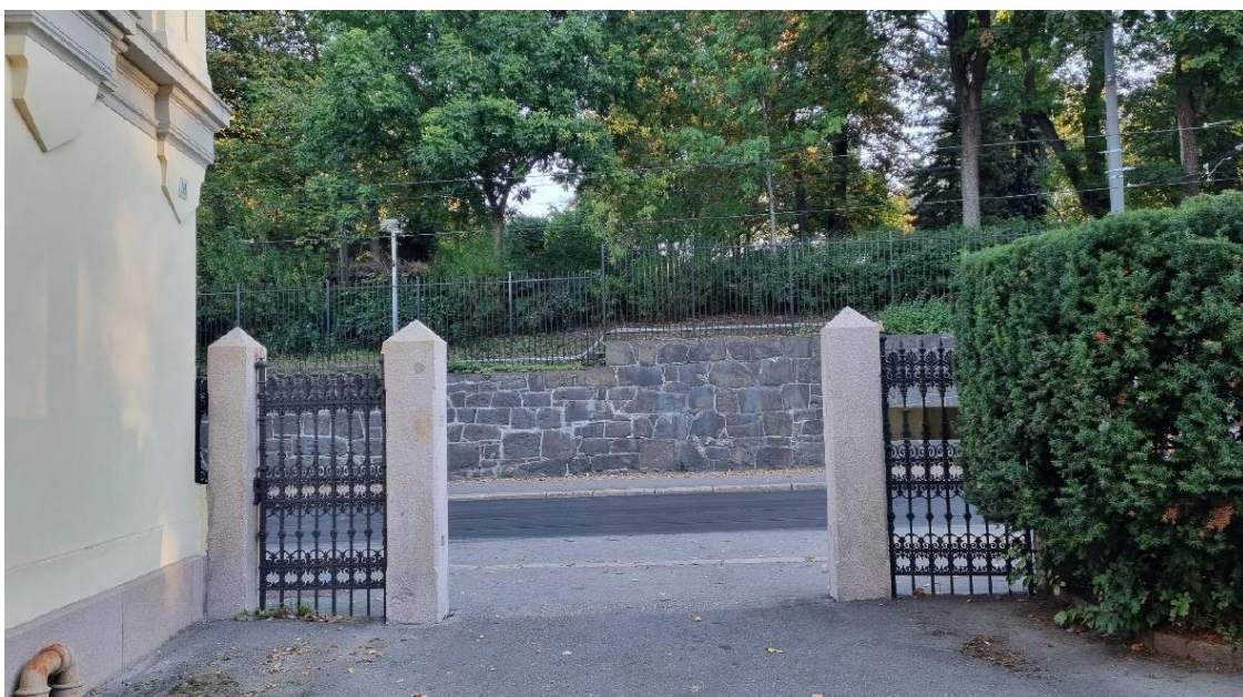
En av to portåpninger mot Drammensveien, foto sett mot nord. Dronninga landskap
