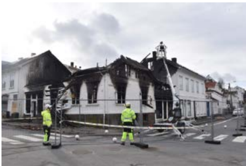
Figur 21: Skadde bygningsfasader etter brannen i Risør. Foto: Agder Fylkeskommune, 2021.
