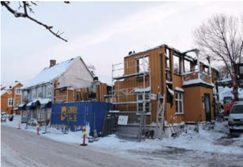
Figur 26: Januar 2016, etter at det gjenværende tømmeret i 2. etasje var merket og demontert. Foto: Per-Willy Færgestad.
