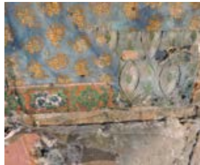
Figur 28: Håndtrykte tapeter fra ca. 1785 og 1805. Border i seks fargetrykk fra 1. etasje sør-øst. Foto: Per-Willy Færgestad.
