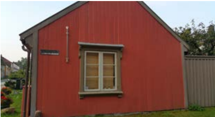
Figur 16: Tørrørsanlegg, med påkoblingsdel for brannvesenet. Foto: Sverre Støle, Fredrikstad kommune.
