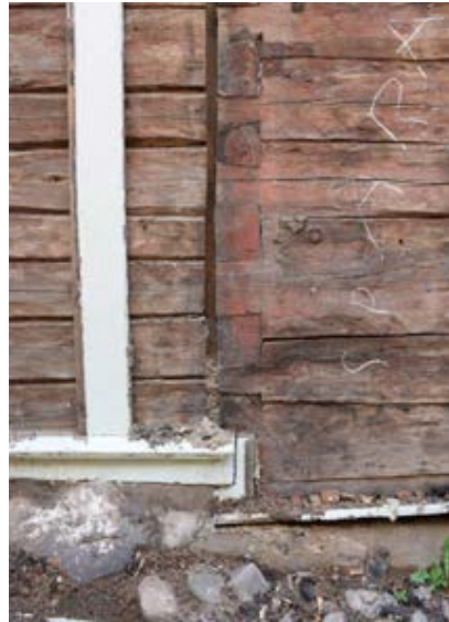
Figur 29: Skjøte mellom to bygningskropper. Foto: Jönköpings Läns Museum.
