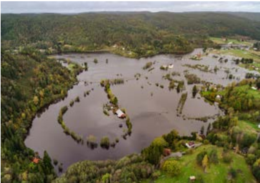
Figur 5: Drangsholt er et boligområde i Kristiansand kommune, som ble sterkt berørt under høstflommen i 2017. En engasjert velforening samarbeider nå med kommunen om varslings- og oppfølgingsberedskap i bygda. Les mer om dette i kapittel 9. Foto: Foto: Trygve E. Tønnesen.
