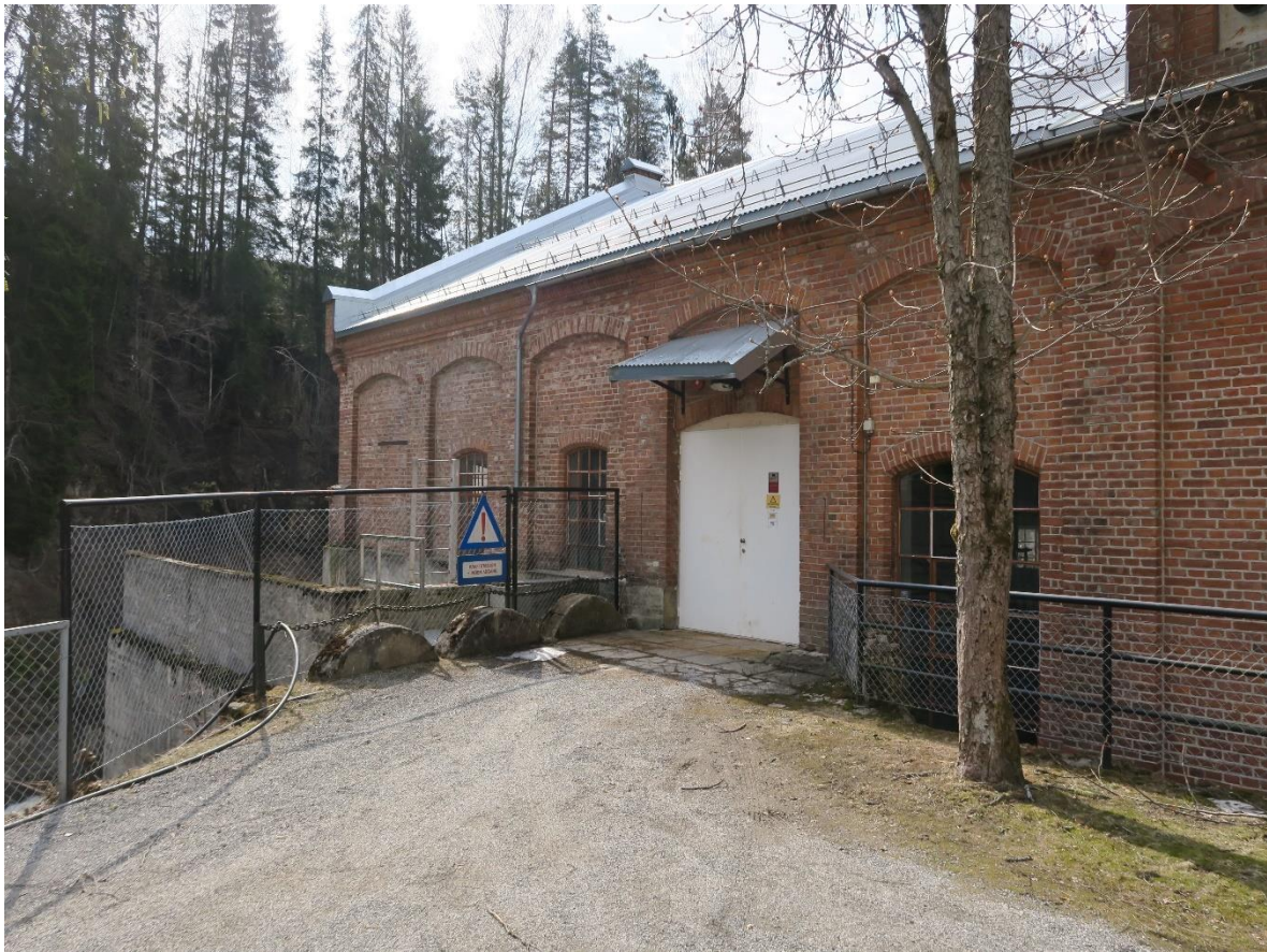
Nordøstre vegg. Inngang til kraftstasjonen.
