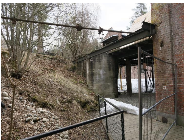
Tv. Tresliperiet sett fra nordvest og mot broa inn til Kapphuset. Th. under broa til Kapphuset. Kapphusets østlige vegg. Se aksling og drivhjul.
