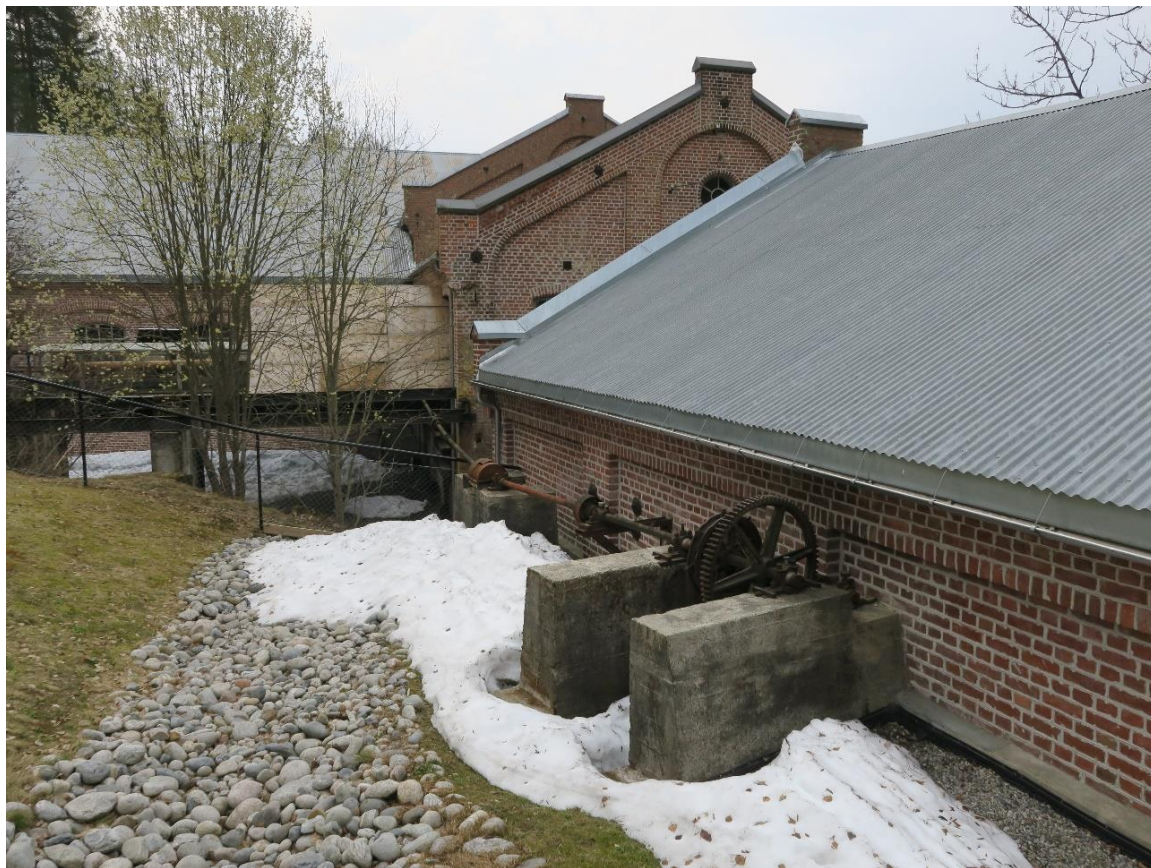
Detalj av drivverket ved østre vegg.
