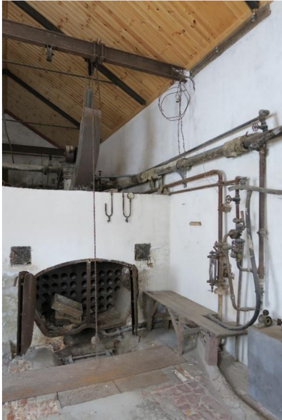
Tv. detalj av fyrkjelen og rør for sentralvarmesystemet på vegg mot sør. Th. detalj av sentralvarmesystemet der vanndamp ble sendt inn til fabrikkbygningene for oppvarming vinterstid.
