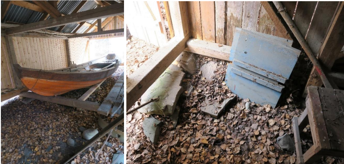
Tv. inne i båthuset sett fra døra i søndre vegg og th. detalj av stakk og dørterskel til døra i søndre vegg.
