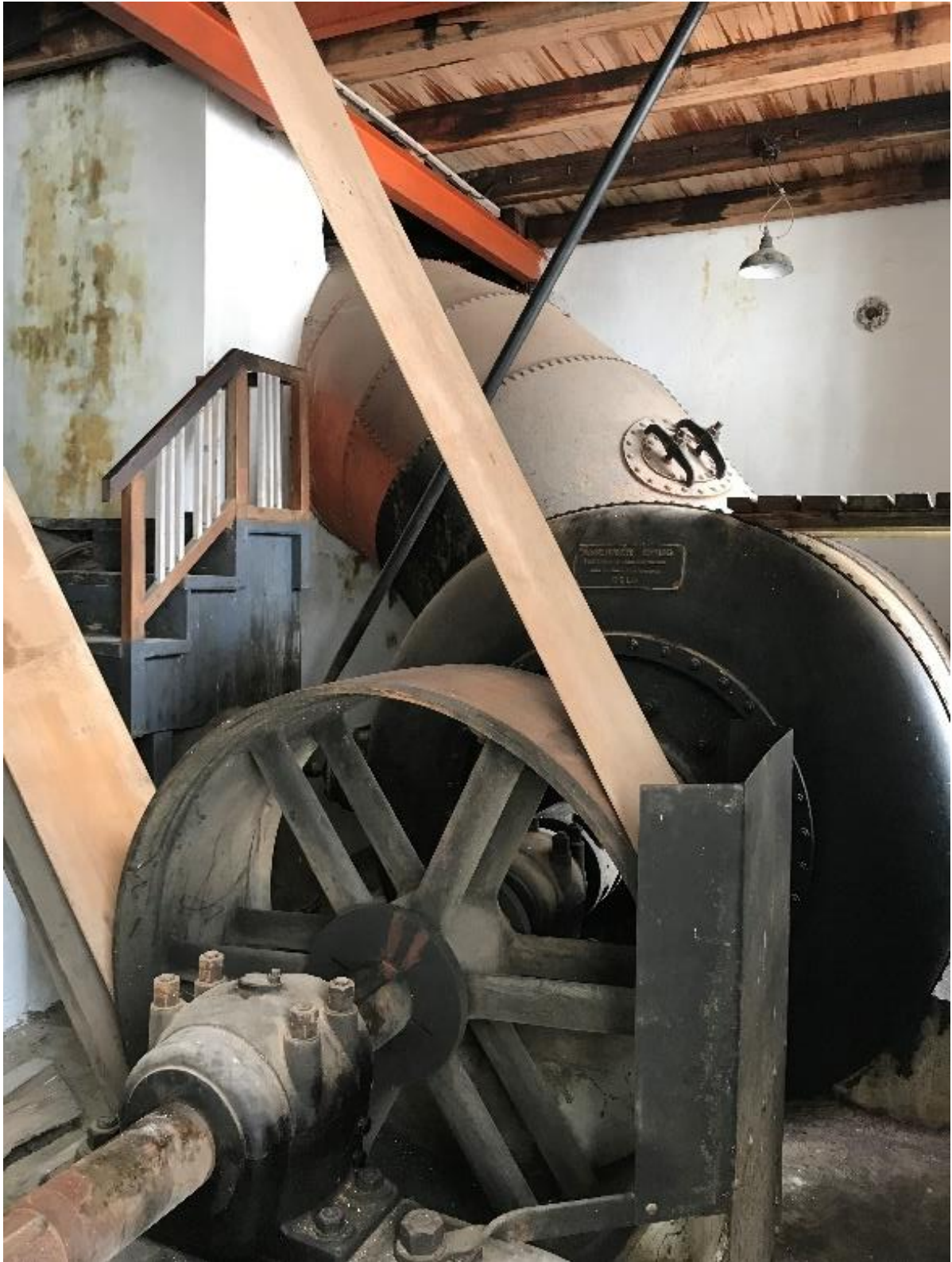
Hovedturbinen er en francisturbin. Her ses den både koblet til turbinrøret og reimverket.
