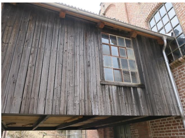
Tv. vestre vegg i passasjen for kubbtransportøren. Bygget i tre med ett støpejernsvindu i vestveggen. Th. inngang til Rensseriet i søndre vegg.
