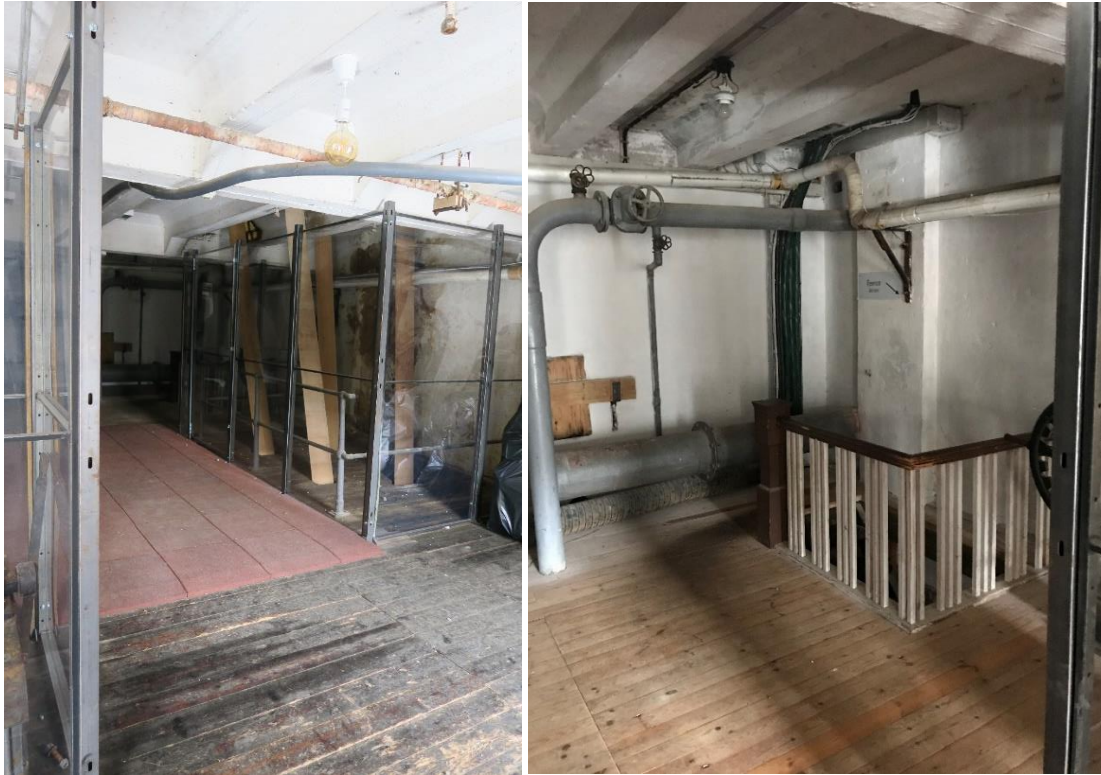
Tv. Mellomrommet sett mot reimverket, innbygget i plexiglass. Th. trapp til Reimrommet og Laboratoriet på nivået under.
