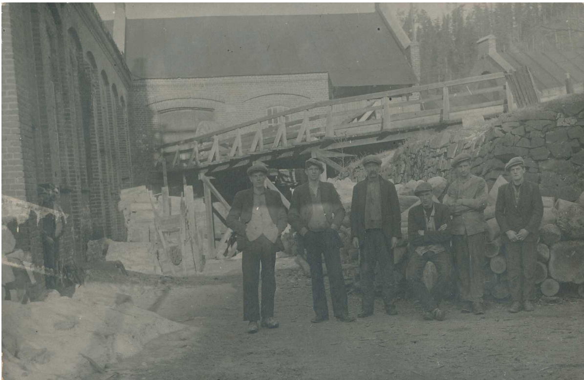
Seks arbeidere fotografert i 1920 foran broa inn til Kapphuset. Oppe på broa står en slipestein på høykant ved porten inn til Kapphuset. Slipesteinene ble altså fraktet inn her og gjennom Kapphuset og videre inn porten til Tresliperiet. Foto: Kistefos-Museet, KIS.F000042
