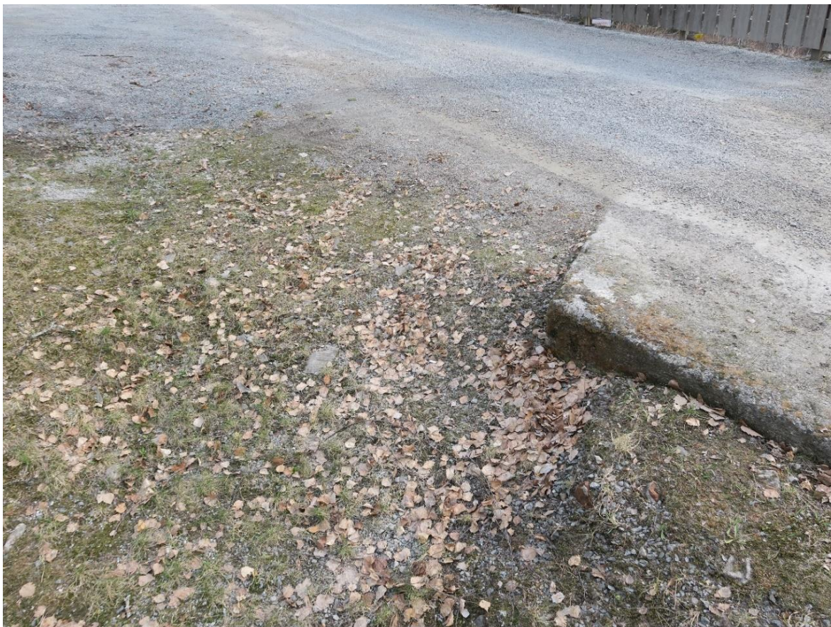
Detalj av sporet etter kulverten ved vestre veikant.
