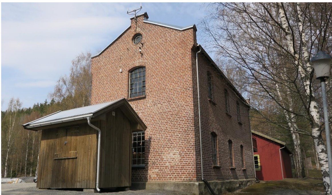
Bygningens søndre gavlvegg.
