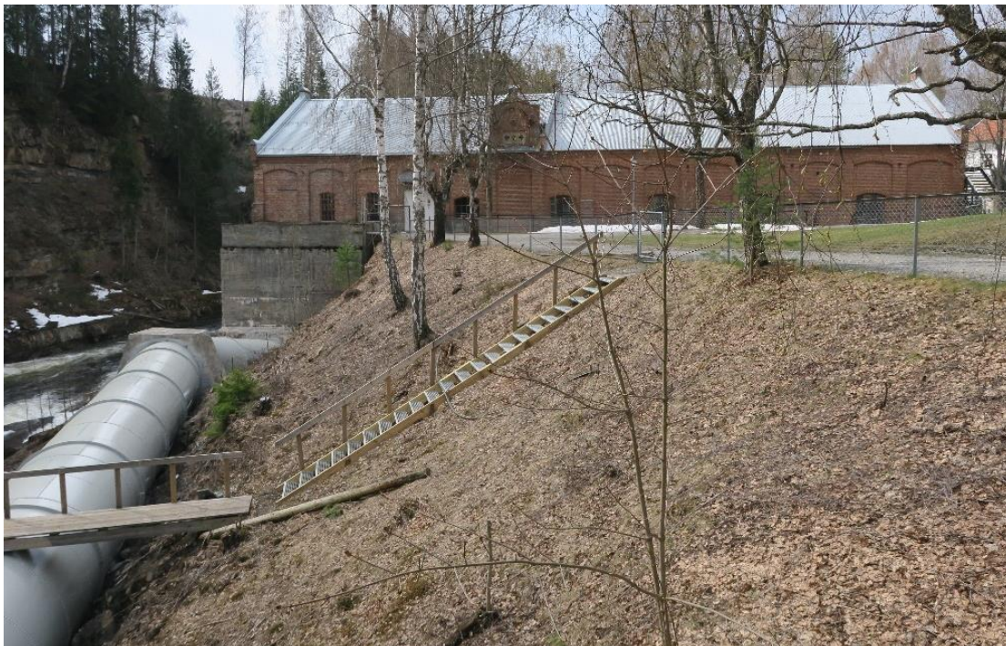
Nordøstre vegg. Turbinrøret inngår ikke i fredningen.
