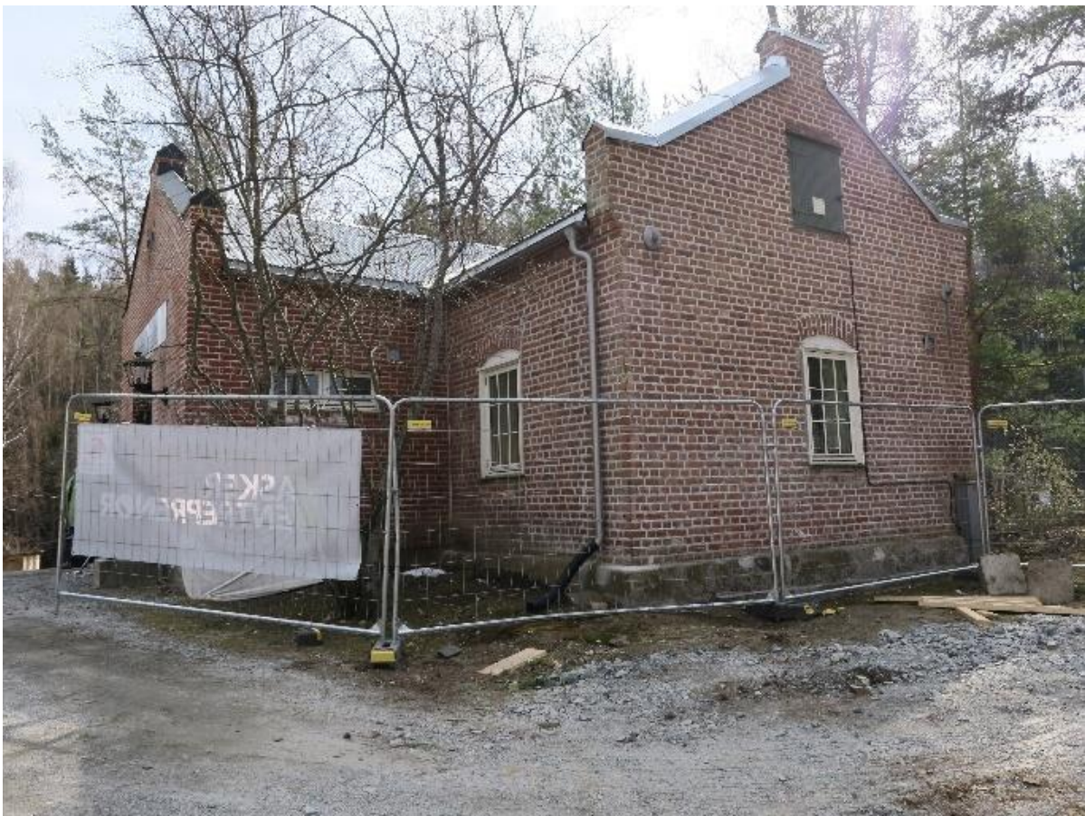
Tv. Messas vestre gavlvegg og nordveggen med inngangspartiet sør.
