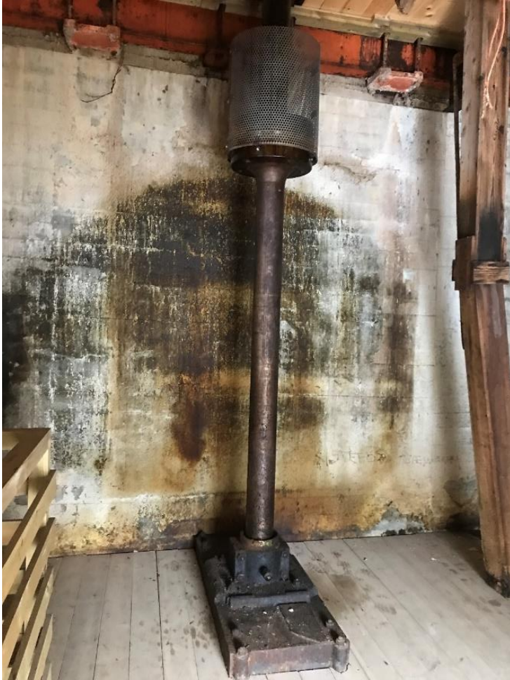
Nivå 2 under akslingsrommet.
