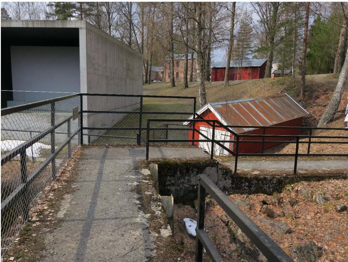
Fløtningsanlegget sett fra anlegget og mot Båthuset, Smia og Magasinet.
