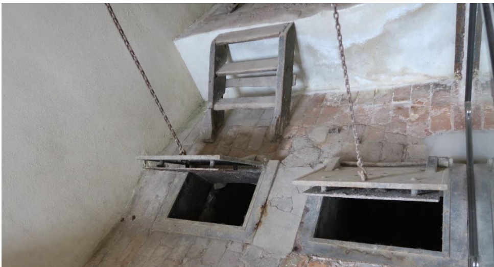
Detalj av luker ved vegg mot nord.
