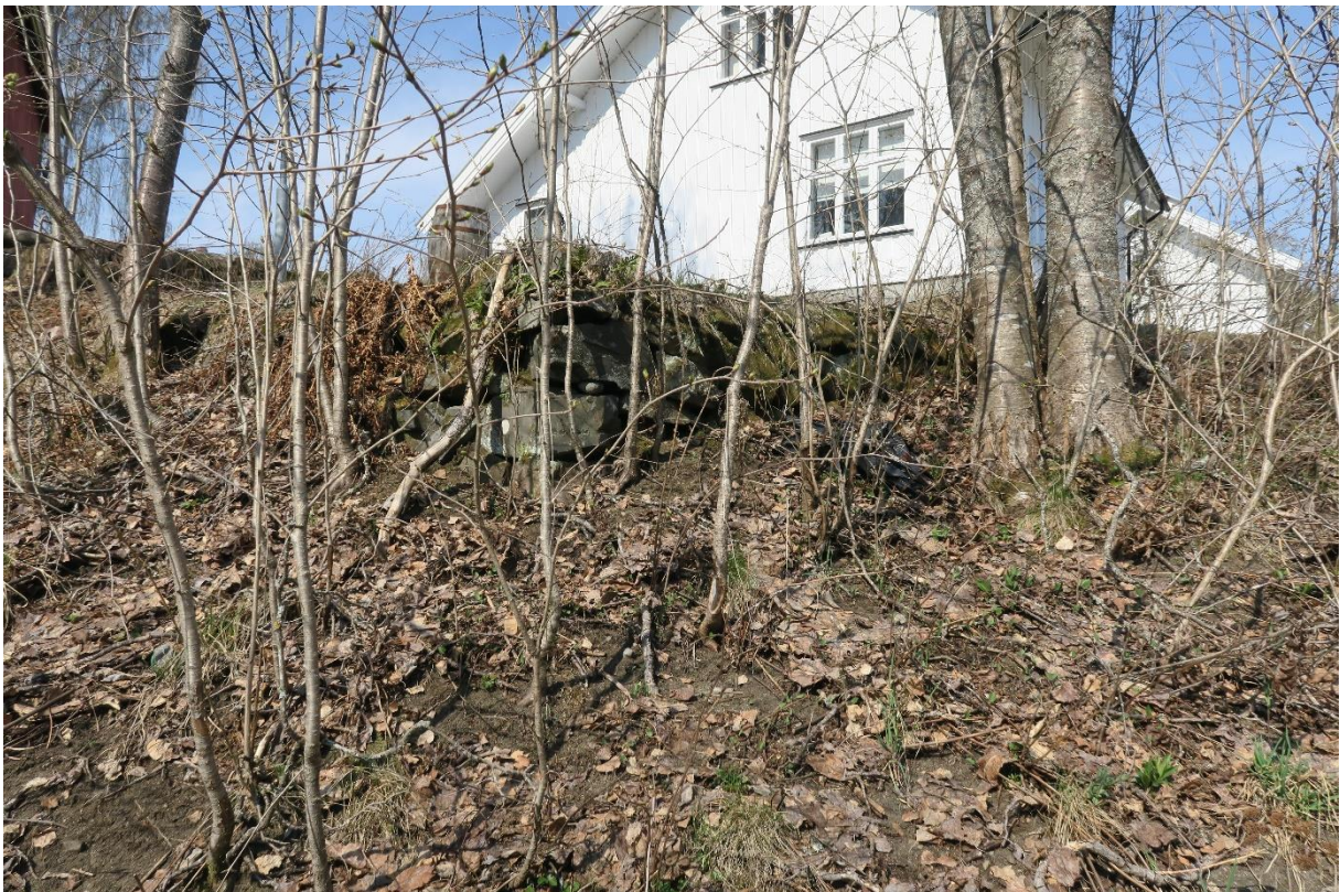
Detalj av mur sør for Reparatørboligen. Foto: Cathrine Arnesen, Riksantikvaren 2019
