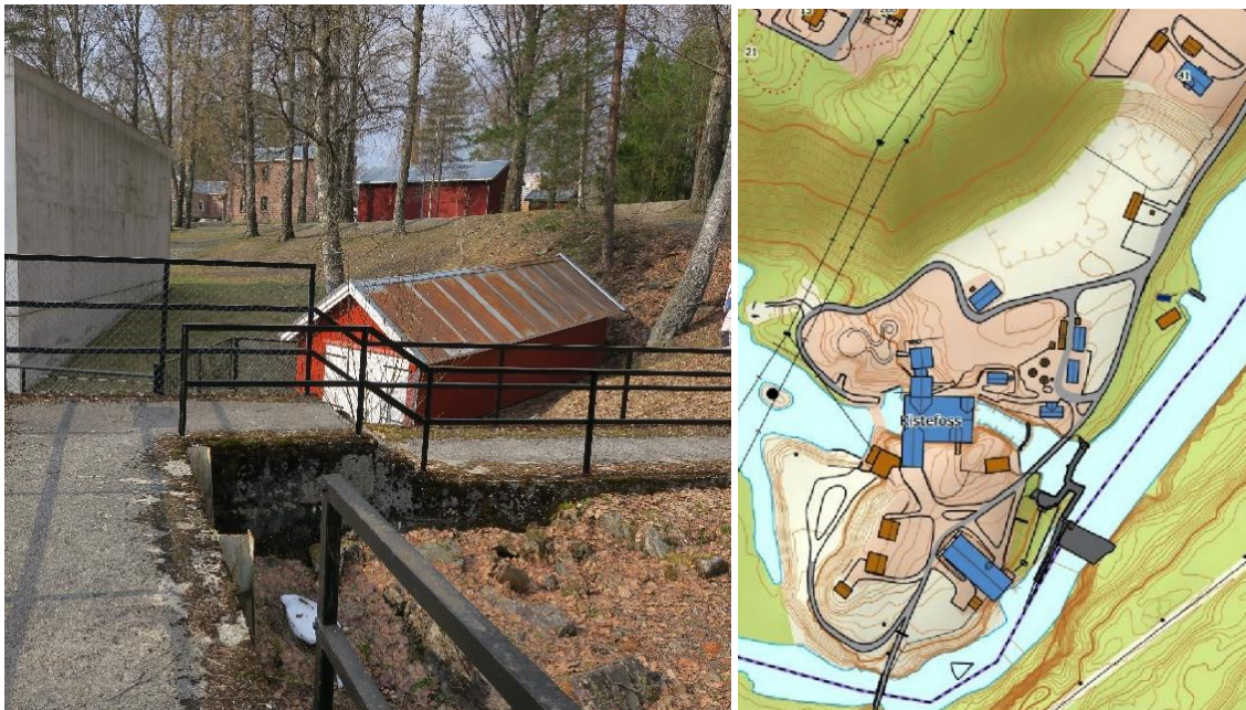
Båthuset fra ca. 1955, gnr./bnr. 150/4, bygningsnummer 157245120.
