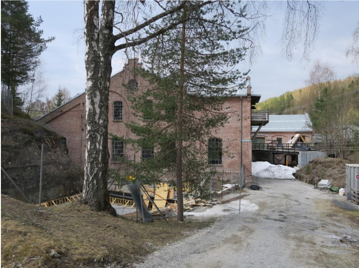
Tresliperiets østre vegg. I bunnen av bygningens østvegg var vanninntaket til turbinene.
