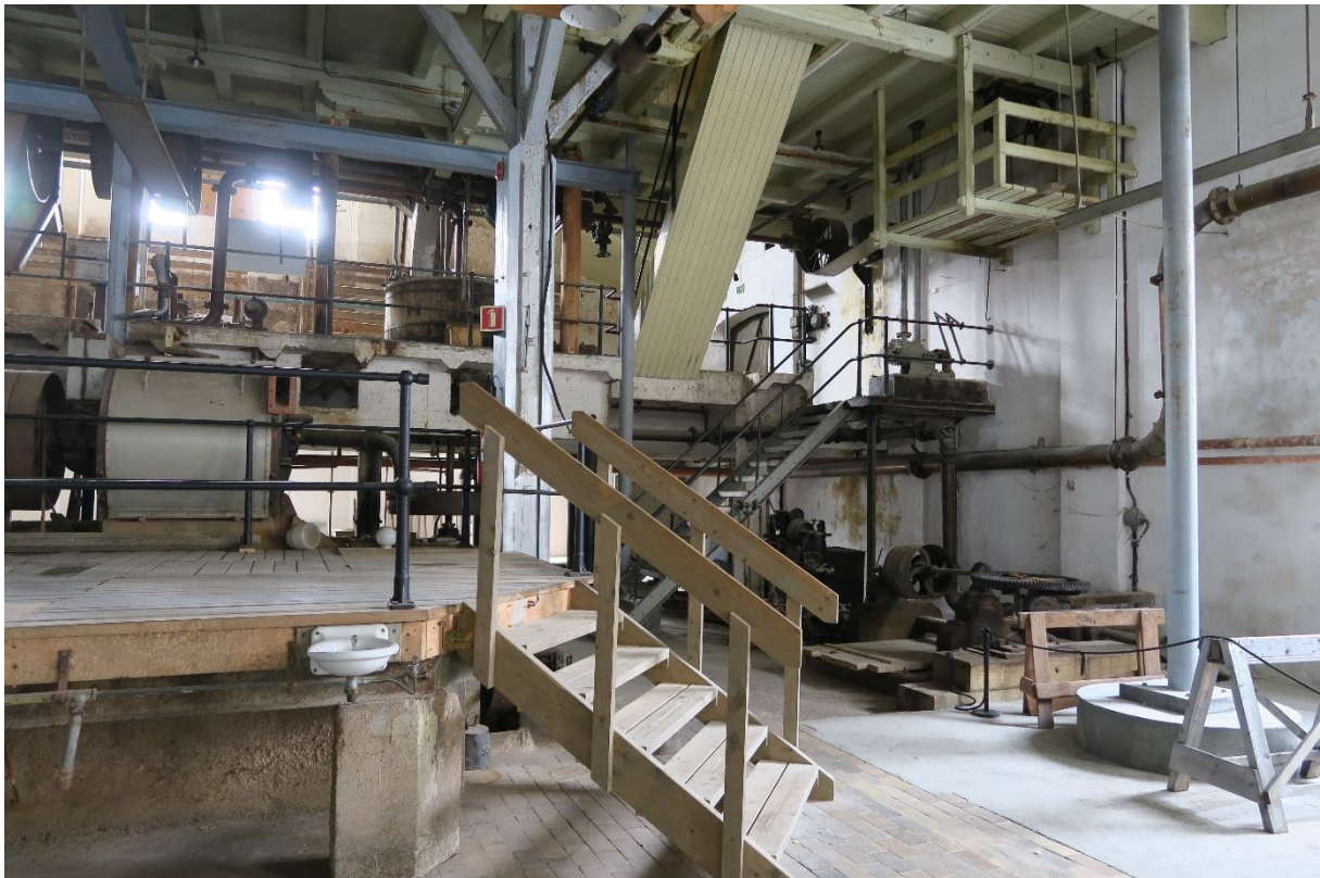
Til venstre i bildet vises litt av podiet med sentrifugalsorteringerne. I øvre del av bildet er Sliperisalen. Bak podiet og under Sorteringen er akslingsrommet.
