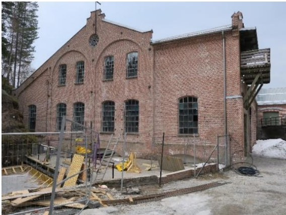
To. Tresliperiets østre vegg. Th. her strømmet vann inn i turbinrørene til de fire turbinene knyttet opp mot de fire slipemaskinene inne i Sliperiet og til hovedturbinen. Ved fredningstidspunktet er dette området tørrlagt. Foto: Cathrine C. Arnesen, Riksantikvaren 2019.
