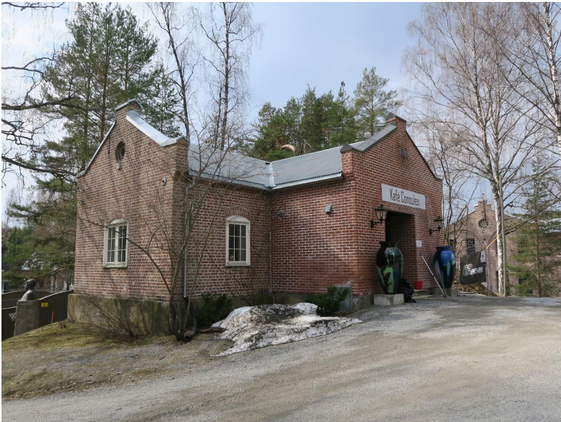
Messas østre gavlvegg og påbygget inngangsparti mot nord.
