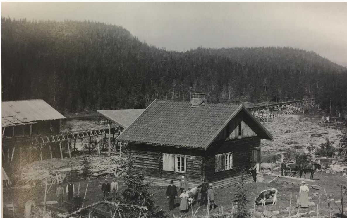
Den gamle sagmesterboligen på Åvella i Land med en tømmerrenne i bakgrunnen. Dette er en av skogseiendommene tresliperiet kjøpte, fotografert mellom 1902 og 1910. Foto: Kistefos-Museet, KIS.F000008
