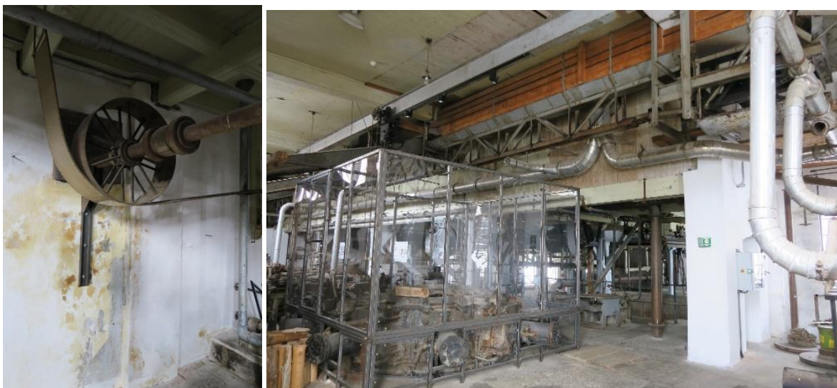
Tv. detalj av reimverk på vegg mot nord. Th. en av slipemaskinene er «satt i drift» og kan settes i gang som en demonstrasjon for publikum på hvordan den fungerer, men den har bare en brøkdel av farta den en gang hadde. Den er ikke koblet opp mot turbinen i kjelleren.
