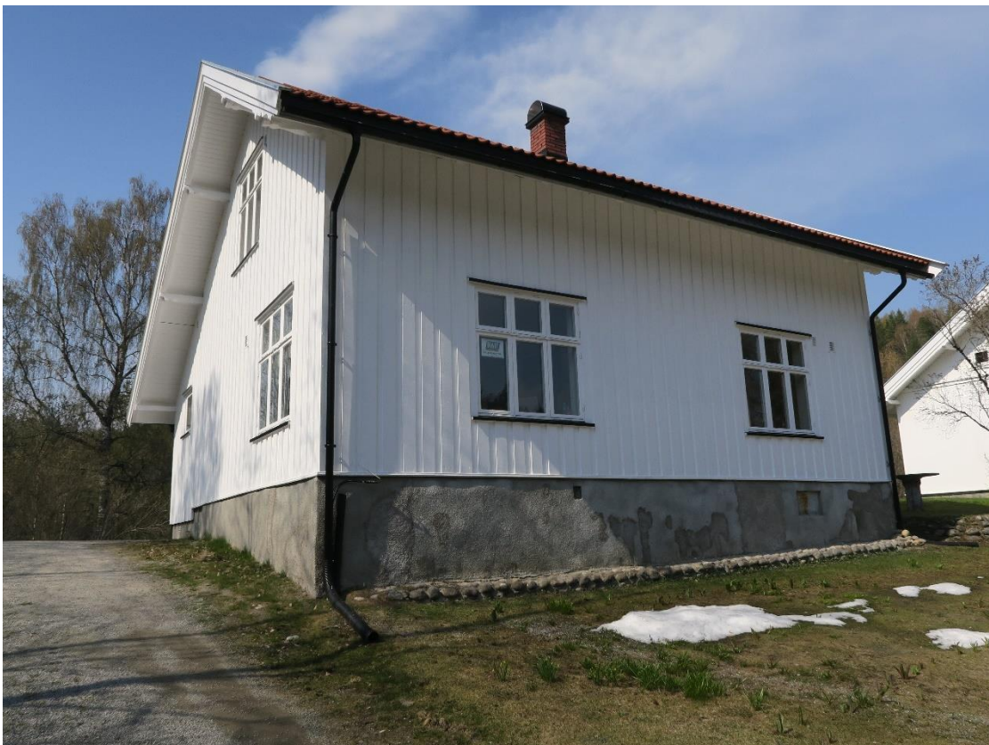
Reparatørboligens østre vegg og søndre gavlvegg.
