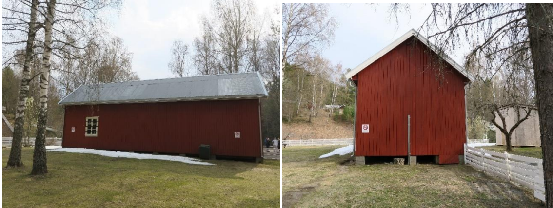
Tv. vestre vegg og th. søndre gavlvegg.
