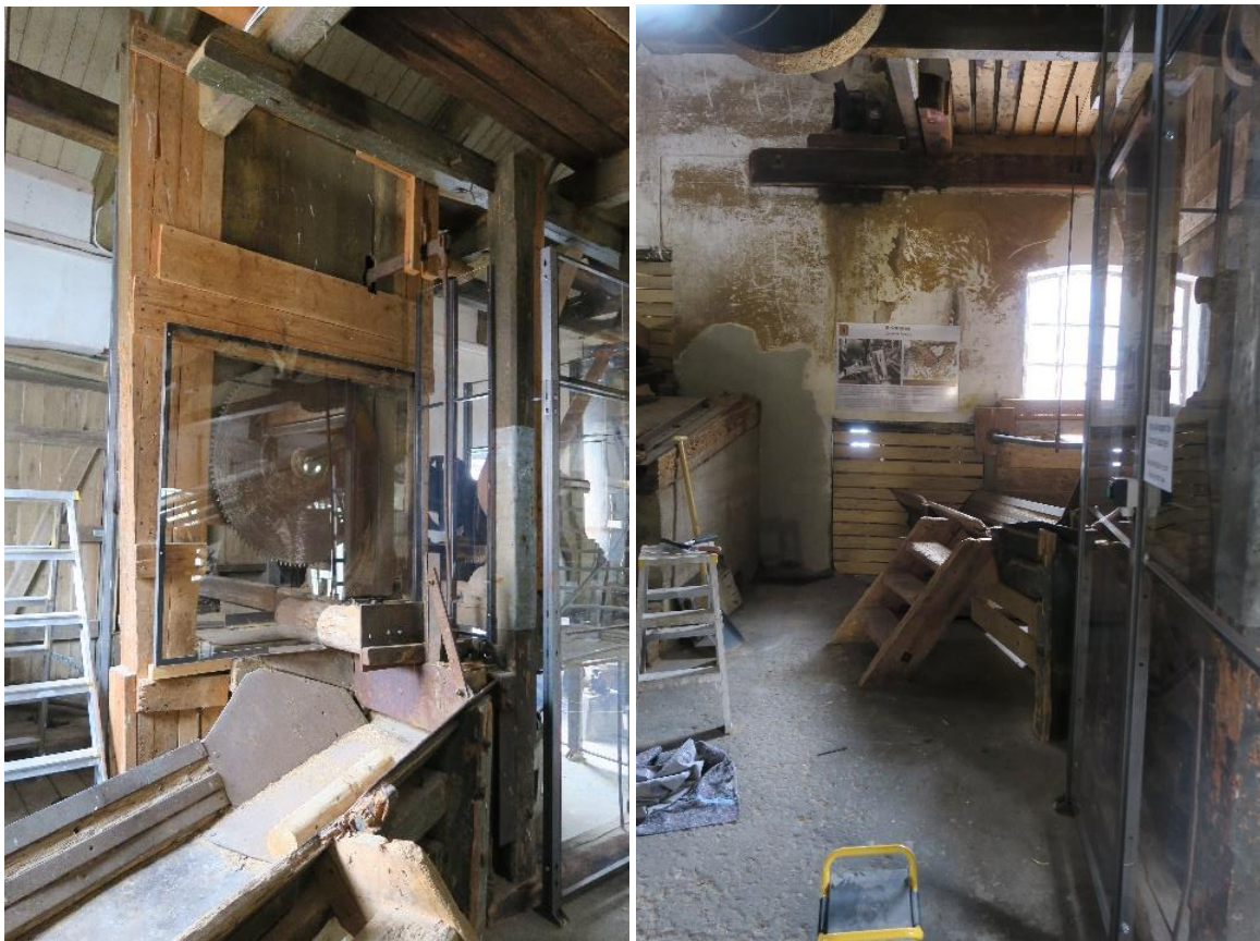
Tv. nærmest til høyre kommer tømmerstokkene inn på rullebommen gjennom østre vegg og kappes. Kappen går videre til transportrenna som fører til Renseriet. Th. kappsag og renne til høyre i bildet ved østre vegg.
