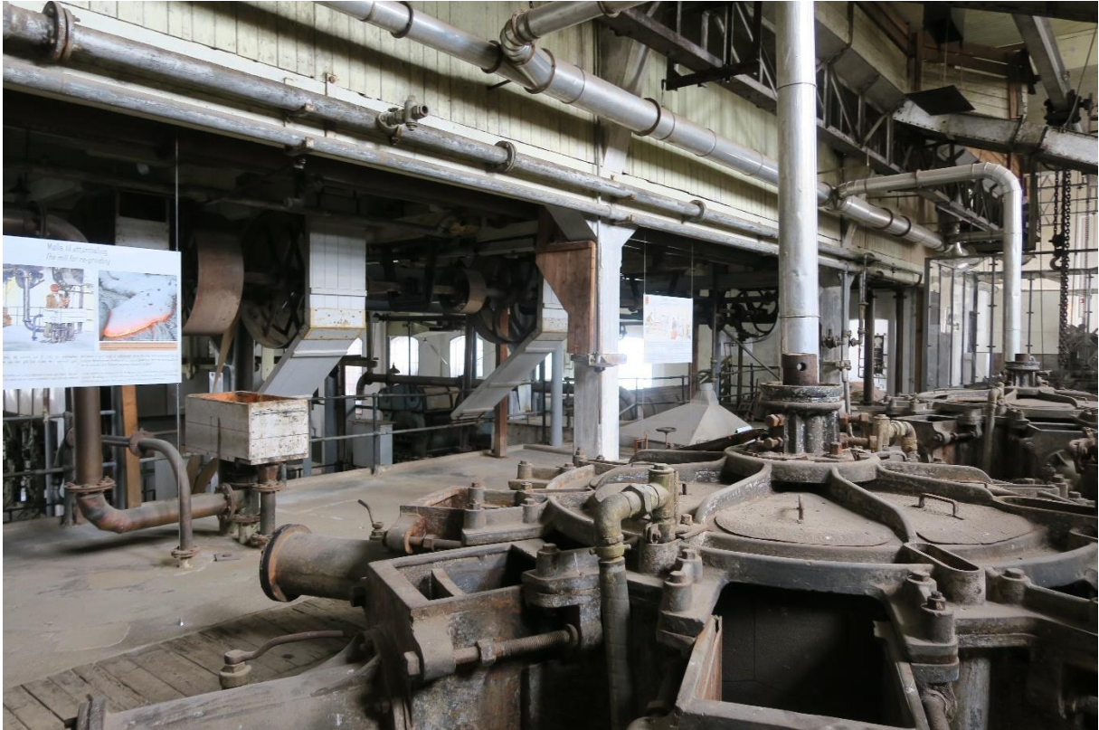
Sorteringen sett fra sliperisalen med slipemaskin i forgrunnen. Til venstre i sorteringen ses den hvite kassa som er påfyllingen til mølla, og til høyre metallokket som er groosollet.
