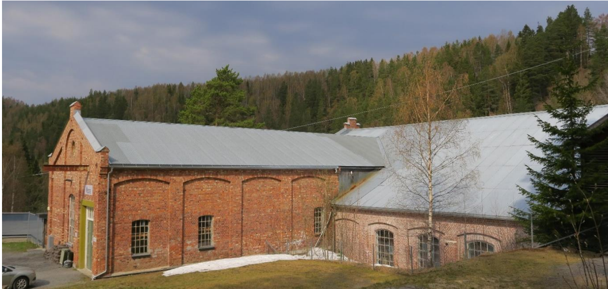
Mesnabyggets søndre gavlvegg og vegg mot øst. Søndre vegg i Tresliperiet til høyre.
