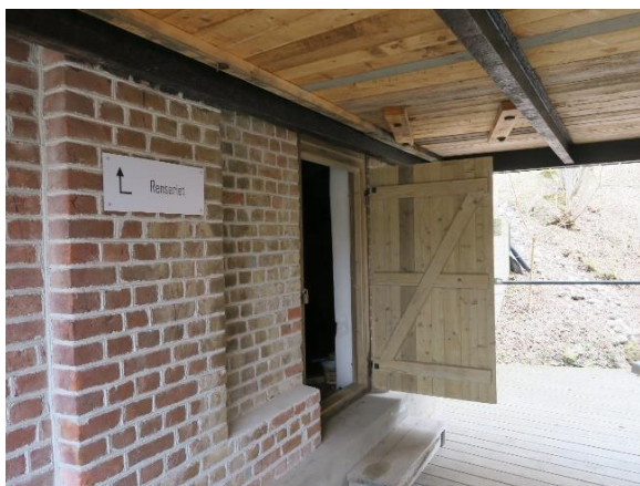
Tv. vestre vegg i passasjen for kubbtransportøren. Bygget i tre med ett støpejernsvindu i vestveggen. Th. inngang til Rensseriet i søndre vegg.
