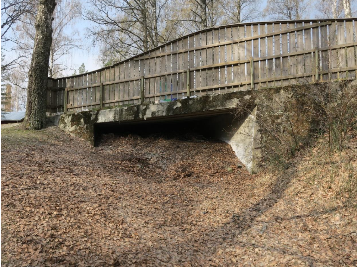
Kulverten sett fra Båthuset.
