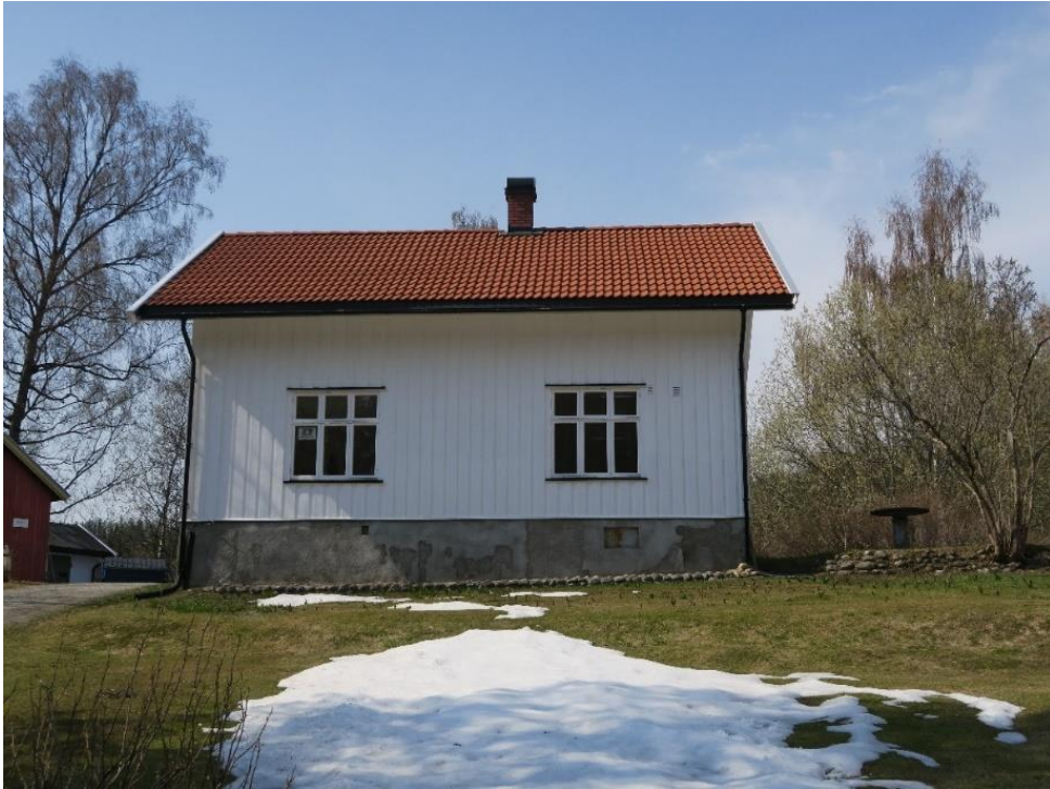
Reparatørboligens østre vegg.
