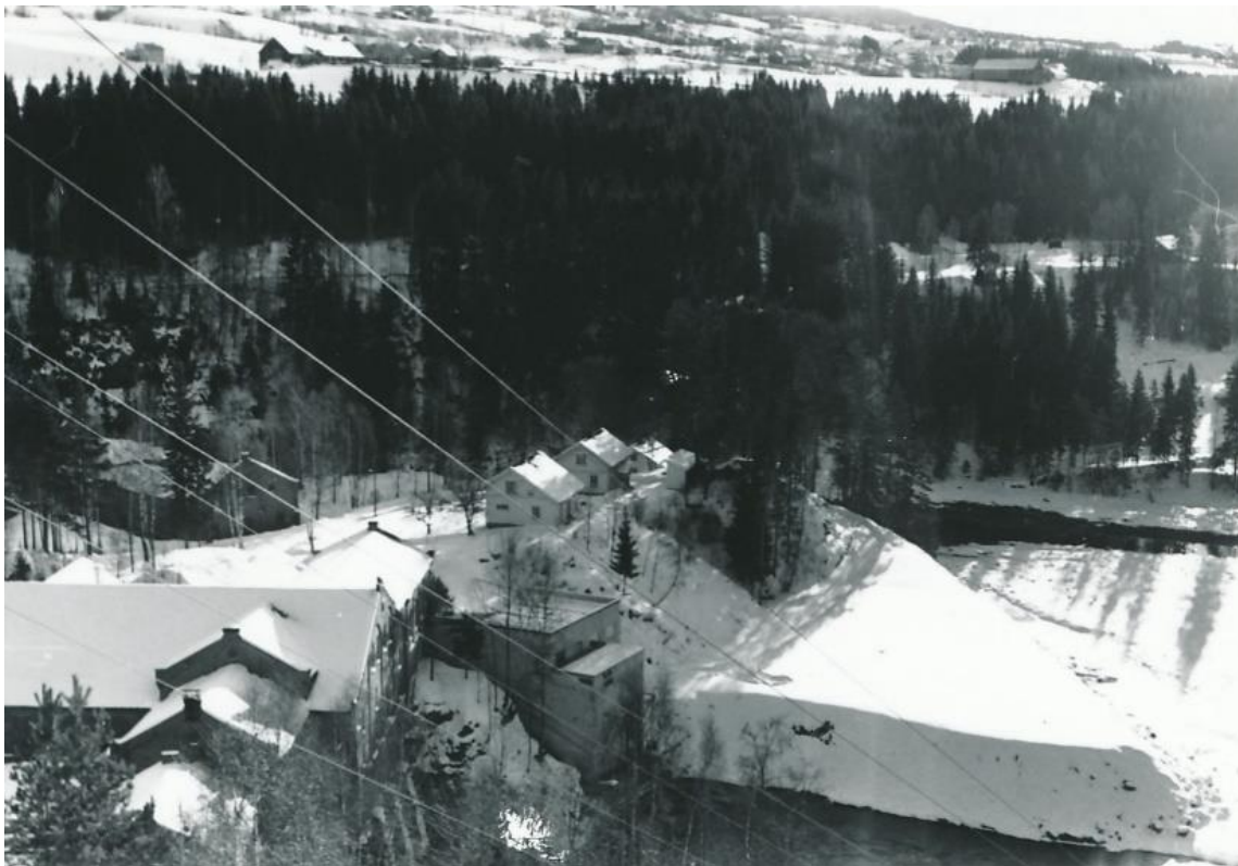
Bak Formannsboligen og Reparatørboligen skimtes Holterhuset, foto fra 1960. Foto: Kistefos-Museet, KIS.F000102
