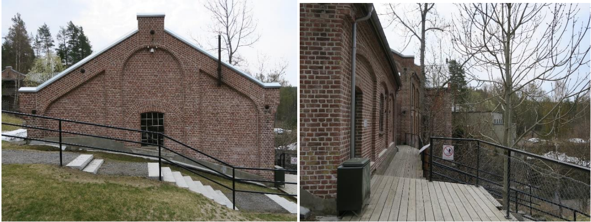
Tv. Renseriets nordlige gavlsoegg, og th. vestre vegg med nybygget plattform for å tilrettelegge for publikum.
