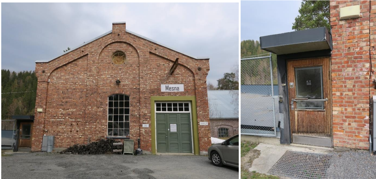
Tv. for å få plass til to nye vertikale slipemaskiner kjøpt av Mesna Træsliperi- og Kartongfabrikk i 1946, måtte fabrikkbygningen utvides. Bygget sto ferdig i 1948 og har navnet Mesna. Her er søndre gavlvegg. Til venstre for bygningen er døra til kraftstasjonen Kistefoss 2, satt i drift i 1955. Th. detalj av døra til kraftstasjonen Kistefoss 2.
