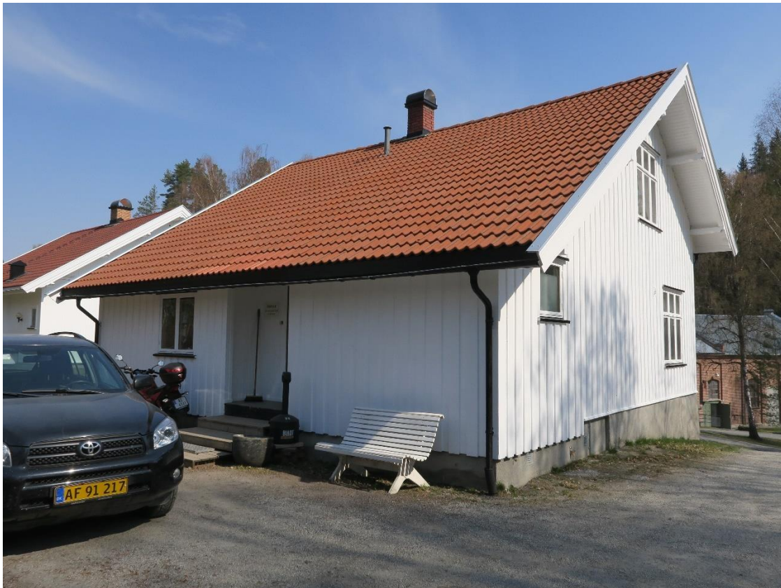
Boligens søndre gavlvegg og vestre vegg.
