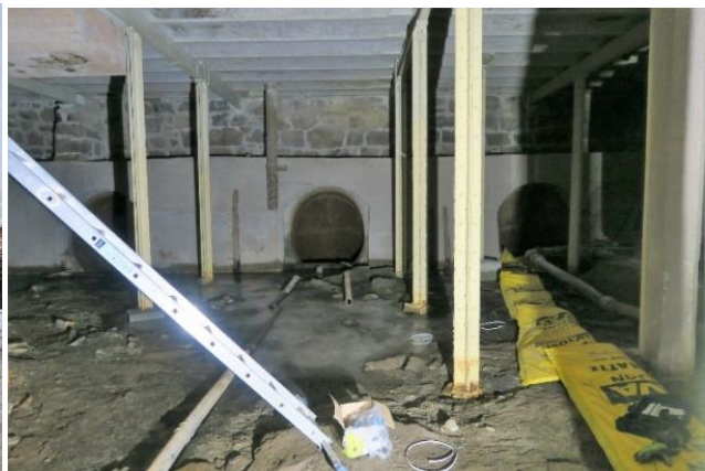
To. Tresliperiets østre vegg. Th. her strømmet vann inn i turbinrørene til de fire turbinene knyttet opp mot de fire slipemaskinene inne i Sliperiet og til hovedturbinen. Ved fredningstidspunktet er dette området tørrlagt. Foto: Cathrine C. Arnesen, Riksantikvaren 2019.
