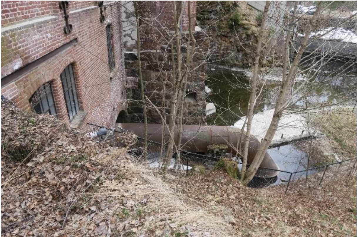
Detalj av rør fra en av turbinene på vestre vegg. Foto: Cathrine C. Arnesen, Riksantikvaren 2019.
