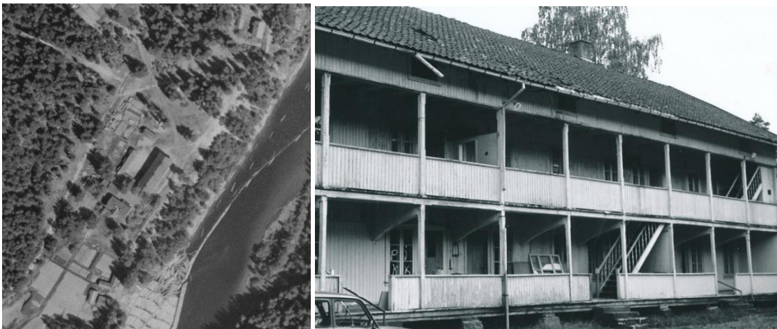
Den store bygningen midt på kartfotoet er Arbeiderboligen. Kartfoto fra finn.no datert 1947. Th. Arbeiderboligen fotografert i 1980, sett innenfra gårdsplassen og fra nordvest. I Arbeiderboligen var det rimelig husleie og den kunne reduseres eller fjernes i perioder med produksjonsstans. Beboerne hadde en åkerlapp og de fikk råtekubb som brensel og elektrisitet. Foto: Åse Lange, Kistefos-Museet, KIS.F000063
