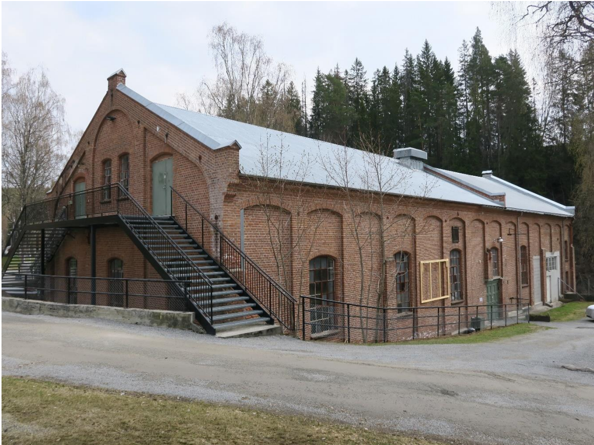
Nordvestre gavlvegg med en relativt nybygd trapp, og sørvestre langvegg.
