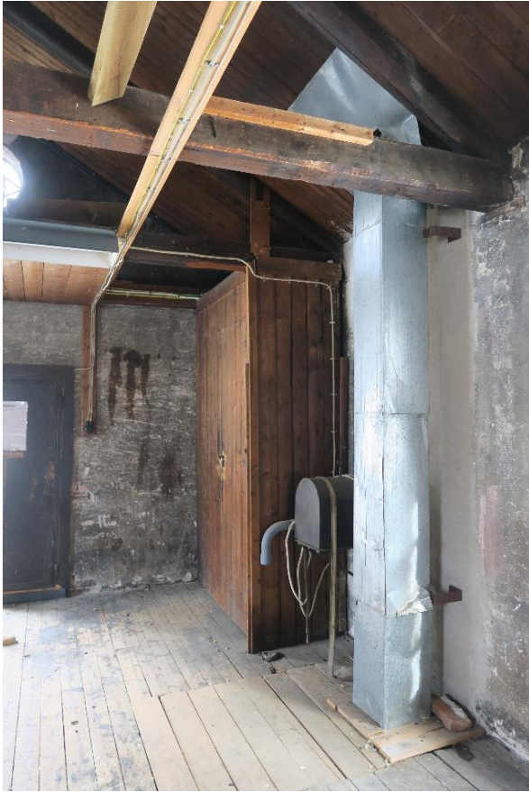
Tv. plassbygd skap langs østre vegg. Ved siden av skapet er det en luftkanal og muligens en apparatur/boks som gir luft inn. Th. detalj av luftkanalen og apparaturen/boksen ved siden av som muligens førte luft inn. Disse elementene antas å være knyttet opp mot smia og essa som befant seg rett under.
