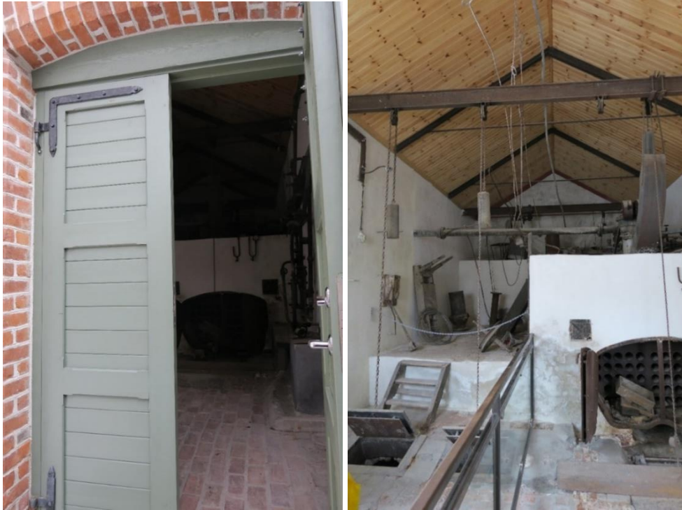
Tv. inngang til Fyrhuset i byggets vestre vegg. Th. Fyrhusets interiør sett mot østre golvvegg.
