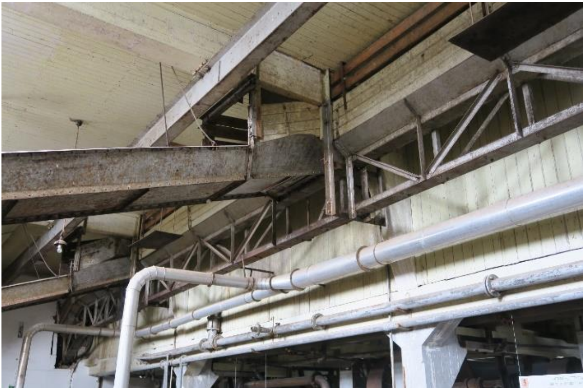
Detalj av kubtransportøren og to renner som førte kubber til siloen.
