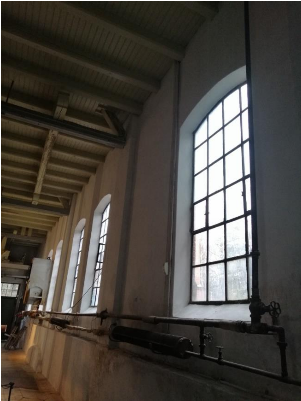
Rør for sentralvarmesystemet i Produksjonshallen langs golvveggen mot øst ved inntakskanalen til turbinene. Sett mot porten og nordøstre hjørne.
