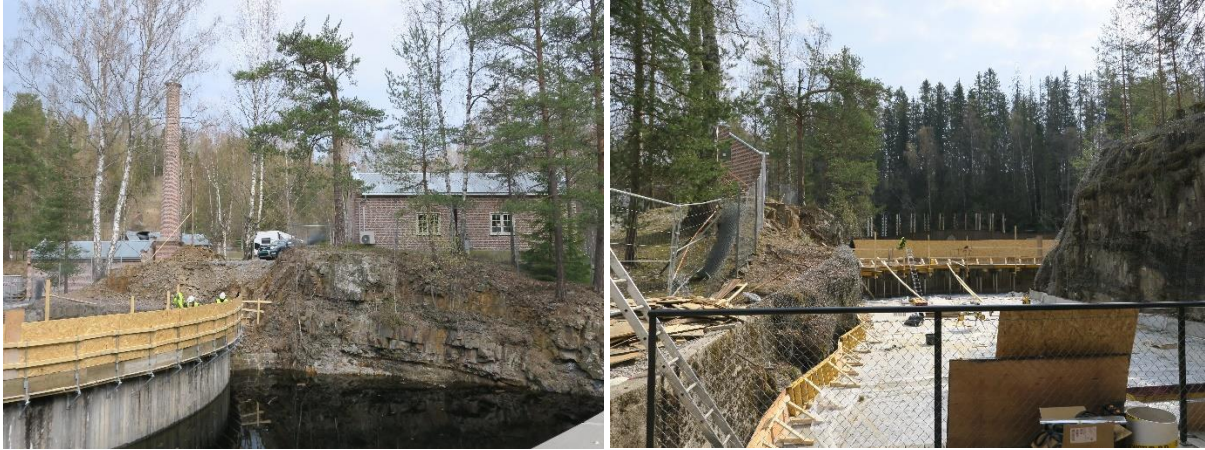
Tv. Messas sørvegg. Th. vannspeil bygges opp på nytt. Tidligere flommet vann inn her, rett nedenfor Messa, og inn i turbinrørene i bunnen av tresliperiet og videre inn i turbinene som igjen satte de horisontale slipemaskinene i gang. Bildene er fra våren 2019. Midt i vannspeilet ble det i mai 2019 avduket en stedsspesifikk skulptur av Yayoi Kusama, Shine of Life.
