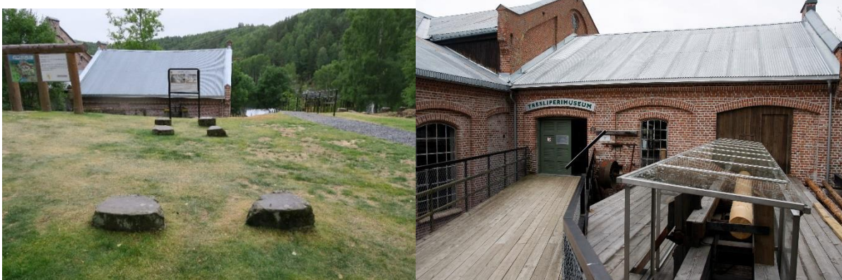
Produksjonslinja startet med tømmerinntaket og kjerraten. Kjerraten fraktet tømmeret fra elva og opp til fabrikken. På bildet tv. vises restene av kjerratens fundamenter. Foto: Cathrine C. Arnesen, Riksantikvaren 2018. Fra kjerraten ble tømmeret fraktet inn til fabrikken på en rullebom, bilde th. Første stopp inne var Kapphuset. Foto: Ulf Gustafsson, Riksantikvaren 2015.
