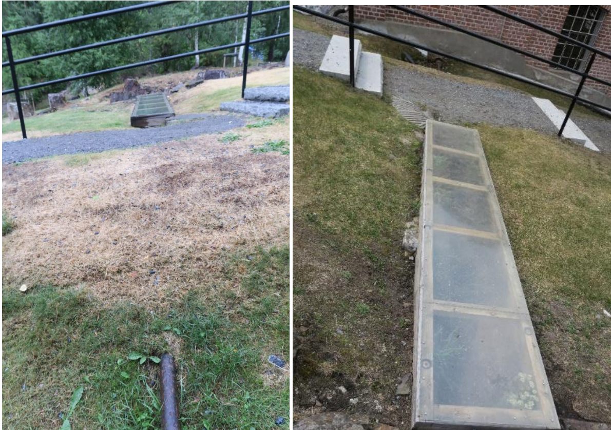
Fragmenter av drivakslingen til saga i Saghuset. Tv. sett fra Renseriet og mot Saghusruinen, foto: Cathrine Arnesen, Riksantikvaren 2018. Th. sett fra Saghusruinen mot Renseriet. Deler av akslingen har fått beskyttelse for noen år siden.
