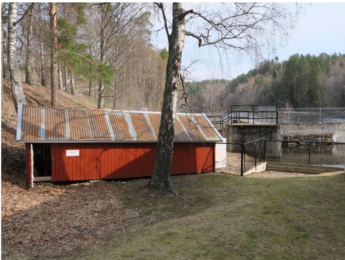
Båthusets sørlige vegg med dør.
