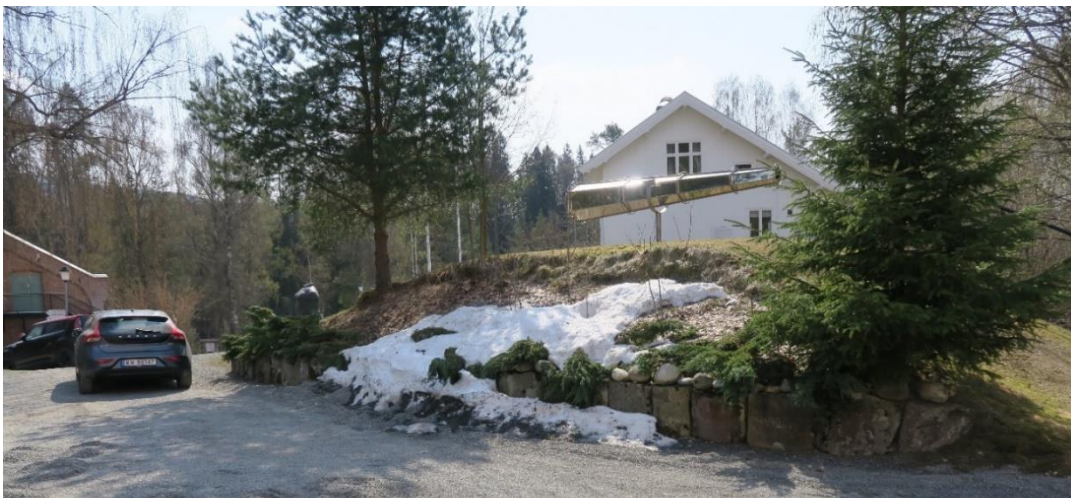
Formannsboligens nordre vegg. Foto: Cathrine Arnesen, Riksantikvaren 2019.
