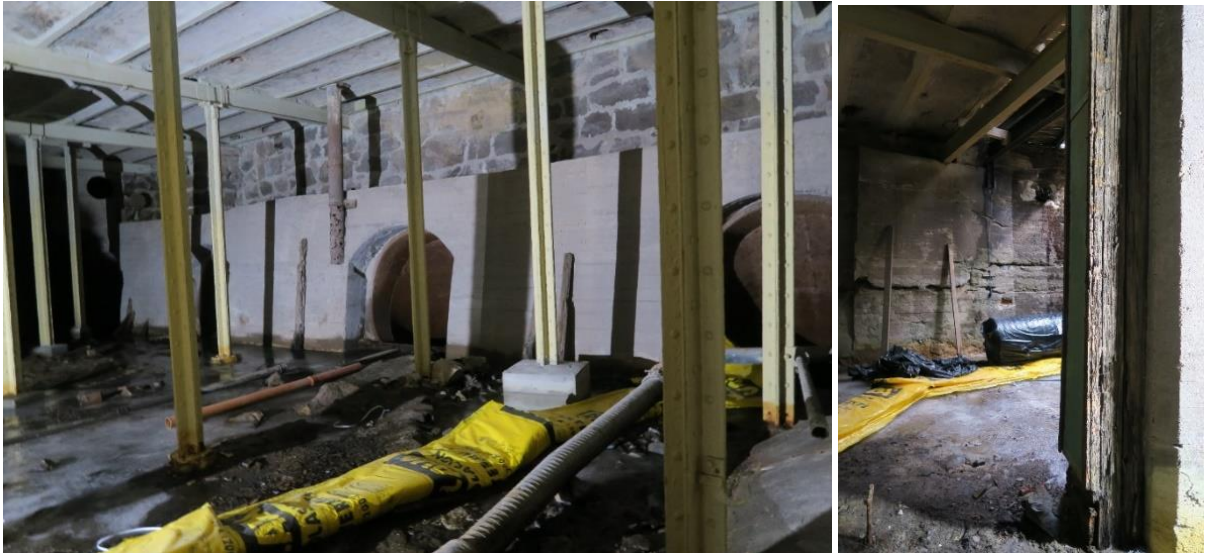
Tv. vanninntak til turbinrør i østre vegg. Th. detalj av en mørken kanal i rommet ved turbinrørintaket, mulig et avfallsrør. Begge foto: Cathrine C. Arnesen, Riksantikvaren 2019.
