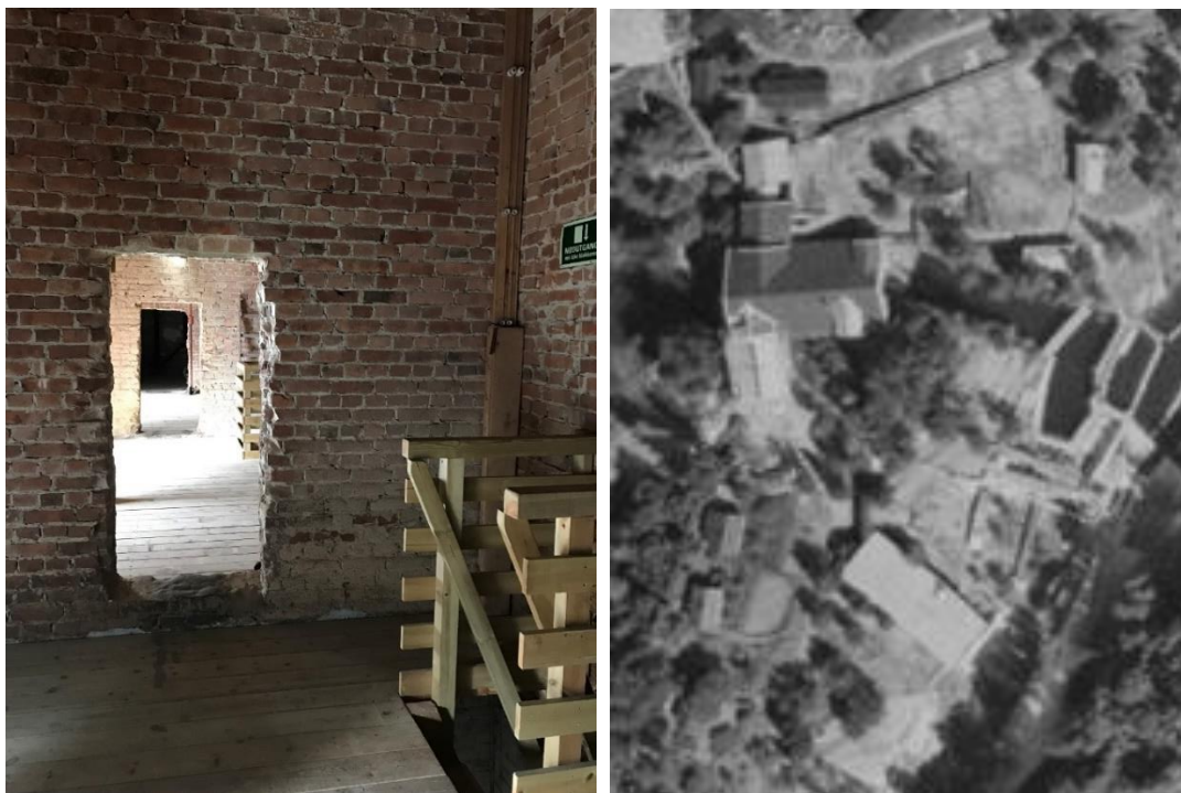
Tv. andre nivå under akslingsrommet der de fire akslingene går gjennom på vei mot hver sin turbin. Sett mot nordre vegg. Th. kartfoto fra 1947 med tresliperiet i senter. Her vises vannets vei inn mot fabrikkens turbinrør i øst og videre gjennom rør under fabrikkbygningen mot turbinene i kjellerdypet i vest, og ut i Randselva vest for bygget.
