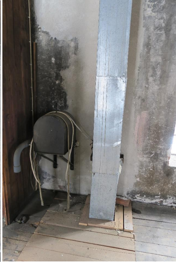
Tv. plassbygd skap langs østre vegg. Ved siden av skapet er det en luftkanal og muligens en apparatur/boks som gir luft inn. Th. detalj av luftkanalen og apparaturen/boksen ved siden av som muligens førte luft inn. Disse elementene antas å være knyttet opp mot smia og essa som befant seg rett under.
