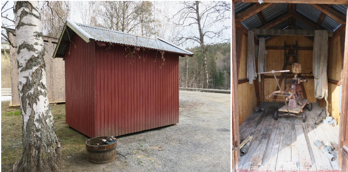
Tv. Brannhuset med bakre gavlvegg og langvegg. Th. Brannhuset har originalt gulv.
