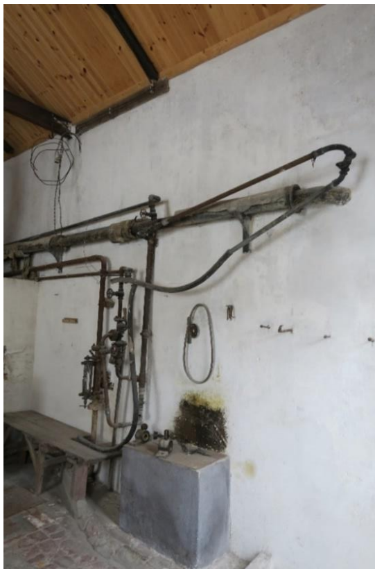
Tv. detalj av fyrkjelen og rør for sentralvarmesystemet på vegg mot sør. Th. detalj av sentralvarmesystemet der vanndamp ble sendt inn til fabrikkbygningene for oppvarming vinterstid.
