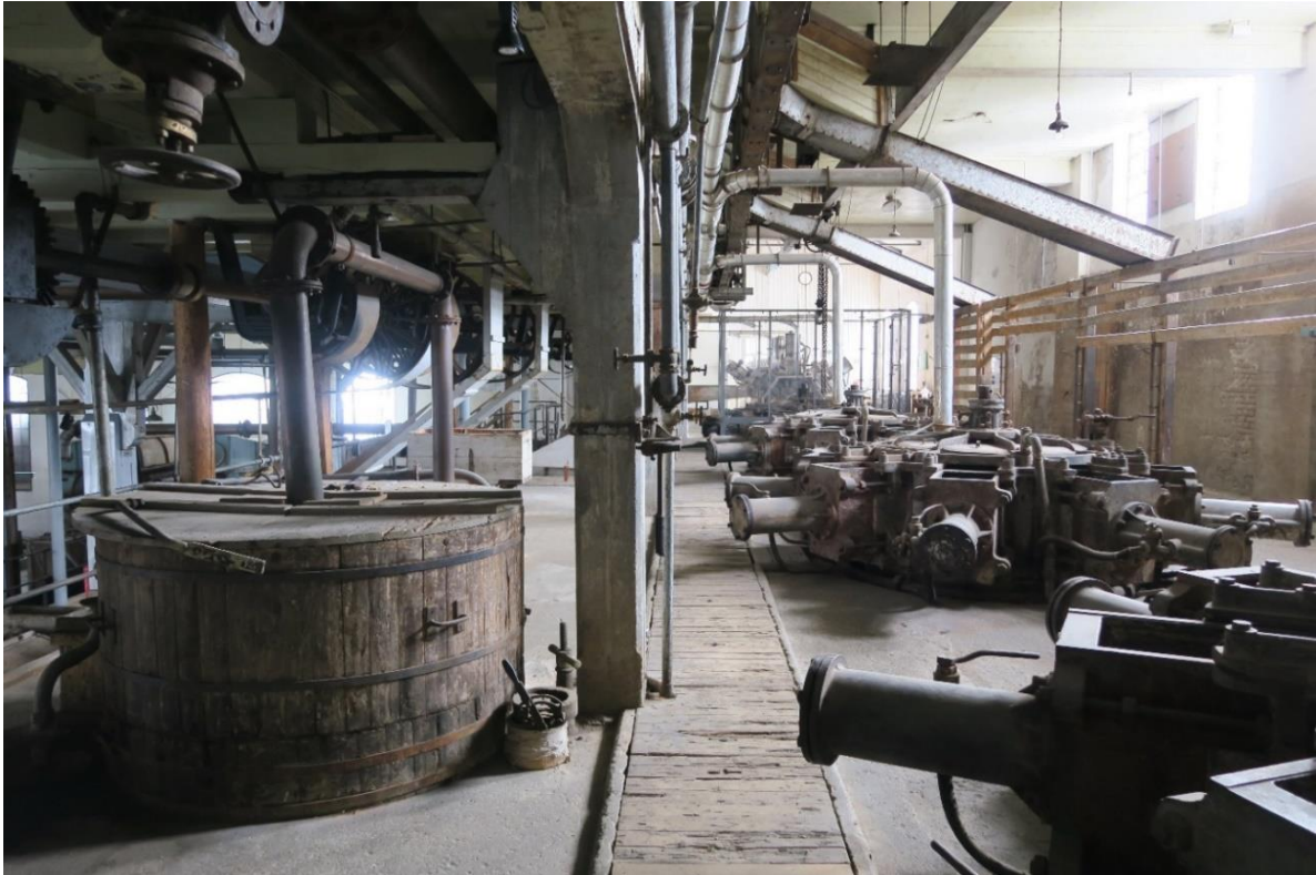
Sliperisalen sett fra kapphuset og mot nybygget i sør med de to vertikale slipemaskinene fra 1948. De fire horisontale slipemaskinene står på rekke til høyre. Til venstre er området for den såkalte sorteringen der flis ble skilt ut fra tremassen. To av rennene til kubtransportøren leder kubbene til kubbsiloen som befinner seg på høyre side av plankegjerdet/stengselet i tre.
