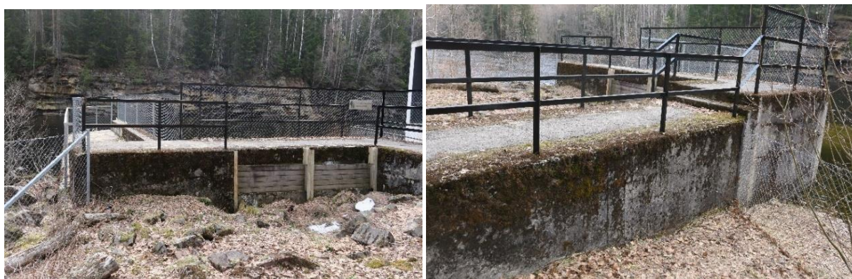
Tv. tømmerfløtingsanlegget sett fra vest og th. fra sørvest.
