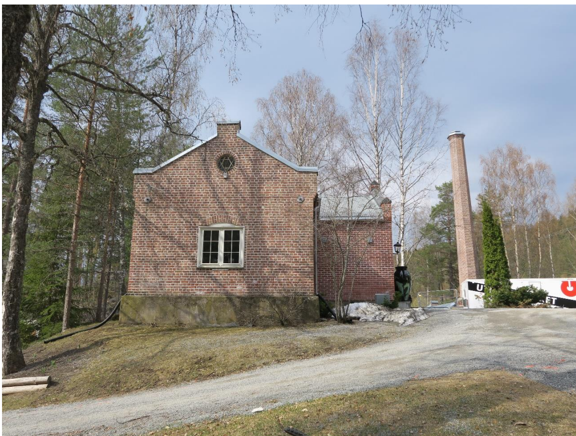
Messas østre gavlvægg. Fyrhusets pipe til høyre.
