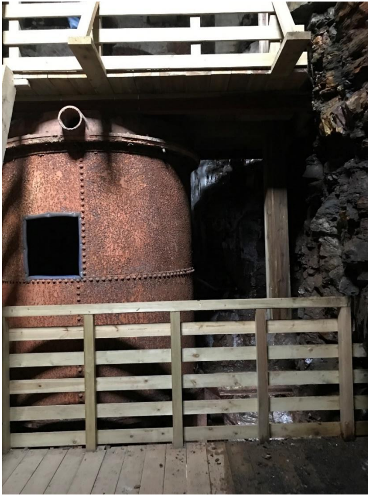
Nivå 4. I bunnen av denne beholderen ligger francisturbinen. Dette er turbinen 1 lengst mot sør. Over turbinbeholderen ses podiet for nivået over. Podiene er en museal tilpasning og er av nyere dato.
