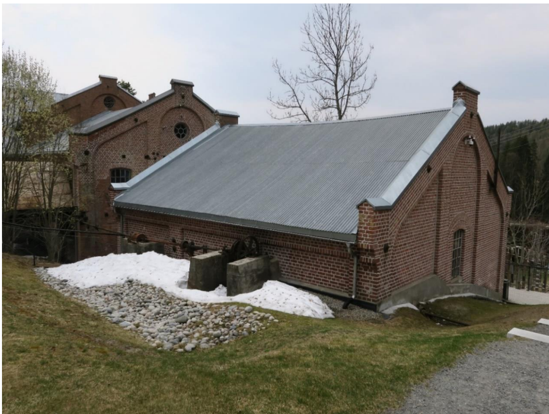
Tresliperiet sett mot nordøstre hjørne og gavløeggen mot nord. Nærmest er Renseriet der kapp ble renset for bark i tromler. Dette bygget ble oppført i 1917. Maskineriet på Renseriets østre vegg var sannsynligvis knyttet opp mot kjerraten og Saghuset. Til venstre for Renseriet ligger Kapphuset der tømmerstokkene ble fraktet inn på rullebommen og kappet opp inne.
