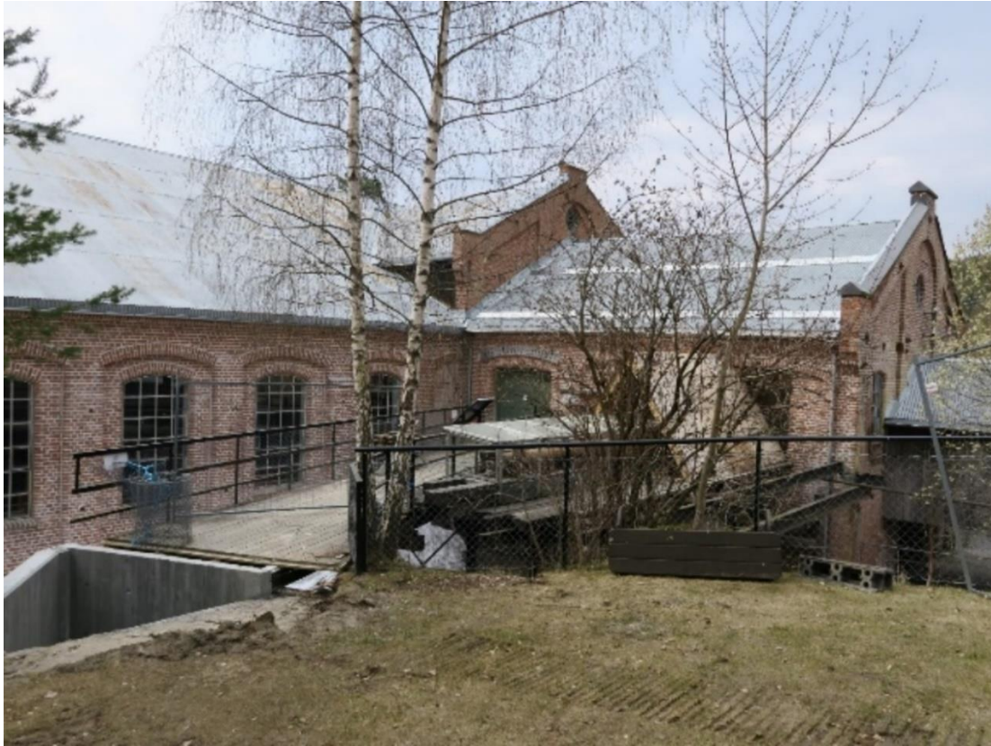
Tresliperiet. Inngangen til Kapphuset i østre vegg med tømmerbom.
