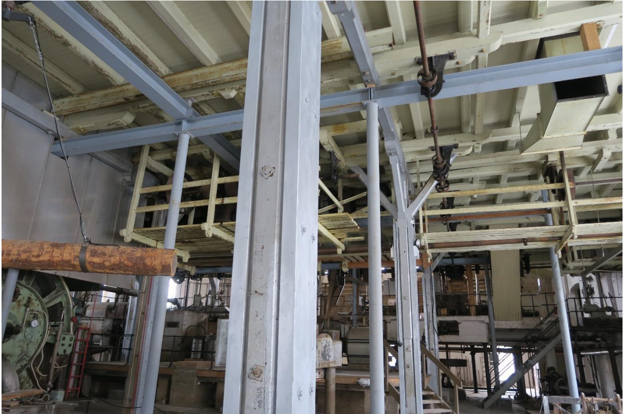
Hallen sett mot sørvest.
