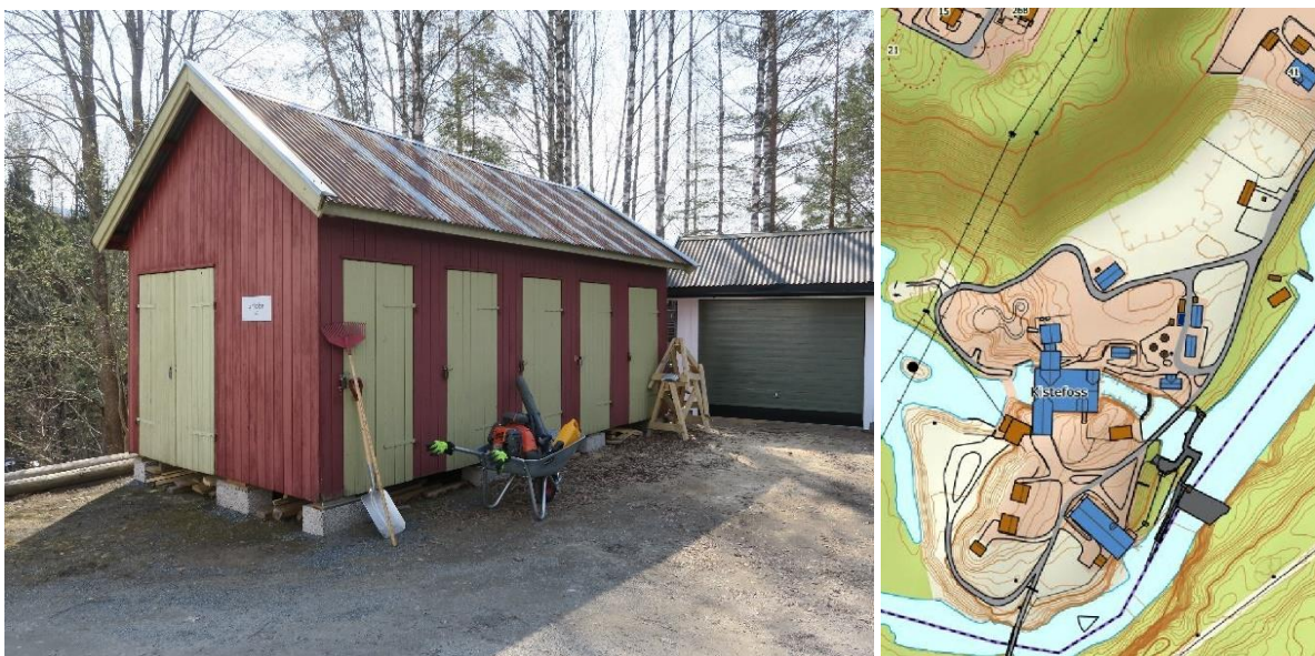
Jernbodene fra 1955, gnr./bnr. 150/4, bygningsnummer 157245139. Midlertidig plassert på tunet til Reparatørboligen.
