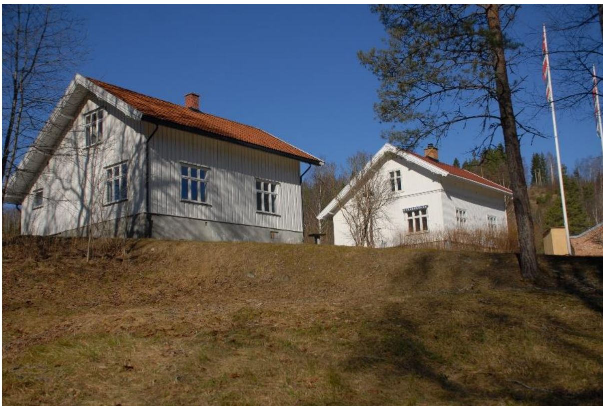
Reparatørboligen til venstre og Formannsboligen til høyre. Foto: Ulf Gustafsson, Riksantikvaren 2015.
