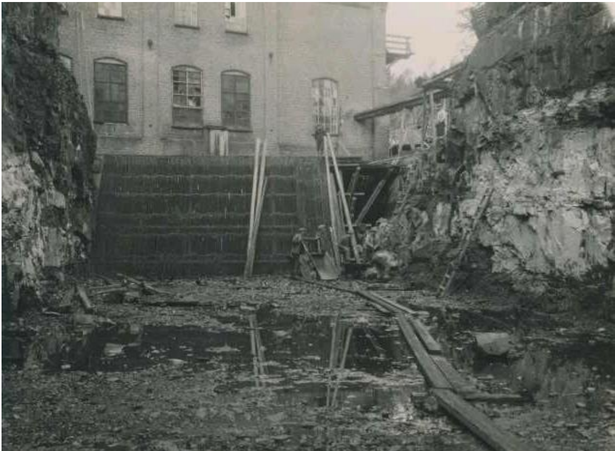
Arbeidere utvider inntakskanalen til turbinene ved Tresliperiet i 1929. Foto: Kistefos-Museet, KIS.F000005
