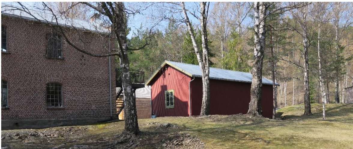
Magasinets søndre gavlvegg og vegg mot øst.
