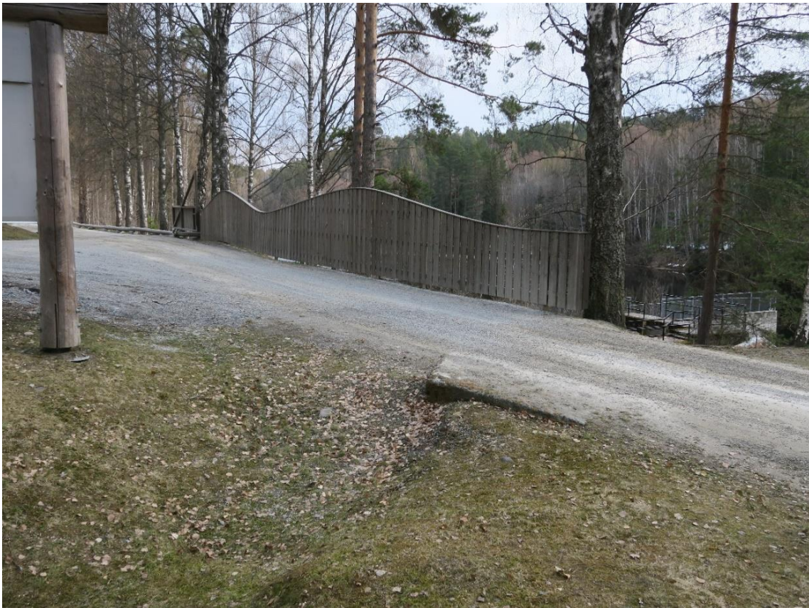
Spor etter kulverten i grunnen ved vestre veikant.
