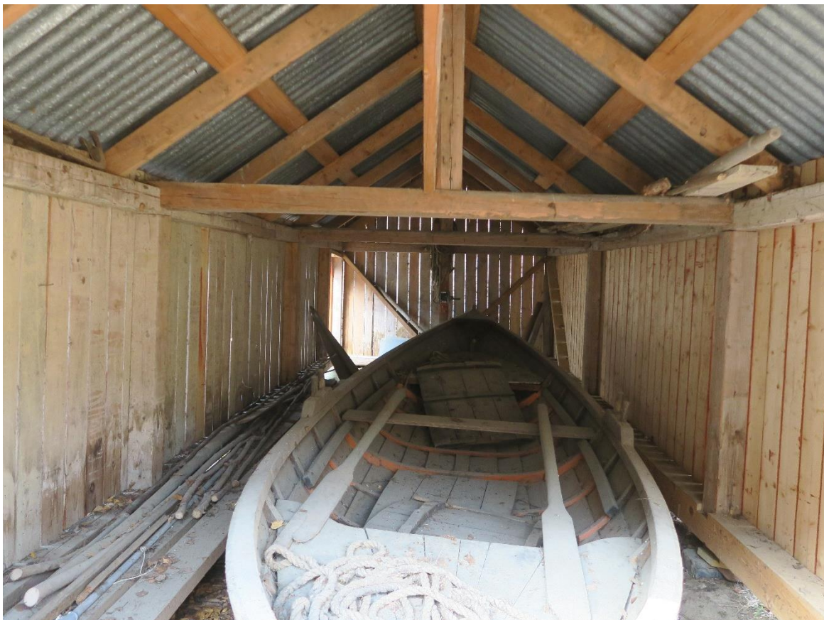
Inne i båthuset er det mulig å se de bærende konstruksjonene.
