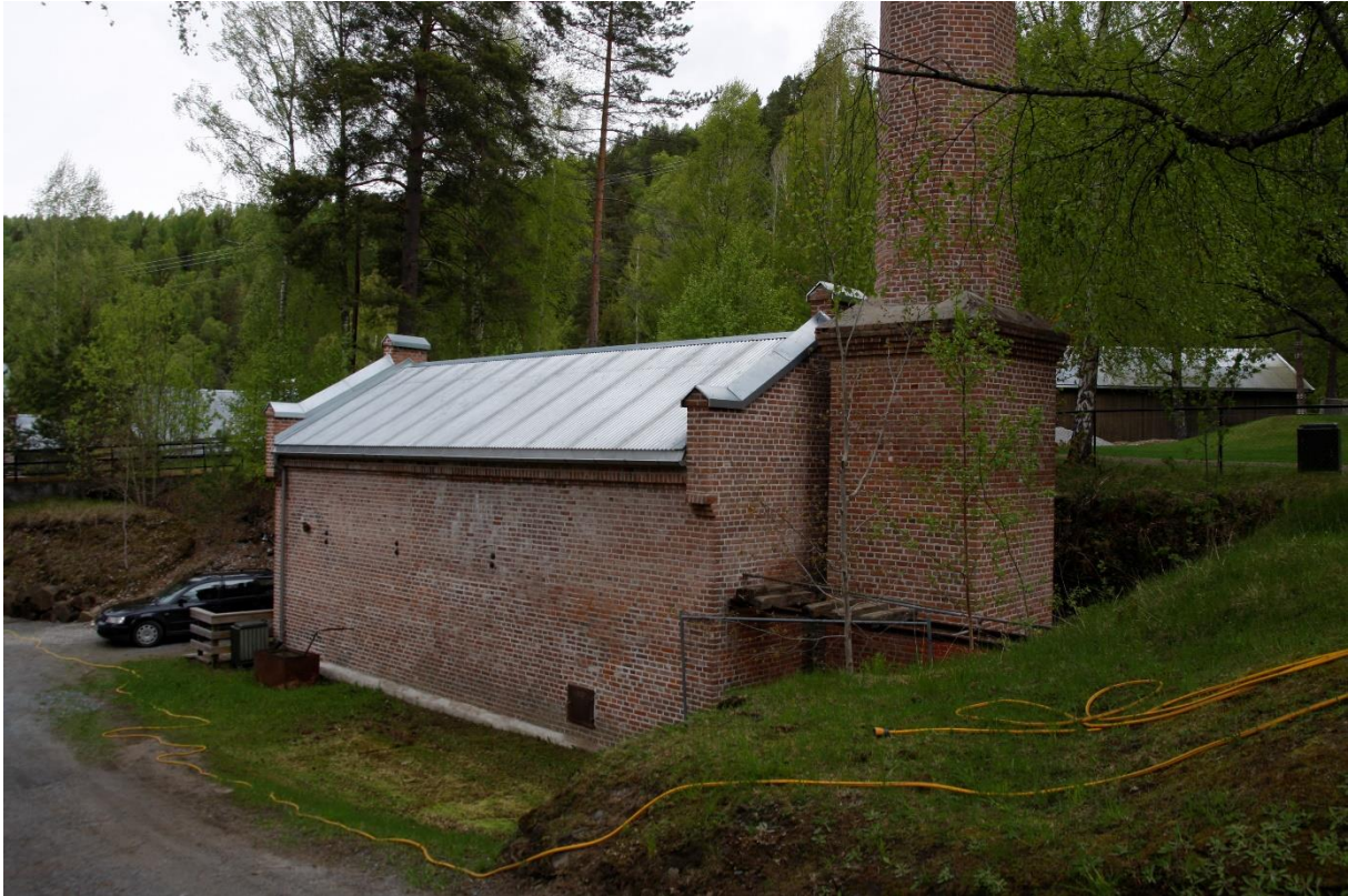
Langvegg mot sør og østre gavlvegg med pipe. Foto: Ulf Gustafsson, Riksantikvaren 2015.
