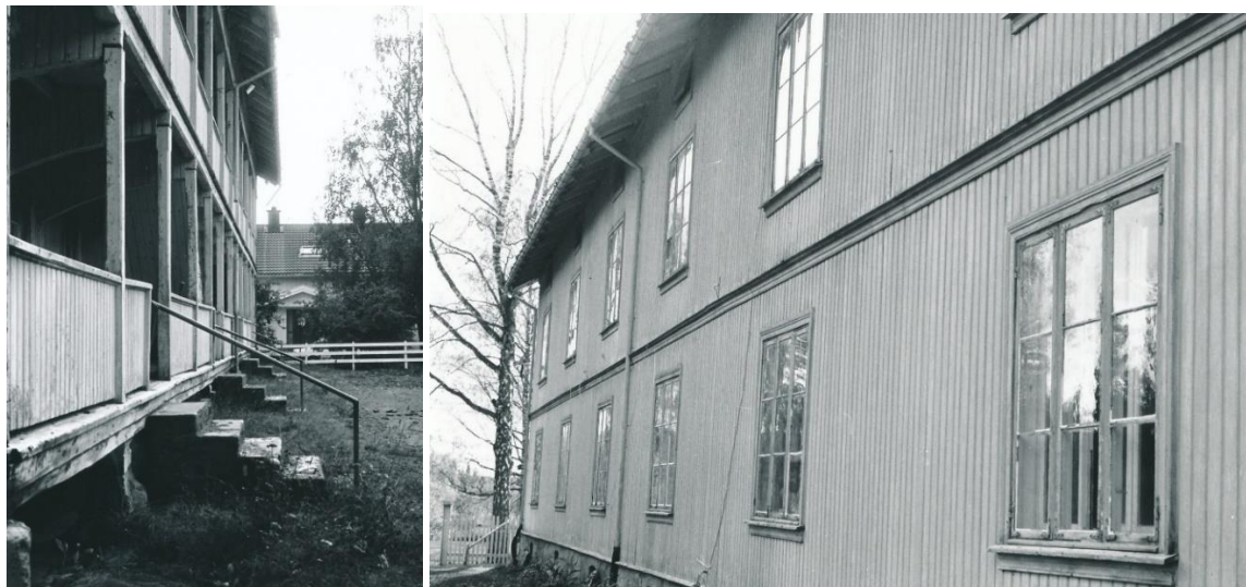
Tv. Arbeiderboligen sett mot Bestyrerboligen, KIS.F000068. Th. Boligen sett fra veien. I bakgrunnen skimtes så vidt porten inn til Bestyrerboligen, KIS.F000081. Foto: Åse Lange, Kistefos-Museet, 1980
