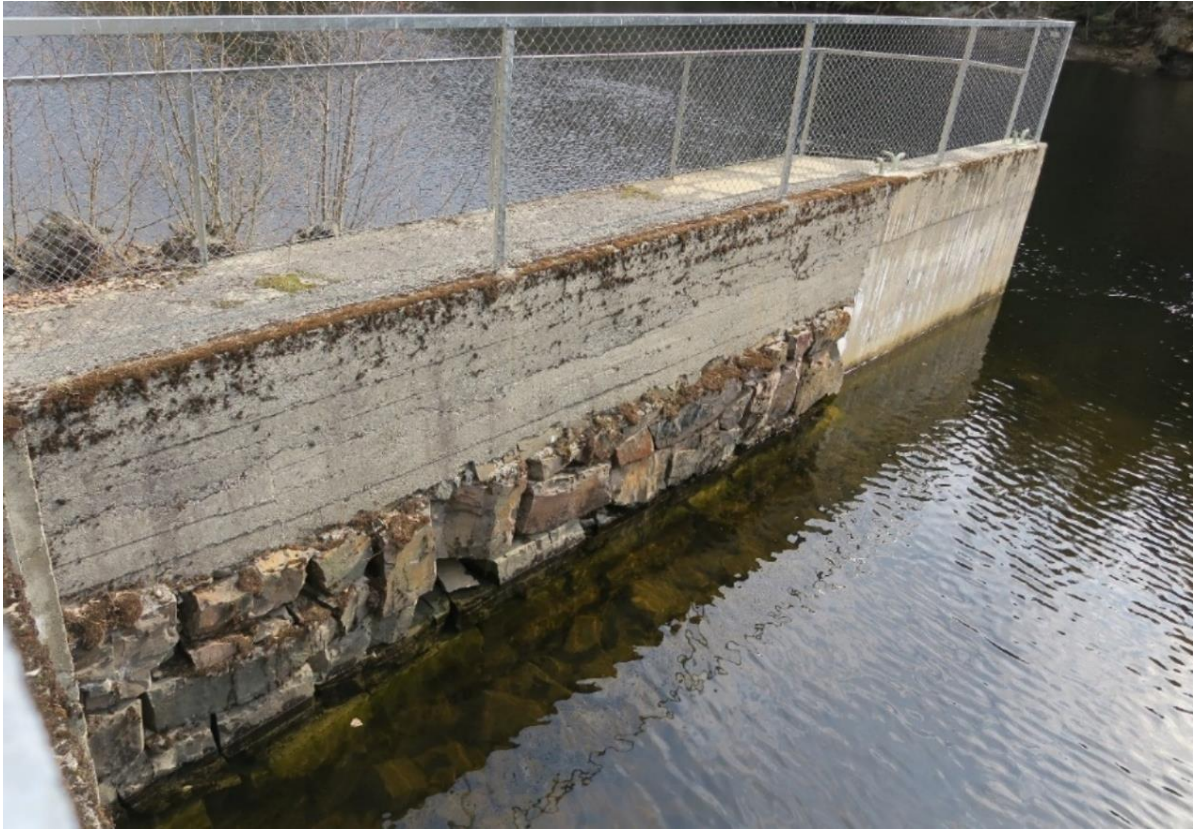
Fløtingsanlegget sett fra anlegget og mot sørvest.
