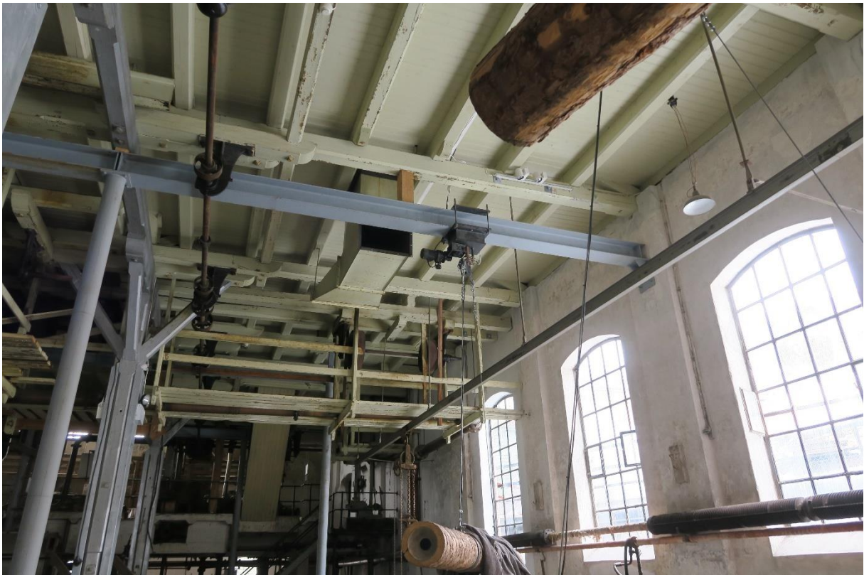
Produksjonshallen sett mot vest, vindusrekke på vegg mot nord.
