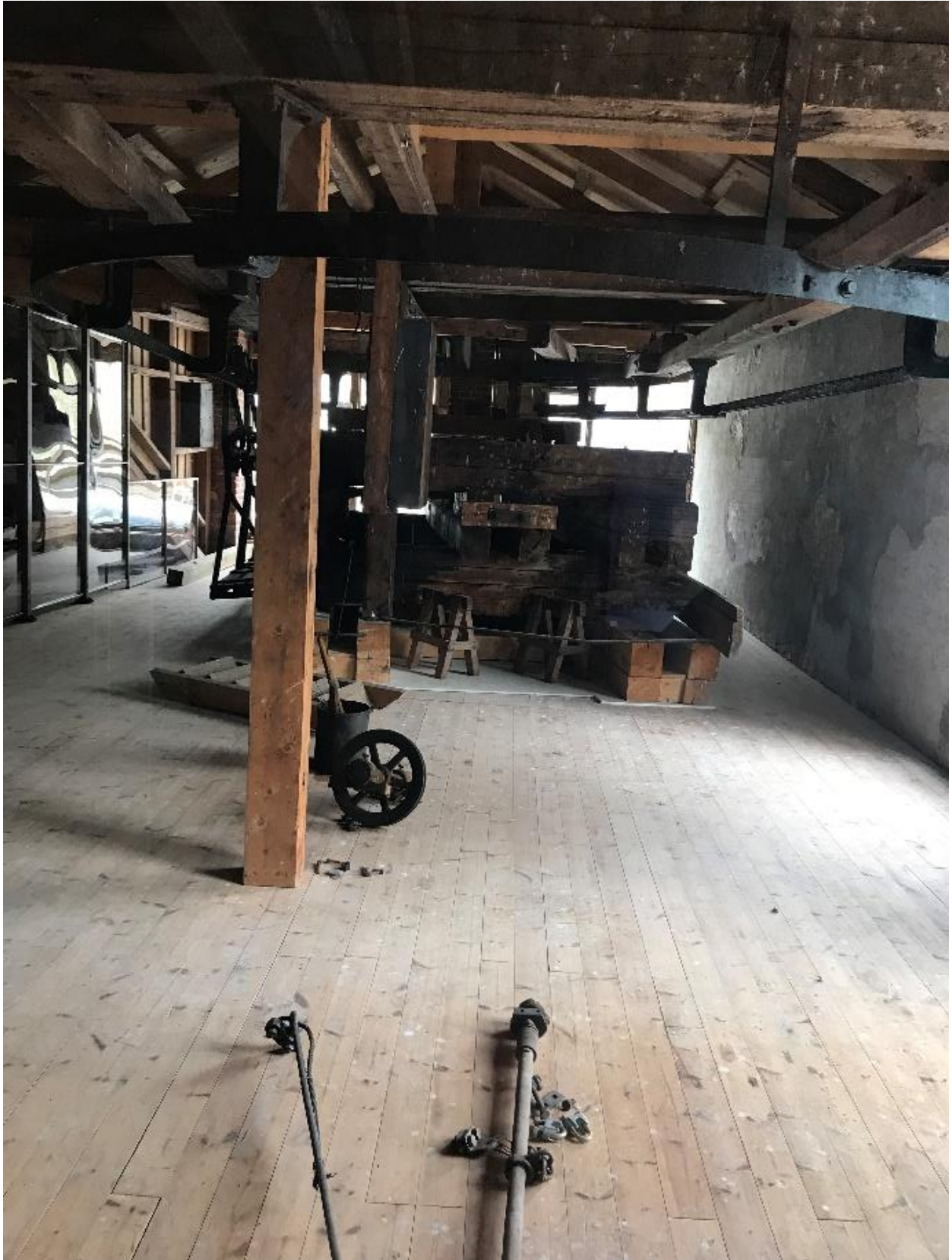
Taubanen sett mot nordre vegg og med østre vegg til høyre.
