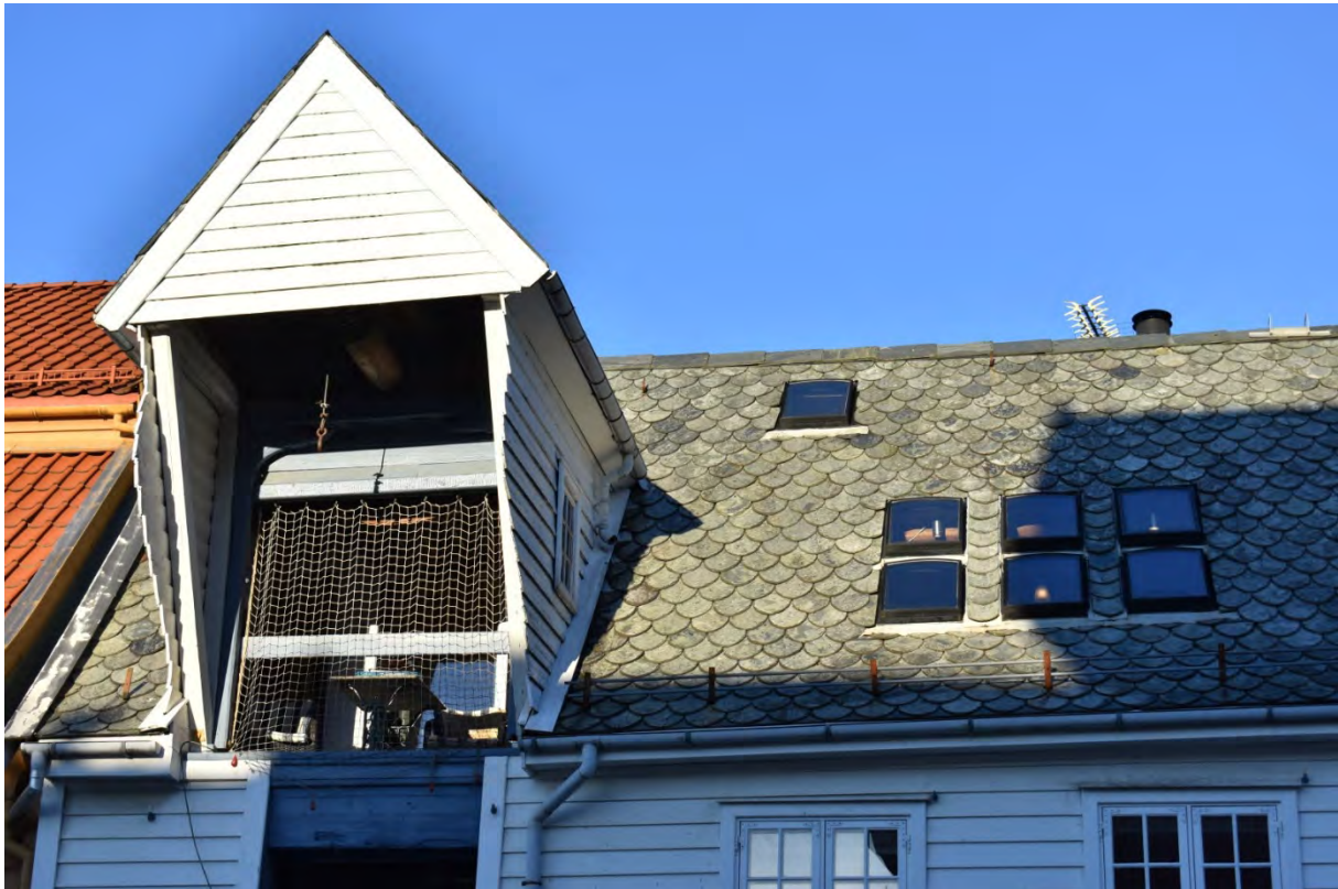
Sandviksbodene 19 A, vindeark på sørfasade
