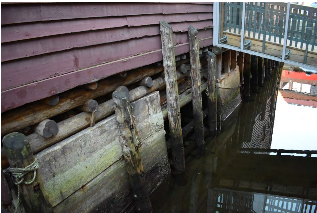
Sandviksbodene 24. Austfasade mot hopen mellom bod 23 og 24
