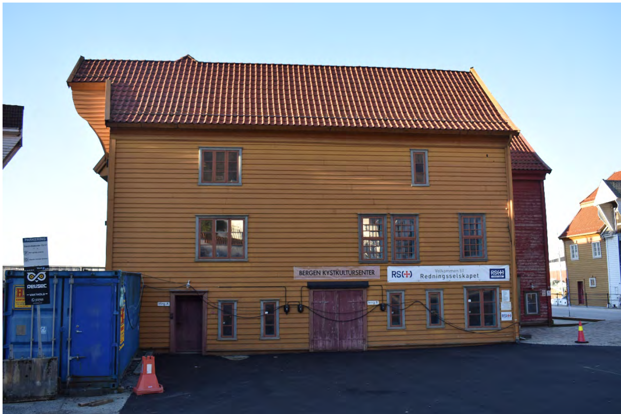
Sandviksbodene 15 B sett frå Sjøgaten
