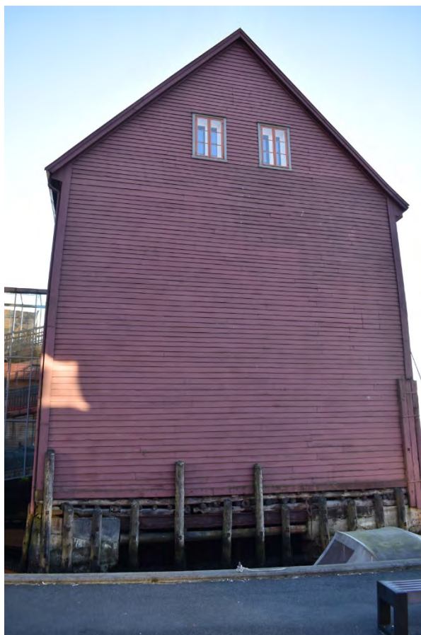
Gavlvegg mot nord
