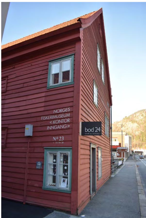
Bod 23 naust, hjørne mot Sjøgaten
