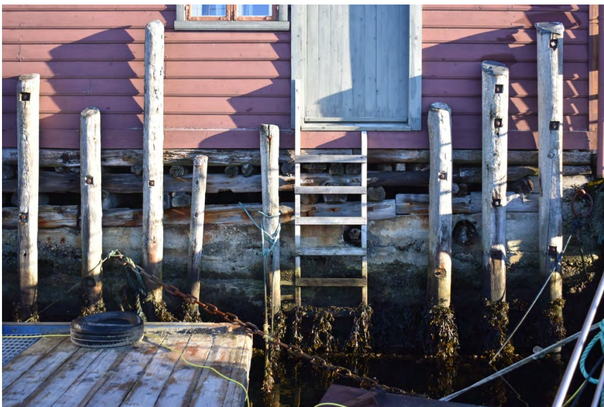
Sandviksbodene 24. Bolverk på sjøsida
