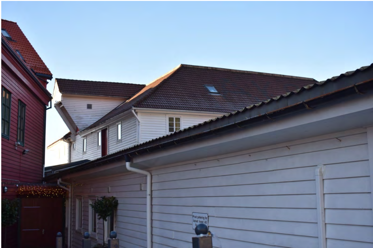
Sandviksbodene 12-13 sett frå Sjøgaten. Nr. 14 i forgrunnen.
