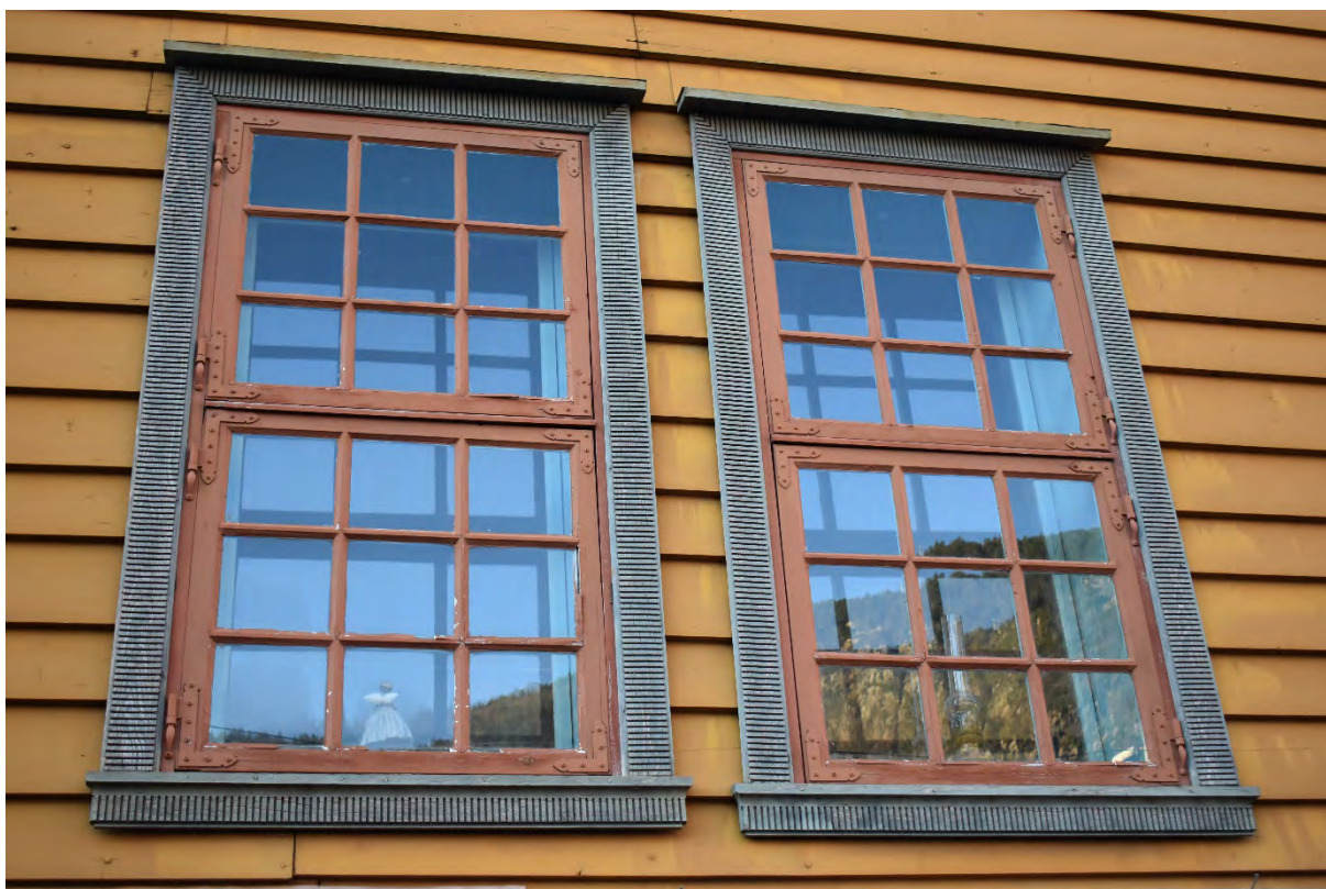
Sandviksbodene 15 B, sett frå Sjøgaten
