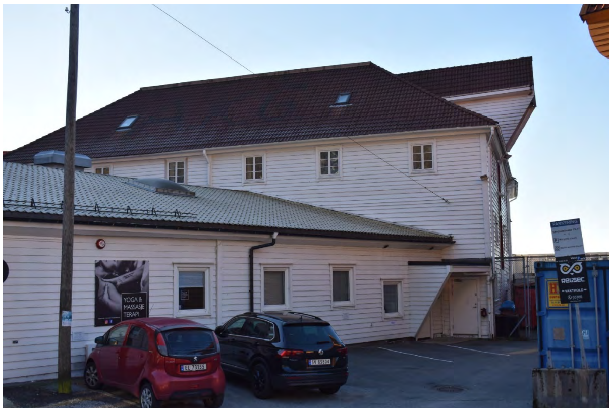
Sandviksbodene 12-13 sett frå Sjøgaten. Nr. 14 i forgrunnen.
