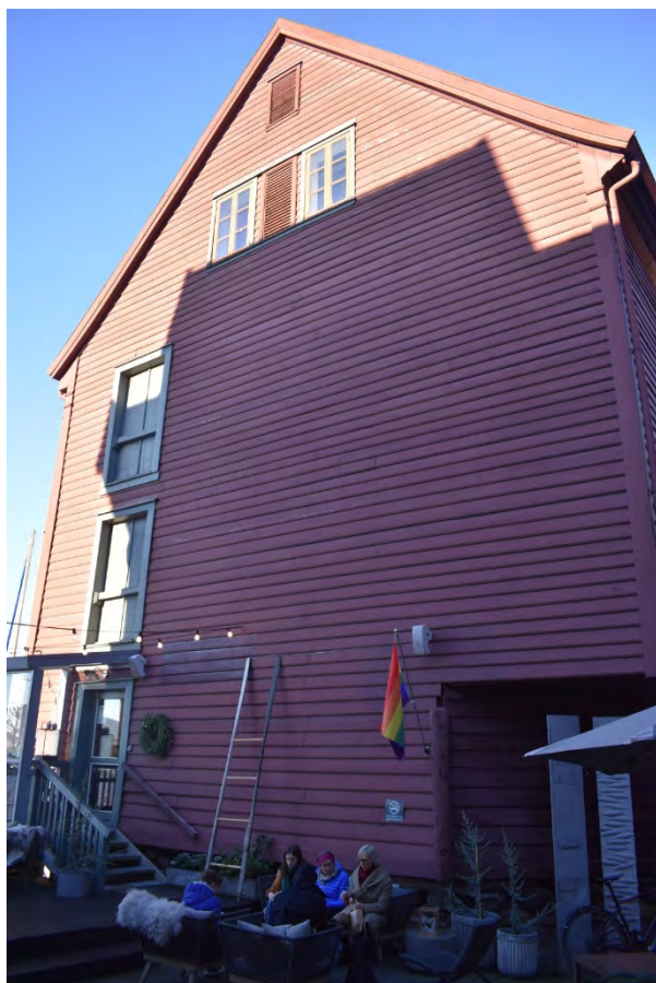
Sandviksbodene 24, fasade mot sør
