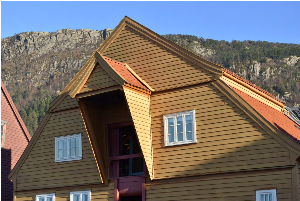
Sandviksbodene 20, vindeark i gavl
