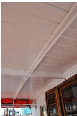
Bærende konstruksjon, takoverbygg.
