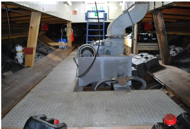
Dørken omkring motor er dekket med platedekk/rifledekk.
