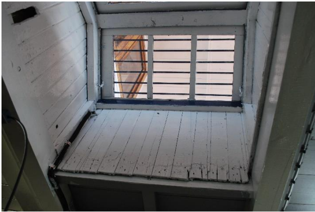
Materialer i skylight er gjenbrukt så langt som mulig. Det meste er uforandret fra perioden før restaureringen.
