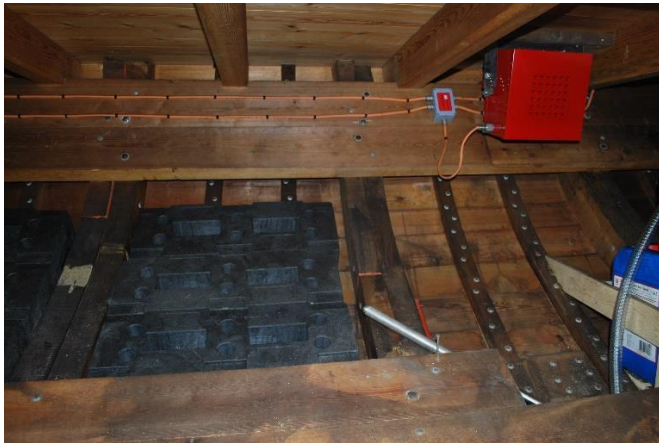
Ballast og spant – BB ved skylight.
