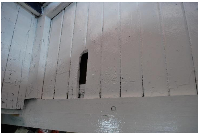
Skylight med tydelig opprinnelig, innvendig panel.
