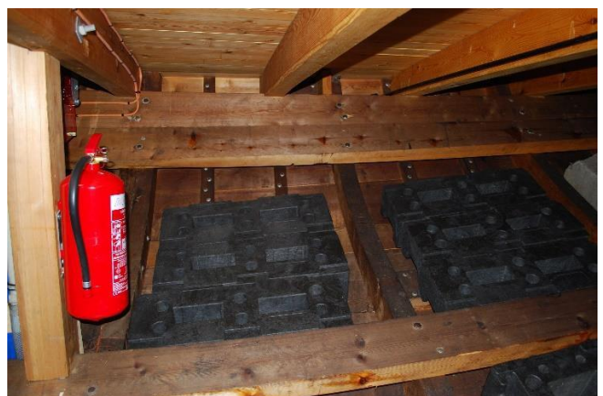
Styrbord side – akter – spant og bjelker dekk.
