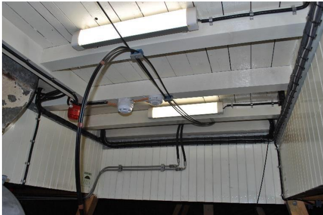
Himling i casing. Kledningen rundt er gjenbrukt så langt som mulig.
