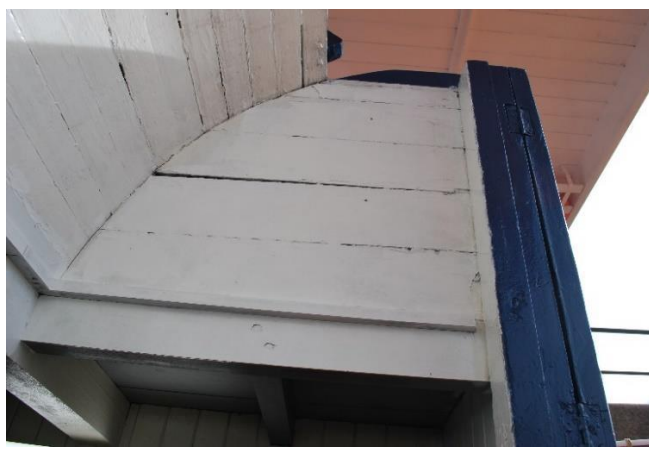
Nedgangskappe SB-side. Opprinnelig kledning.
