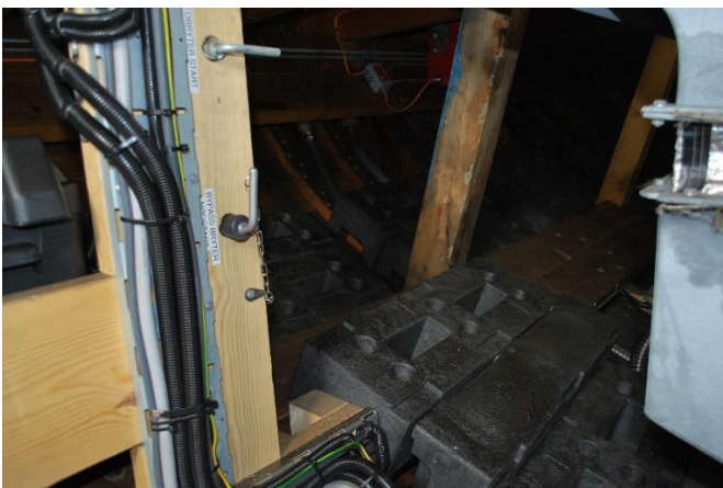
Ballast og spant – BB ved skylight.
