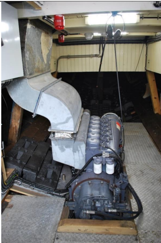
Motor med eksos/kjøleluftkanal.
