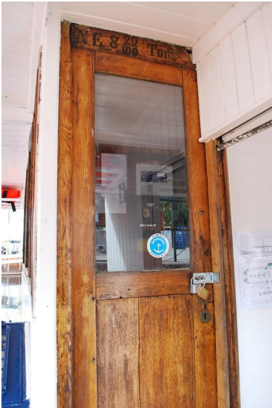
Dør og inngang til styrhus.
