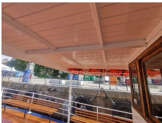
Takoverbygg – innvendig, SB-side forut.
