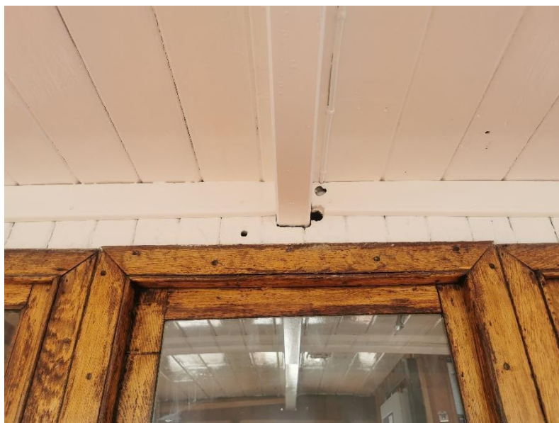
Rammer rundt frontvinduene.
