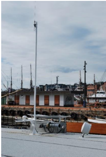
Antennemast, lys og eksos/luftavkjølingsuttak – motor, BB-side.
