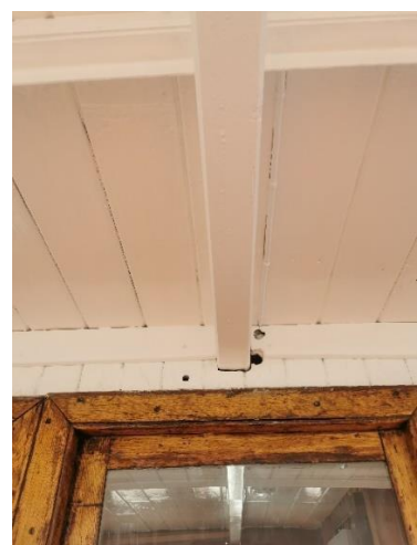
Bærende konstruksjon, takoverbygg.
