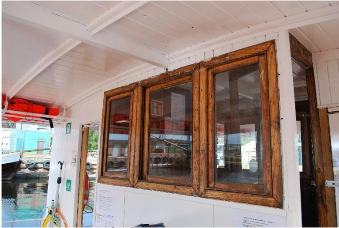
Opprinnelige vinduer i front.
