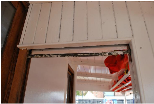
Åpning i skillevegg med skyvedør.
