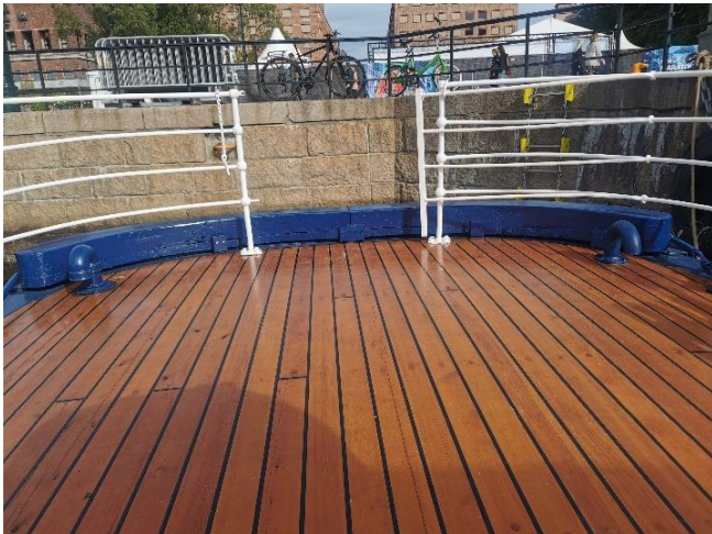
Utgang forut i rekkeledning.
