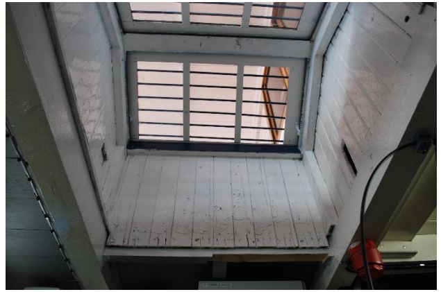
Skylight. Kledningen rundt er opprinnelig.
