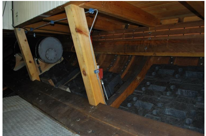
Ballast, spant og støtter til kravell i dekket – BB ved skylight.
