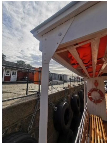
Opprinnelig stender i vinkelstål og kneplate/bjelkene – takoverbygget -fordekket.
