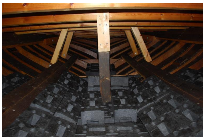
Mot forpiggen – ballast.
