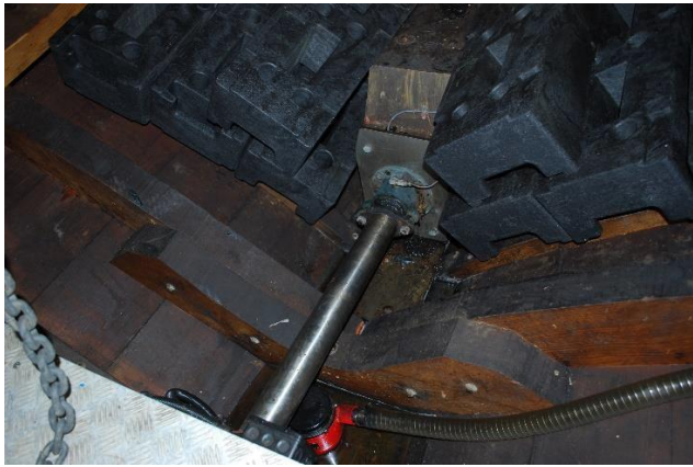
Akselgjennomføring fra motor til propell.
