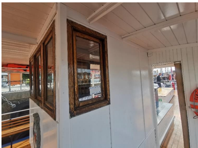
Styrhuset – kledd med asbestfrie huntonit-plater. Platene er kopier av eternittplatene med asbest som var påmontert tidligere. Denne utvendige kledningen kom på i 1970.
