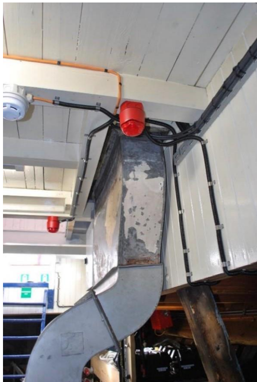
Eksos/kjøleluftkanal. Denne ble endret i 1970. Tidligere hadde «balja» skorstein. Et par år mot 1970 også eksosen nede ved fribord i hekken, BB-side.
