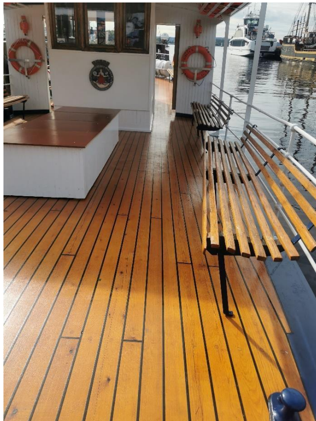
Dekk i forskipet under takoverbygg, BB-side.
