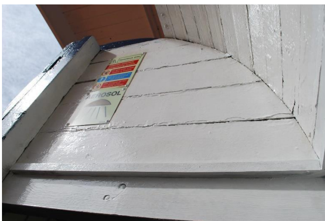
Nedgangskappe BB-side, skylight. Opprinnelig kledning.
