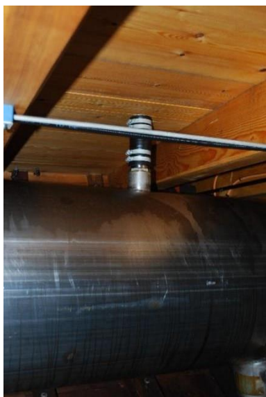
Dieseltank - dieselryr.
