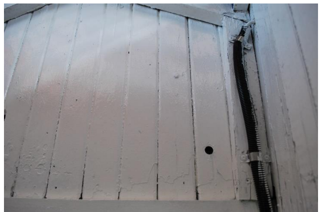
Skylight – opprinnelig, innvendig panel.
