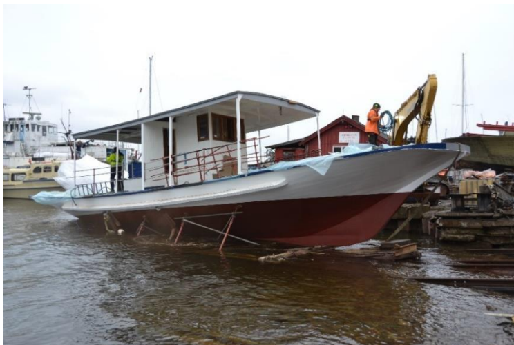
Sjøsetting av M/S «Sjøbad II» etter endt restaurering og istandsetting den 24. april 2023.
