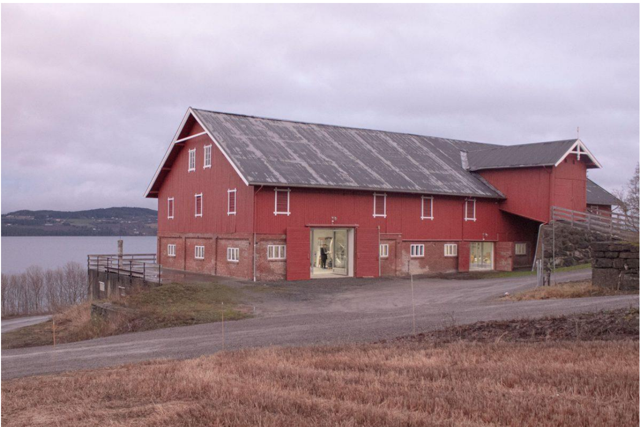
Enhetslåven på Billerud gård har fått ny bruk som atelier og utstillingslokale for Peder Balke-senteret på Toten. Eksemplet, signert Kastler Skjeseth arkitekter, viser hvordan enkle og kostnadseffektive tiltak kan tilrettelegge for ny bruk. Foto: Erlend Skjeseth.
