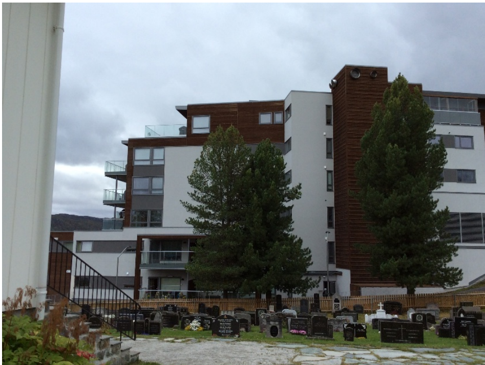
Eksempel på bebyggelse rett ved gravplass. Kirkeveggen til venstre. Foto: Dnk/TFT
