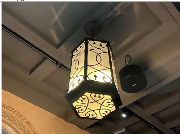
Originale kobberlykter, teknisk lagt utenpå himling
