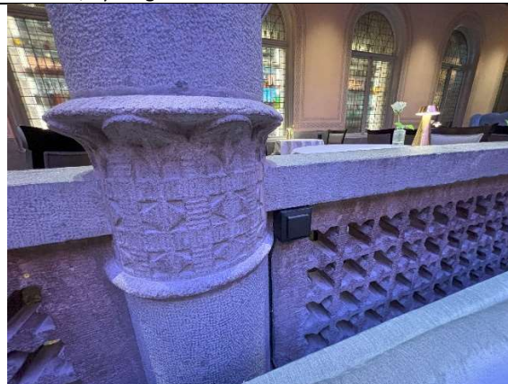
Detalj søylebase med dekor og rekkverk
