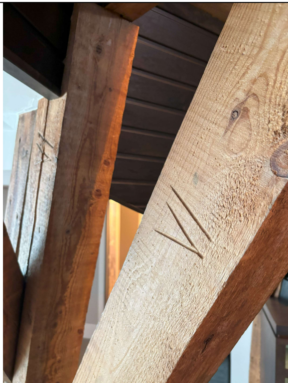
Detalj, konstruksjons-/flyttemerker på bjelker
