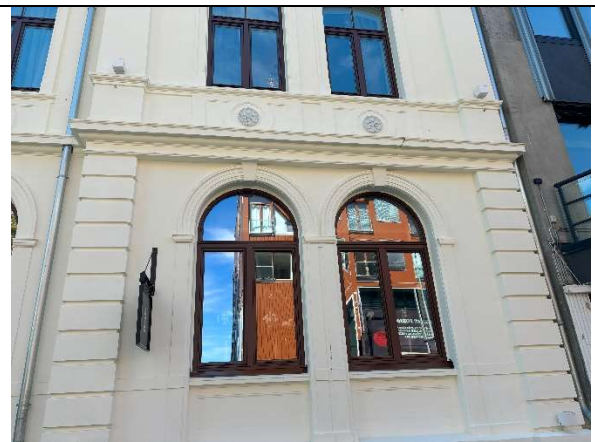
Detalj fasade, vindu og utsmykning, mot vest
