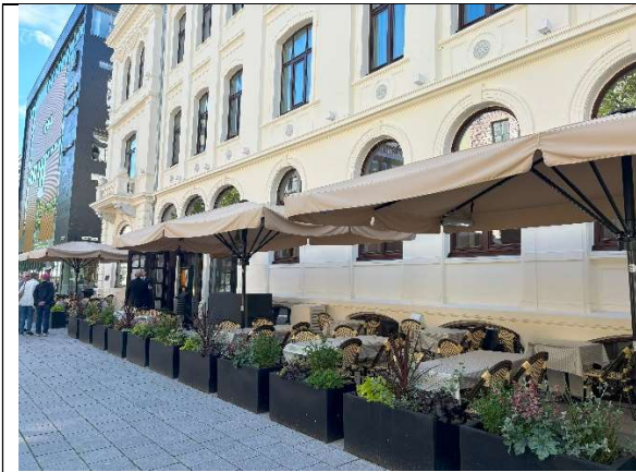
Fasade bakkenivå, uteservering østlig del av fasade
