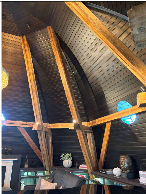
Detalj takkonstruksjon i kuppel
