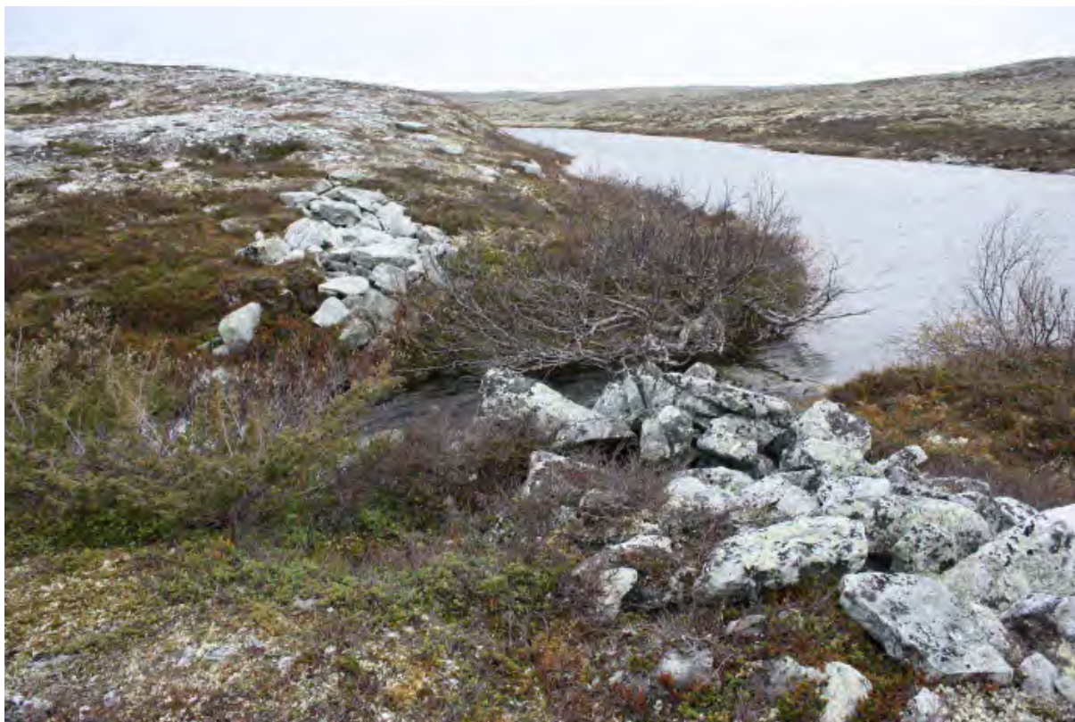
Figur 29. Damanlegget ved Tvillingtjønnan.
