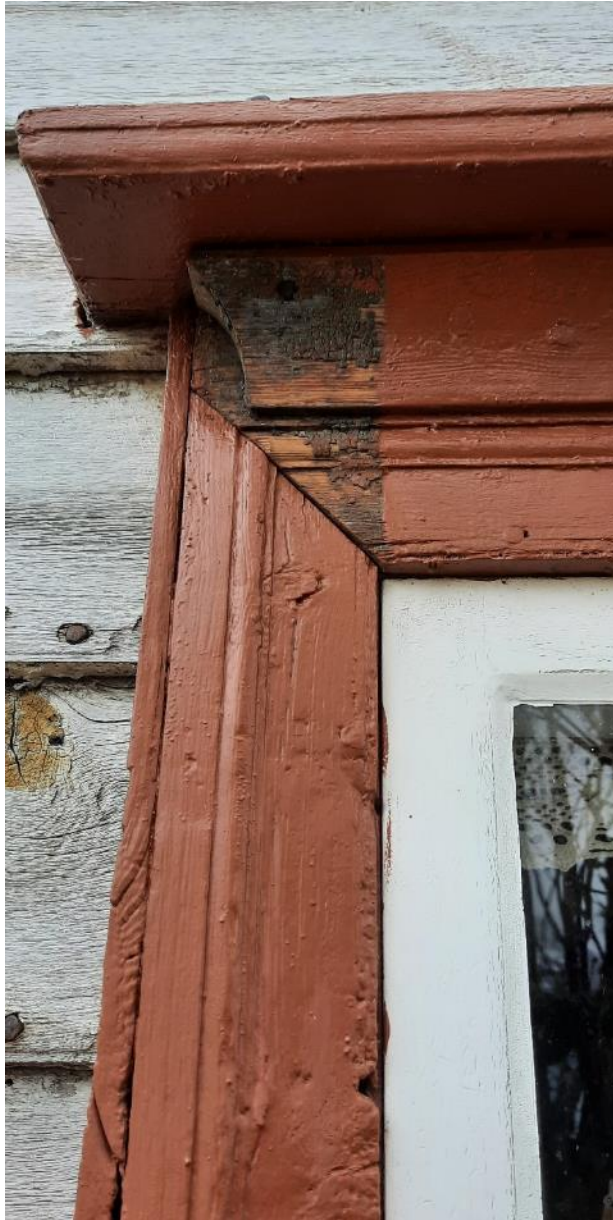
Detalj vindu. Det er laget en malingstrapp som viser tidligere situasjon
