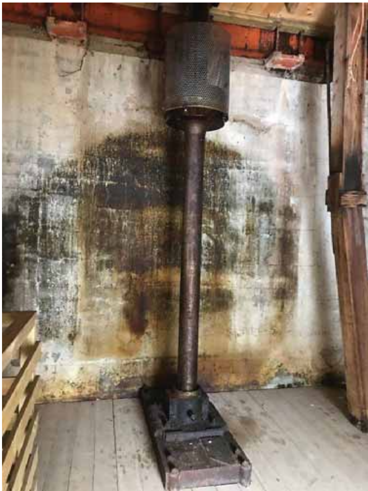
Nivå 2 under akslingsrommet.
