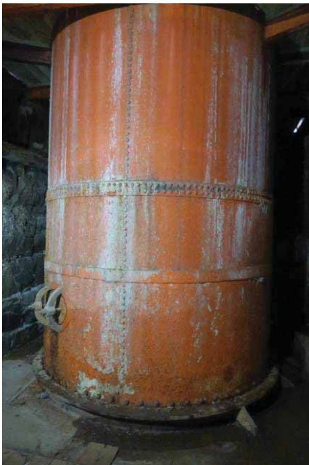
Selve turbinen på nivå 4.
