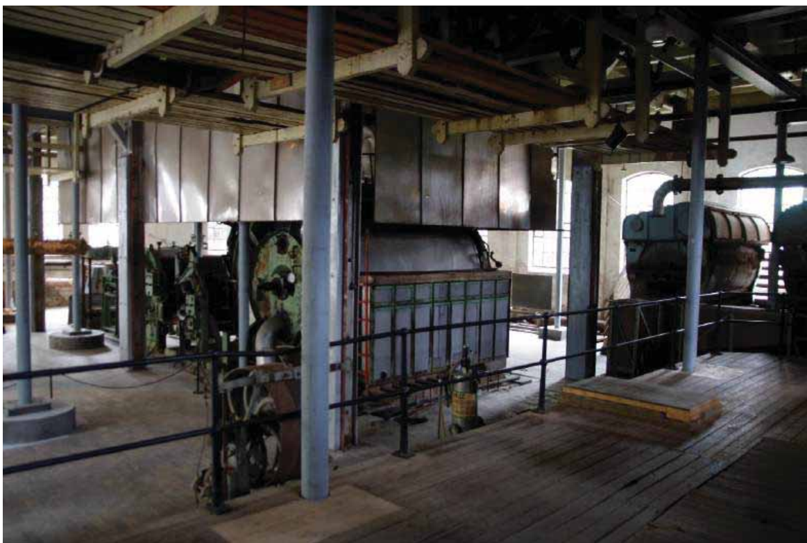
En kalle-regulator ble hentet inn til Kistefos i 1950-årene. Denne kontrollerte konsistensen på tremassen før den gikk til oppfangingsmaskinen. Kalle-regulatoren som er på Kistefos i dag sto opprinnelig på Follum. Den ble montert i 2012 på opprinnelig plassering foran oppfangingsmaskinens siber (den er ikke på plass på befaringsdagen). Den inngår ikke i fredningen fordi den er en innsamlet museumsgjenstand.
