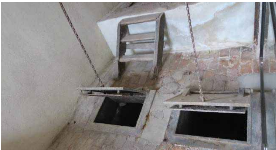
Detalj av luker ved vegg mot nord.
