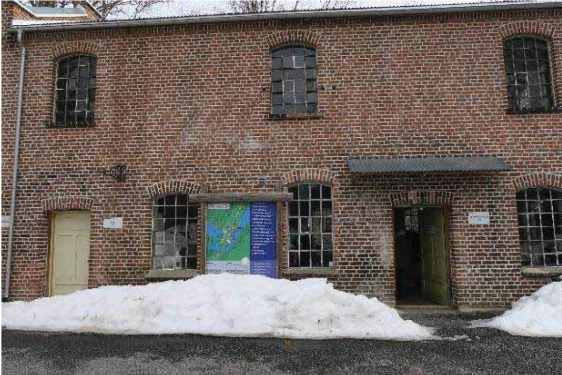
Dør til venstre er inngangen til smia, nordre rom og døra til høyre fører til det mekaniske verkstedet, søndre rom.
