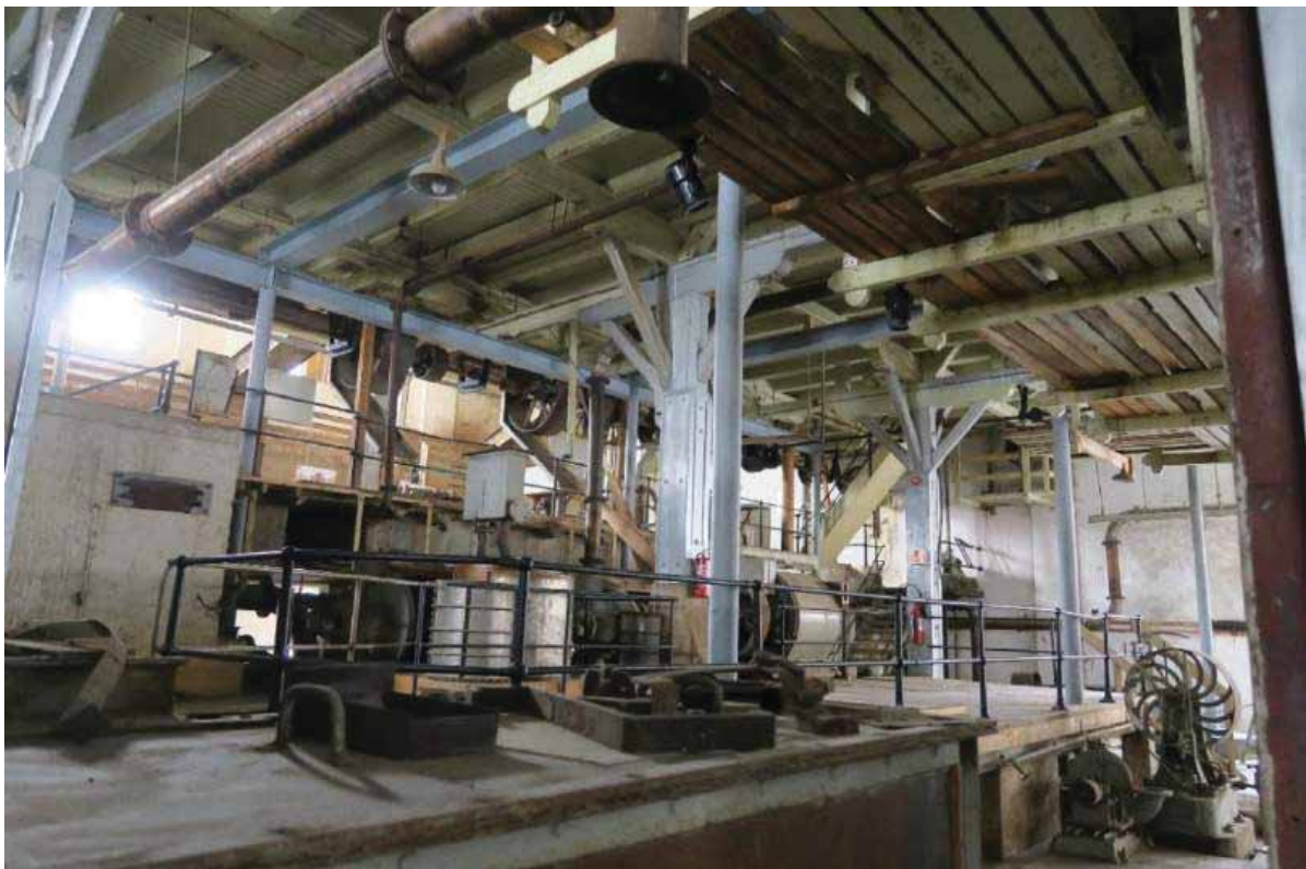
Tre av tidligere åtte sentrifugalsortere står plassert på podiet. Dette var deres opprinnelige plass. Podiet ble restaurert for noen år siden etter modell av det opprinnelige podiet. Sett mot sliperiet.
