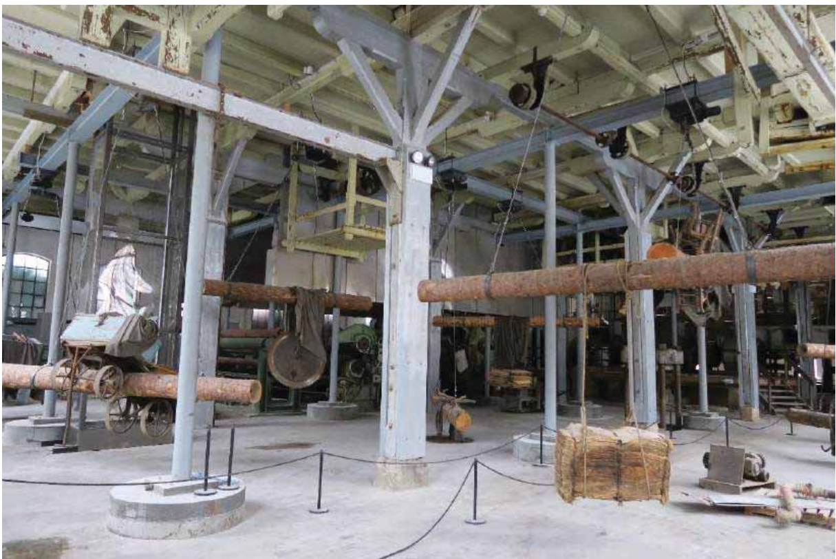
Hallen sett fra nordøstre hjørne mot sørvest.
