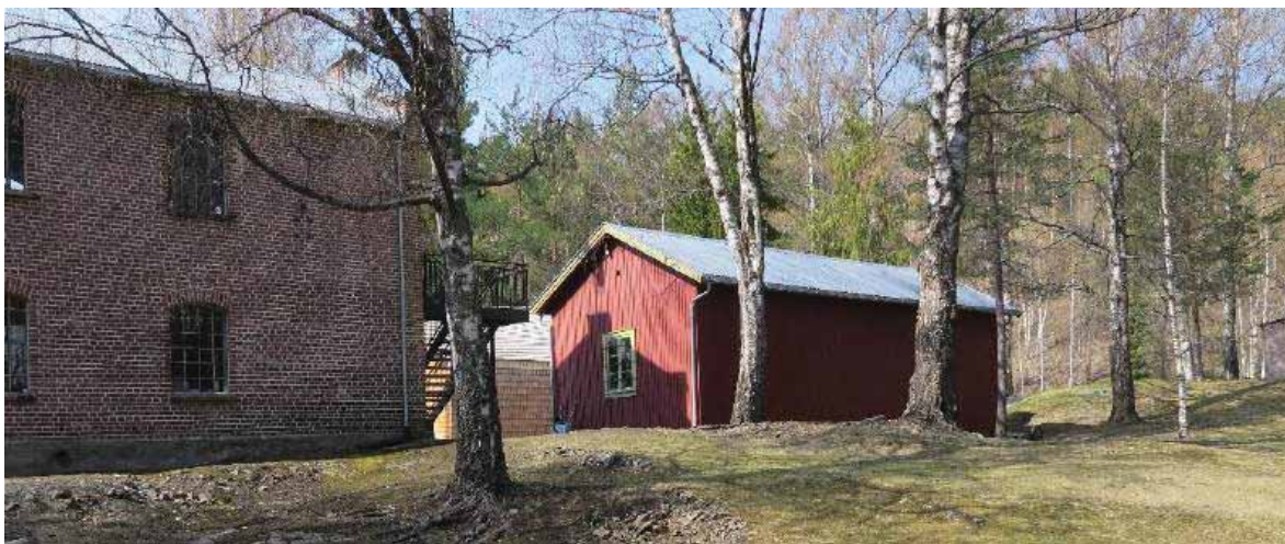
Magasinets søndre gavlvegg og vegg mot øst.
