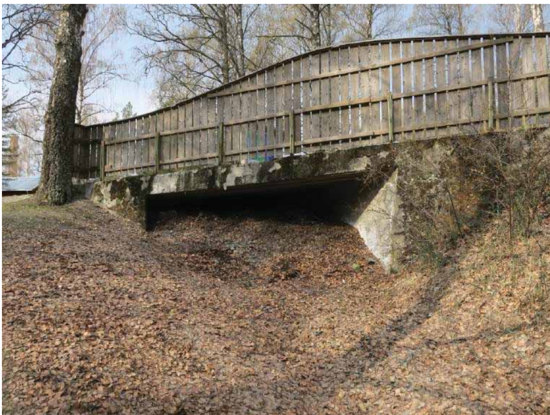
Kulverten sett fra Båthuset.
