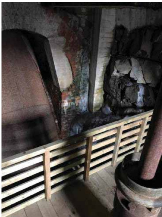
Nivå 3. Tv. aksling ses til høyre i bildet. Til venstre i bildet vises turbinrøret som munner i turbinen. Th. turbinrøret.
