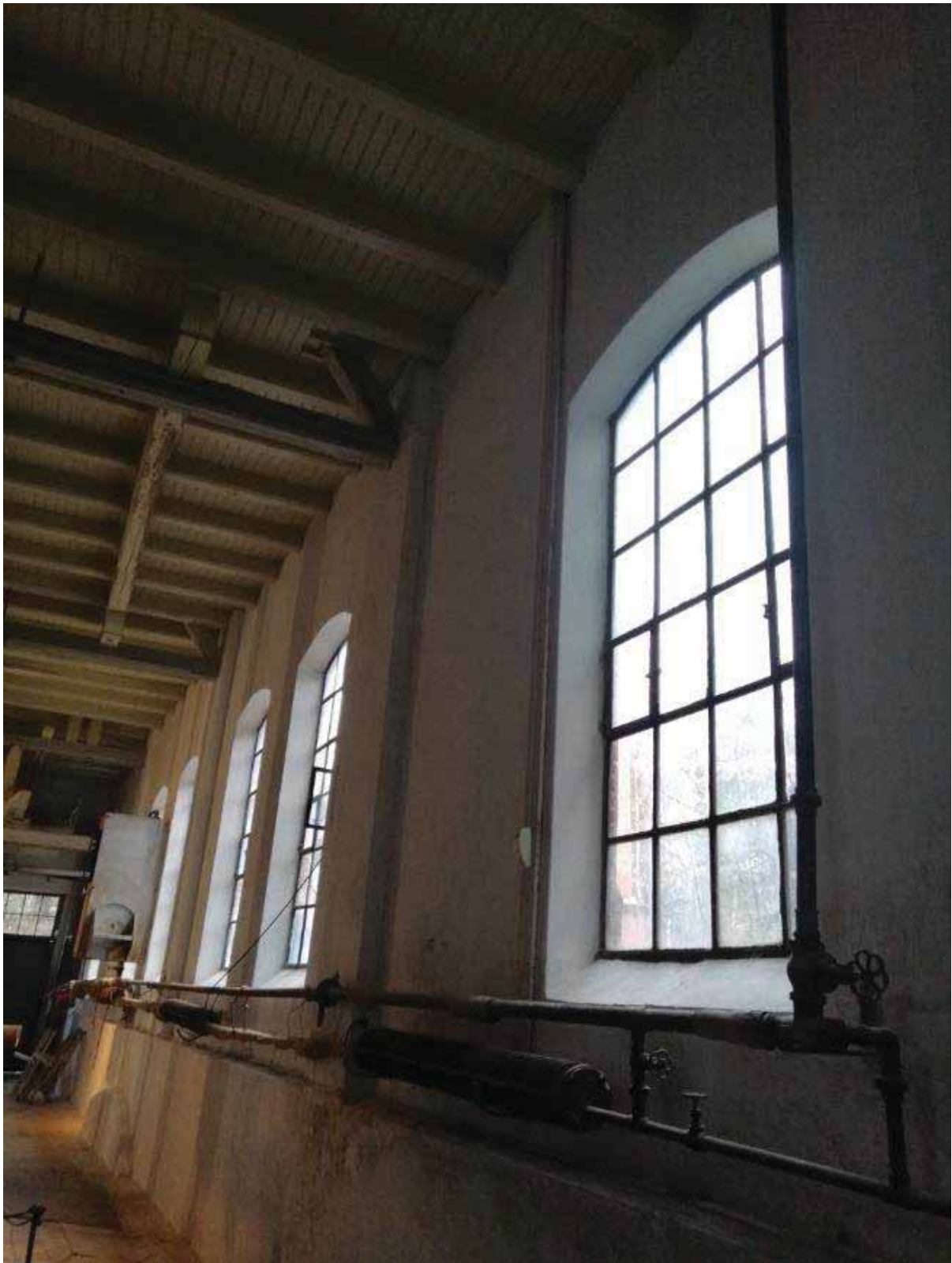
Rør for sentralvarmesystemet i Produksjonshallen langs gavlveggen mot øst ved inntakskanalen til turbinene. Sett mot porten og nordøstre hjørne.
