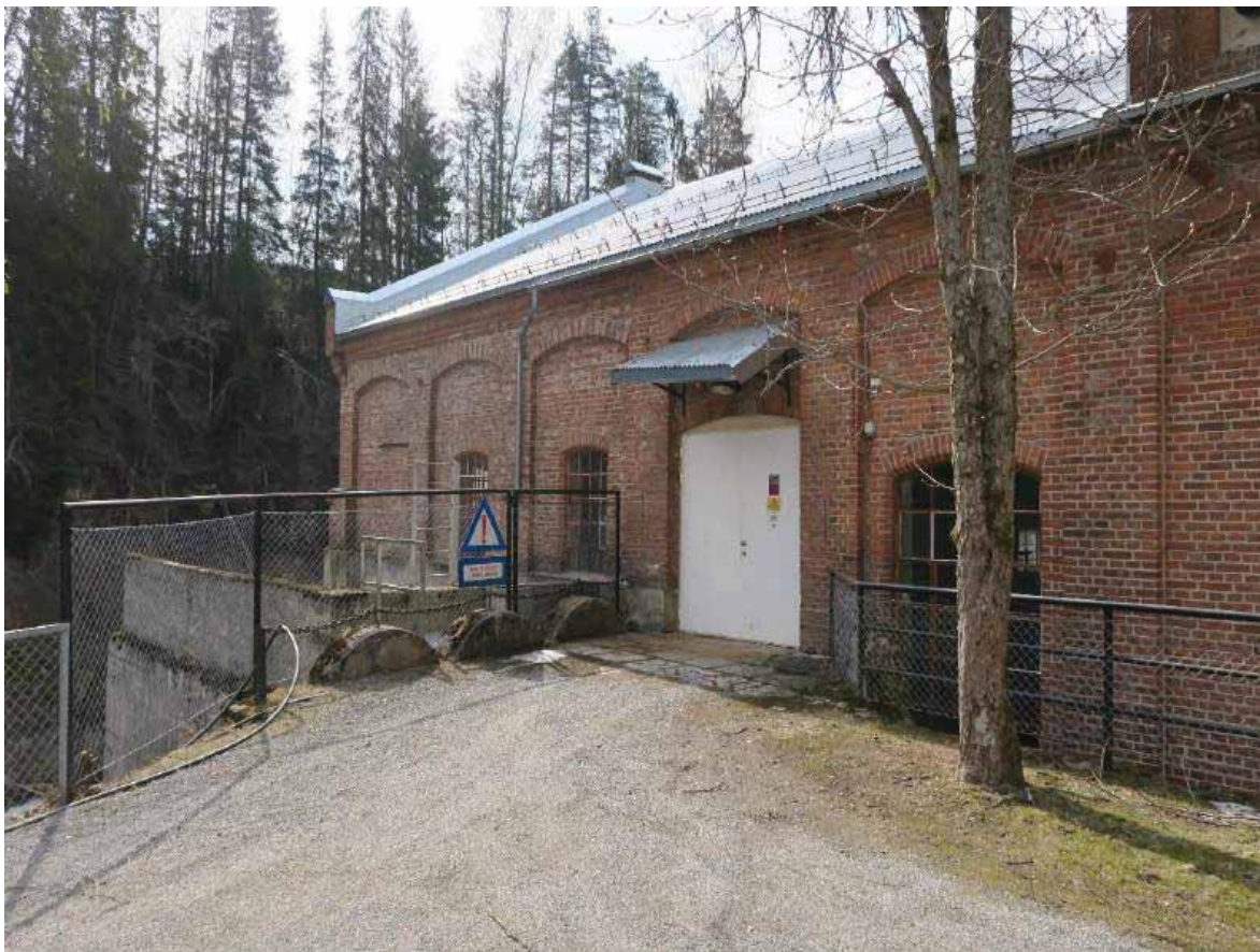
Nordøstre vegg. Inngang til kraftstasjonen.
