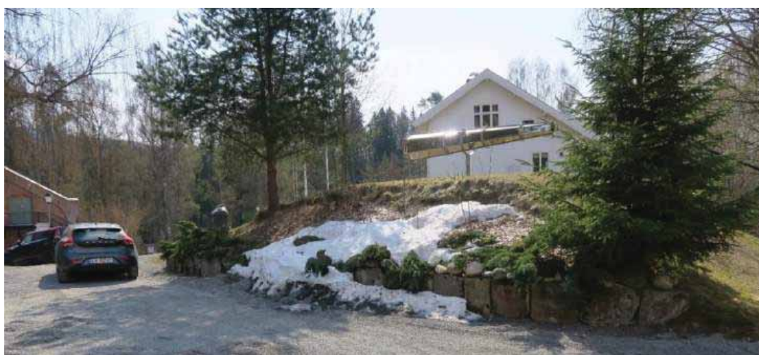
Formannsboligens nordre vegg. Foto: Cathrine Arnesen, Riksantikvaren 2019.
