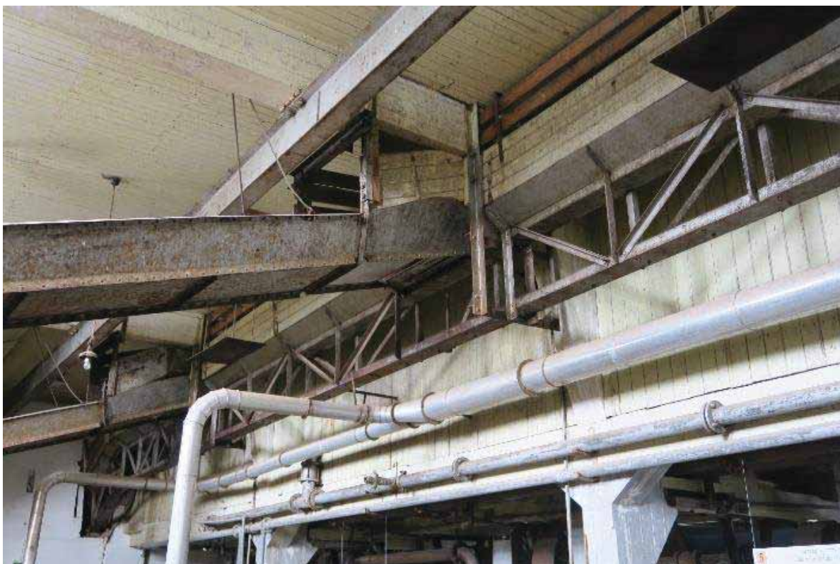
Detalj av kubbtransportøren og to renner som førte kubber til siloen.
