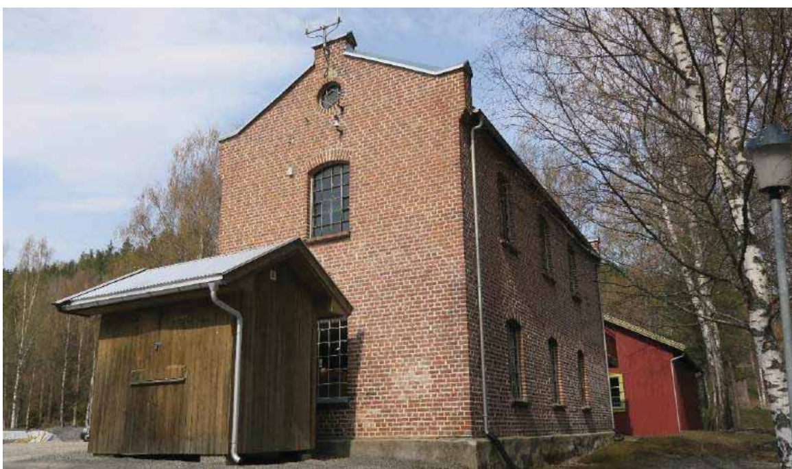
Bygningens søndre gavlvegg.
