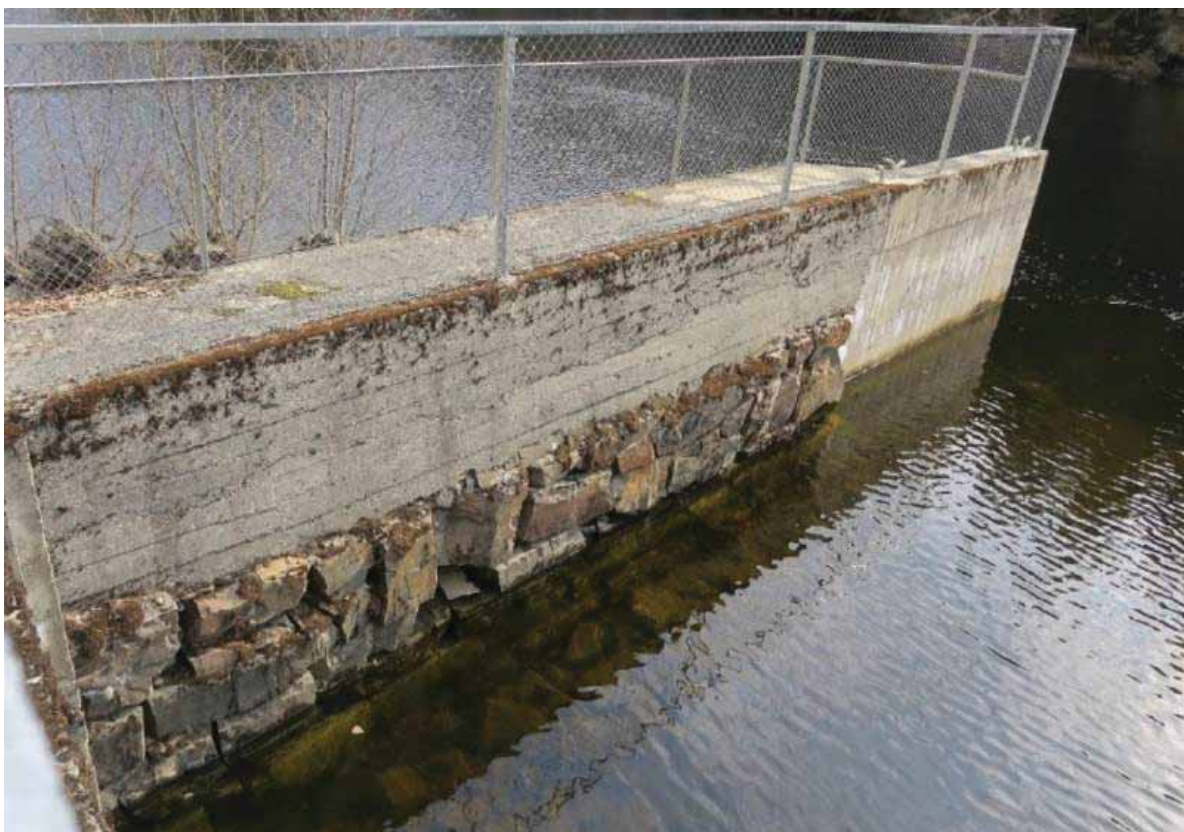
Fløtingsanlegget sett fra anlegget og mot sørvest.
