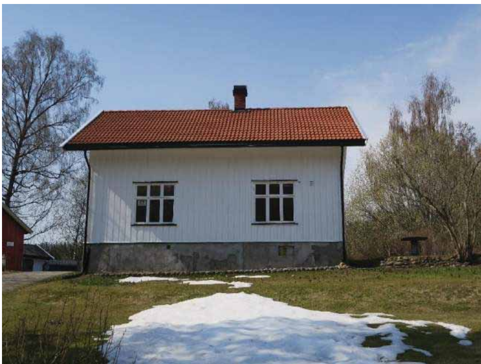
Reparatørboligens østre vegg.
