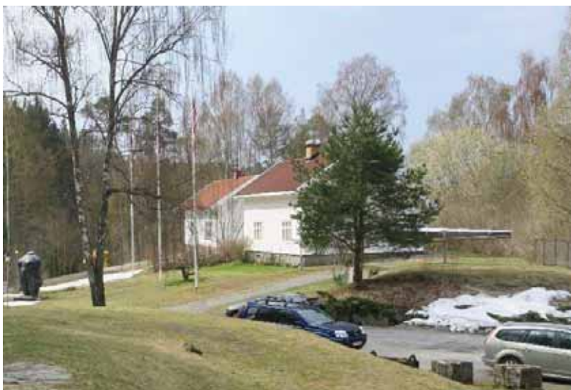
Formannsboligen og Reparatørboligen hage
