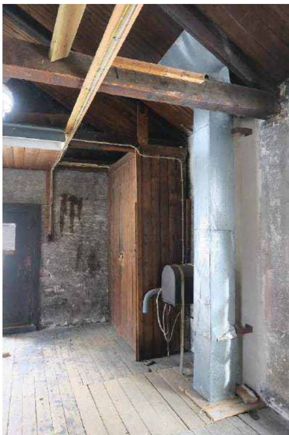
Tv. plassbygd skap langs østre vegg. Ved siden av skapet er det en luftekanal og muligens en apparatur/boks som gir luft inn. Th. detalj av luftekanalen og apparaturen/boksen ved siden av som muligens førte luft inn. Disse elementene antas å være knyttet opp mot smia og essa som befant seg rett under.
