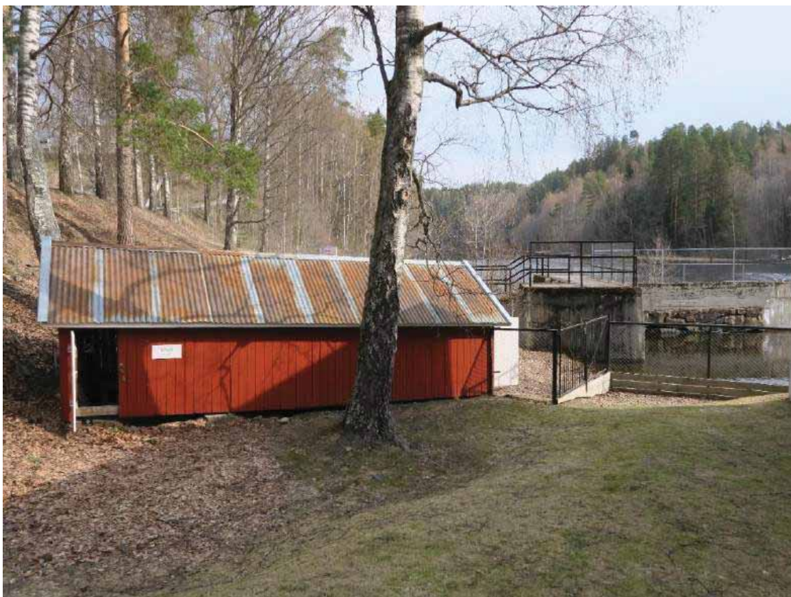
Båthusets sørlige vegg med dør.
