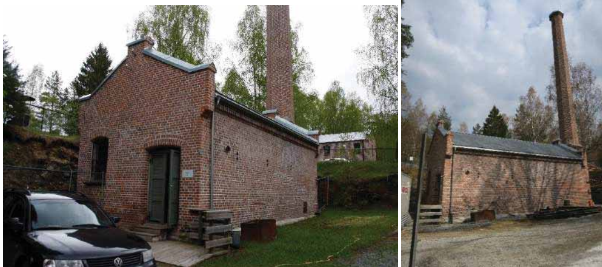
Tv. Fyrhusets vestre gavlvegg og sørveggen. Foto: Ulf Gustafsson, Riksantikvaren 2015. Th. langvegg mot sør og pipe ved østre gavlvegg.
