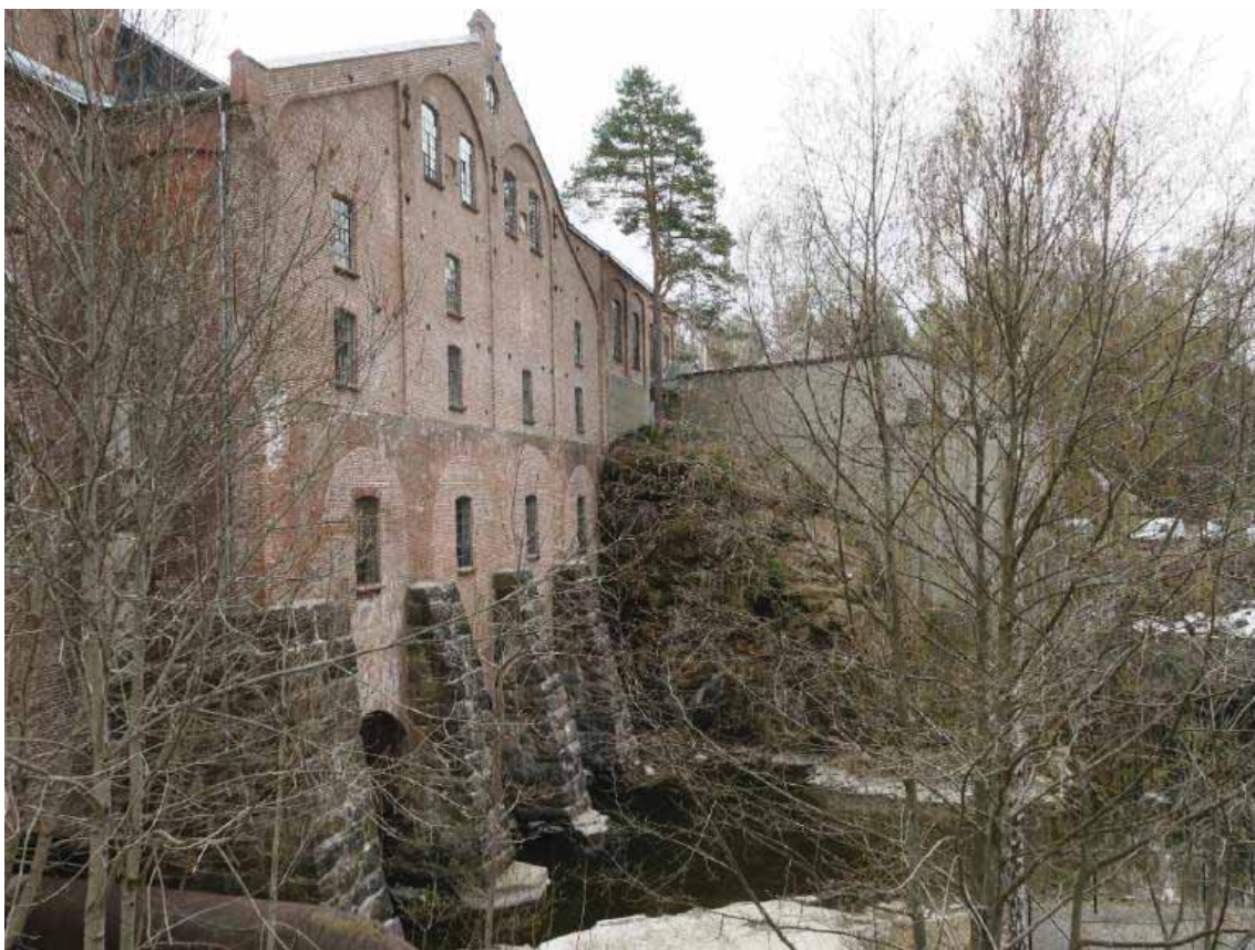
Tresliperiets vestre vegg. I bunnen mot vannet, hvelvede åpninger for spillvannsrør fra turbinene.
