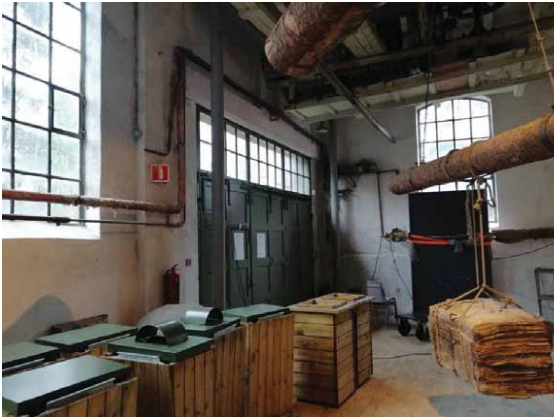
Rør for sentralvarmesystemet i Produksjonshallen langs, sett mot nordøstre hjørne. Sett mot nordøstre hjørne. Noen meter nordøst herfra ligger Fyrhuset der varmen til anlegget produseres.
