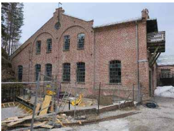
Tv. Tresliperiets østre vegg. Th. her strømmet vann inn i turbinrørene til de fire turbinene knyttet opp mot de fire slipemaskinene inne i Sliperiet og til hovedturbinen. Ved fredningstidspunktet er dette området tørrlagt. Foto: Cathrine C. Arnesen, Riksantikvaren 2019.
