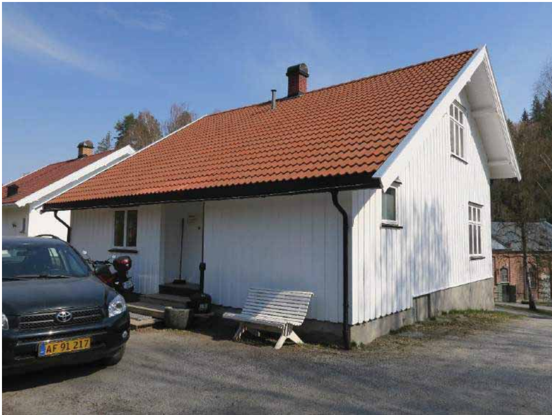
Boligens søndre gavlvegg og vestre vegg.
