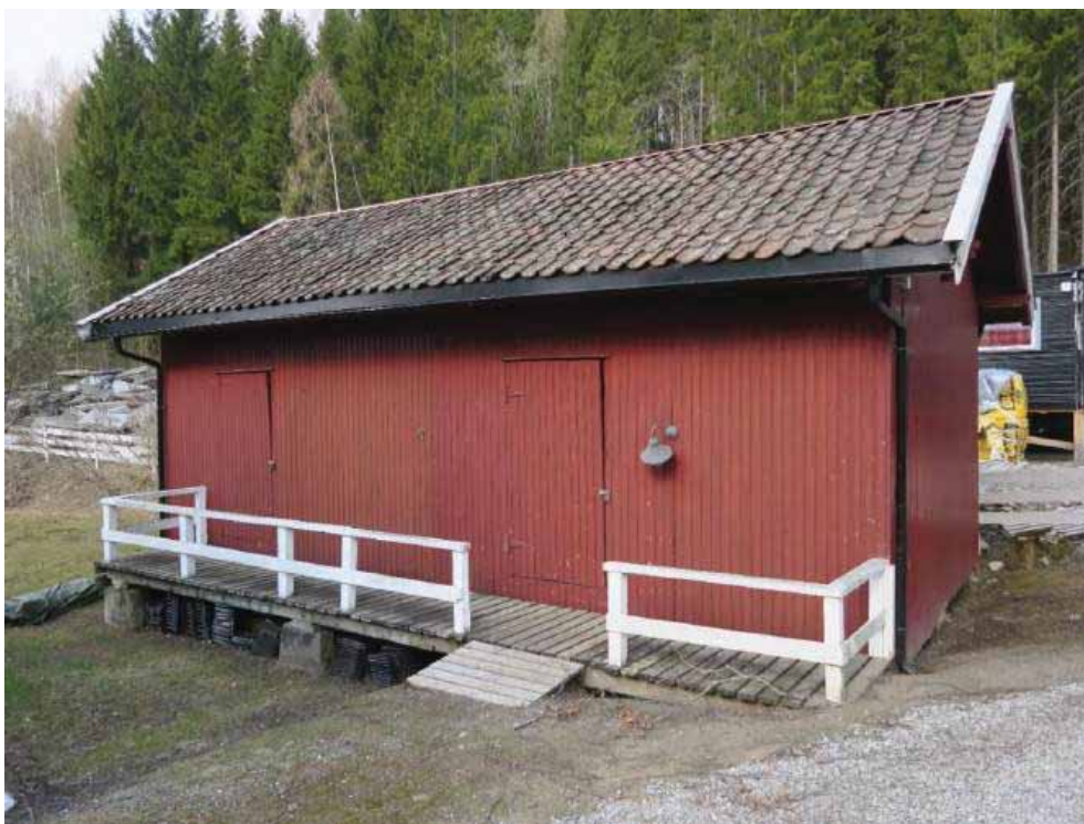
Bestyrerboligens uthus, østre vegg og gavlvegg mot nord.
