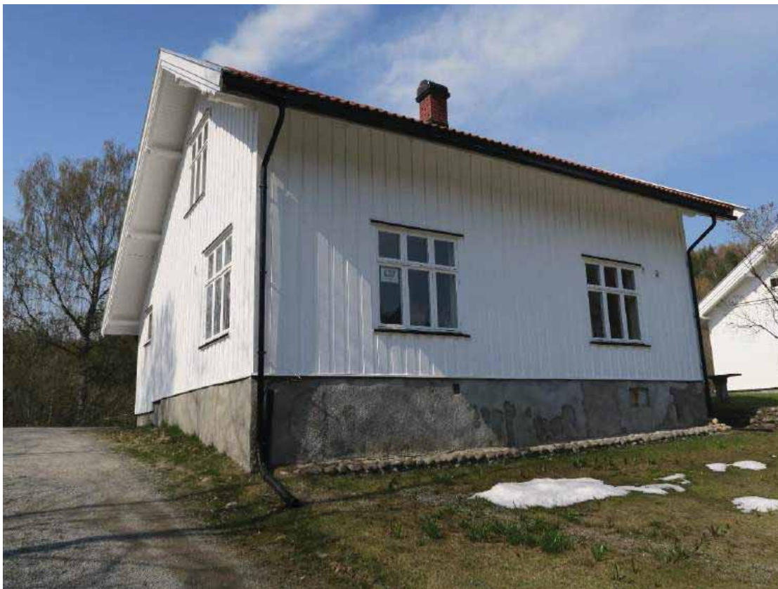
Reparatørboligens østre vegg og søndre gavlvegg.
