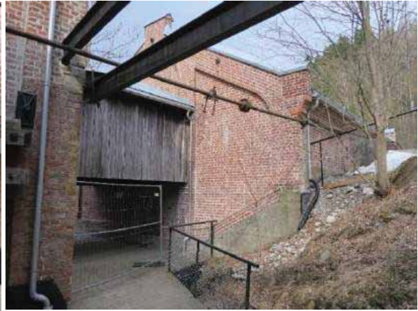
Tv. Kapphusets østlige vegg. Th. østre vegg i passasjen for kubbtransportøren og Renseriets sørlige gavlvegg. I begge bildene ses akslinger og drivhjul.
