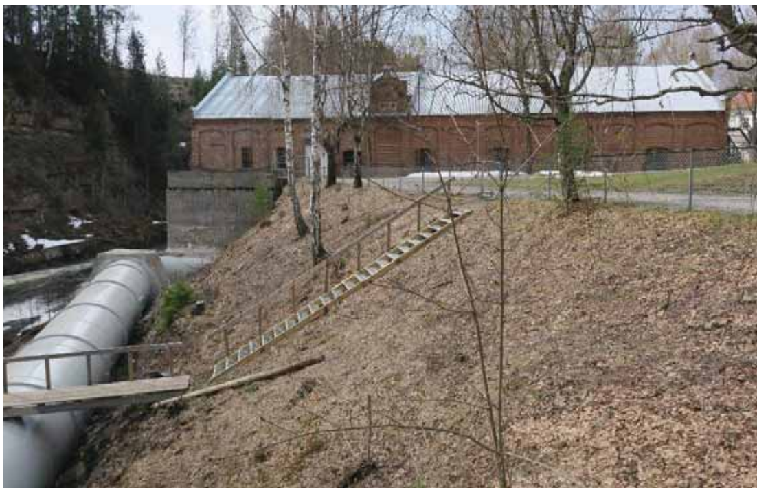
Nordøstre vegg. Turbinrøret inngår ikke i fredningen.
