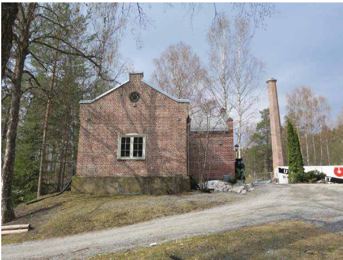
Messas østre gavlvegg. Fyrhusets pipe til høyre.
