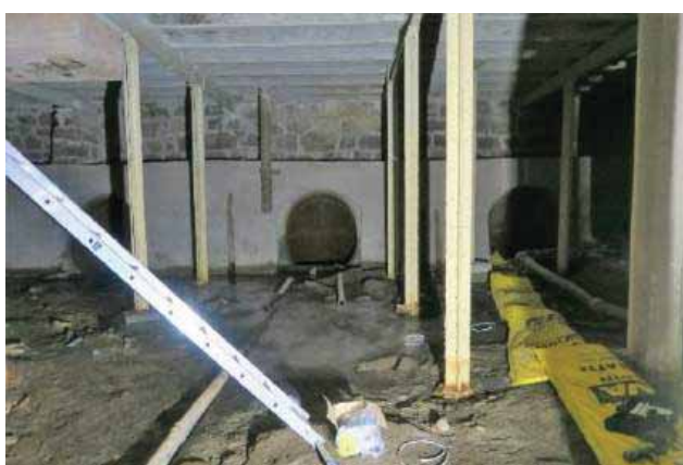
Tv. Tresliperiets østre vegg. Th. her strømmet vann inn i turbinrørene til de fire turbinene knyttet opp mot de fire slipemaskinene inne i Sliperiet og til hovedturbinen. Ved fredningstidspunktet er dette området tørrlagt. Foto: Cathrine C. Arnesen, Riksantikvaren 2019.
