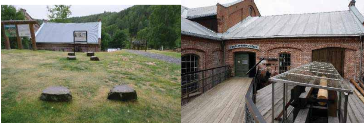
Produksjonslinja startet med tømmerinntaket og kjerraten. Kjerraten fraktet tømmeret fra elva og opp til fabrikk. På bildet tv. vises restene av kjerratens fundamenter. Foto: Cathrine C. Arnesen, Riksantikvaren 2018. Fra kjerraten ble tømmeret fraktet inn til fabrikk på en rullebom, bilde th. Første stopp inne var Kapphuset. Foto: Ulf Gustafsson, Riksantikvaren 2015.
