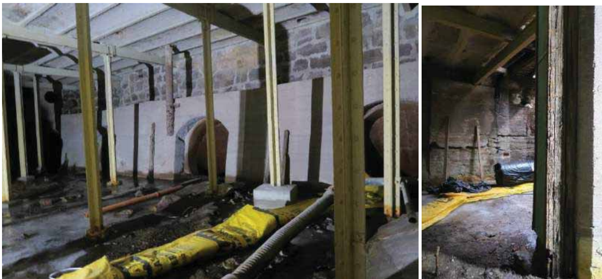
Tv. vanninntak til turbinrør i østre vegg. Th. detalj av en mørken kanal i rommet ved turbinrørinntaket, mulig et avfallsrør. Begge foto: Cathrine C. Arnesen, Riksantikvaren 2019.
