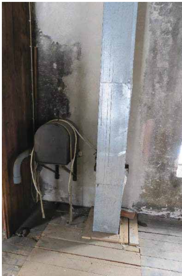
Tv. plassbygd skap langs østre vegg. Ved siden av skapet er det en luftekanal og muligens en apparatur/boks som gir luft inn. Th. detalj av luftekanalen og apparaturen/boksen ved siden av som muligens førte luft inn. Disse elementene antas å være knyttet opp mot smia og essa som befant seg rett under.
