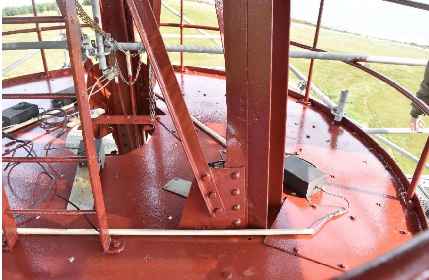
Figur 20: Plattformen på 29 meters høyde etter istandsetting. Byttet tilbake til perforert stålplate, siden det var det opprinnelig. Foto: FFK.
