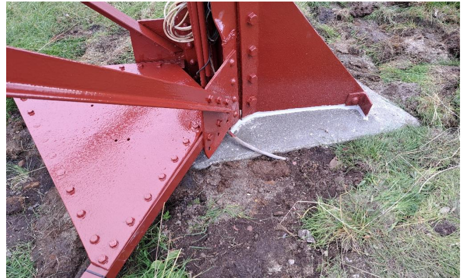
Figur 23: Innfesting til fundament. Foto: FFK.
