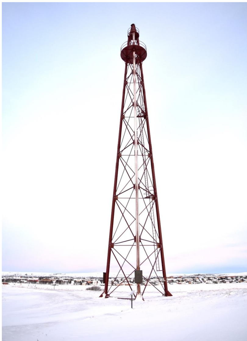
Figur 11: Luftskipsmasta, hjørne sør, med minneplakett fra 1986. Foto: FFK.
