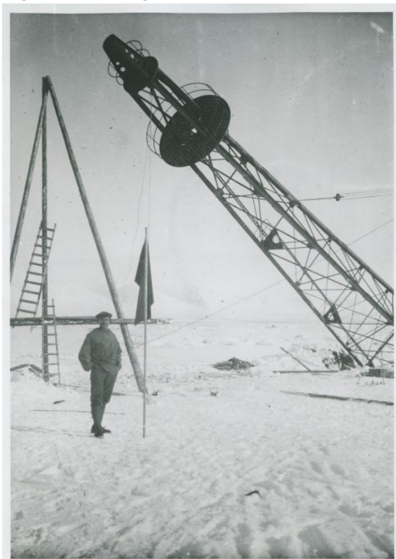
Figur 34: Ny-Ålesund. Tømmermester F. Arild ved reising av luftskipsmasta. Foto: Ukjent fotograf/ Svalbard museum. Gjengitt med tillatelse.
