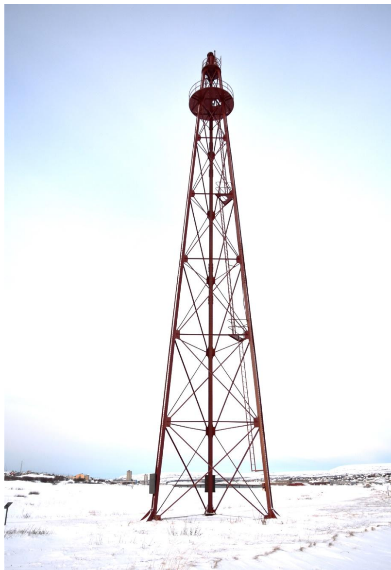
Figur 12: Luftskipsmasta, fasade mot sørøst. Foto: FFK.
