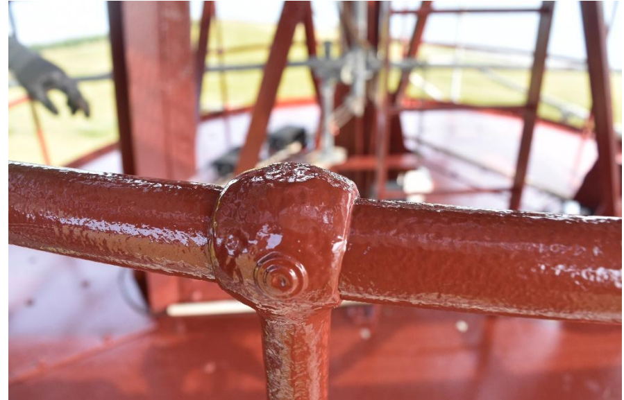
Figur 22: Detalj av rekkverk på den største plattformen. Foto: FFK.
