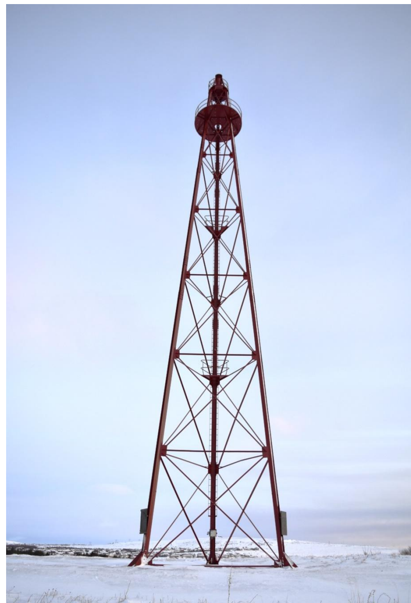
Figur 16: Luftskipsmasta, fasade mot sørvest. Foto: FFK.
