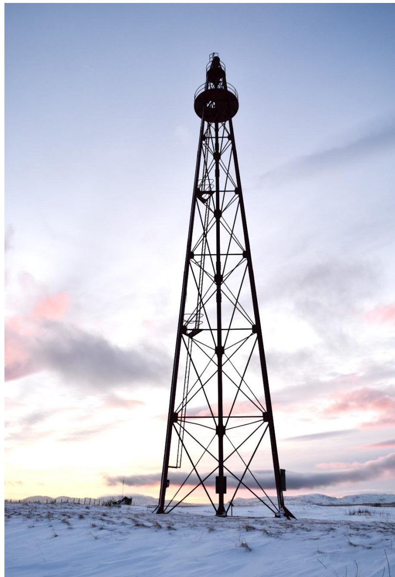
Figur 14: Luftskipsmasta, fasade mot nord. Foto: FFK.
