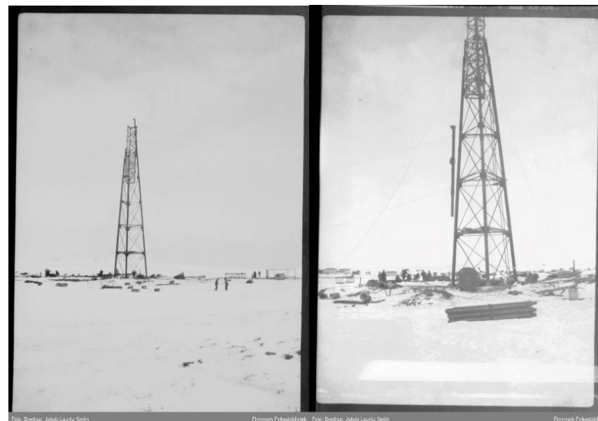
Figur 35: Bygging av masta i 1926. Til høyre ser vi deler av masta som heises på plass. Begge foto: Bredrup, Jakob Lauritz Smith / Finnmark Fylkesbibliotek. https://digitaltmuseum.org/021015580457/arbeidere-ved-luftskipsmasta-pa-vadsoya-enten-er-dette-mens-masta-var-under https://digitaltmuseum.org/021015580458/arbeidere-ved-luftskipsmasta-pa-vadsoya-masta-er-nesten-ferdig-bare-toppen
