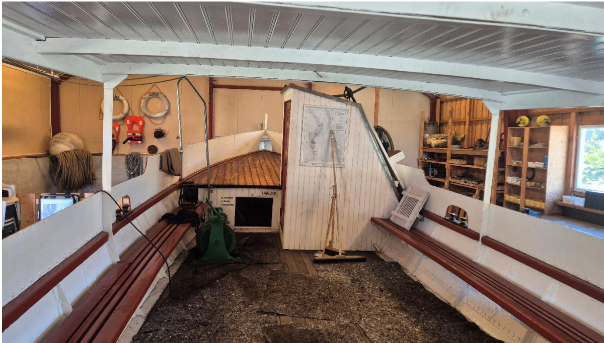
Hovuddekk med toalett på styrbord side forut. Ankervinsj demontert og står på hovuddekket. Denne står normalt montert på bakkdekket men var demontert for vedlikehold av dekket. 6/5-2026. Foto: Kjartan Nordby, Agder fylkeskommune.
