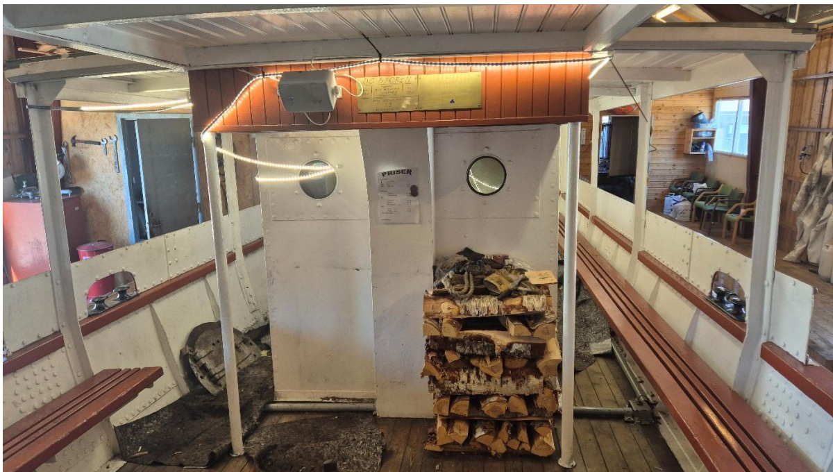
Hovuddekk, ser akterover mot fyrroms casing. 6/5-2026. Foto: Kjartan Nordby, Agder fylkeskommune.
