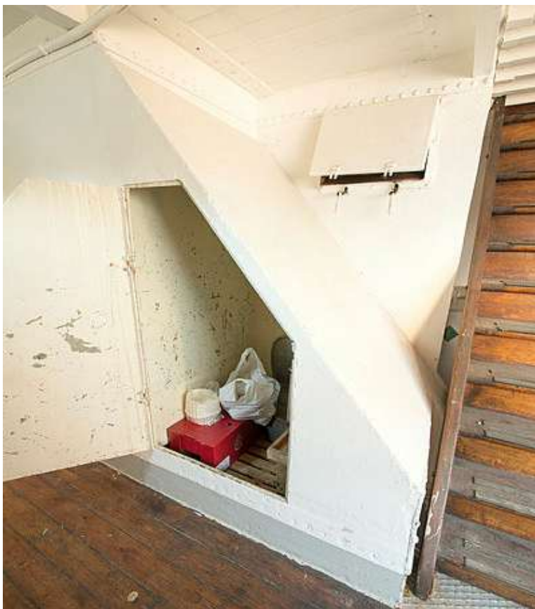
Figur 18 Babord leder etter at den ble plassert tverrskips. Vi kan se skråkanten i stålet hvor lederen var plassert før ombyggingen
