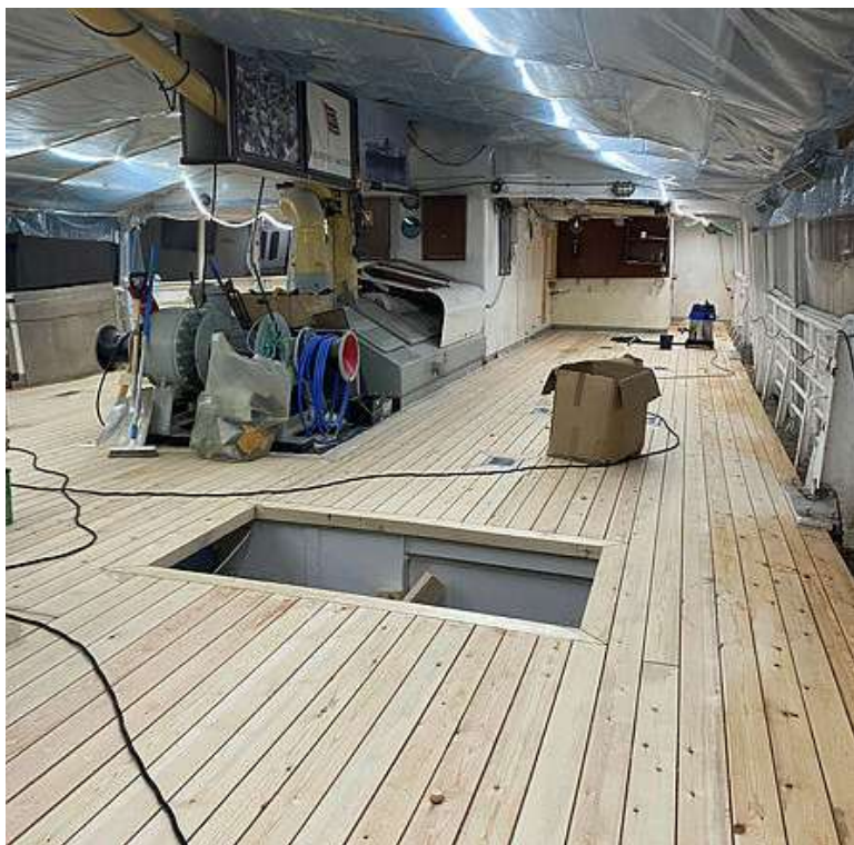
Figur 44 Det ny dekket som ble lagt i 2024, Område 308 Foto: HFS 2024
