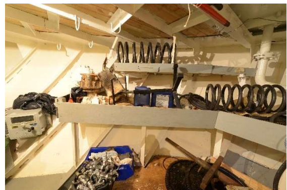
Figur 87 Fra rom for styremaskin
