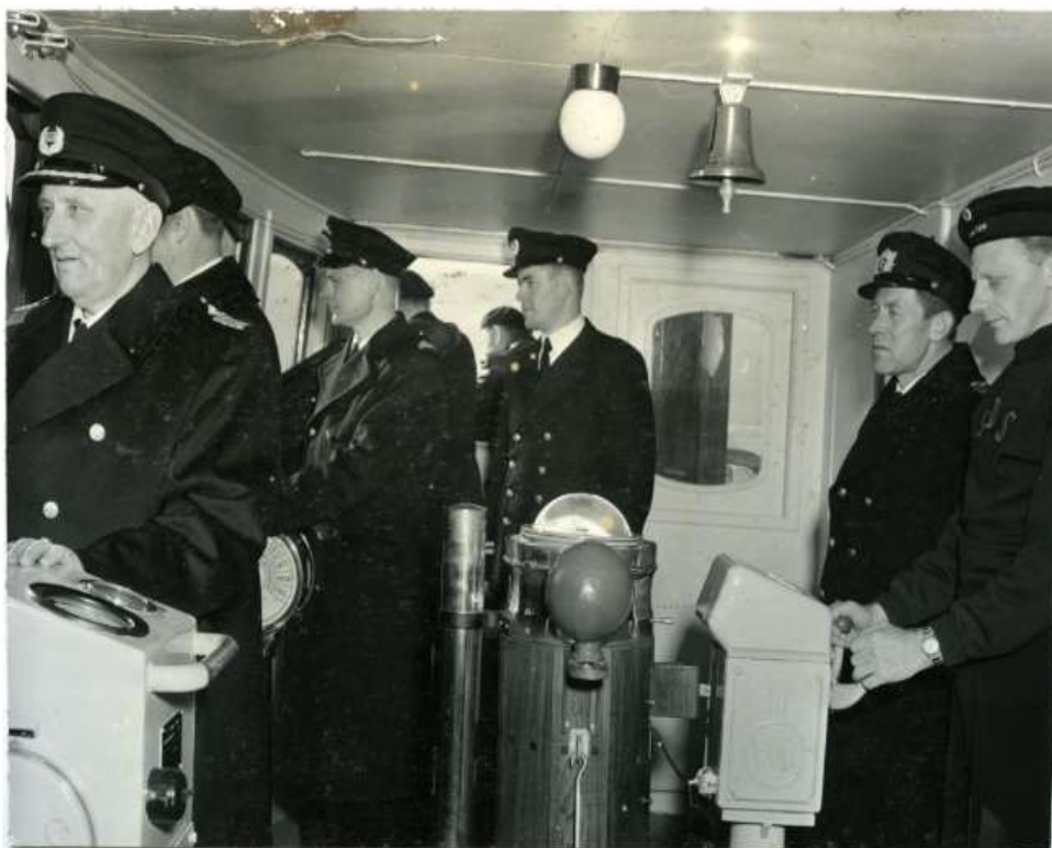
Figur 13 Skipsutstyr på broen på «Salten». Fra venstre til høyre: kamerasøyle, maskintelegraf, kompass, skipsklokke og styresøyle. Foto: Ukjent dato og fotograf. Arkiv i Nordland, Saltens Dampskibsselskab
