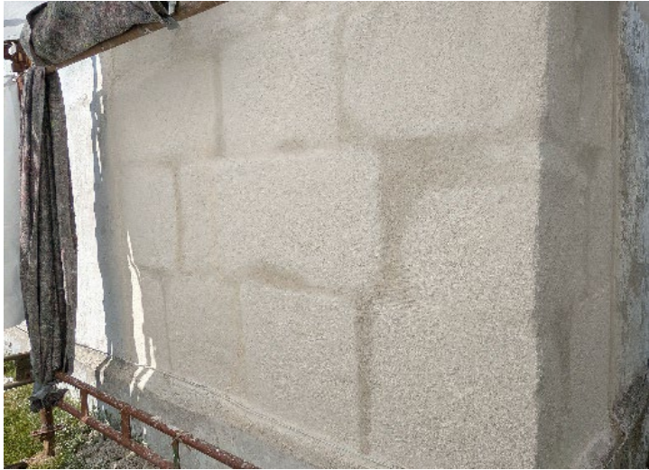
Ferdig slemma overflate. Tromøy kyrkje. Foto: Per Storemyr, Fabrica.
