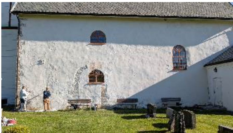
Sørveggen på skipet. Foto: Per Storemyr, Fabrica.
