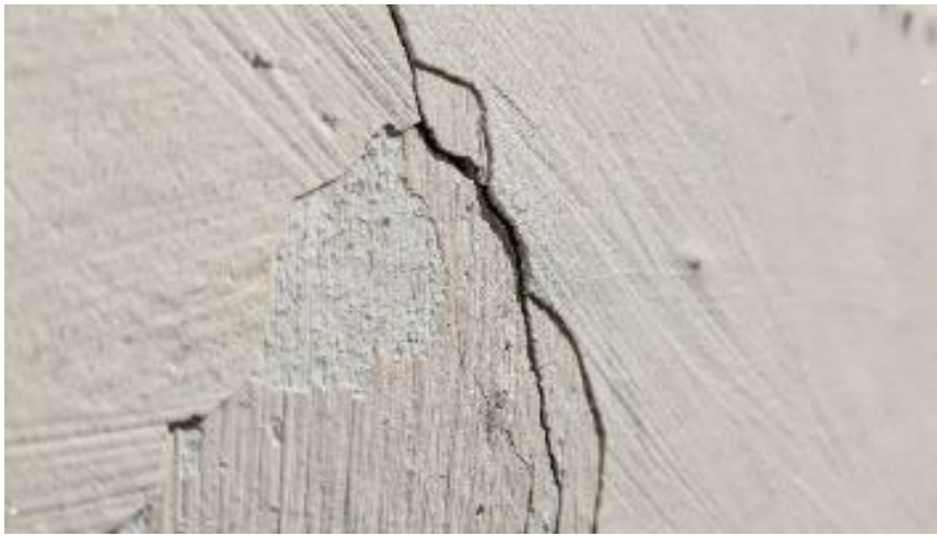
Typisk utsjånad på hard Mineralux som ligg som ei slemming på Tanum kyrkje sine ytterveggar. Foto: Per Storemyr, Fabrica.
