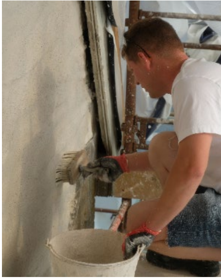
Kvittalking av fersk kalkpuss. Høsbý kyrkje. Foto: Morten Stige, Fabrica.
