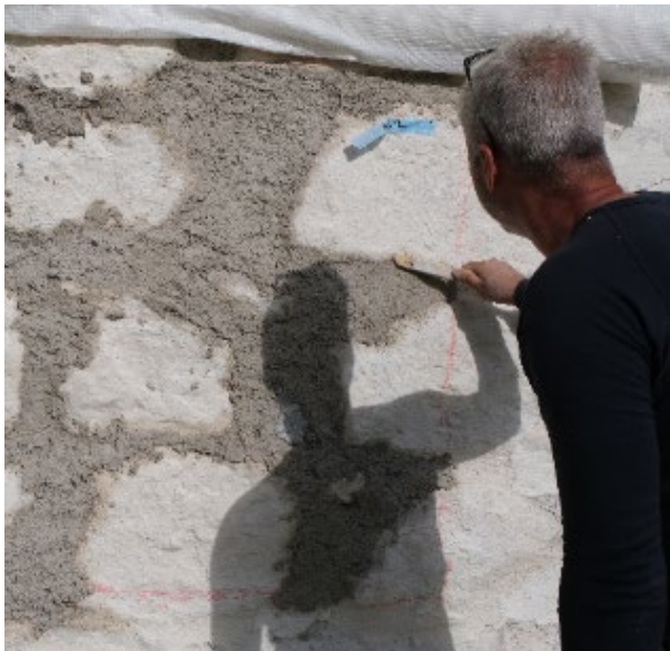
Komprimering av fuger som er bygd opp til nivået for meddregne fuger. Tanum kyrkje, Larvik. Foto: Morten Stige, Fabrica.
