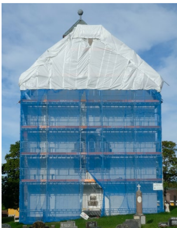
Gavlstillas som er dekt til med tett duk i toppen for å hindre at det renn vatn nedover vegg. Nettet på resten av stillaset stoppar slagregnet, men gir framleis god lufting. Nokre gonger vil ein ha tett duk på heile stillaset for å kunne ha betre kontroll på klimaet. Mariakyrkja, Gran. Foto: Morten Stige, Fabrica.
