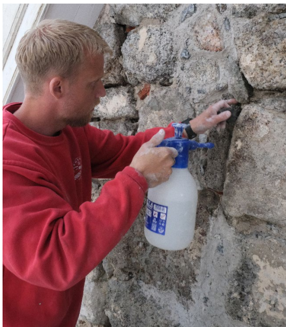
Forvatning og utprøving av pinningsstein. Tanum kyrkje. Foto: Morten Stige, Fabrica.
