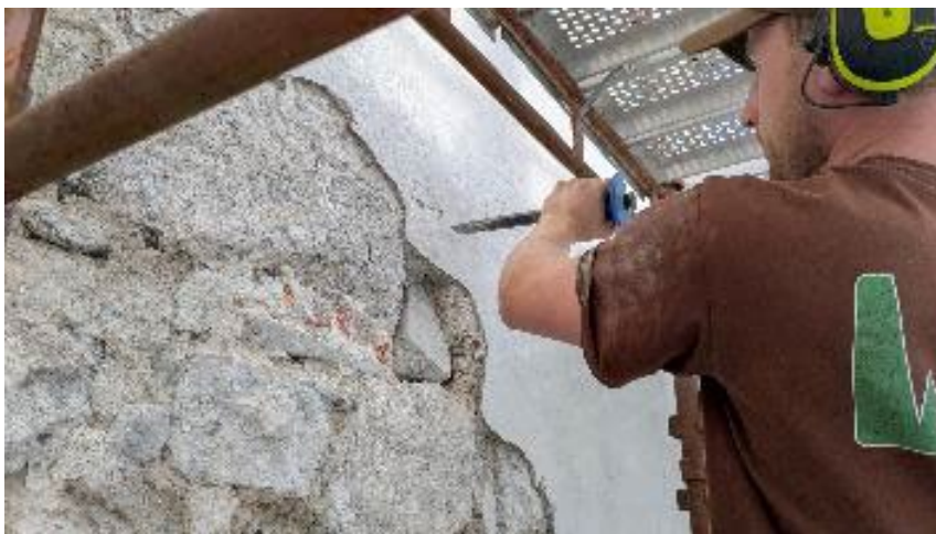
Fjerning av den Mineralux-behandla pussen med bruk av meisel og slagar. Foto: Per Storemyr, Fabrica.
