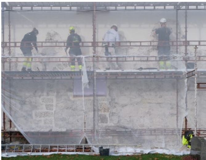
Organisering av arbeidet slik at alle er på same stillasnivå er ein enkel måte å redusere faren for skadar pga. nedfall. Tanum kyrkje, Larvik. Foto: Morten Stige, Fabrica.
