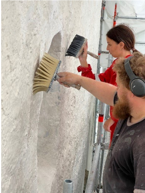
Kalking som vedlikehald av 1700-talls puss på Moster gamle kyrkje. Foto: Terje Berner.
