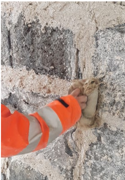
Strieskuring eignar seg også godt, fordi det gir ei ru overflate på fuger eller puss. Hesby kyrkje. Foto: Morten Stige, Fabrica.
