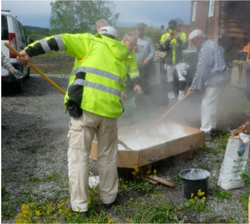
Våtlesking av brentkalk i tradisjonell kalkbenk. Vassdampen kjem av den høge temperaturen som oppstår under leskinga. Foto: Morten Stige, Fabrica.
