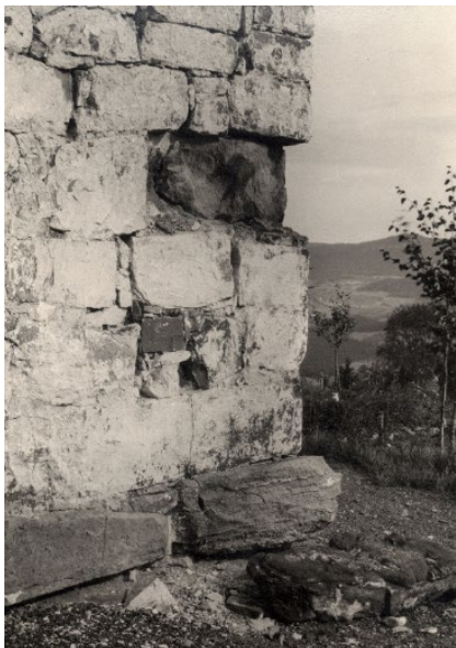
Løveskulpturen på ein av hjørnekvadrane på Lunner kyrkje fall i bakken i 1926 då steinen sprakk på grunn av belastning eller naturleg kløyv i steinen. Foto: Erdmann, Riksantikvaren.
