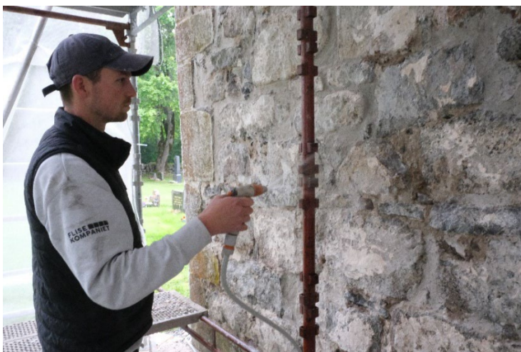
Muren må vatnast godt før pussarbeid, t.d. med ein vasslange med dusj. Vent med påkast til steinoverflatene ikkje lenger er blanke av vatn. Tanum kyrkje, Larvik. Foto: Morten Stige, Fabrica.
