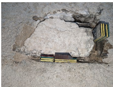
Liming av stein. Første foto viser muren etter at ein tommetjukk skalk hadde losna. I andre fotoet er steinen limt på plass att og blir halde fast av elastiske kilar. Talgje kyrkje. Foto: Morten Stige, Fabrica.
