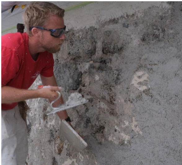
Kollegaen på Tanum kyrkje kastar på ein noko våtare mørtel. For å jamne overflata utan å glatte den dreg han pussen av med skeia. Foto: Morten Stige, Fabrica.
