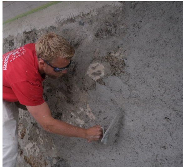
Kollegaen på Tanum kyrkje kastar på ein noko våtare mørtel. For å jamne overflata utan å glatte den dreg han pussen av med skeia. Foto: Morten Stige, Fabrica.
