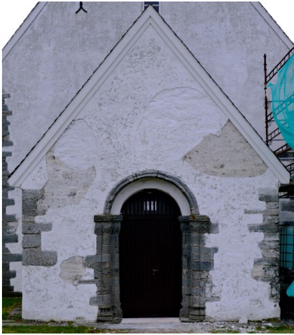
Den sementhaldige pussen sprekk av i store flak, medan eldre kalkpuss ligg under. Talgje kyrkje. Foto: Morten Stige, Fabrica.
