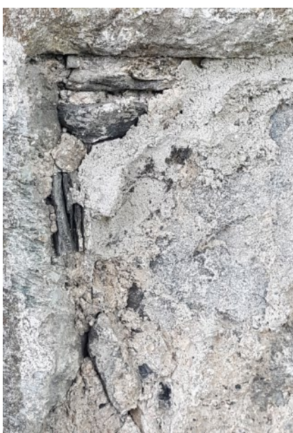
Bevart murverk med fingerfast mørtel og pinning treng berre eit påkast på fugen for å lage eit jamt murverk. Hesby kyrkje. Foto: Morten Stige, Fabrica.
