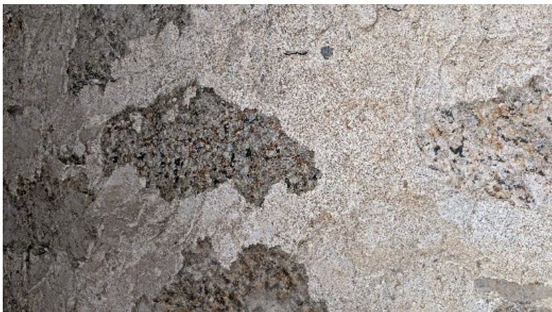
Typiske meddregne fuger på innandørs gavlvegg. Mellomalder, Tanum kyrkje, Larvik. Foto: Per Storemyr, Fabrica.
