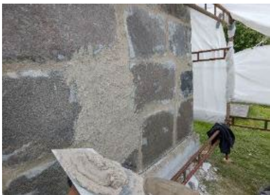
Påkast av bindemiddelrik (1:1,5) hotmix som er slått kraftig opp på murarbrettet for å unngå høgt vassinnhald i den svært tynne pussen (2-4 mm). Tromøy kyrkje har eit murverk med ombrukte kvaderstein. Foto: Per Storemyr, Fabrica.
