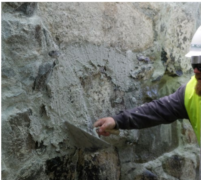
Grunne fuger blir bygd opp med påkast til nivået til murlivet. Stavanger domkyrkje. Foto: Morten Stige, Fabrica.
