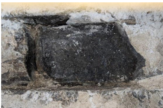
Liming av stein. Første foto viser muren etter at ein tommetjukk skalk hadde losna. I andre fotoet er steinen limt på plass att og blir halde fast av elastiske kilar. Talgje kyrkje. Foto: Morten Stige, Fabrica.
