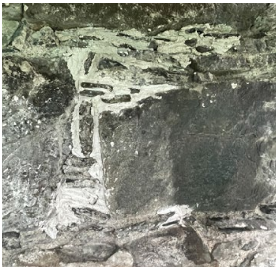
Spekking av djupe fuger med pinning ut til murlivet. Hesby kyrkje. Foto: Morten Stige, Fabrica.
