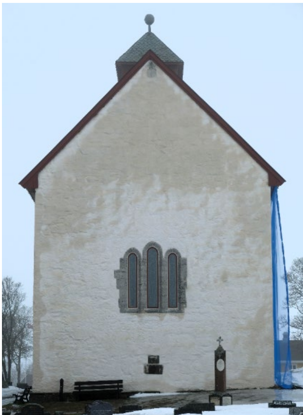
Mariakyrkja på Gran har fått ein kalkpuss som lever med vêret. Når den blir fuktig, blir variasjonen i suget til pussen tydeleg. Det er ikkje ein feil ved utføringa, men ein naturleg kvalitet ved kalkpussen. Foto: Morten Stige, Fabrica.
