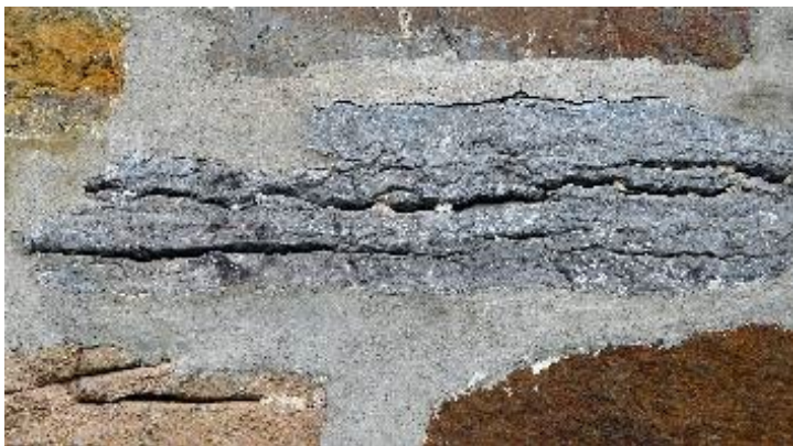
Forvitring av leirelag i kalkstein. Når steinen ligg på flasken går det gjerne bra, men dersom den står på kløyven kan lag spaltast av. Tingelstad kyrkje. Foto: Per Storemyr, Fabrica.
