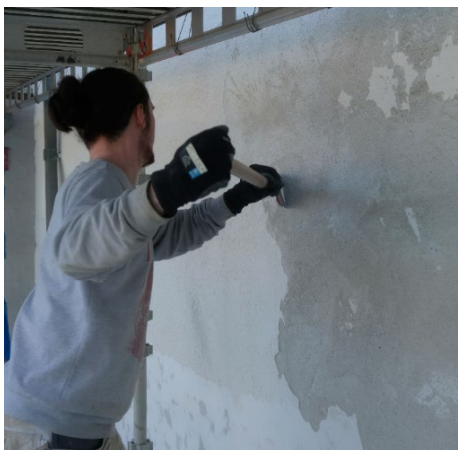
Det kan vera effektivt å fjerne organisk slemming med skrape. Her blir det brukt ein barkspeade. Ogna kyrkje. Foto: Morten Stige, Fabrica.
