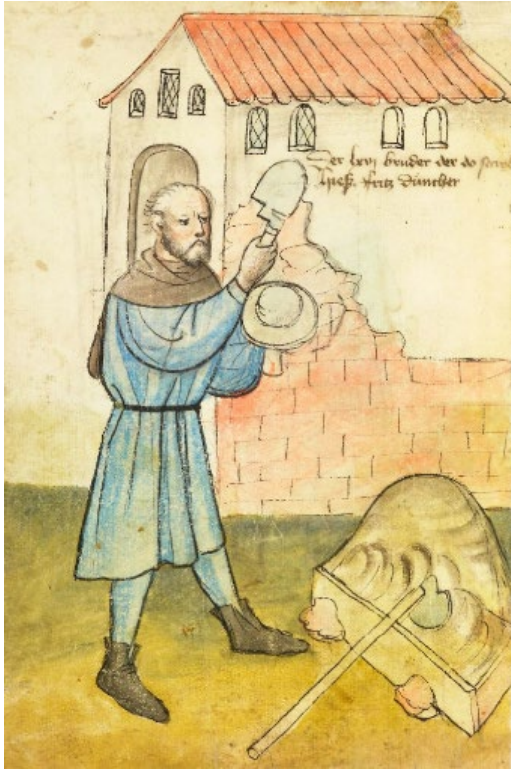
Munk og murer Fritz Düncher pussar ein kvadermur i Nürnberg i 1425. Han arbeider med ein mørtel som er så tørr at den ligg på brettet i ein klump. Kjelde: Hausbuch des Mendelschen Zwölfbrüderstiftung, Stadtbibliothek im Bildungscampus Nürnberg.
