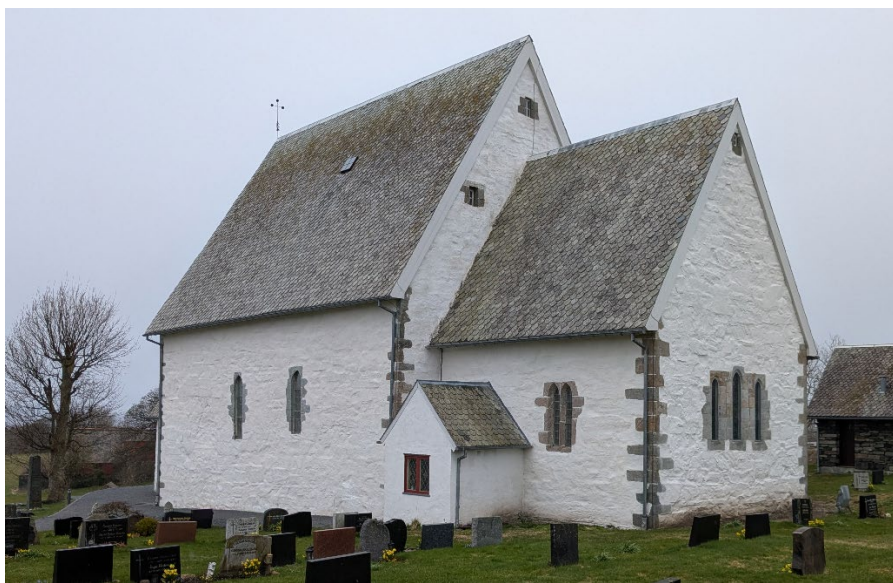
Hesby kyrkje etter at den var restaurert med mørtelleska tradisjonskalk frå Mosterhamn i 2024-25. Dette er ein kalk som er svært lik den opphavlege kalken frå 1200-talet. Foto: Per Storemyr, Fabrica.
