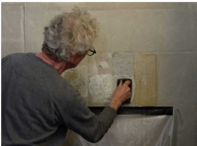
Prøvefelt for kjemisk målingsfjerning med ulike kjemiske produkt. Hoff kyrkje på Toten. Foto: Morten Stige, Fabrica.
