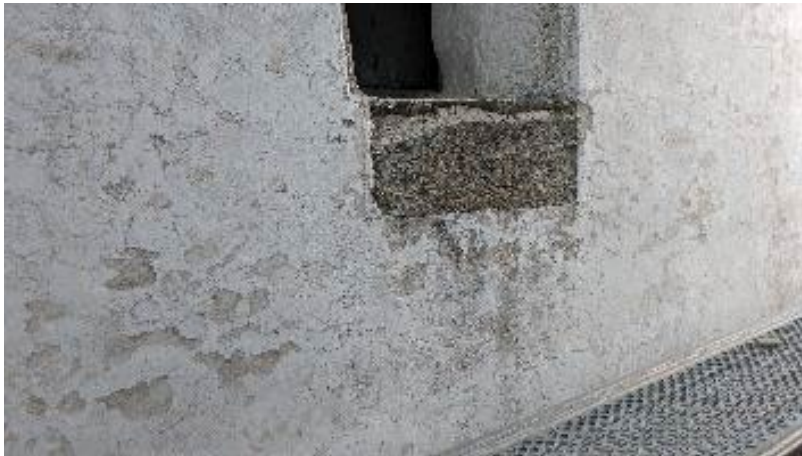
Krakelering og flaking av puss basert på NHL 3,5. Foto: Per Storemyr, Fabrica.
