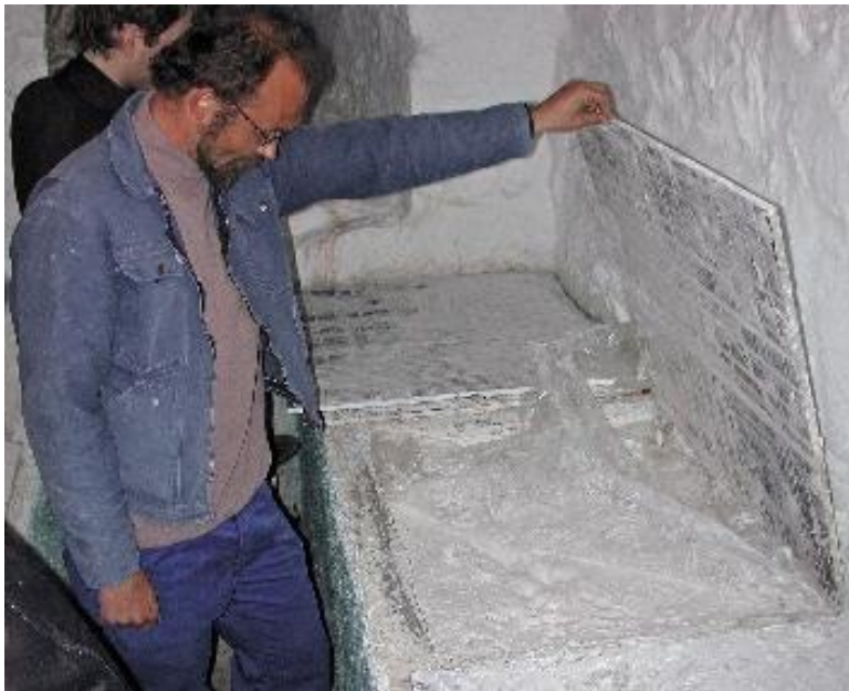
Eldre kalkkule i kjellaren under Nidarosdomen. Den våtleska kalken har stått lufttett i fleire tiår og er framleis godt brukbar. Foto: Per Storemyr, Fabrica.
